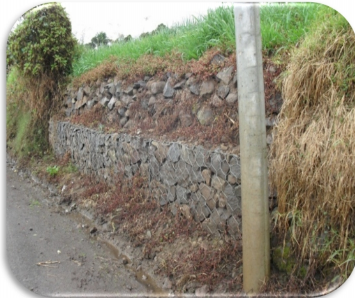
Fotografía 11. Muro de contención, corregimiento de Buesaquillo.
