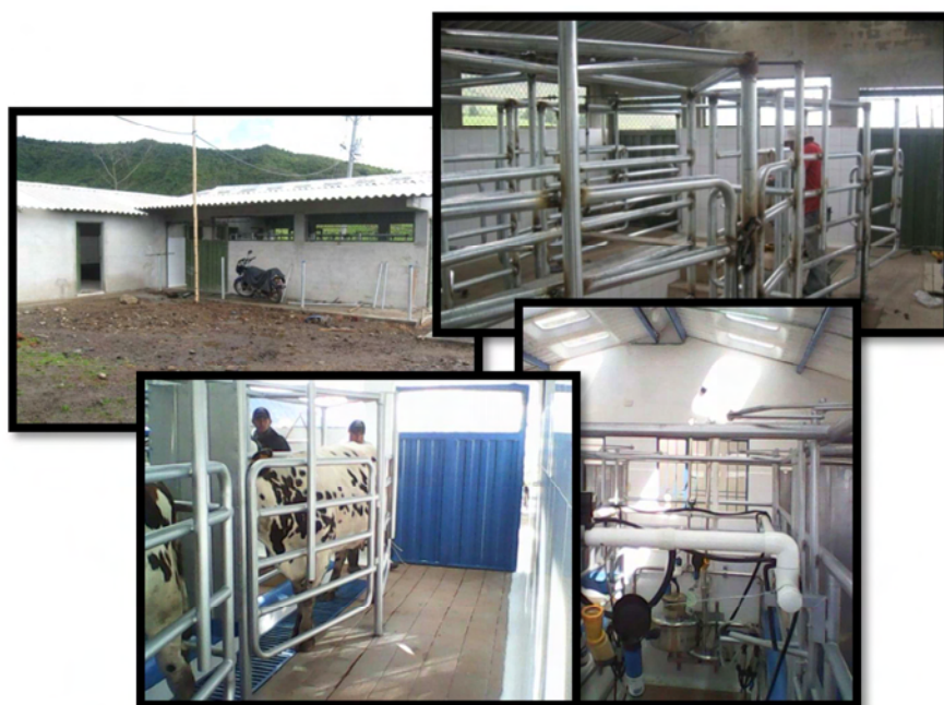
Figura 48. Avance de Instalaciones sala de ordeño. La Esperanza
