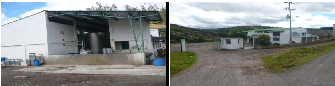
Figura 4. Centro de Acopio planta principal
