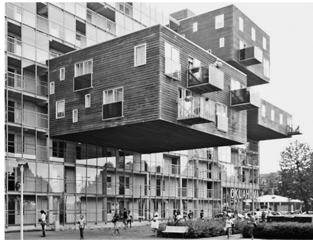
imagen nº 78- referente viviendas WOZOCO / MVRDV fachadas
