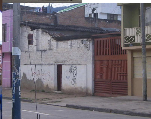
imagen nº 111- Edificaciones susceptibles de renovación
