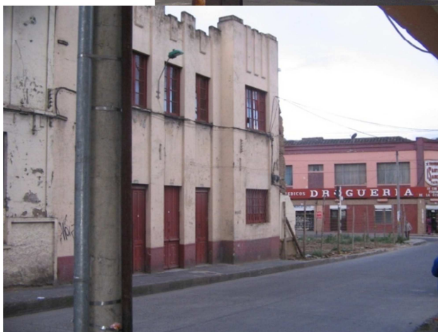
imagen nº 110- Edificaciones susceptibles de renovación
