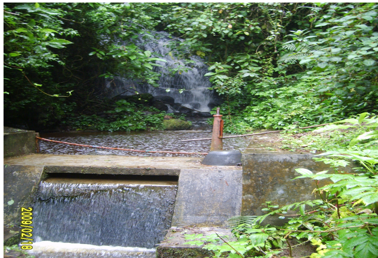
Figura 3. Bocatoma Acueducto Casco Urbano Municipio Gualmatán
