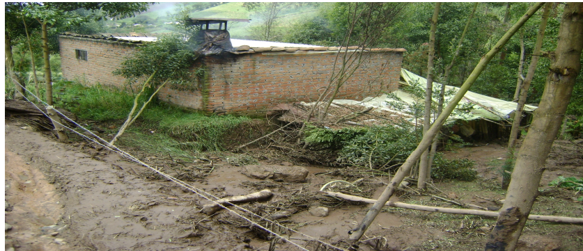
Figura 8. Daño parcial en vivienda rural, por inundación Municipio de Gualmatán
