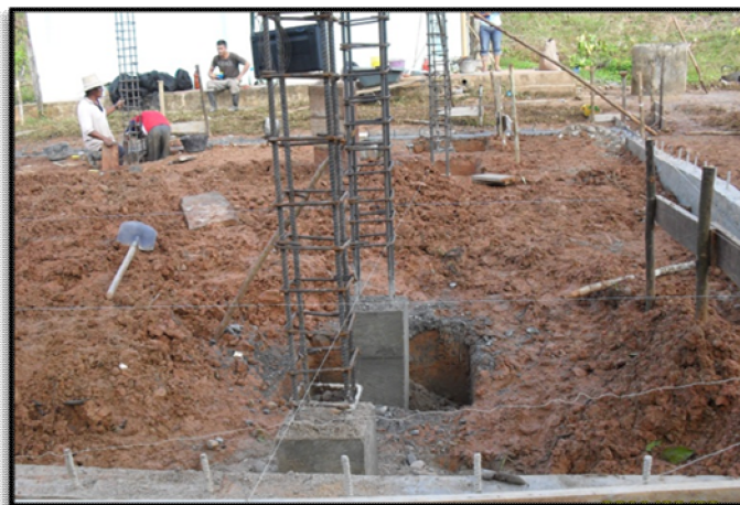
Ilustración 11. Colocación refuerzo para columnas.
