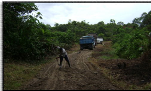
Ilustración 40. Suministro y extensión manual del material granular
