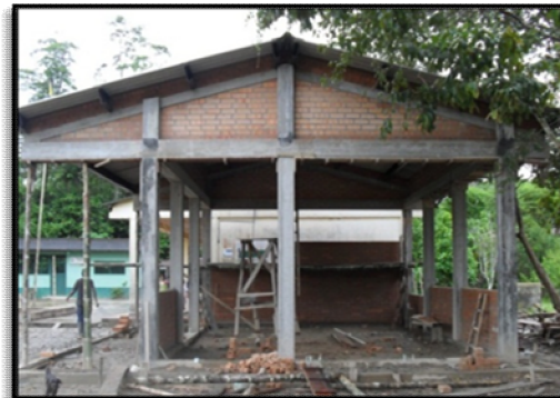
Ilustración 32. Soldadura de perfiles PHR de 220x80x2mm e Instalación de teja fibrocemento.
