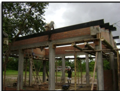
Ilustración 32. Soldadura de perfiles PHR de 220x80x2mm e Instalación de teja fibrocemento.
