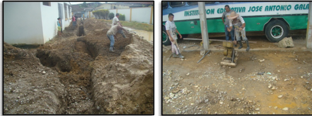
Ilustración 60. Relleno con material granular, compactación mecánica y retiro de sobrantes.
