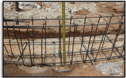
Ilustración 20. Cimentación y colocación de acero de refuerzo.
