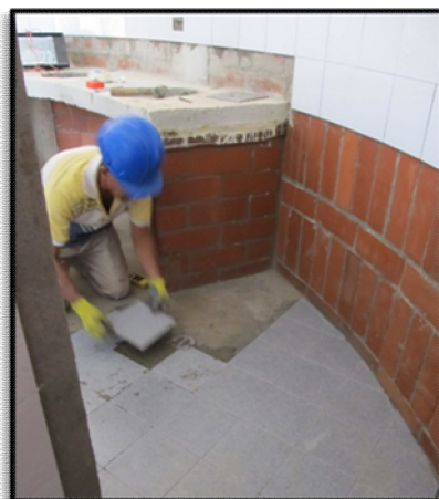
Ilustración 25. Instalación de pisos y enchapes.
