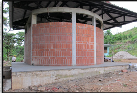
Ilustración 24. Muros en ladrillo a la vista.
