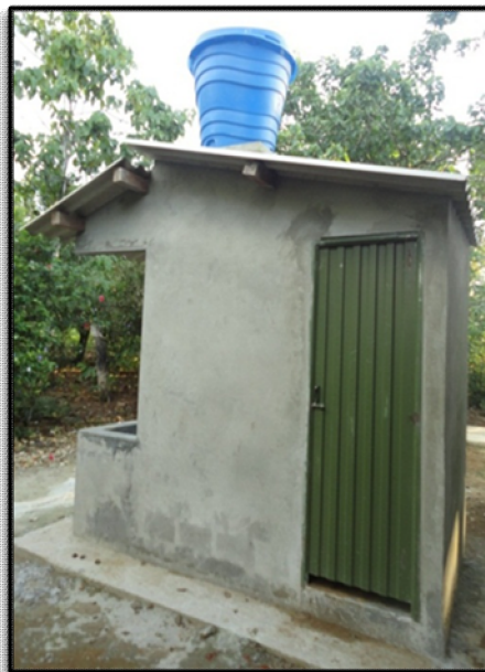
Ilustración 6. Pañetes, pisos, cubierta, instalación de aparatos sanitarios y carpintería metálica en las unidades sanitarias.
