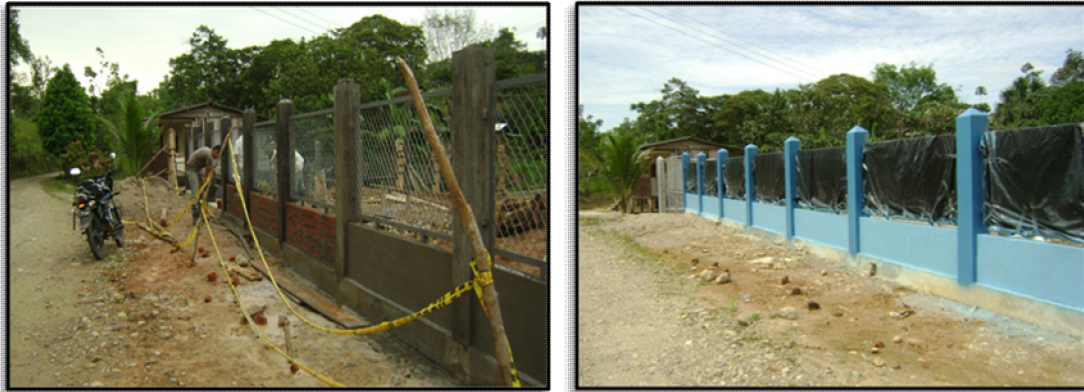
Ilustración 46. Construcción de muros y aplicación de esmalte.
