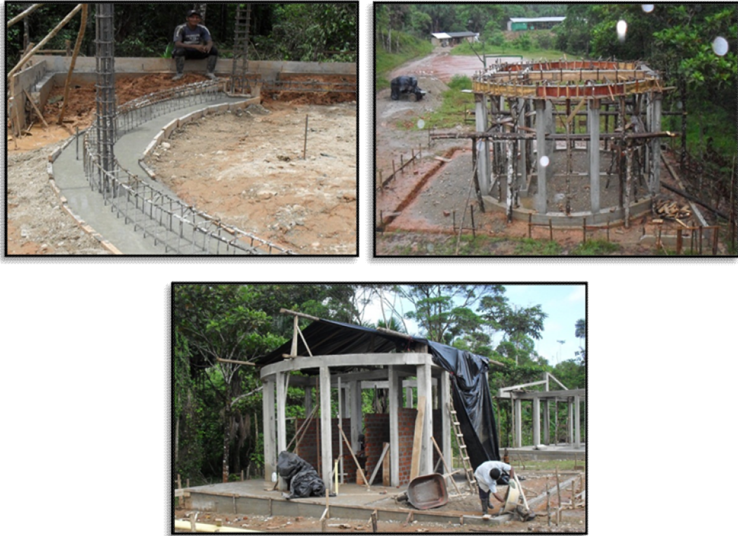
Ilustración 21. Cimentación, sistema aporticado y muro perimetral en la batería sanitaria.
