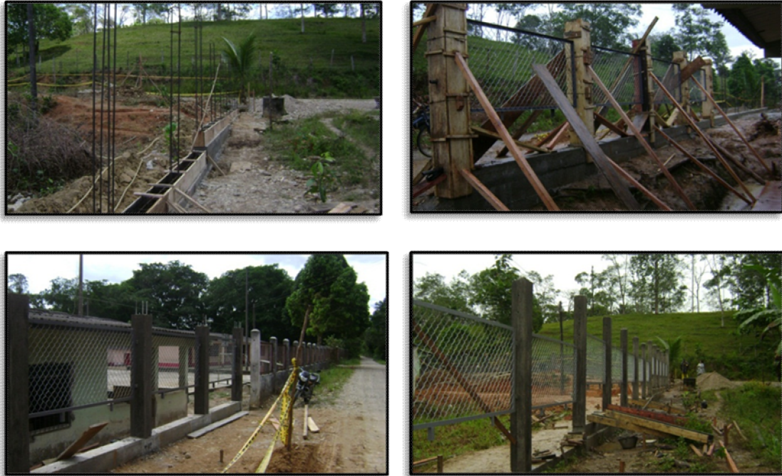
Ilustración 45. Acero de refuerzo y concretos para columnas y vigas del cerramiento escolar.
