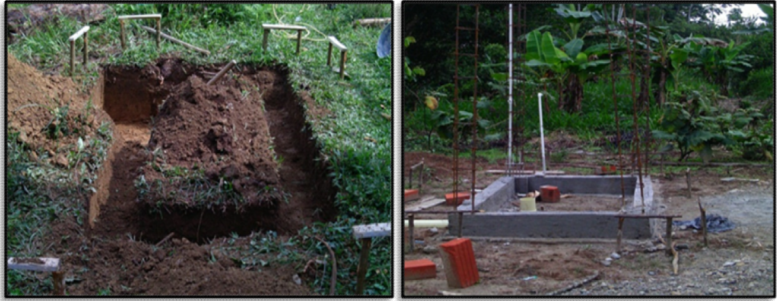
Ilustración 4. Preliminares, cimentación y desagües en las unidades sanitarias.
