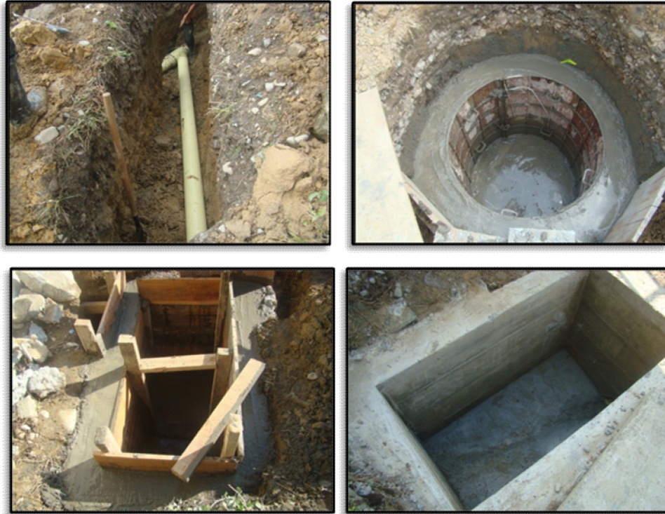
Ilustración 59. Instalación tubería sanitaria y construcción de pozos de inspección.
