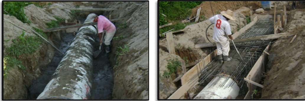
Ilustración 54. Recubrimiento en concreto reforzado del tramo de tubería.
