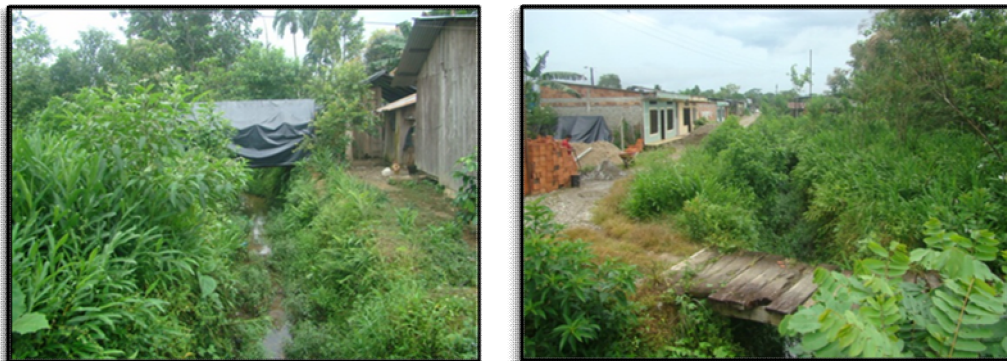
Ilustración 48. Caño periférico antes de la canalización
