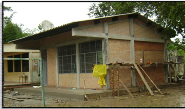
Ilustración 33. Muros en ladrillo a la vista.
