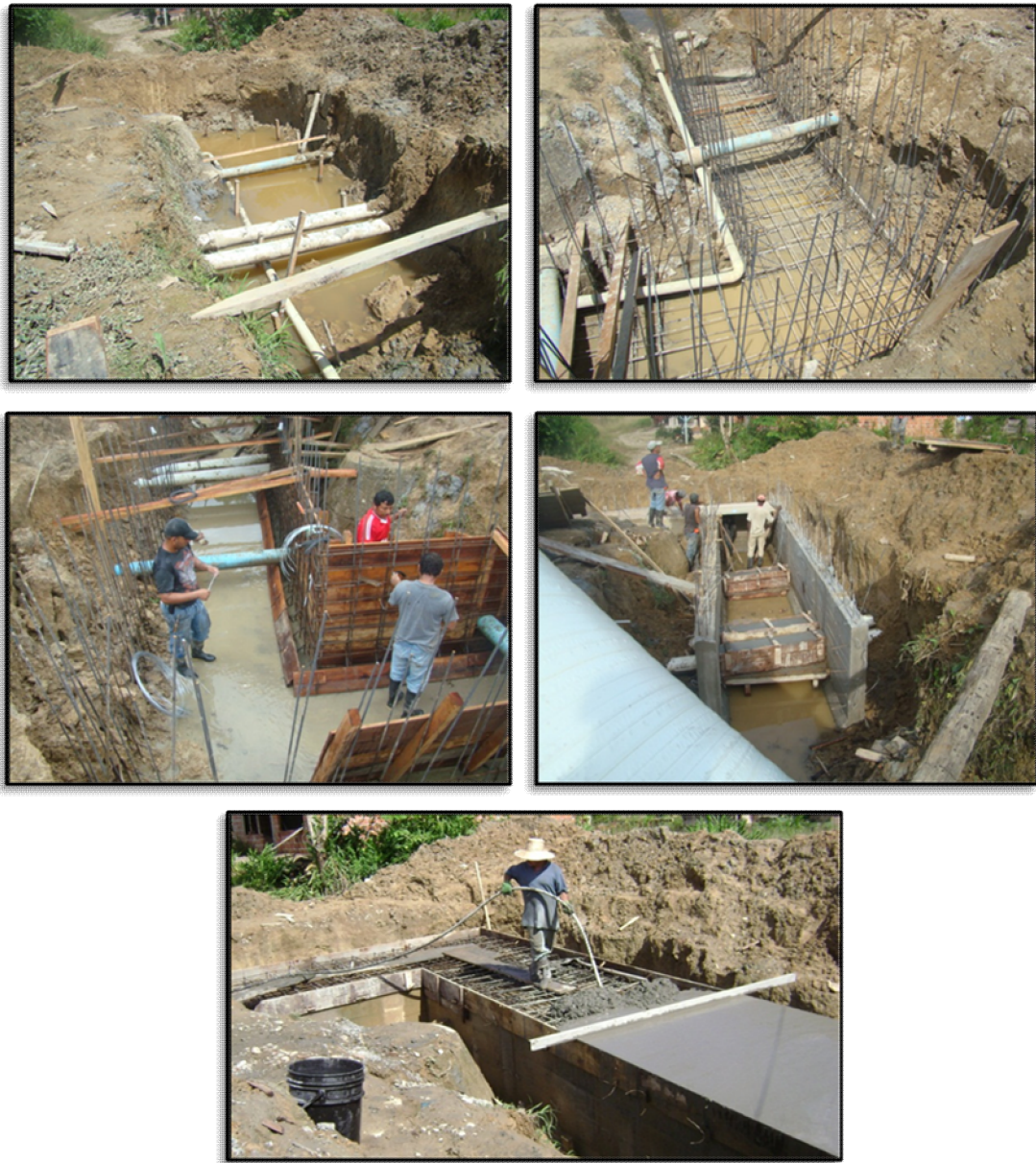
Ilustración 51. Proceso constructivo del boxculvert.
