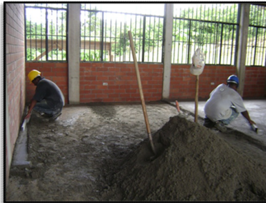
Ilustración 16. Afinado de piso mortero 1:4- e=4,0 cm.
