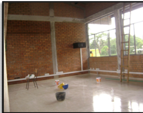
Ilustración 36. Instalación de pisos y acabados.
