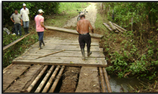
Ilustración 42. Reparación de puente en madera, vereda El Caruzo.
