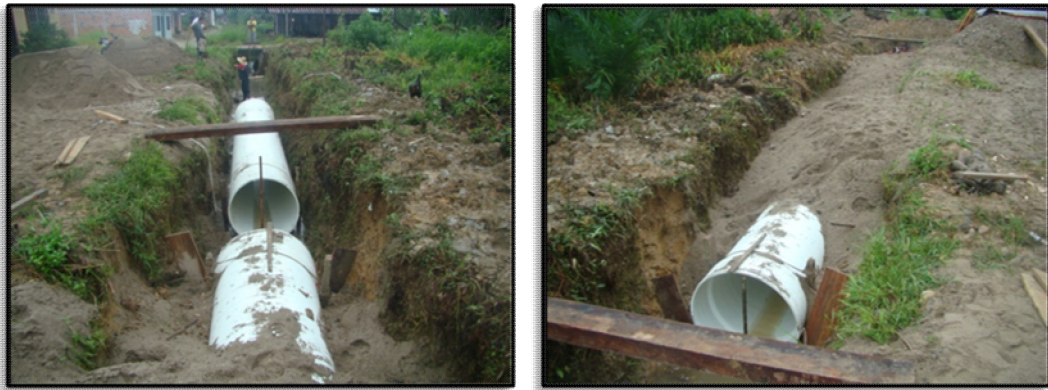
Ilustración 52. Instalación de tubería de 36”.
