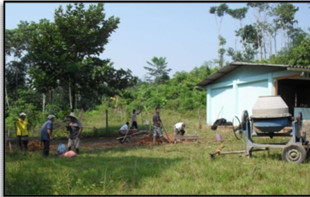
Ilustración 10. Limpieza y descapote del lote.
