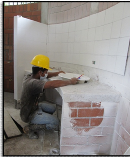
Ilustración 29. Instalación de lavamanos, tasas sanitarias y orinales
