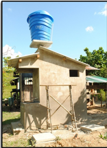
Ilustración 6. Pañetes, pisos, cubierta, instalación de aparatos sanitarios y carpintería metálica en las unidades sanitarias.
