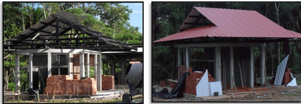
Ilustración 23. Instalación de teja ajover trapezoidal thermoacústica
