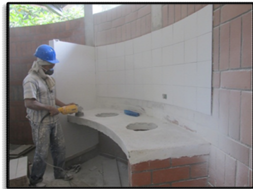
Ilustración 26. Construcción de mesones para lavamanos.
