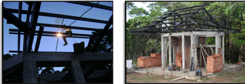
Ilustración 22. Instalación de estructura de la cubierta.
