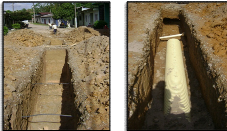
Ilustración 55. Obstáculos presentados en la excavación.
