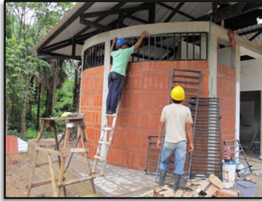
Ilustración 27. Instalación de puertas y ventanas en la batería sanitaria
