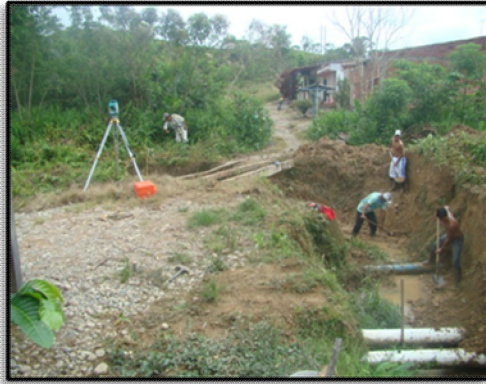
Ilustración 49. Limpieza y excavación del caño.
