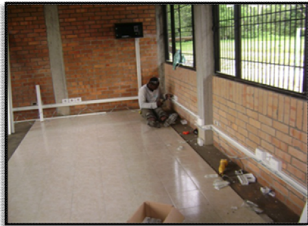
Ilustración 34. Instalación eléctrica y de datos.
