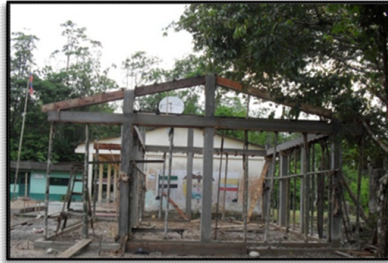
Ilustración 31. Pórticos y vigas de corona fundidos.
