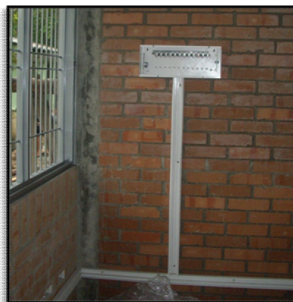
Ilustración 35. Tablero de distribución bifásico para doce circuitos.
