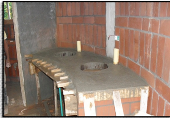
Ilustración 26. Construcción de mesones para lavamanos.
