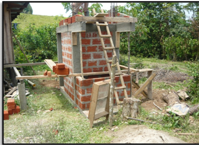
Ilustración 5. Estructura y mampostería en las unidades sanitarias.
