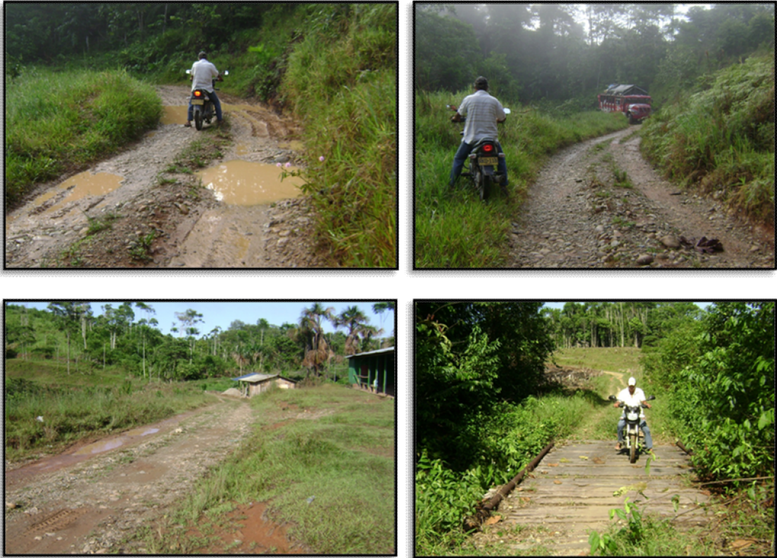
Ilustración 38. Estado inicial de las vías
