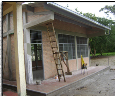
Ilustración 37. Instalación de carpintería metálica.
