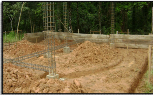
Ilustración 20. Cimentación y colocación de acero de refuerzo.
