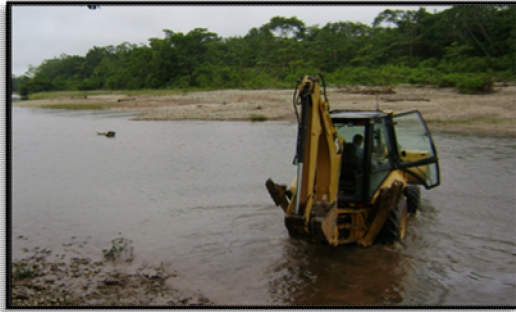
Ilustración 39. Cargue del material granular
