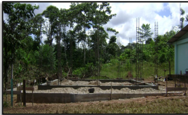
Ilustración 13. Sistema aporricado y vigas de corona
