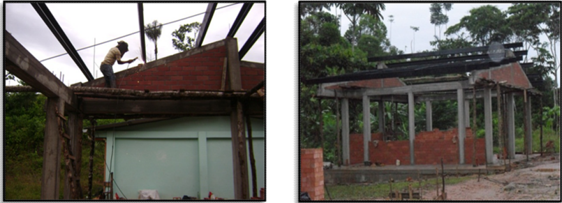
Ilustración 15. Soldadura de correas en perfilería PHR 220x80x2mm en C.
