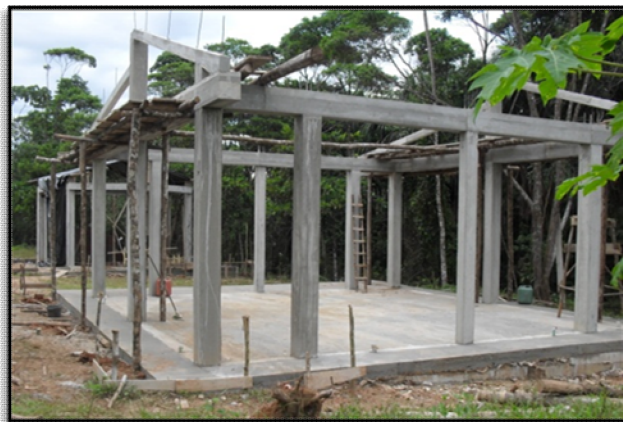
Ilustración 13. Sistema aporricado y vigas de corona
