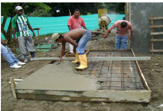
Fotografía 78: Proceso constructivo de tanque de almacenamiento de agua, Hogar Infantil La Florida.
