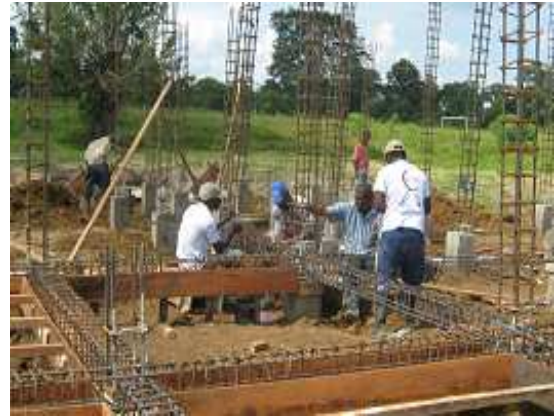
Fotografía 99: Encofrado y armado de acero de refuerzo de vigas de cimentación, Hogar Infantil Once de Noviembre.
