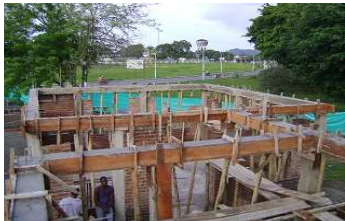
Fotografía 40: Proceso constructivo de viga aérea, Hogar Infantil La Florida.
