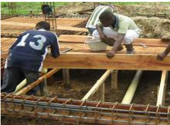
Fotografía 100: Encofrado y armado de acero de refuerzo de losa maciza, Hogar Infantil Once de Noviembre.
