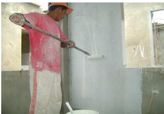
Fotografía 65: Aplicación de pintura de base y acabado sobre muros, Hogar Infantil La Florida.
