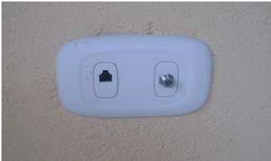
Fotografía 76: Instalación de toma telefónica y tevecable, Hogar Infantil La Florida.
