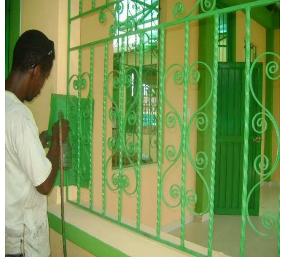
Fotografía 67: Aplicación de pintura esmalte sobre puertas, estructura para cubierta y protectores, Hogar Infantil La Florida.
