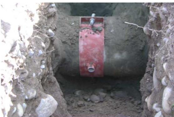
Fotografía 80: Instalación de acometida hidráulica, Hogar Infantil La Florida.
