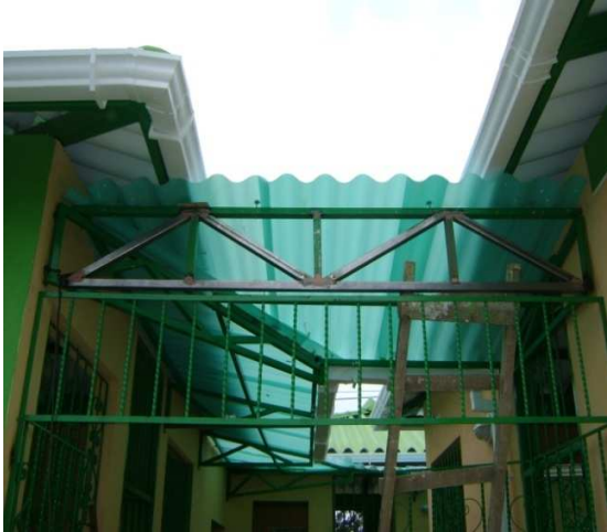
Fotografía 48: Instalación de tejas en estructura para cubierta de pasillo, Hogar Infantil La Florida.
