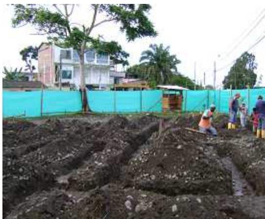
Fotografía 25: Excavación y compactación de zanjas para cimiento, Hogar la Florida.
