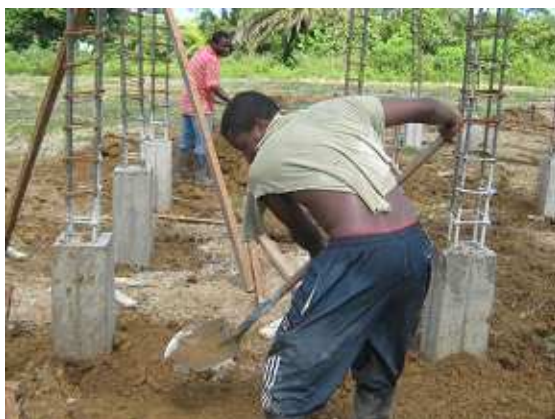
Fotografía 96: Fundición de pedestales y relleno con material del sitio, Hogar Infantil Once de Noviembre.
