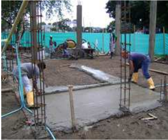
Fotografía 37: Fundición de losa para piso, Hogar Infantil La Florida.
