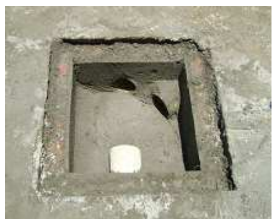
Fotografía 32: Instalación sanitaria con sus respectivas cajas de paso, Hogar Infantil La Florida.
