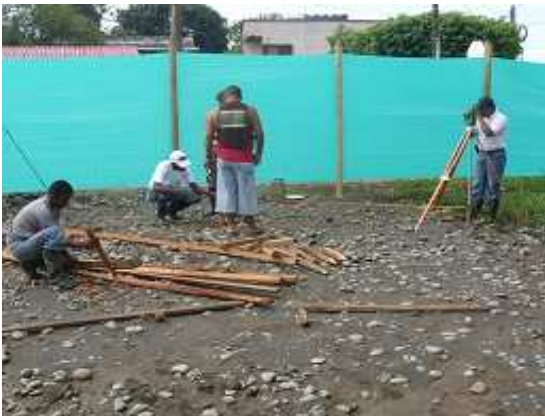
Fotografía 22: Localización de ejes, marcando la ubicación de los pilotes, Hogar Infantil La Florida.
