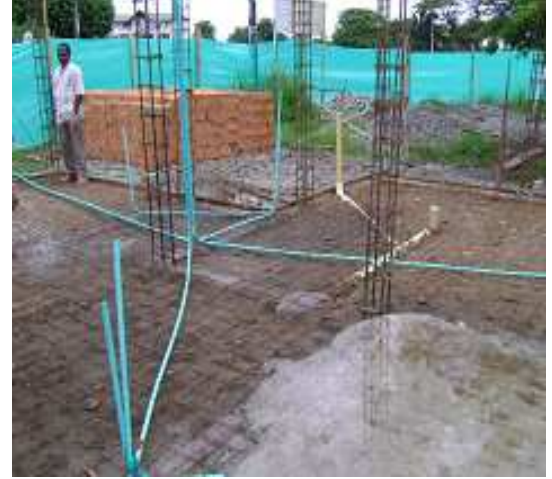
Fotografía 36: Instalación de tubería conduit para la red eléctrica, Hogar Infantil La Florida.
