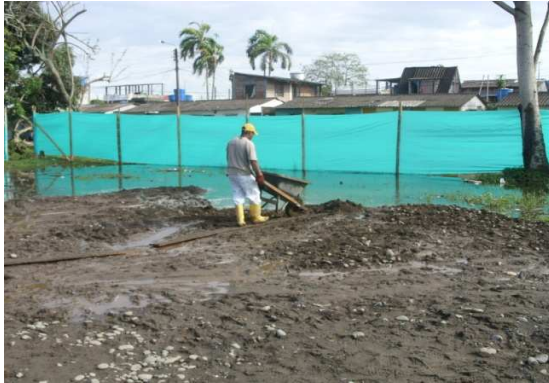
Fotografía 20: Relleno de sitio con material para base para la construcción del Hogar Infantil La Florida.
