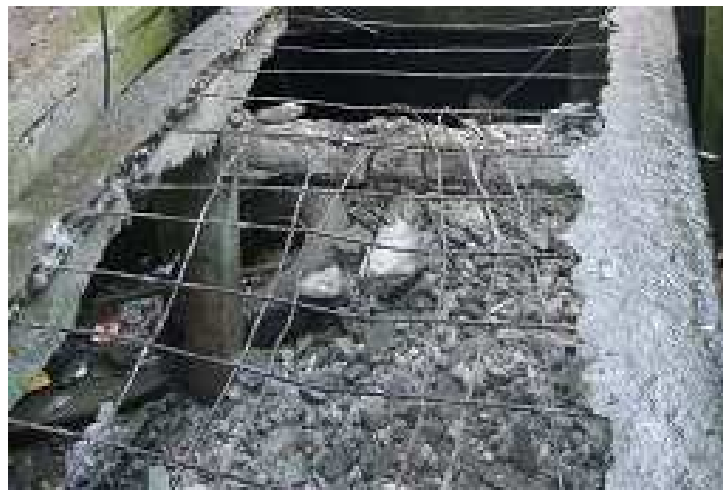
Fotografía 04: Demolición de estructura en concreto reforzado y madera, puente Barracón, tramos 1, 2, 3, 4 y 5
