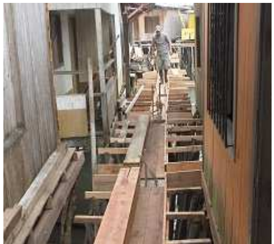
Fotografía 15: Encofrado de viga aérea y losa maciza, puente Barracón, tramos 1, 2, 3, 4 y 5
