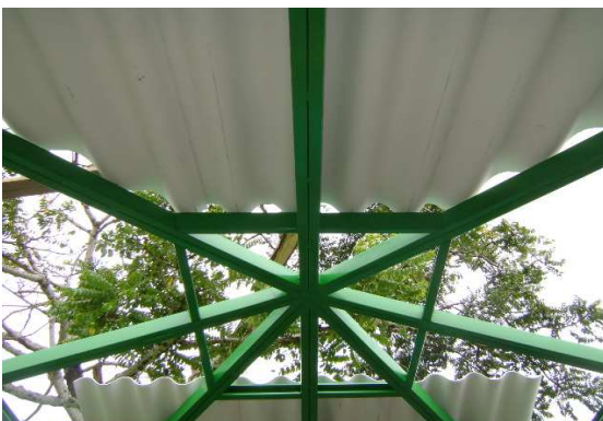
Fotografía 47: Instalación de tejas en estructura para cubierta, Hogar Infantil La Florida.
