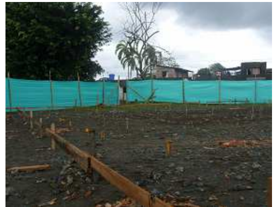
Fotografía 22: Localización de ejes, marcando la ubicación de los pilotes, Hogar Infantil La Florida.
