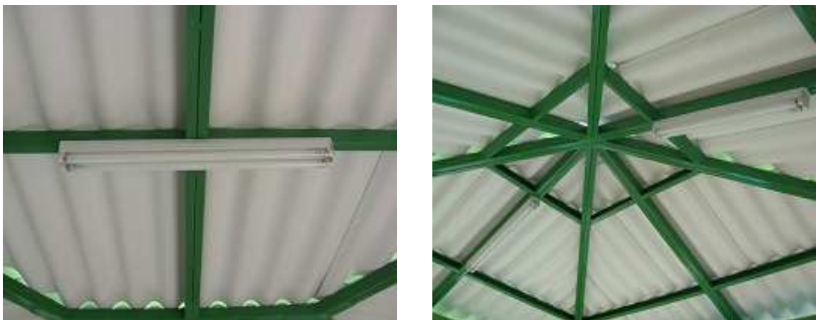
Fotografía 132: Instalación lámparas, Hogar Infantil Once de Noviembre.
