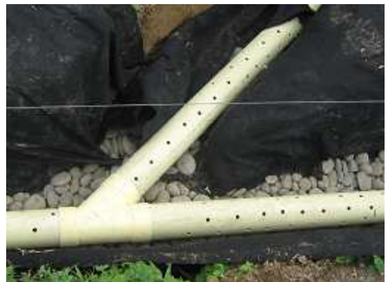
Fotografía 98: Puntos sanitarios, pozo anaeróbico y campo de infiltración, Hogar Infantil Once de Noviembre.
