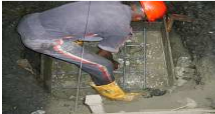
Fotografía 09: Solado para zapatas, puente Barracón, tramos 1, 2, 3, 4 y 5
