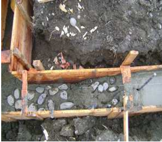
Fotografía 27: Encofrado, fundición de ciclópeo en concreto ciclópeo dejando pelos en varilla de 5/8" y desencofrado del mismo, Hogar Infantil La Florida.
