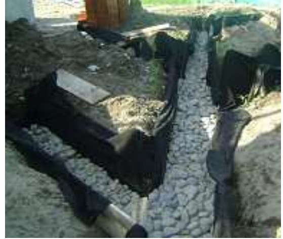
Fotografía 34: Construcción de campo de infiltración para aguas residuales, Hogar Infantil La Florida.
