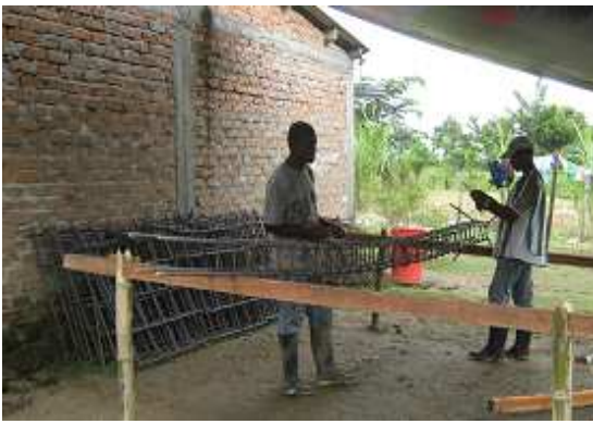
Fotografía 93: Figurado y armado de castillos para vigas de cimentación y columnas, Hogar Infantil Once de Noviembre.
