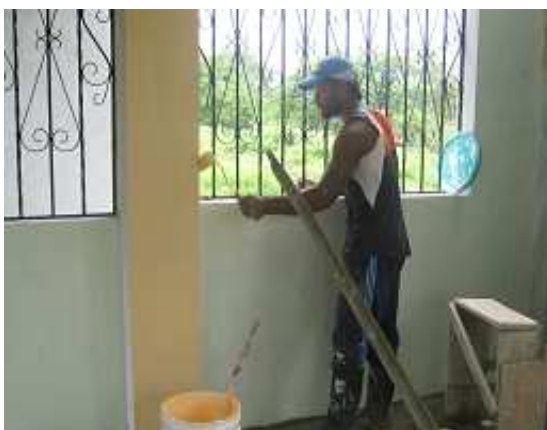
Fotografía 126: Aplicación de pintura de base y acabado sobre cara interior de muros, vigas y columnas, Hogar Infantil Once de Noviembre.
