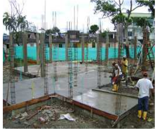
Fotografía 37: Fundición de losa para piso, Hogar Infantil La Florida.
