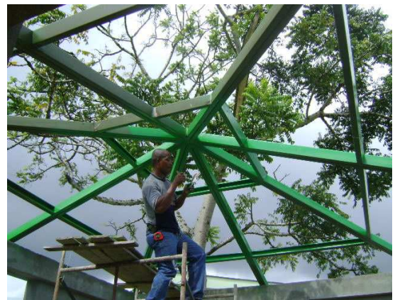
Fotografía 44: Construcción de estructura metálica para cubierta, Hogar Infantil La Florida.
