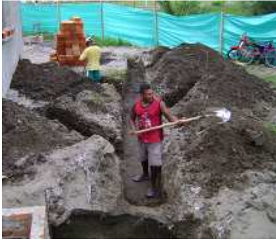
Fotografía 34: Construcción de campo de infiltración para aguas residuales, Hogar Infantil La Florida.
