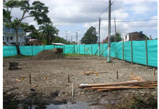
Fotografía 20: Relleno de sitio con material para base para la construcción del Hogar Infantil La Florida.
