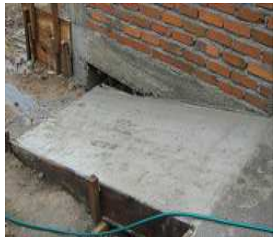
Fotografía 119: Construcción de rampas en concreto reforzado, Hogar Infantil Once de Noviembre.
