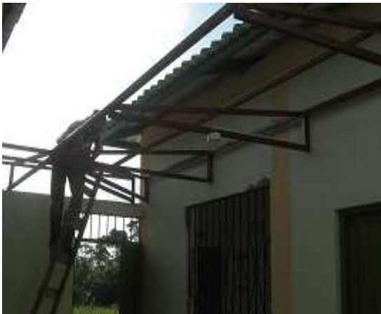
Fotografía 109: Construcción de estructura metálica para cubierta de pasillo, Hogar Infantil Once de Noviembre.
