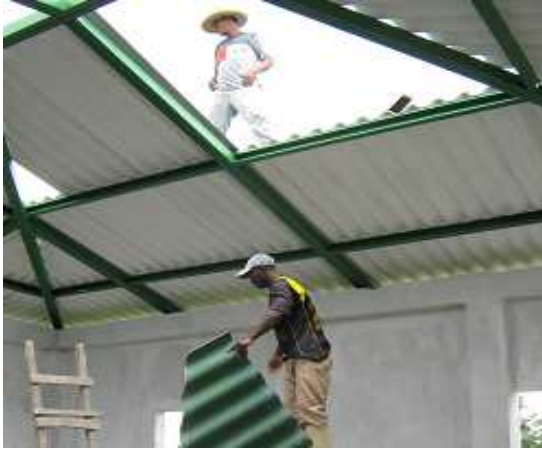
Fotografía 110: Instalación de tejas en estructura para cubierta, Hogar Infantil Once de Noviembre.
