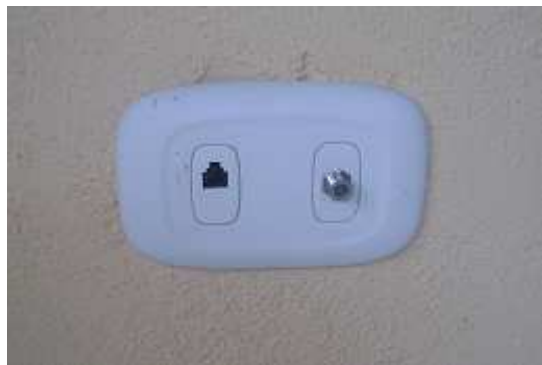
Fotografía 134: Instalación de toma telefónica y tevecable, Hogar Infantil Once de Noviembre.
