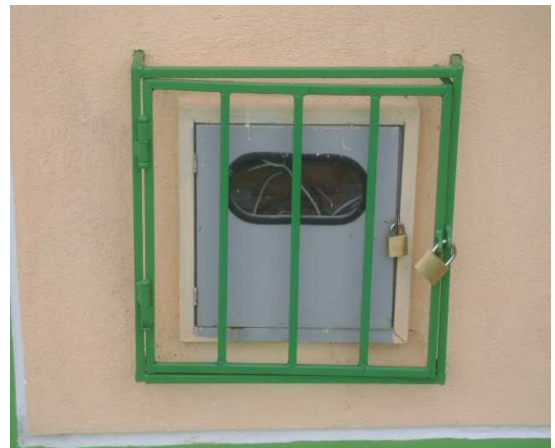
Fotografía 73: Instalación de caja para medidor y protector de seguridad, Hogar Infantil La Florida.
