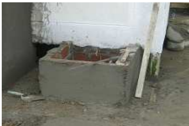
Fotografía 139: Construcción de lavatraperos, Hogar Infantil Once de Noviembre.
