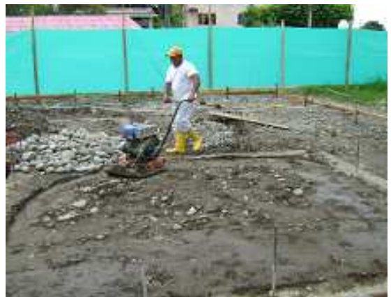
Fotografía 28: Relleno y compactación de zanjas con material para base, Hogar Infantil La Florida.
