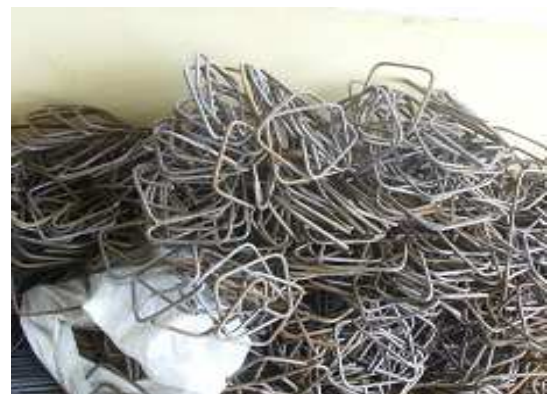
Fotografía 23: Figurado y armado de acero de refuerzo para vigas de cimentación y columnas, Hogar Infantil La Florida.
