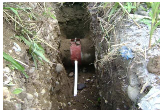
Fotografía 80: Instalación de acometida hidráulica, Hogar Infantil La Florida.
