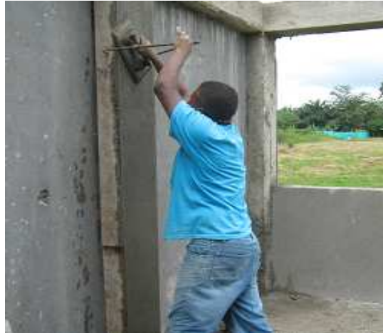
Fotografía 106: Repello interior de muros, vigas y columnas con sus respectivas dilataciones, Hogar Infantil Once de Noviembre.
