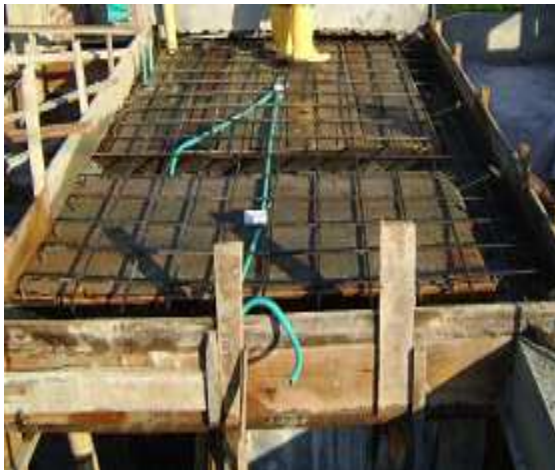
Fotografía 105: Fundición de viga de aérea y placa para tanques, Hogar Infantil Once de Noviembre.
