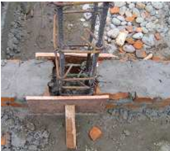
Fotografía 31: Fundición de pedestales a nivel de ladrillo en tizón, Hogar Infantil La Florida.
