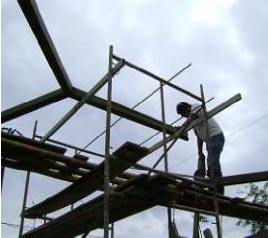
Fotografía 108: Construcción de estructura metálica para cubierta, Hogar Infantil Once de Noviembre.
