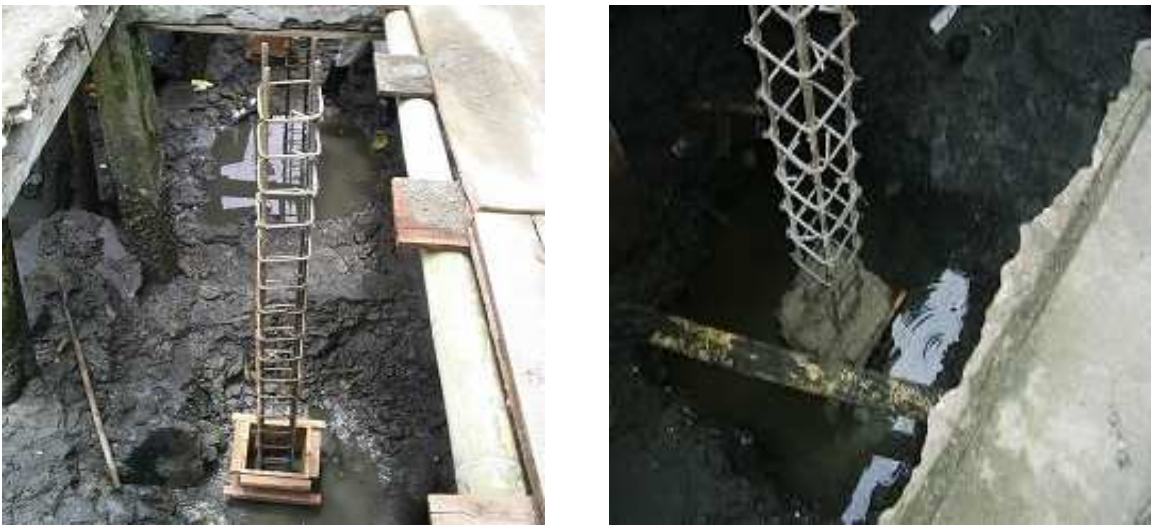
Fotografía 12: Fundición de pedestales, puente Barracón, tramos 1, 2, 3, 4 y 5
