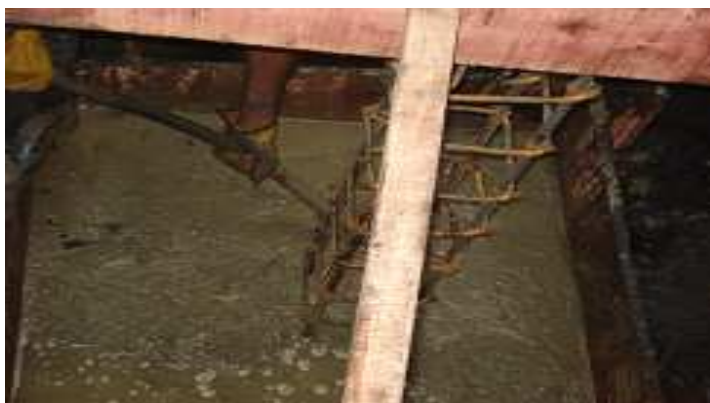
Fotografía 10: Fundición de zapatas, puente Barracón, tramos 1, 2, 3, 4 y 5
