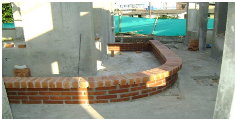
Fotografía 53: Proceso constructivo de jardinera en ladrillo limpio, Hogar Infantil La Florida.
