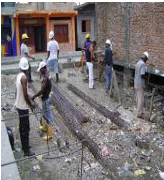
Fotografía 11: Armado de acero de refuerzo para columnas, puente Barracón, tramos 1, 2, 3, 4 y 5
