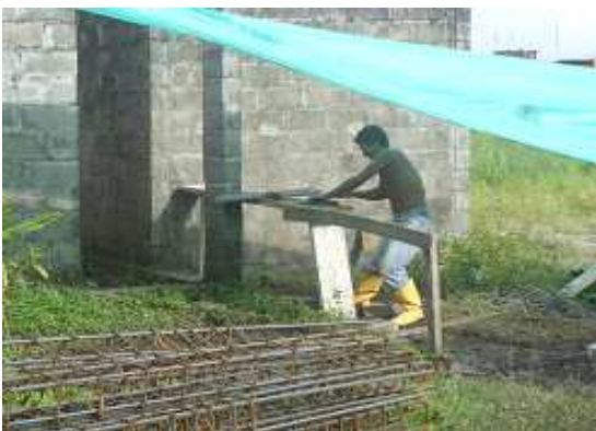
Fotografía 23: Figurado y armado de acero de refuerzo para vigas de cimentación y columnas, Hogar Infantil La Florida.
