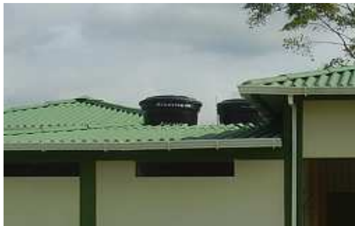
Fotografía 137: Instalación de tanques de almacenamiento de agua, Hogar Infantil Once de Noviembre.
