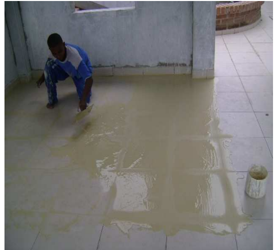
Fotografía 55: Asentamiento de cerámica, nivelación y fraguado de dilataciones, Hogar Infantil La Florida.
