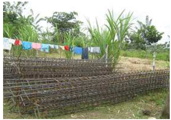
Fotografía 93: Figurado y armado de castillos para vigas de cimentación y columnas, Hogar Infantil Once de Noviembre.
