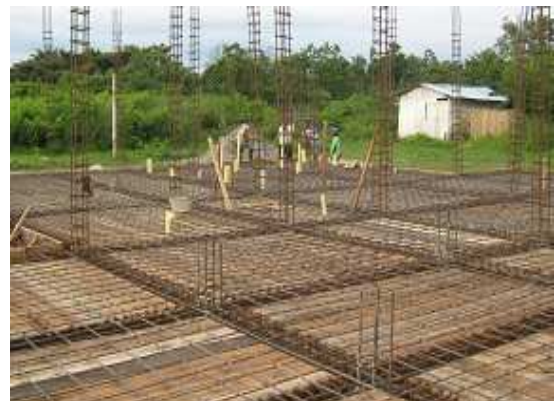
Fotografía 100: Encofrado y armado de acero de refuerzo de losa maciza, Hogar Infantil Once de Noviembre.
