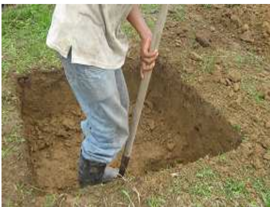
Fotografía 92: Excavación manual para zapatas, Hogar Infantil Once de Noviembre.
