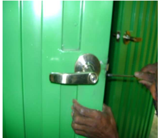
Fotografía 70: Instalación de puertas con su respectiva chapa de seguridad, Hogar Infantil La Florida.
