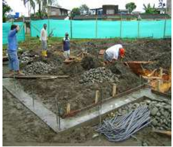
Fotografía 27: Encofrado, fundición de ciclópeo en concreto ciclópeo dejando pelos en varilla de 5/8" y desencofrado del mismo, Hogar Infantil La Florida.
