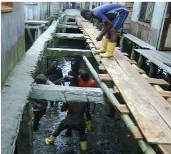
Fotografía 07: Hincado de pilotes en madera, puente Barracón, tramos 1, 2, 3, 4 y 5
