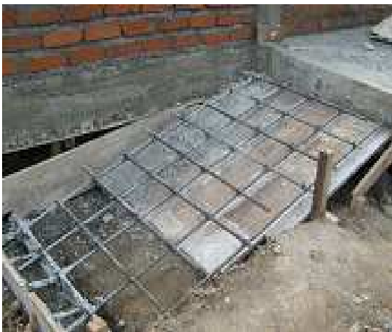
Fotografía 119: Construcción de rampas en concreto reforzado, Hogar Infantil Once de Noviembre.
