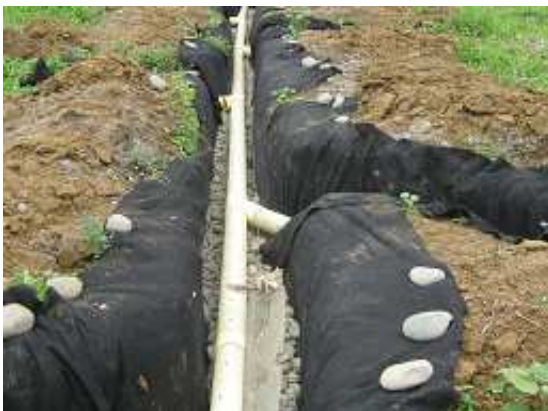
Fotografía 98: Puntos sanitarios, pozo anaeróbico y campo de infiltración, Hogar Infantil Once de Noviembre.
