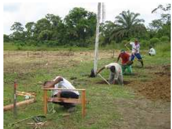
Fotografía 92: Excavación manual para zapatas, Hogar Infantil Once de Noviembre.
