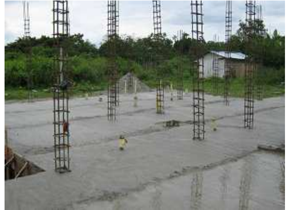
Fotografía 101: Fundición de vigas de cimentación y losa de piso en concreto reforzado, Hogar Infantil Once de Noviembre.
