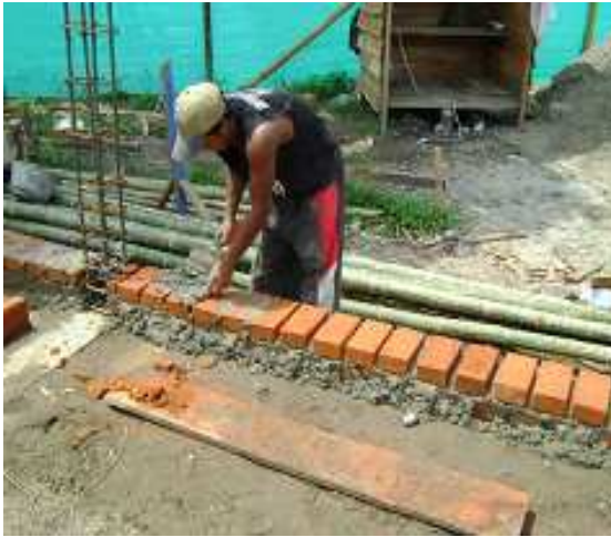
Fotografía 30: Pega de ladrillo en tizón sobre viga de cimentación para sobrecimiento, Hogar Infantil La Florida.
