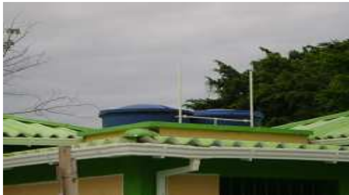
Fotografía 81: Instalación de tanques de almacenamiento de agua, Hogar Infantil La Florida.
