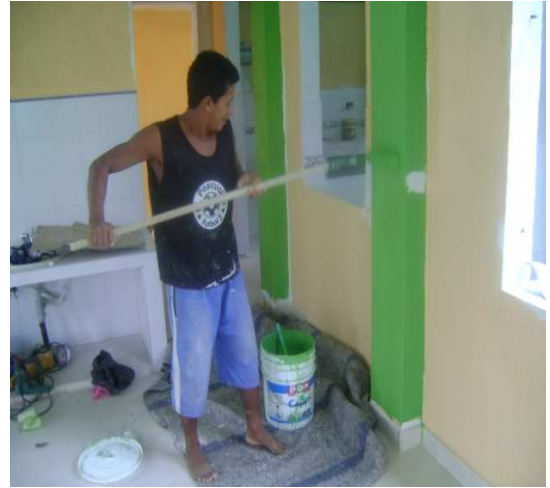
Fotografía 66: Aplicación de pintura de acabado sobre vigas y columnas, Hogar Infantil La Florida.
