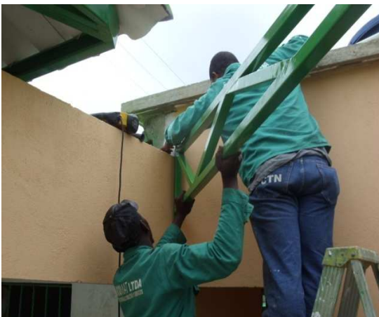
Fotografía 45: Construcción de estructura metálica para cubierta de pasillo, Hogar Infantil La Florida.
