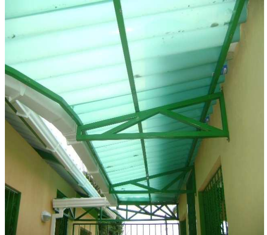
Fotografía 48: Instalación de tejas en estructura para cubierta de pasillo, Hogar Infantil La Florida.
