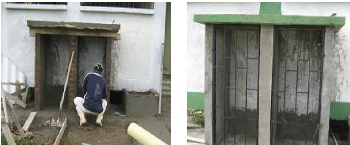
Fotografía 138: Construcción de caseta para hidrofloc y tanque de gas, Hogar Infantil Once de Noviembre.
