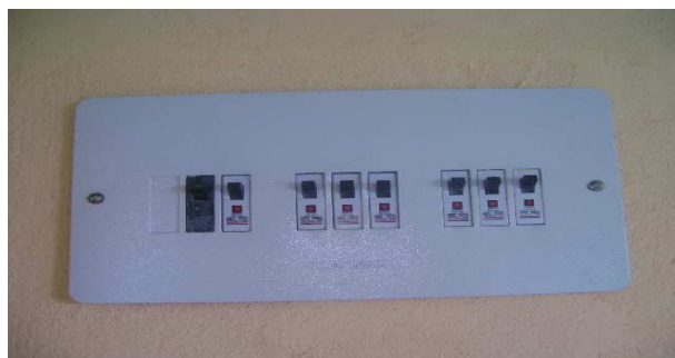
Fotografía 77: Instalación de caja para breakers, Hogar Infantil La Florida.
