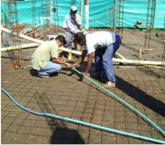
Fotografía 36: Instalación de tubería conduit para la red eléctrica, Hogar Infantil La Florida.
