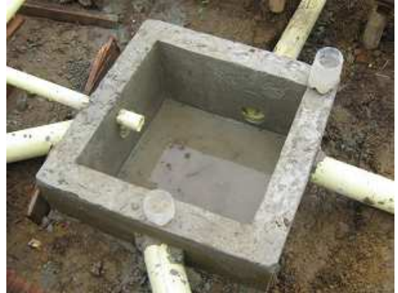
Fotografía 97: Instalación sanitarios y caja de inspección en concreto reforzado, Hogar Infantil Once de Noviembre.
