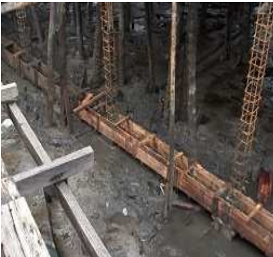
Fotografía 13: Encofrado, armado de acero y fundición de viga de cimentación, puente Barracón, tramos 1, 2, 3, 4 y 5
