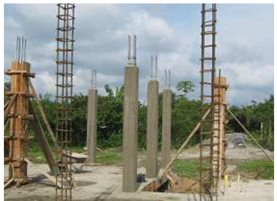
Fotografía 102: Fundición de columnas en concreto reforzado, Hogar Infantil Once de Noviembre.
