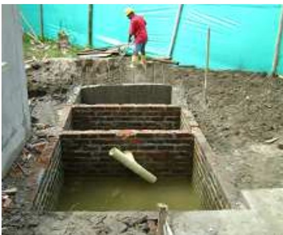
Fotografía 33: Construcción de trampa de grasa y pozo anaeróbico FAFA, Hogar Infantil La Florida.
