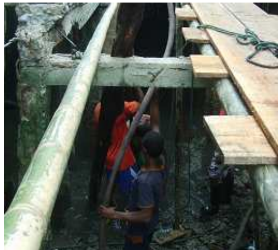
Fotografía 07: Hincado de pilotes en madera, puente Barracón, tramos 1, 2, 3, 4 y 5
