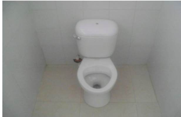
Fotografía 68: Instalación de aparatos sanitarios, Hogar Infantil La Florida.
