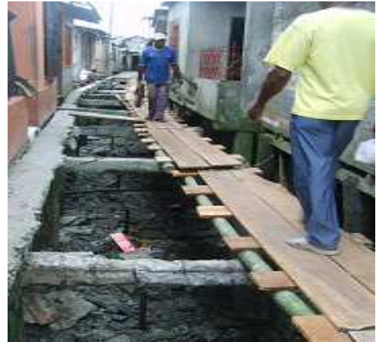
Fotografía 05: Construcción de puente provisional, puente Barracón, tramos 1, 2, 3, 4 y 5
