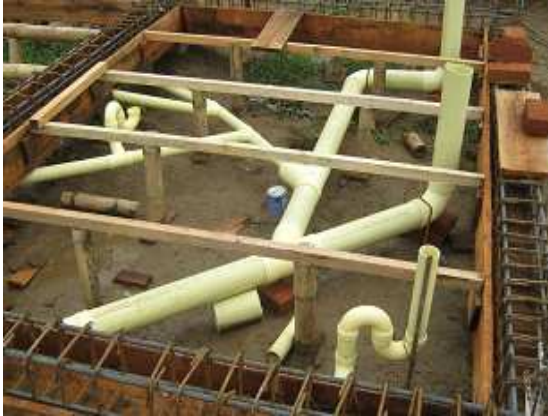
Fotografía 97: Instalación sanitarios y caja de inspección en concreto reforzado, Hogar Infantil Once de Noviembre.
