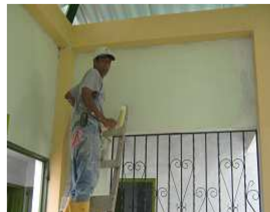
Fotografía 126: Aplicación de pintura de base y acabado sobre cara interior de muros, vigas y columnas, Hogar Infantil Once de Noviembre.
