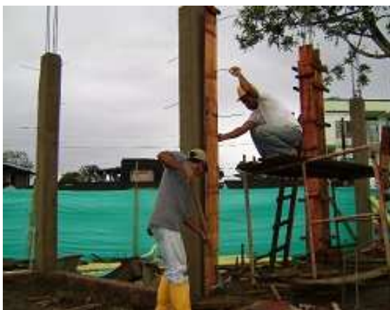
Fotografía 38: Fundición, desencofrado y curado de columnas, Hogar Infantil La Florida.
