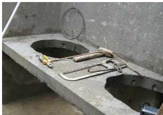
Fotografía 113: Construcción de mesón para lavamanos, Hogar Infantil Once de Noviembre.
