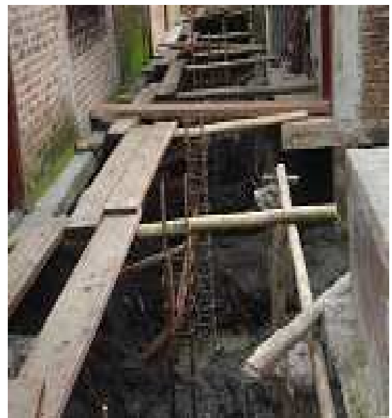
Fotografía 11: Armado de acero de refuerzo para columnas, puente Barracón, tramos 1, 2, 3, 4 y 5
