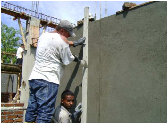
Fotografía 42: Repello de muros interiores y exteriores con sus respectivas dilataciones, Hogar Infantil La Florida.
