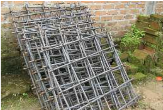
Fotografía 94: Figurado, armado de parrillas y fundición de solado para zapatas, Hogar Infantil Once de Noviembre.
