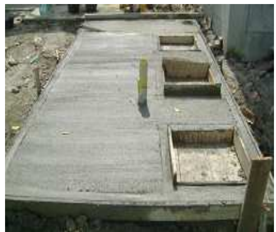
Fotografía 33: Construcción de trampa de grasa y pozo anaeróbico FAFA, Hogar Infantil La Florida.
