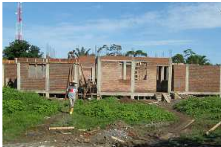
Fotografía 103: Mampostería de muros exteriores e interiores en ladrillo tolete común, Hogar Infantil Once de Noviembre.
