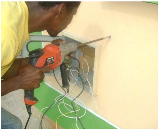
Fotografía 73: Instalación de caja para medidor y protector de seguridad, Hogar Infantil La Florida.
