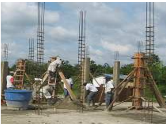
Fotografía 102: Fundición de columnas en concreto reforzado, Hogar Infantil Once de Noviembre.
