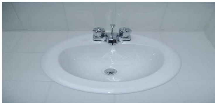
Fotografía 69: Instalación de lavamanos de empotrar, Hogar Infantil La Florida.
