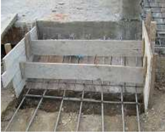
Fotografía 120: Construcción de escaleras en concreto reforzado, Hogar Infantil Once de Noviembre.
