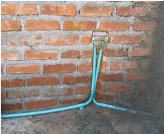
Fotografía 104: Instalación de tubería para la red eléctrica, Hogar Infantil Once de Noviembre.
