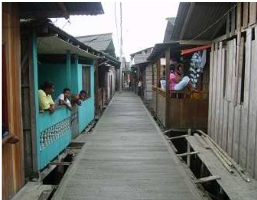
Fotografía 1: Puente peatonal Barracón ramal 5, al finalizar su construcción.
