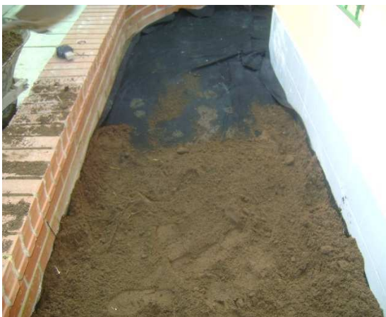
Fotografía 85: colocación de geotextil, vaciado de tierra y sembrado de matas, Hogar Infantil La Florida.
