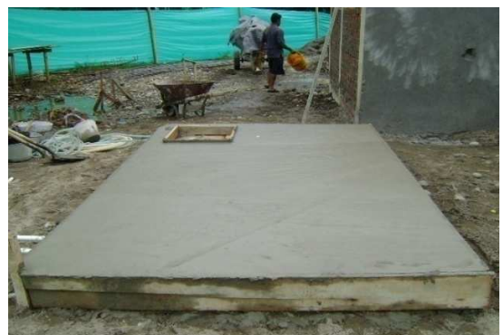
Fotografía 78: Proceso constructivo de tanque de almacenamiento de agua, Hogar Infantil La Florida.
