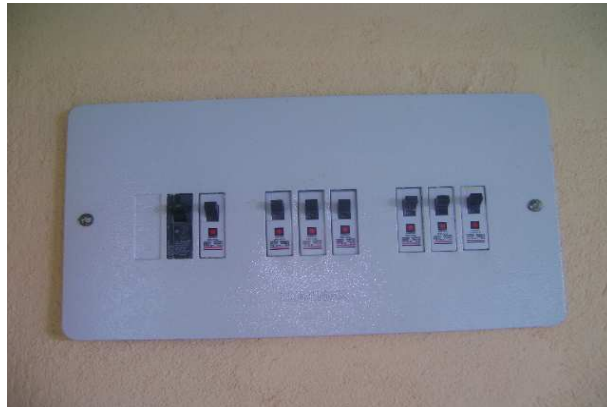
Fotografía 135: Instalación de caja para breakers, Hogar Infantil La Florida.
