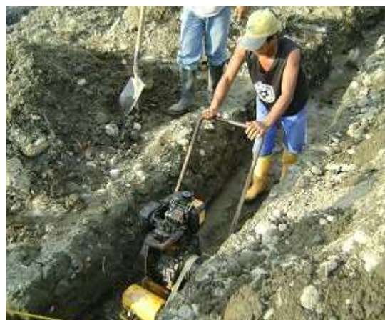
Fotografía 25: Excavación y compactación de zanjas para cimiento, Hogar la Florida.
