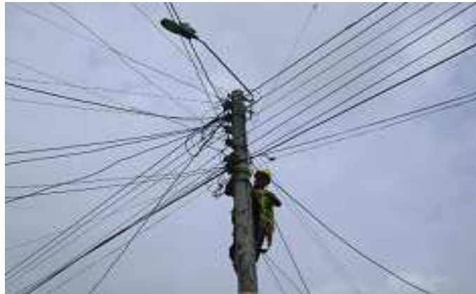
Fotografía 131: Instalación de red eléctrica principal, Hogar Infantil Once de Noviembre.
