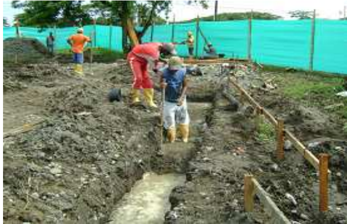
Fotografía 26: Vaciado de solado de limpieza en toda la base de la excavación para el cimiento en concreto ciclópeo, Hogar Infantil La Florida.
