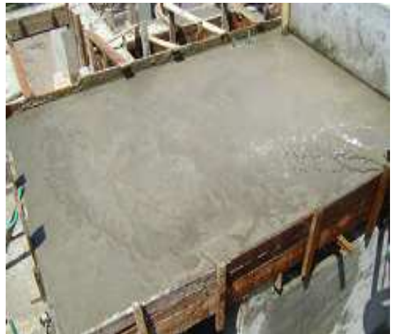
Fotografía 105: Fundición de viga de aérea y placa para tanques, Hogar Infantil Once de Noviembre.
