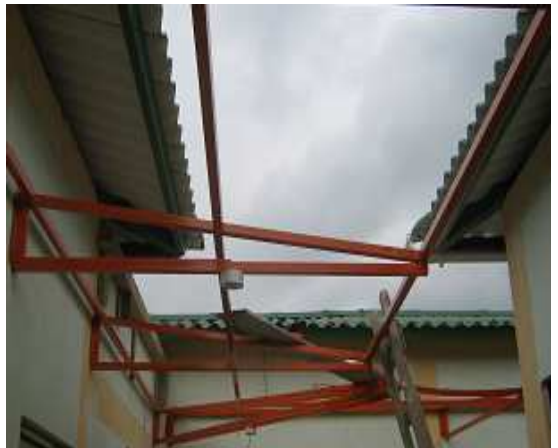
Fotografía 109: Construcción de estructura metálica para cubierta de pasillo, Hogar Infantil Once de Noviembre.
