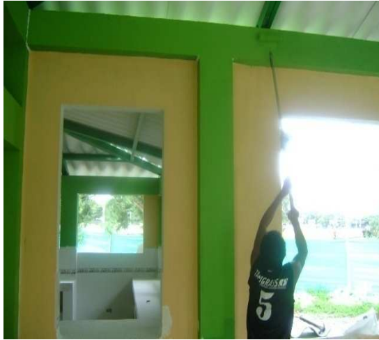
Fotografía 66: Aplicación de pintura de acabado sobre vigas y columnas, Hogar Infantil La Florida.
