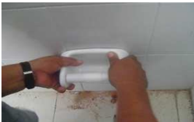
Fotografía 141: Instalación de accesorios sanitarios, Hogar Infantil Once de Noviembre.
