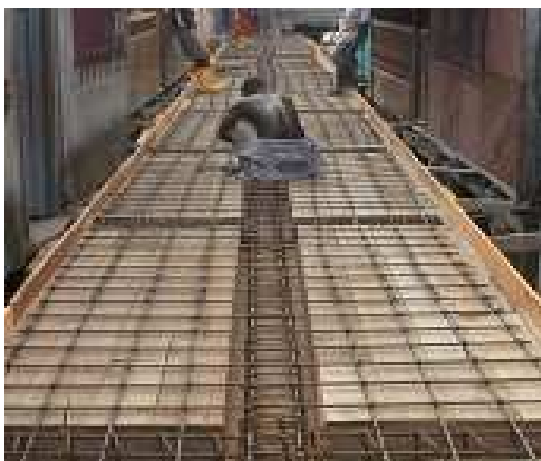
Fotografía 16: Armado de acero de refuerzo para viga aérea y losa maciza, puente Barracón, tramos 1, 2, 3, 4 y 5
