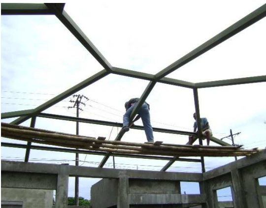
Fotografía 44: Construcción de estructura metálica para cubierta, Hogar Infantil La Florida.
