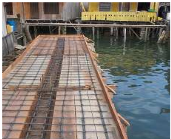
Fotografía 16: Armado de acero de refuerzo para viga aérea y losa maciza, puente Barracón, tramos 1, 2, 3, 4 y 5
