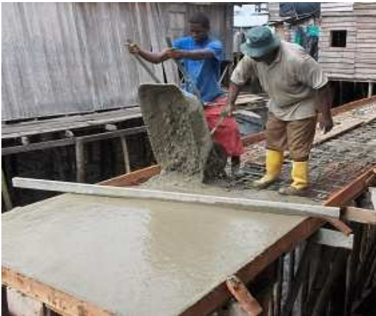
Fotografía 17: Fundición de viga aérea y losa maciza, puente Barracón, tramos 1, 2, 3, 4 y 5
