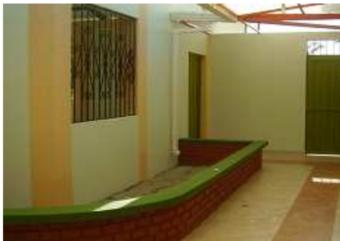
Fotografía 115: Proceso constructivo de jardinera en ladrillo limpio y concreto reforzado, Hogar Infantil Once de Noviembre.
