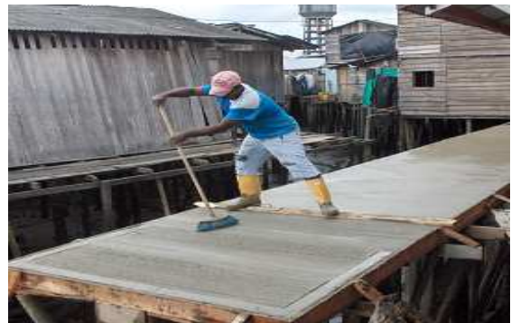
Fotografía 18: Acabado fina de losa maciza, puente Barracón, tramos 1, 2, 3, 4 y 5
