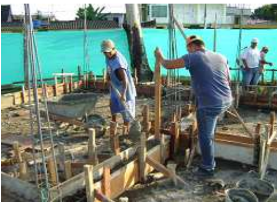
Fotografía 29: Fundición y curado de viga de cimentación, Hogar Infantil La Florida.
