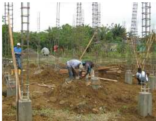
Fotografía 96: Fundición de pedestales y relleno con material del sitio, Hogar Infantil Once de Noviembre.
