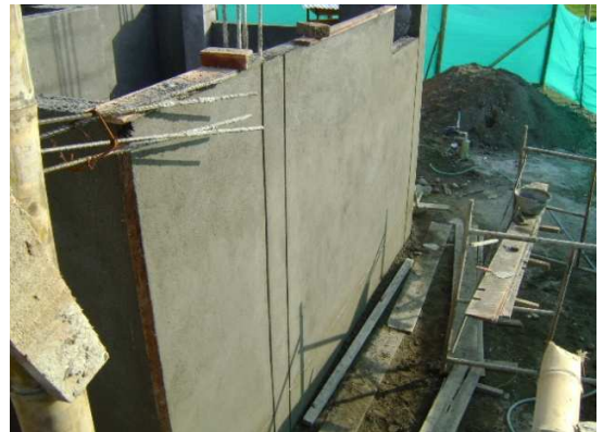
Fotografía 42: Repello de muros interiores y exteriores con sus respectivas dilataciones, Hogar Infantil La Florida.
