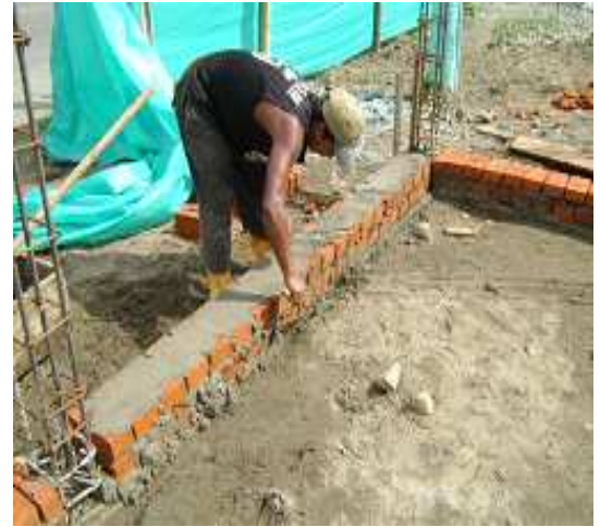
Fotografía 30: Pega de ladrillo en tizón sobre viga de cimentación para sobrecimiento, Hogar Infantil La Florida.
