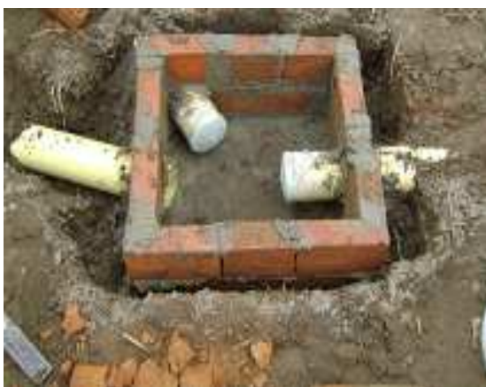
Fotografía 32: Instalación sanitaria con sus respectivas cajas de paso, Hogar Infantil La Florida.
