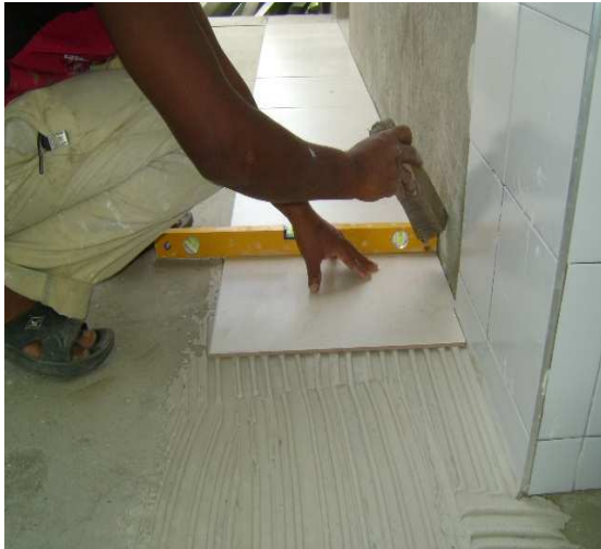
Fotografía 55: Asentamiento de cerámica, nivelación y fraguado de dilataciones, Hogar Infantil La Florida.
