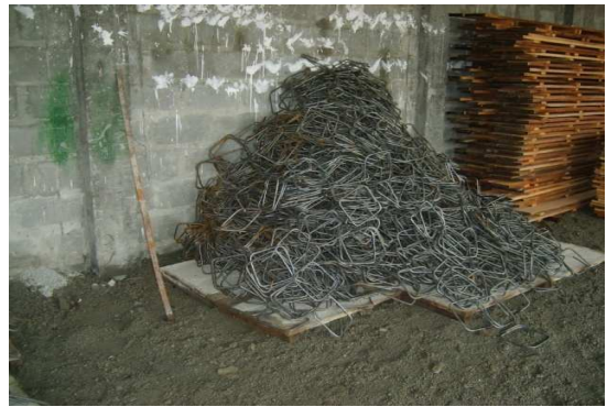
Fotografía 02: Figurado de acero de refuerzo para vigas y columnas, puente Barracón, tramos 1, 2, 3, 4 y 5
