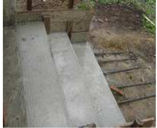
Fotografía 120: Construcción de escaleras en concreto reforzado, Hogar Infantil Once de Noviembre.
