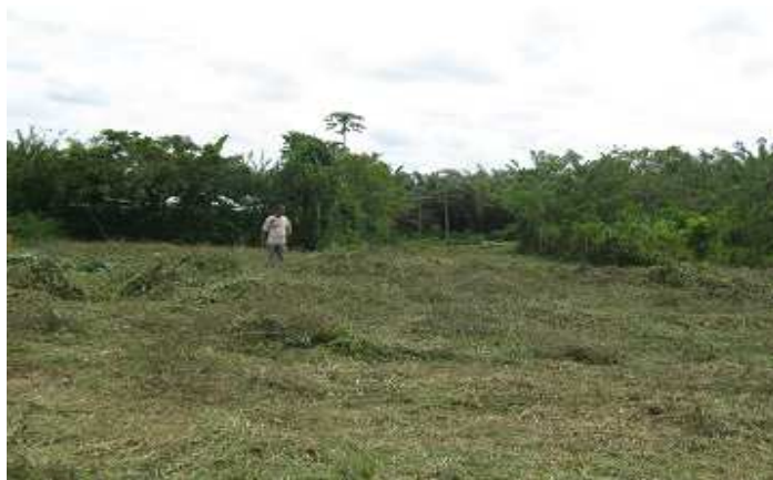
Fotografía 90: Descapote y limpieza de terreno, Hogar Infantil Once de Noviembre.
