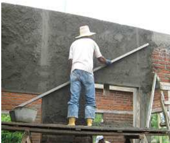
Fotografía 106: Repello interior de muros, vigas y columnas con sus respectivas dilataciones, Hogar Infantil Once de Noviembre.
