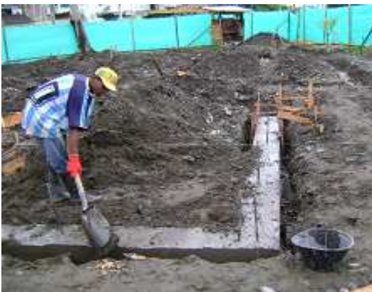
Fotografía 28: Relleno y compactación de zanjas con material para base, Hogar Infantil La Florida.
