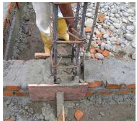
Fotografía 31: Fundición de pedestales a nivel de ladrillo en tizón, Hogar Infantil La Florida.
