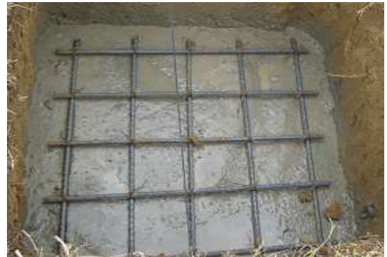
Fotografía 94: Figurado, armado de parrillas y fundición de solado para zapatas, Hogar Infantil Once de Noviembre.
