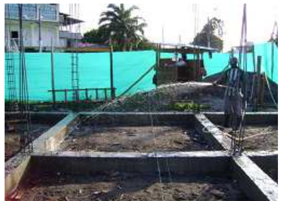
Fotografía 29: Fundición y curado de viga de cimentación, Hogar Infantil La Florida.
