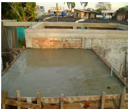
Fotografía 41: Proceso constructivo de placas para tanques elevados, Hogar Infantil La Florida.
