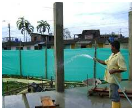
Fotografía 38: Fundición, desencofrado y curado de columnas, Hogar Infantil La Florida.
