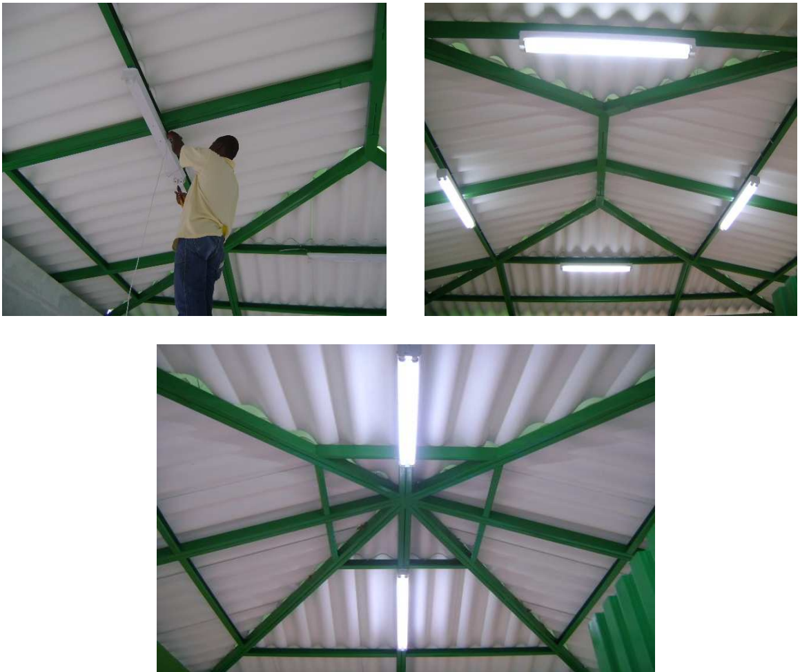
Fotografía 74: Instalación lámparas, Hogar Infantil La Florida.
