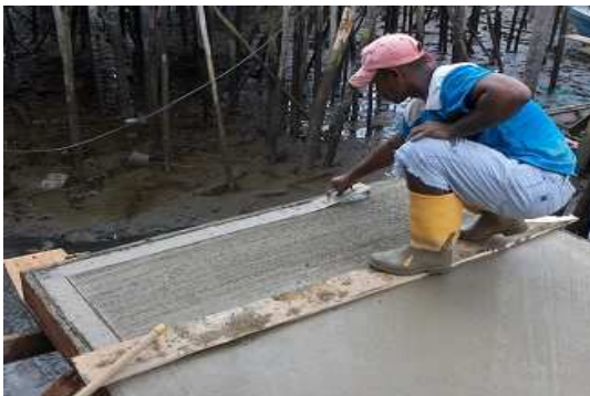
Fotografía 18: Acabado fina de losa maciza, puente Barracón, tramos 1, 2, 3, 4 y 5
