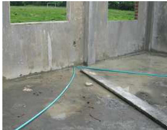
Fotografía 104: Instalación de tubería para la red eléctrica, Hogar Infantil Once de Noviembre.
