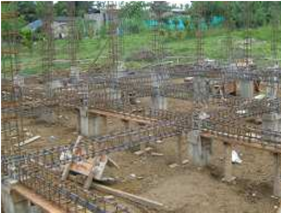
Fotografía 99: Encofrado y armado de acero de refuerzo de vigas de cimentación, Hogar Infantil Once de Noviembre.
