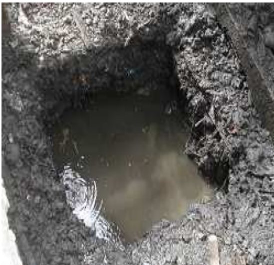
Fotografía 08: Excavación de zapatas hasta descubrir la cabeza de los pilotes, puente Barracón, tramos 1, 2, 3, 4 y 5
