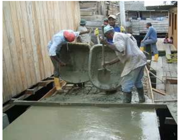
Fotografía 17: Fundición de viga aérea y losa maciza, puente Barracón, tramos 1, 2, 3, 4 y 5
