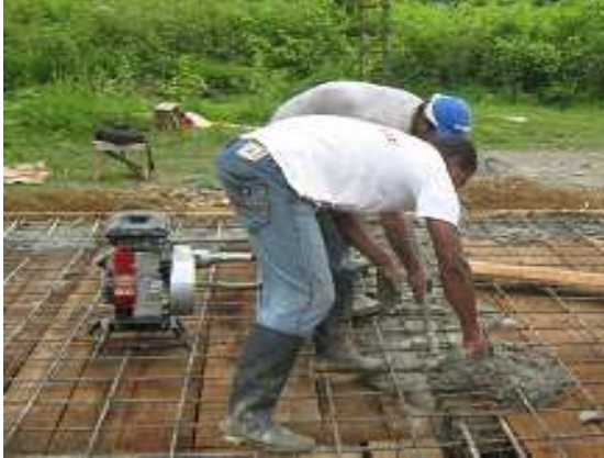
Fotografía 101: Fundición de vigas de cimentación y losa de piso en concreto reforzado, Hogar Infantil Once de Noviembre.
