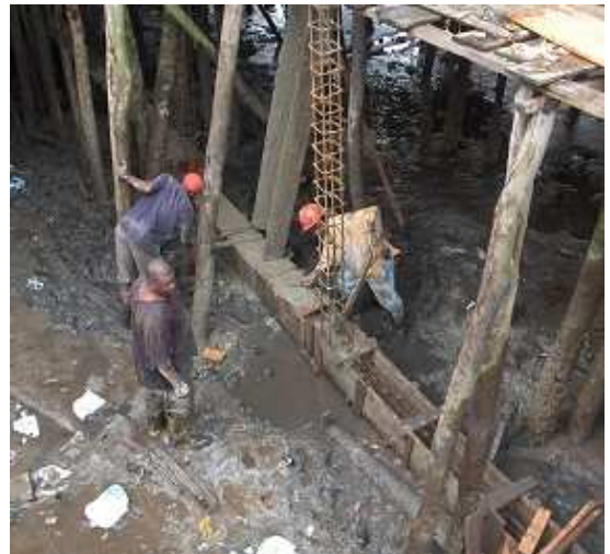
Fotografía 13: Encofrado, armado de acero y fundición de viga de cimentación, puente Barracón, tramos 1, 2, 3, 4 y 5
