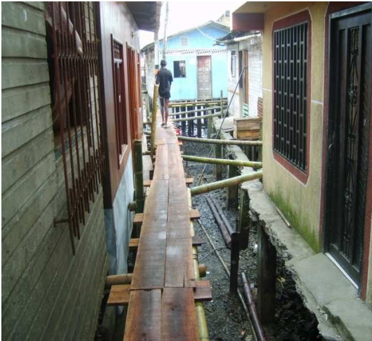
Fotografía 05: Construcción de puente provisional, puente Barracón, tramos 1, 2, 3, 4 y 5
