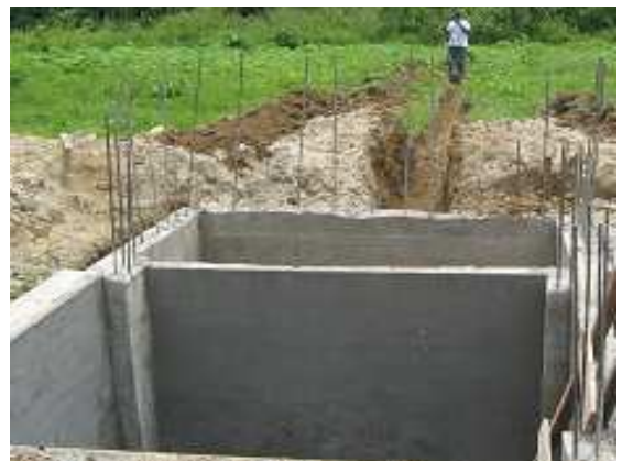
Fotografía 97: Instalación sanitarios y caja de inspección en concreto reforzado, Hogar Infantil Once de Noviembre.
