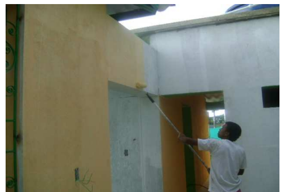
Fotografía 65: Aplicación de pintura de base y acabado sobre muros, Hogar Infantil La Florida.
