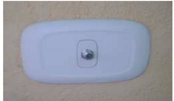
Fotografía 76: Instalación de toma telefónica y tevecable, Hogar Infantil La Florida.
