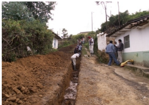
Figura 6. Excavación cámaras de quiebre
