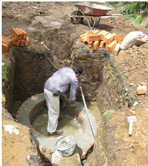
Figura 17. Elevación de muros
