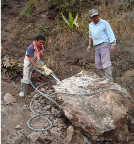
Figura 78. Voladura de roca
