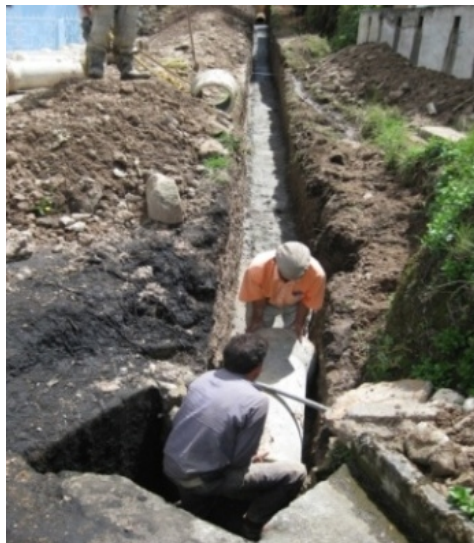
Figura 11. Desagüe en alcantarilla existente
