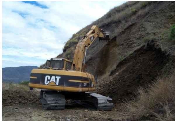
Figura 80. Corte de talud
