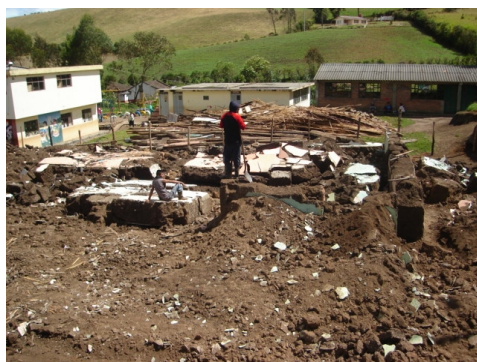
Figura 131. Desalajo de escombros
