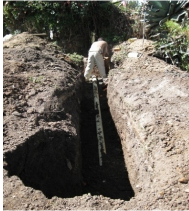
Figura 28. Conexión a tubería de concreto
