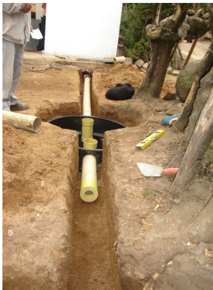
Figura 125. Pozo séptico
