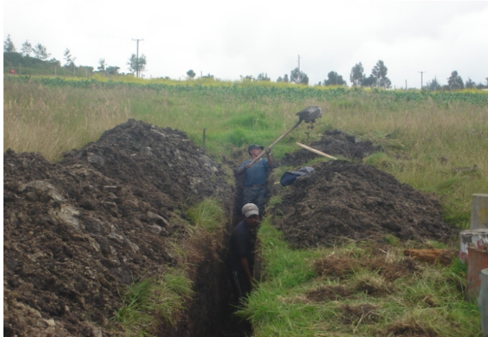
Figura 57. Excavación a mano
