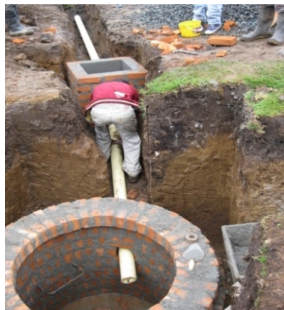
Figura 27. Conexión a cámara
