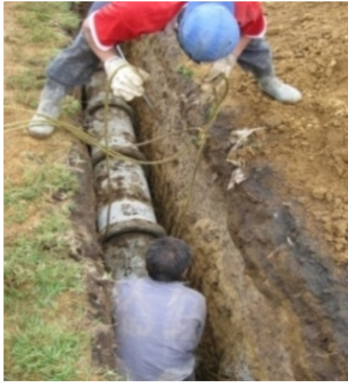
Figura 12. Colocación de tubería
