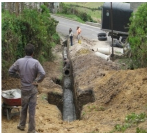
Figura 13. Chequeo acople tubería
