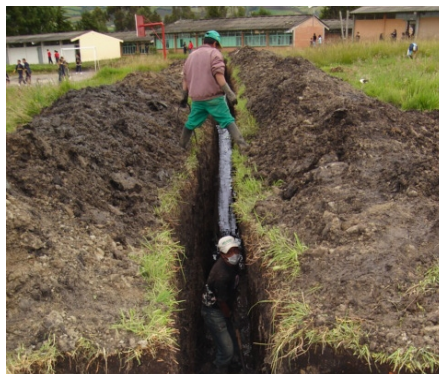
Figura 59. Colocación de Tubería
