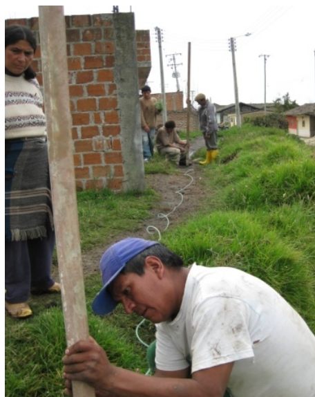
Figura 38. Levantamiento perfil del terreno
