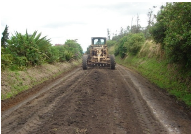
Figura 97. Nivelación y perfilado
