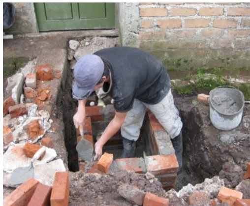
Figura 54. Elevación de muros
