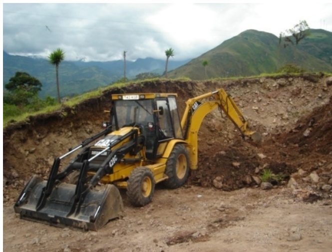
Figura 90. Corte de talud
