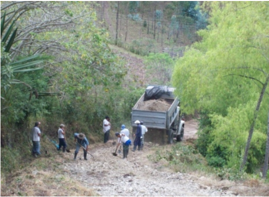
Figura 84. Limpieza de cunetas
