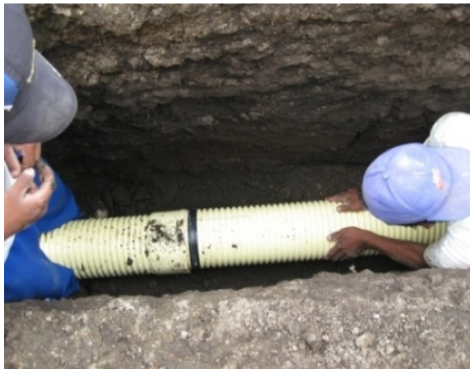
Figura 44. Empalme de tubería
