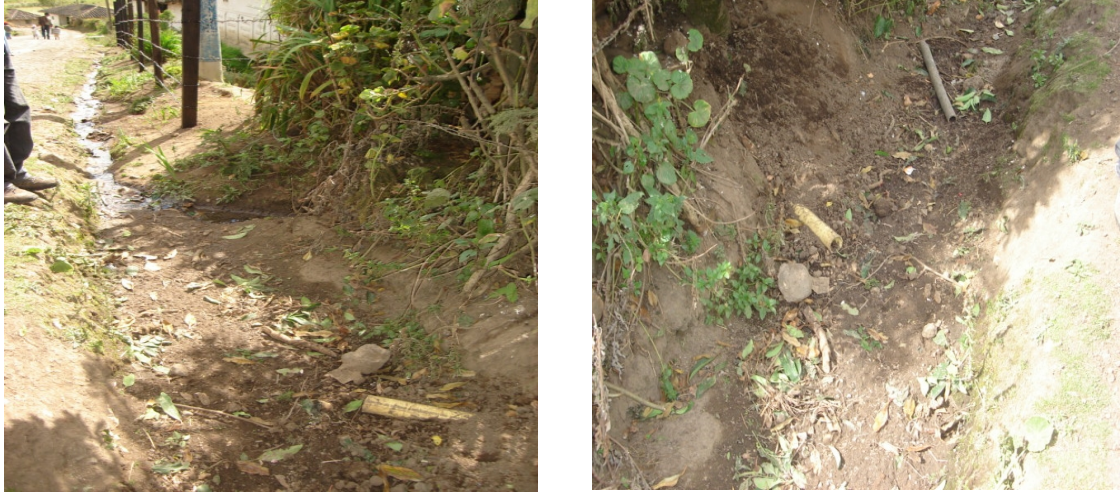
Figura 128. Evacuación de agua tratada a cunetas
