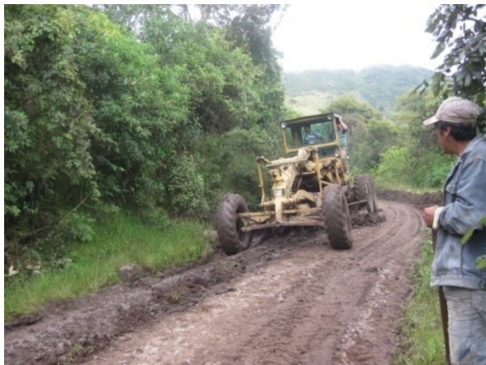
Figura 98. Inclinación de hoja vertedera
