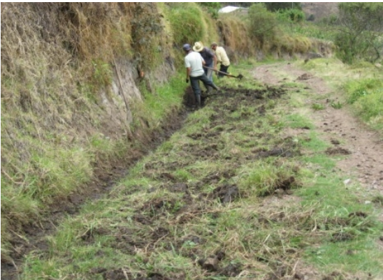
Figura 84. Limpieza de cunetas
