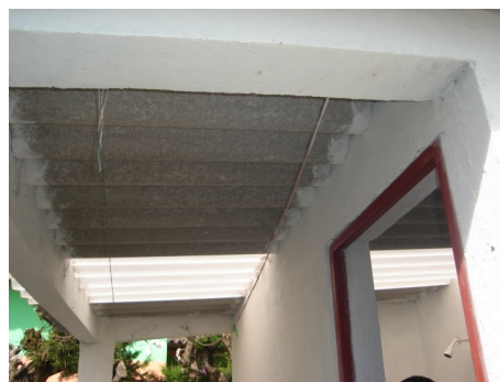
Figura 122. Teja fibrocemento y traslúcida
