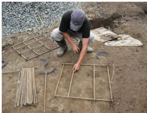
Figura 24. Acero de refuerzo
