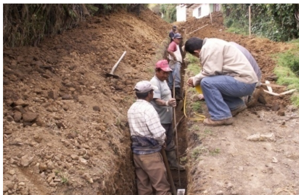
Figura 7. Verificación de profundidad
