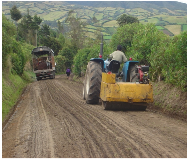
Figura 108. Compactación centro de vía
