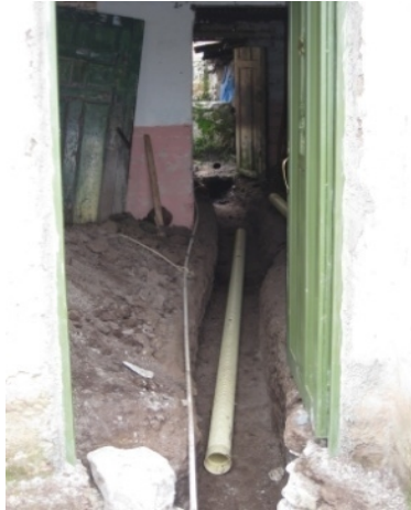
Figura 46. Perforación de tubería
