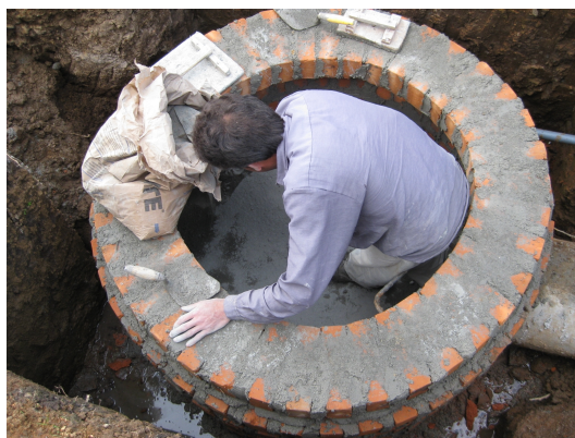
Figura 20. Impermeabilización
