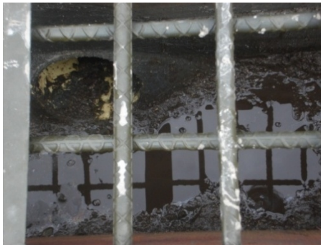
Figura 34. Tubería 4" de diámetro
