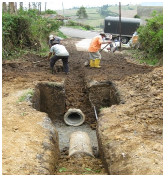
Figura 15. Relleno de la zanja
