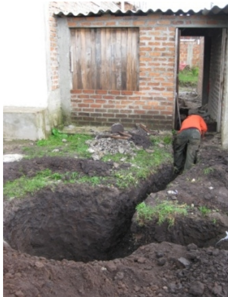
Figura 42. Excavación cajillas
