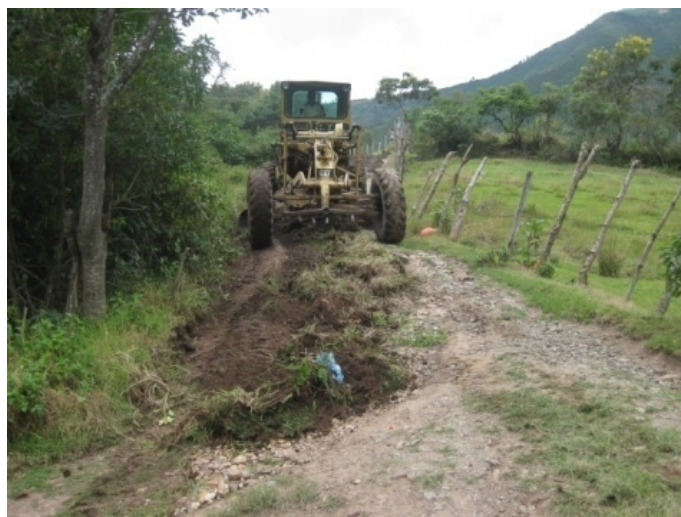
Figura 99. Excavación de cunetas
