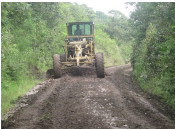
Figura 95. Extensión de material
