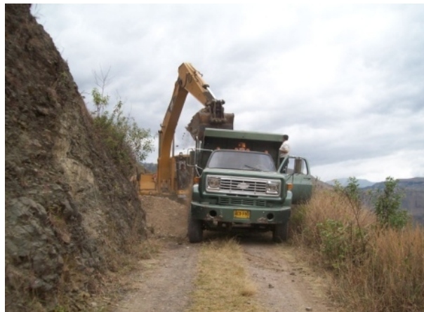
Figura 81. Cargue de material
