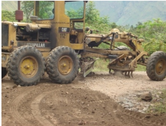
Figura 100. Aireación de material
