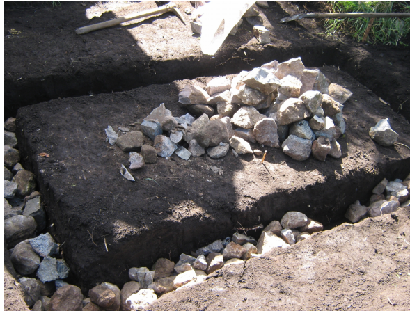
Figura 115. Cimentación en concreto ciclópeo
