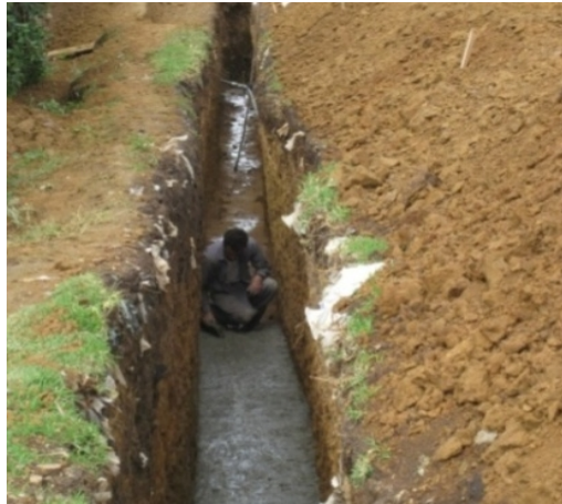
Figura 10. Colocación de solado
