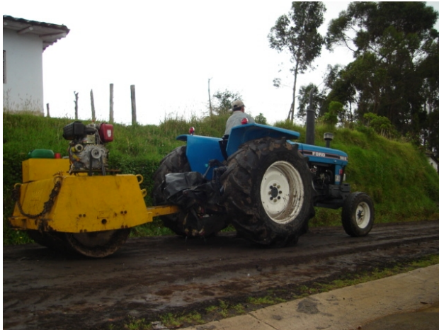
Figura 107. Cilindro liso Vibratorio
