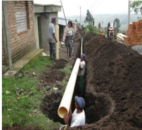
Figura 43. Colocación de tubería PVC
