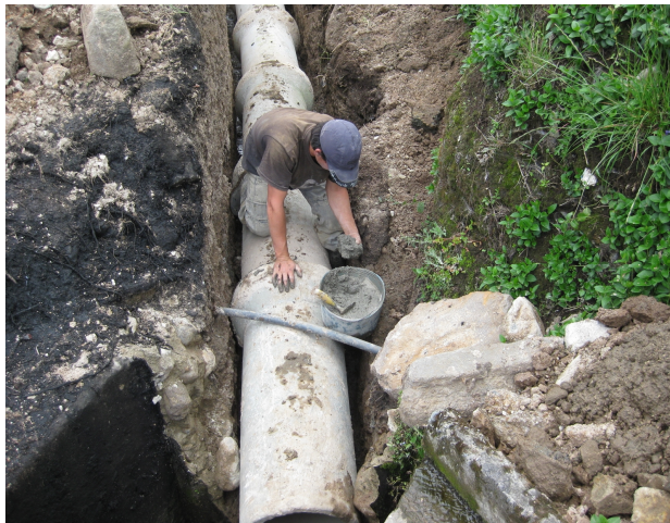
Figura 14. Sellamiento de campanas
