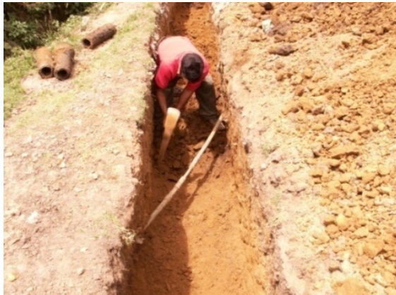
Figura 8. Red de agua potable
