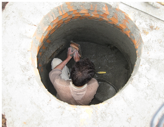
Figura 20. Impermeabilización
