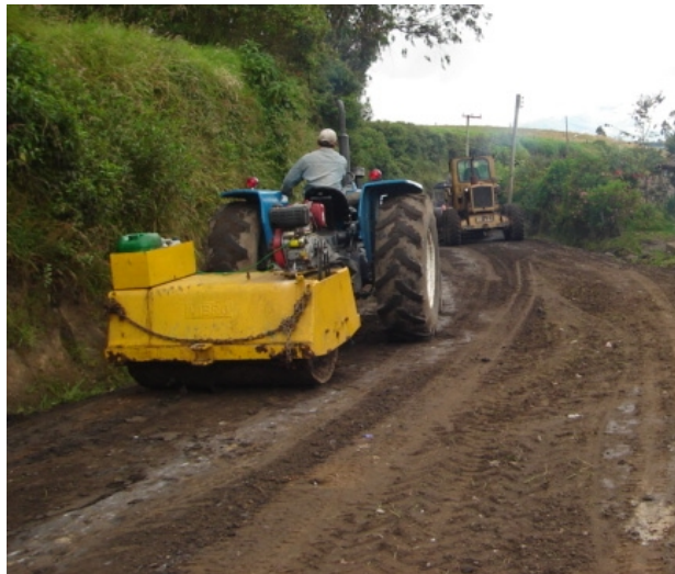
Figura 109. Compactación borde de vía
