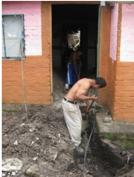
Figura 42. Excavación cajillas
