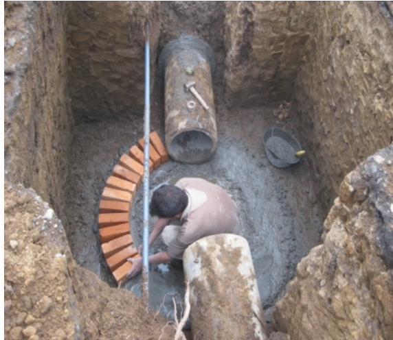
Figura 16. Solado cámara de inspección
