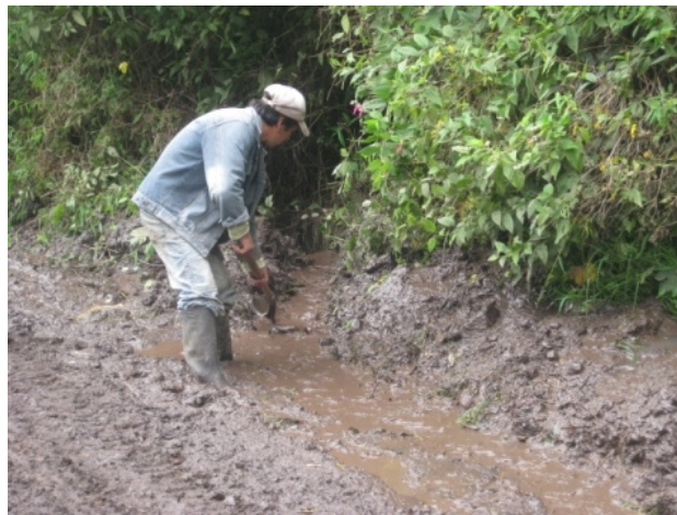
Figura 103. Limpieza de cunetas
