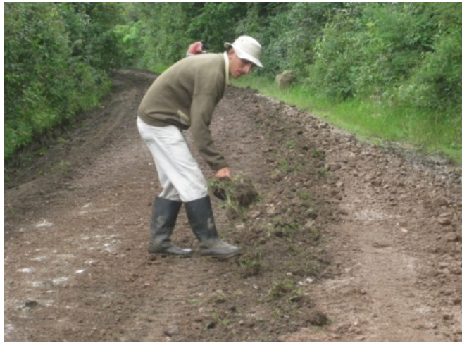
Figura 103. Limpieza de cunetas
