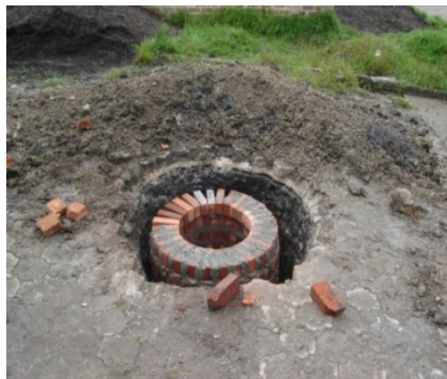
Figura 52. Cámara que conecta la red existente con alcantarillado nuevo.
