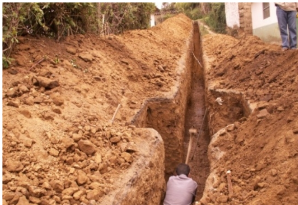
Figura 6. Excavación cámaras de quiebre
