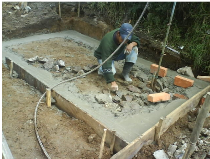
Figura 115. Cimentación en concreto ciclópeo
