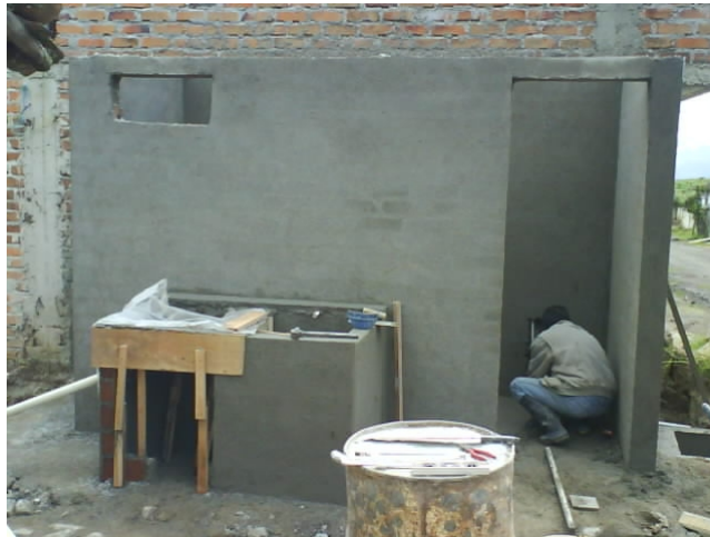
Figura 119. Repello e impermeabilizado
