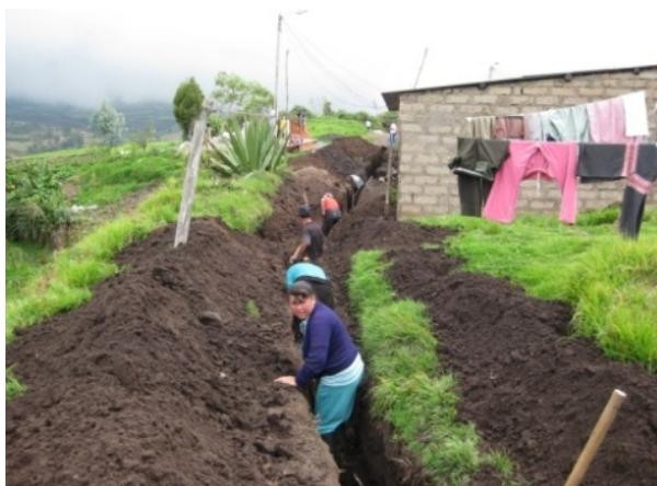
Figura 40. Excavación para tubería
