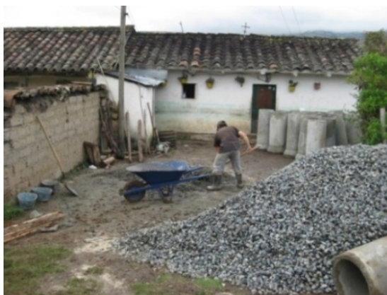
Figura 9. Elaboración de mezcla
