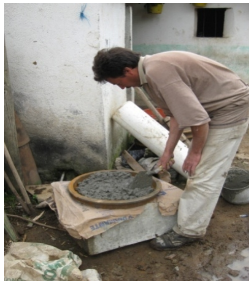
Figura 22. Vaciado del concreto
