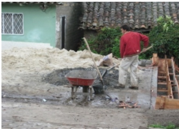
Figura 32. Elaboración de mezcla
