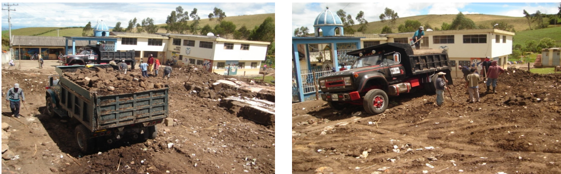
Figura 132. Transporte de escombros
