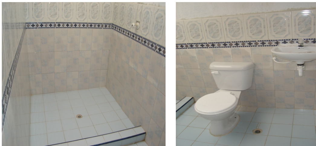
Figura 121. Enchape de piso y muros
