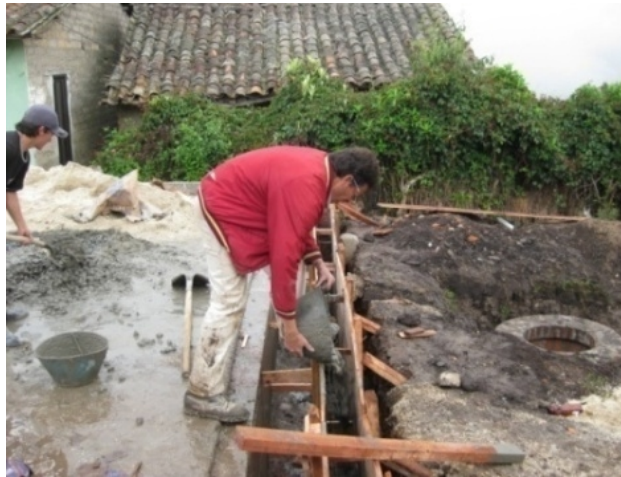
Figura 33. Vaciado del concreto
