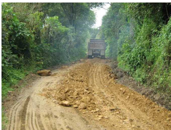
Fotografía N° 96 Extendido De Material Para Conformación De Calzada.
