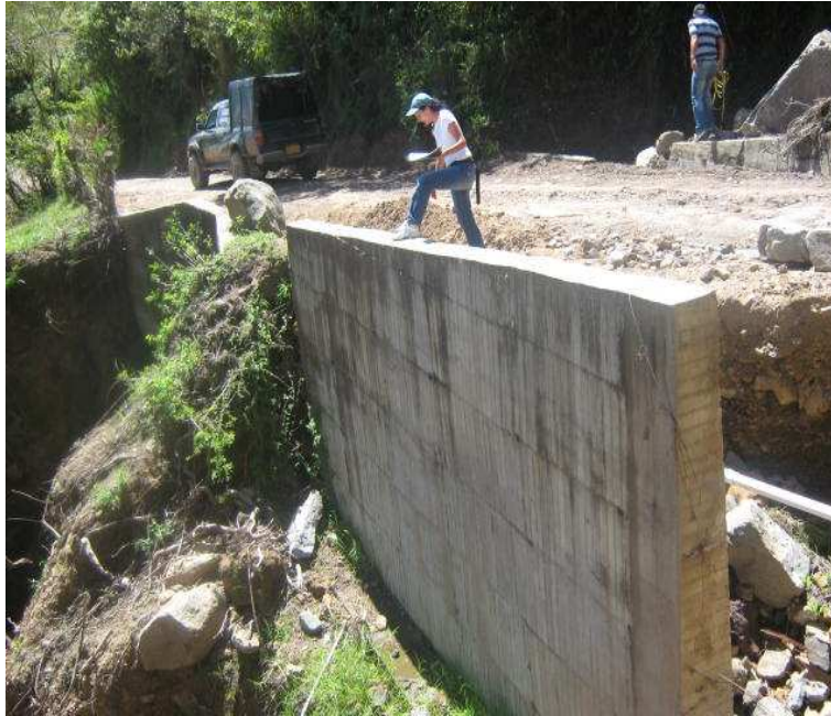
K 1+0300; N1 38.190 W77 01.506 Muro de contención en concreto reforzado.
