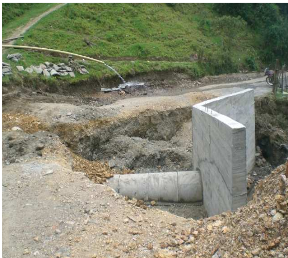
Fotografía N° 90 Construcción de alcantarilla de 36”.
