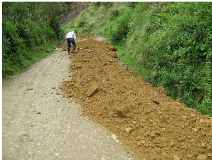
Fotografía N° 96 Extendido De Material Para Conformación De Calzada.
