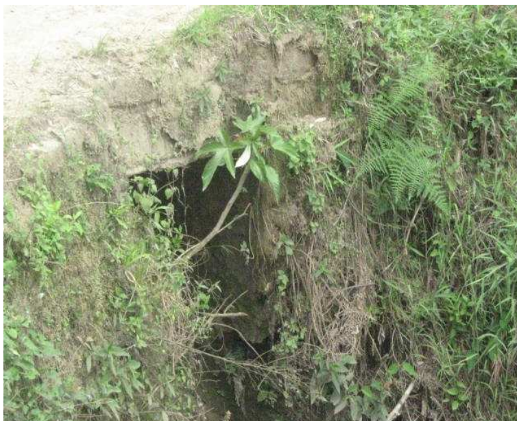
K 2+0550, N1 39.419 W77 04.270. Box culvert falta de mantenimiento y rocería pero funcionan bien.
