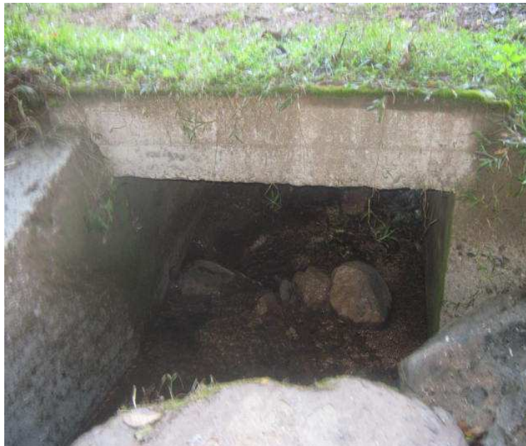
K 1+0900; N1 38.103 W77 01.676, Box Coulvert en buen estado, Falta de mantenimiento.
