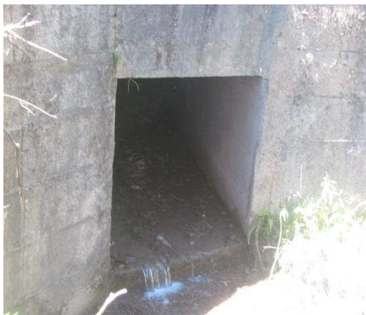
K 3+0390, N1 37.783 W77 02.067, Box culver Buen funcionamiento ya que son construcción nueva.
