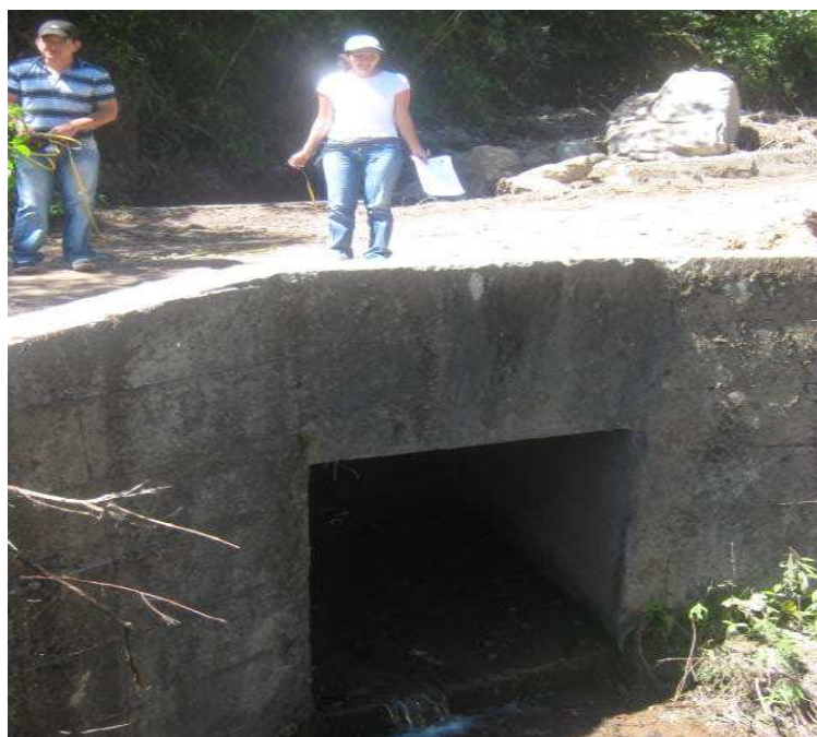
K 9+0850, N1 38.090 W77 03.120. Box coulver Buen funcionamiento ya que son construcción nueva.
