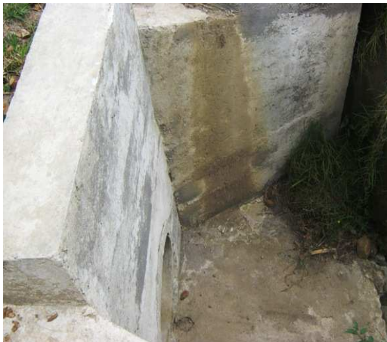
K 1+0600; N1 34.251 W76 57.369. Alcantarilla de 36", Caja de entrada y salida de alcantarilla de 36", en buen estado.
