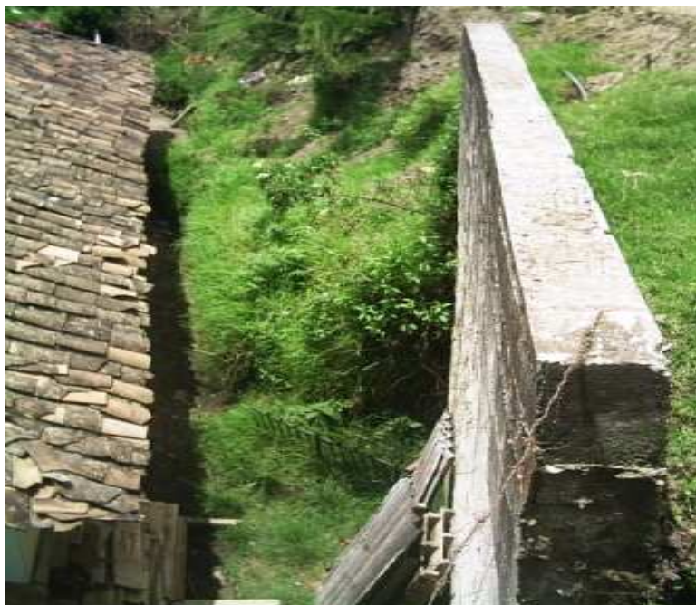
K 3+0180; N1 36.449 W77 00.377. Muro en concreto reforzado en buen estado de longitud de 7m.
