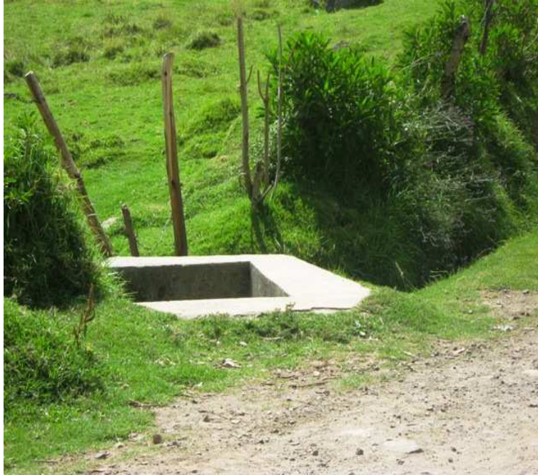
K 2+0200, N1 33.825 W76 55.530. Alcantarilla 36" nueva buen funcionamiento.
