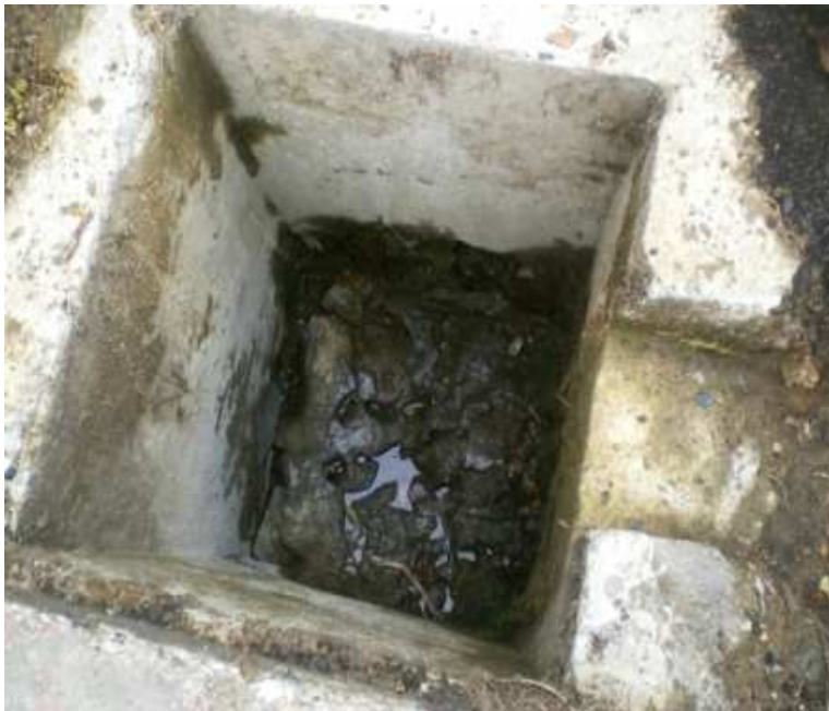
K 9+0600; Caja de entrada de alcantarilla, N1 36.520 W77 03.767
