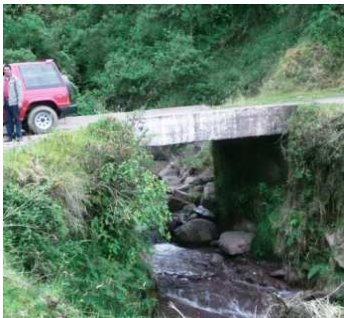
K 3+0900, Pontón en concreto, N1 35.465 W77 02.480.
