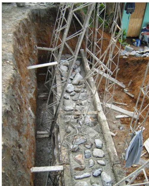
Fotografía N° 92 Construcción De Un Muro En Concreto Reforzado.
