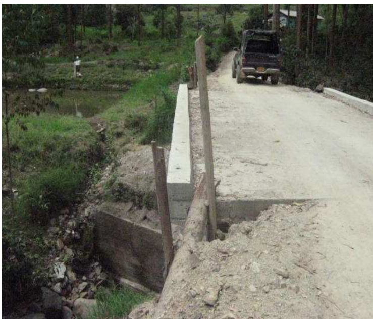
K 0+0900; N1 39.700 W77 03.875, Puente nuevo, construido sobre uno existente Buen estado.
