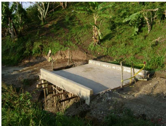
Fotografía N° 93 Construcción De Un Pontón.
