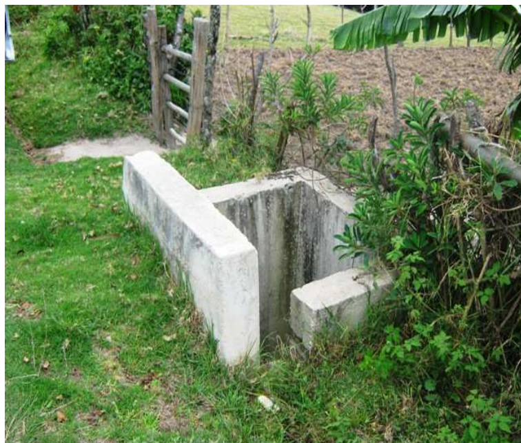
K 2+0200; N1 37.365 W76 58.522. Alcantarilla de 36", en buen estado.
