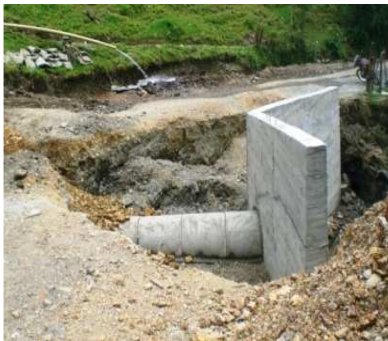
K 6+0900; N1 37.164 W77 01.064. Alcantarilla de 36", en construcción.
