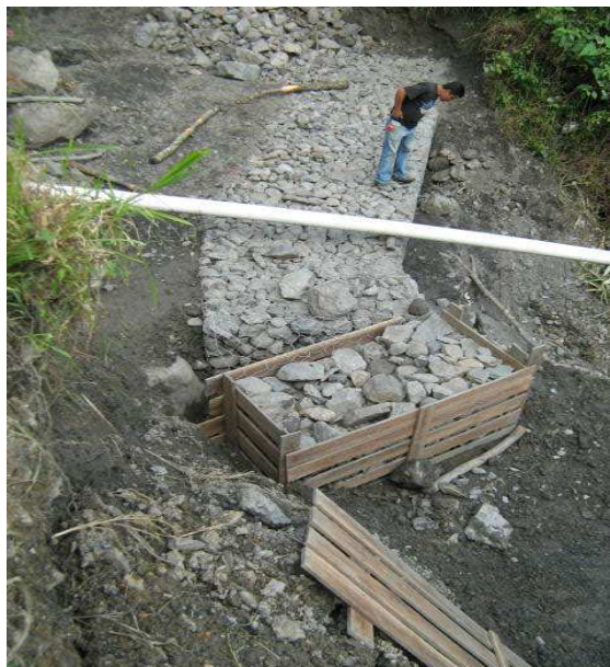
Fotografía N° 91 Construcción De Un Muro En Gaviones.
