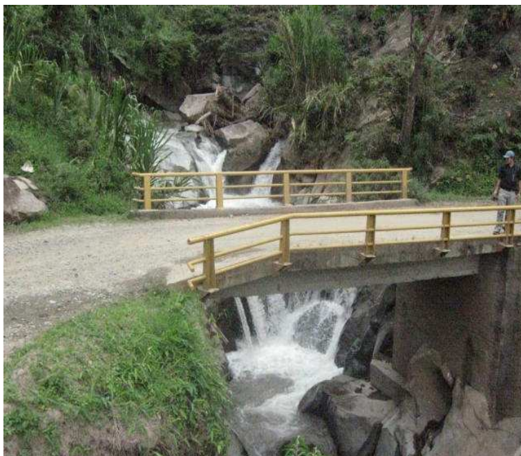
K 8+0700; N1 37.789 W77 05.749. Puente en concreto En buen estado.
