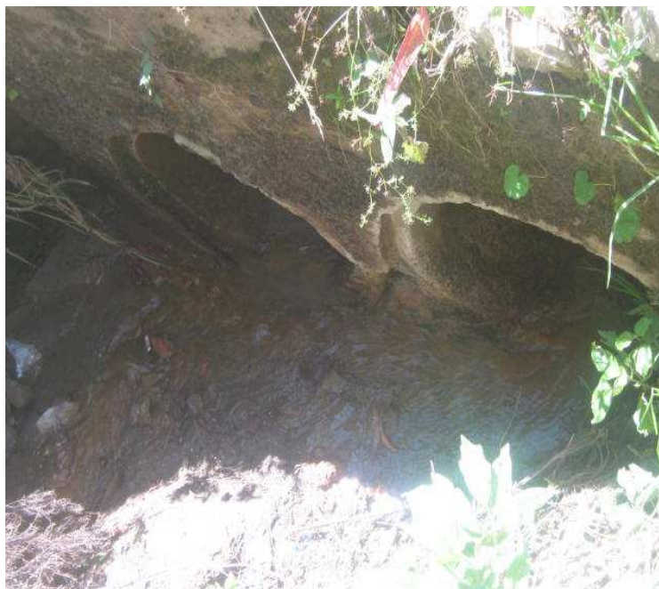
K 4+0000, N1 37.771 W77 02.269, Alcantarilla gemela caja de salida en buen estado sin mantenimiento.
