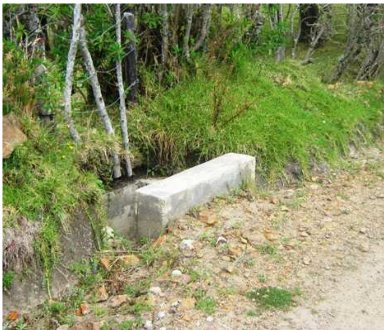
K 1+0600; N1 34.251 W76 57.369. Alcantarilla de 36", Caja de entrada, en buen estado.
