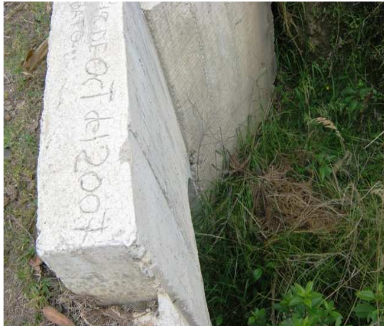
K 1+0100; N1 36.931 W76 58.308. Alcantarilla de 36", en buen estado.
