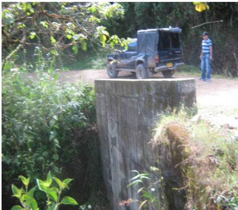
K 2+0600; N1 37.935 W77 01.888 Muro de contención en concreto reforzado.
