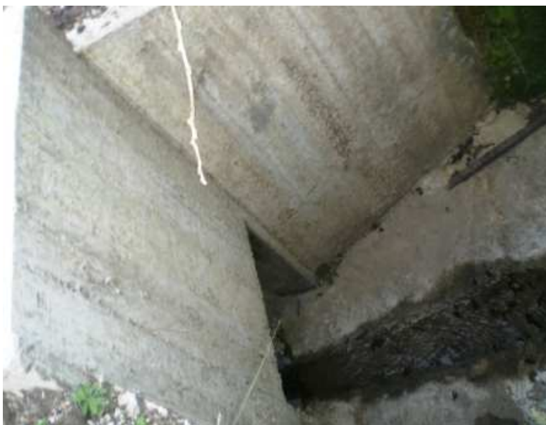
K 11+0600; Salida de alcantarilla, N1 36.841 W77 03.915.
