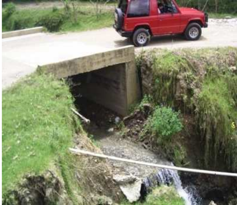
K 1+0800; N1 36.360 W77 00.856, Pontón en buen estado
