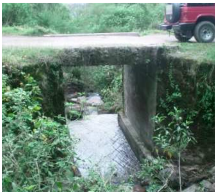
K 4+0700, Pontón en concreto, N1 35.514 W77 02.702.
