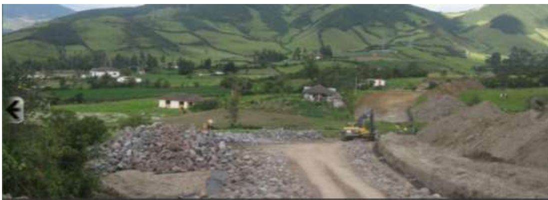
Imagen 71 vía en construcción variante paso por Pasto DEVINAR
