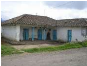
Imagen 24 viviendas en el corregimiento de mocondino
