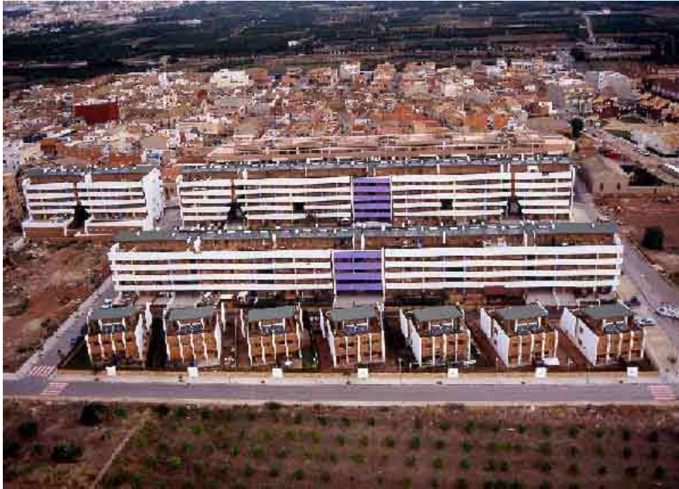
Imagen 17 vista general de URBANIZACIÓN LLIRI BLAU (ESPAÑA).
