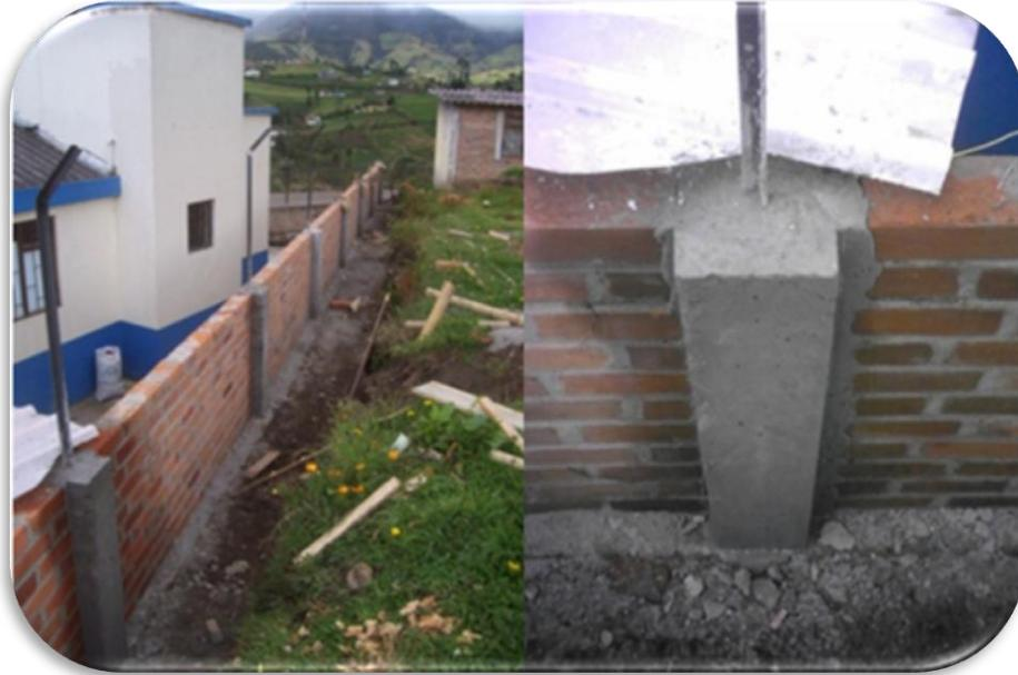
**Ilustración 28: Repello de columnas**
