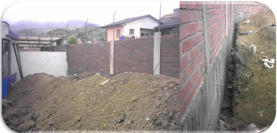
**Ilustración 29: Desencofrado columnas Muro No 2**
