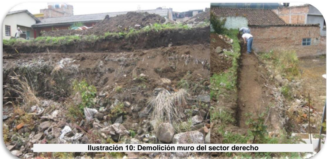
Se realiza de demolición del muro existente, para continuar con la remoción de material y seguir con la excavación para el muro de contención.
