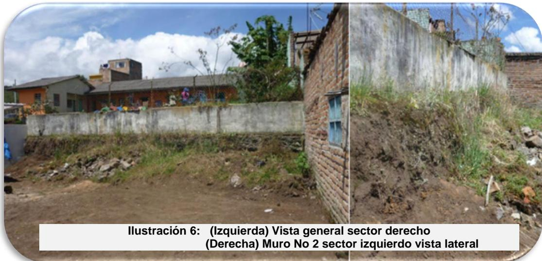
Muro que separa el centro de salud con la institución que será demolido y se construirá un muro de contención, columnas y malla.
