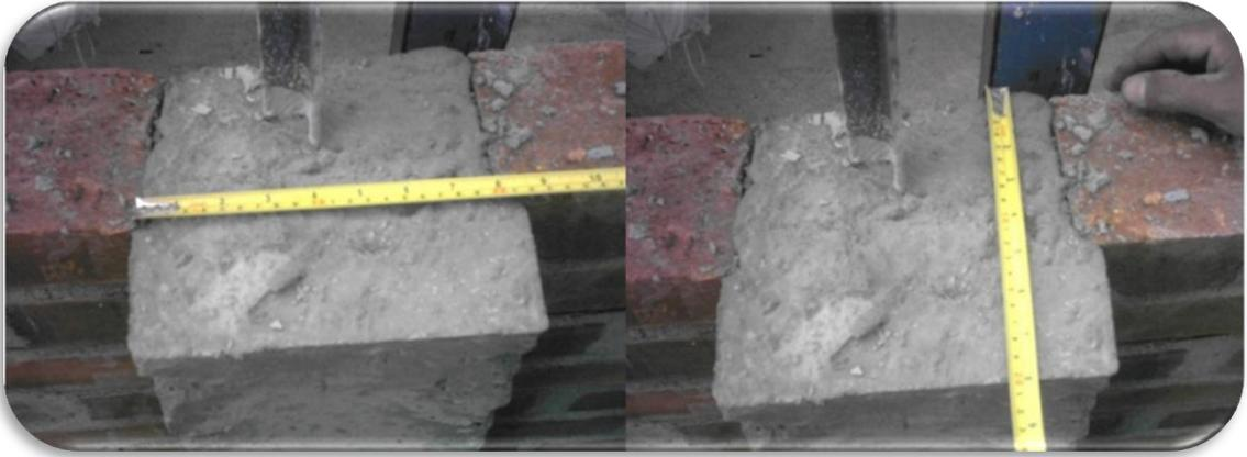
**Ilustración 26: Revisión medidas de columnas**
