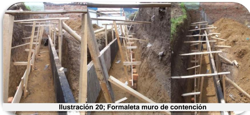
**Ilustración 20; Formaleta muro de contención**
