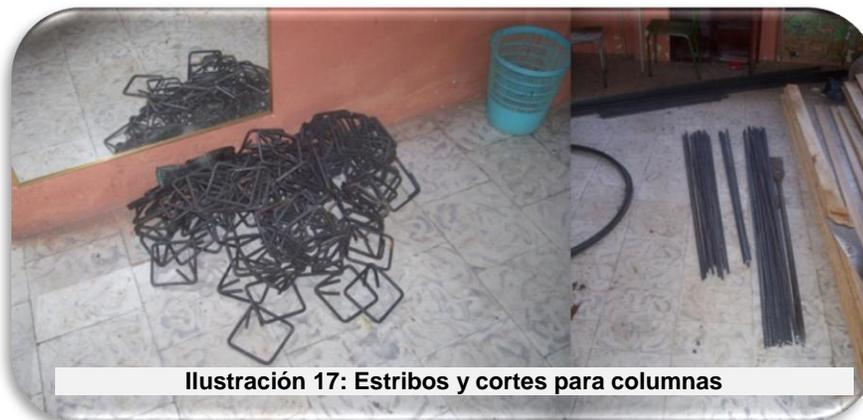
Se elaboran estribos y se prepara el refuerzo para columnas.
