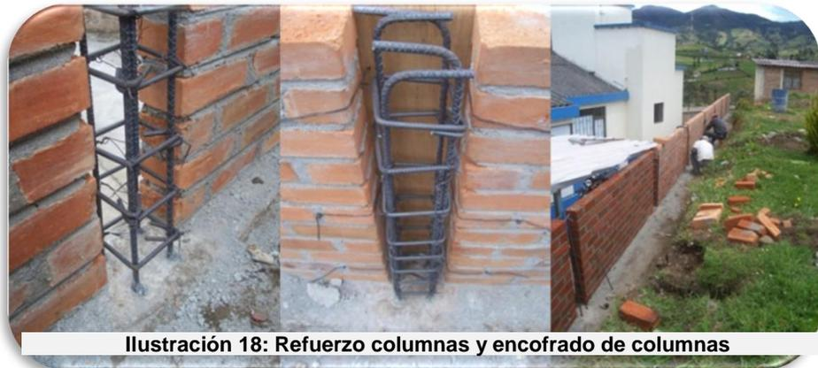
**Ilustración 18: Refuerzo columnas y encofrado de columnas**
