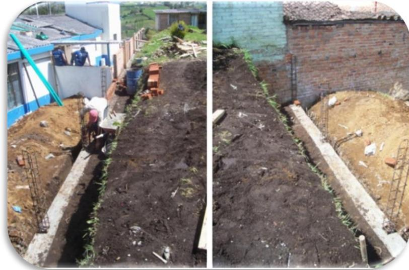
**Ilustración 24: Relleno muro de contención**
