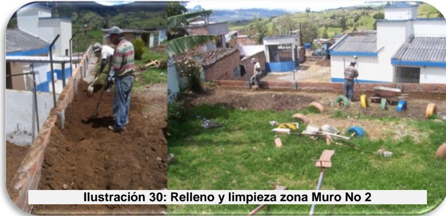
Se realiza el relleno de la parte posterior del muro de contención.
