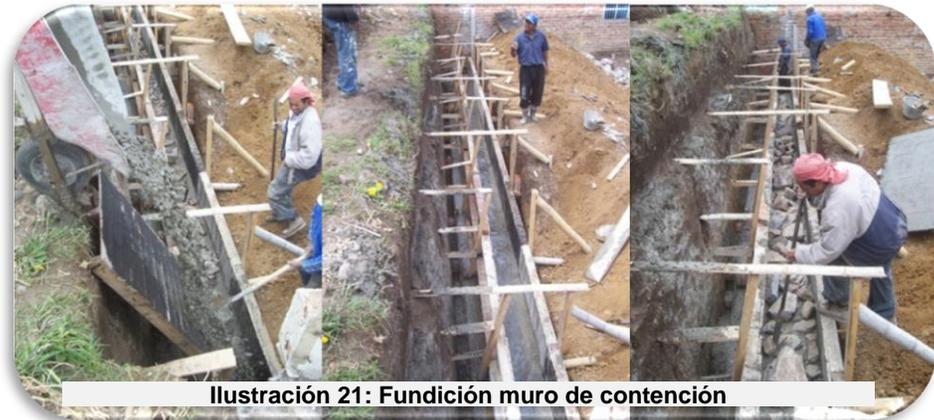
Se procede hacer el vaciado de concreto ciclópeo para el muro de contención.
