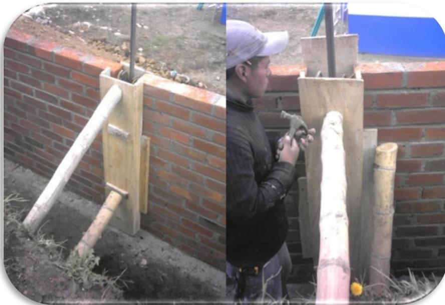
**Ilustración 27: Formaleteo columnas muro No 2**
