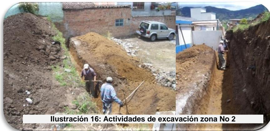
Se continua con la excavación para la construcción del muro de contención.
