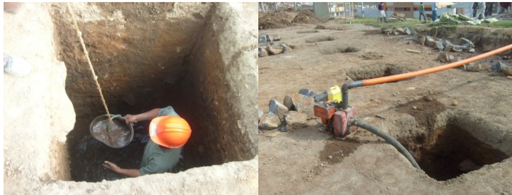
Figura 109. Extracción de agua del nivel freático
