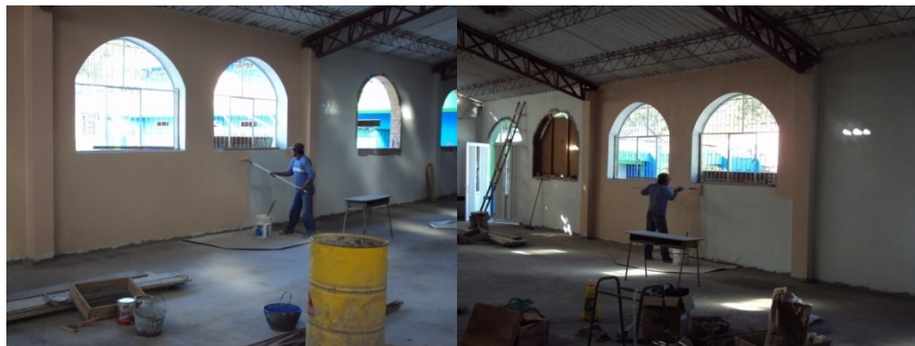
Figura 59. Pintura de muros interiores
