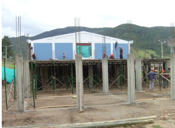
Figura 114. Armado de formaleta para losa aligerada
