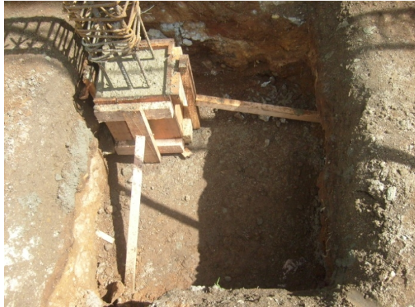
Figura 112. Fundición de pedestales
