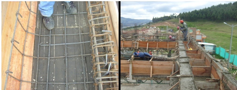
Figura 122. Viga canal
