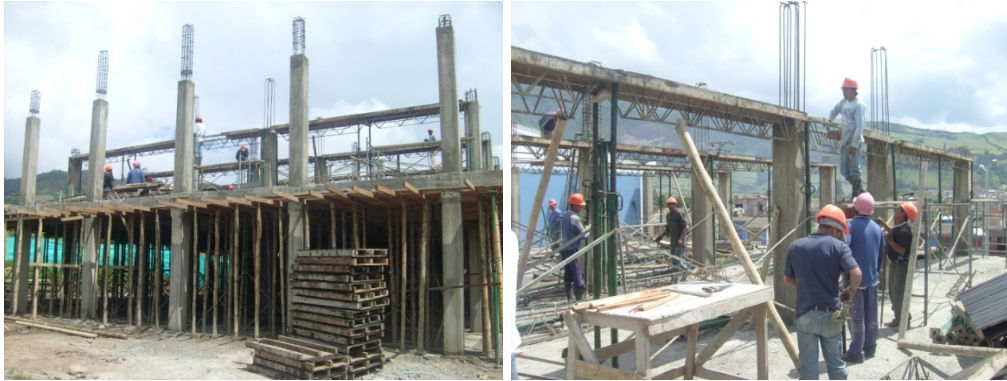
Figura 121- Armado de vigas N + 6.00
