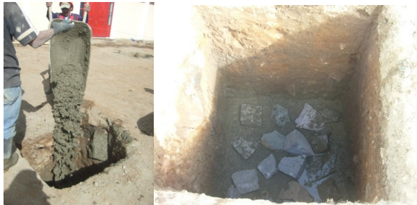
Figura 110. Vaciado de concreto ciclópeo para cimientos
