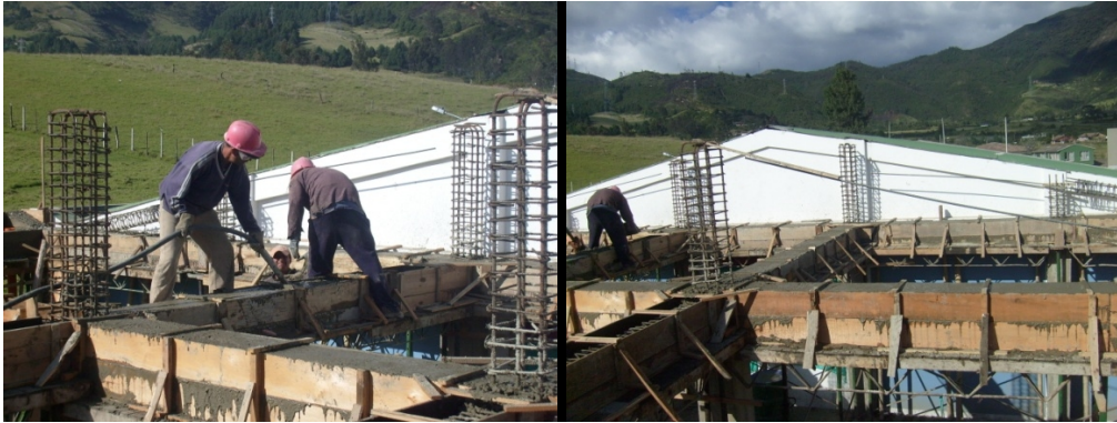
Figura 123. Fundición de vigas N+ 6.00
