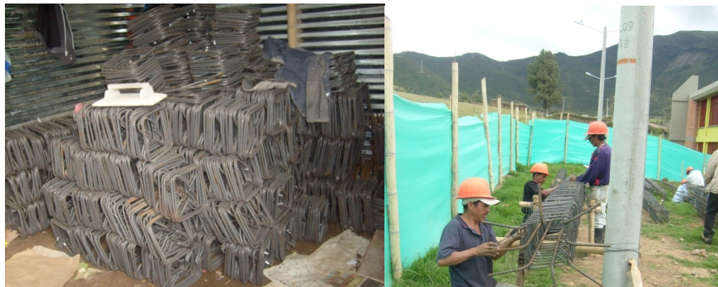
Figura 111. Figurado y amarre de hierro para columnas
