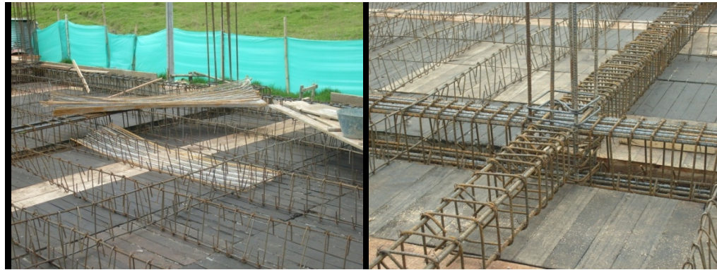
Figura 116. Armado de nervios y vigas de entrepiso
