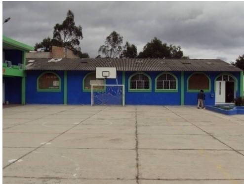
Figura 48. Fachada principal - Aula Múltiple I.E.M José Antonio Galán
