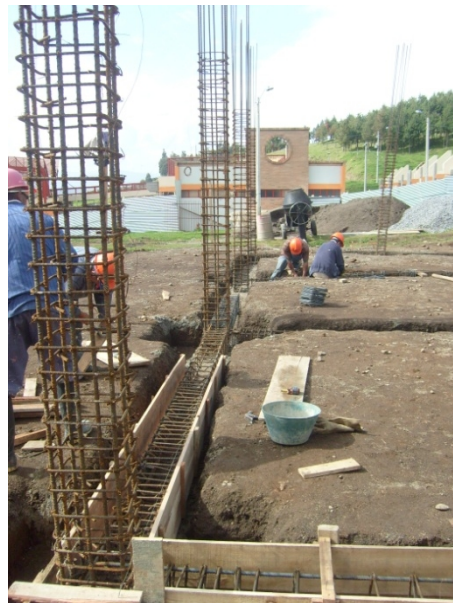
Figura 113. Armado de vigas de cimentación y columnas
