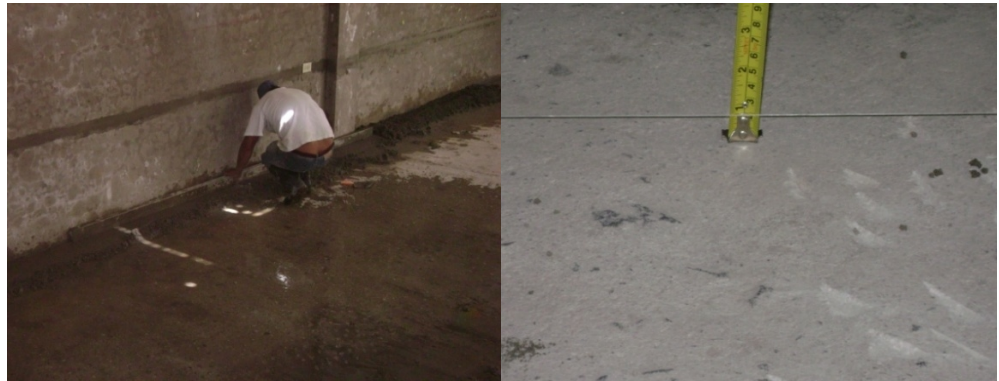
Figura 58. Afinado de pisos y chequeo de niveles
