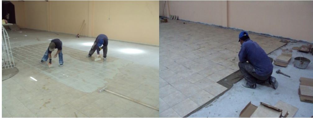
Figura 60. Instalación de cerámica
