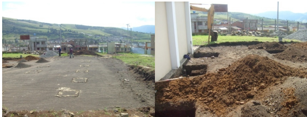
Figura 107. Localización y excavación de zapatas
