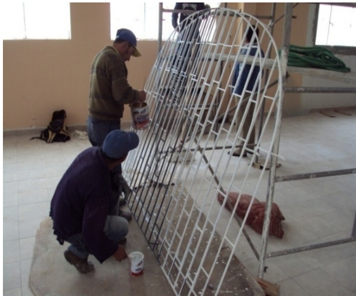
Figura 64. Instalación de antepechos
