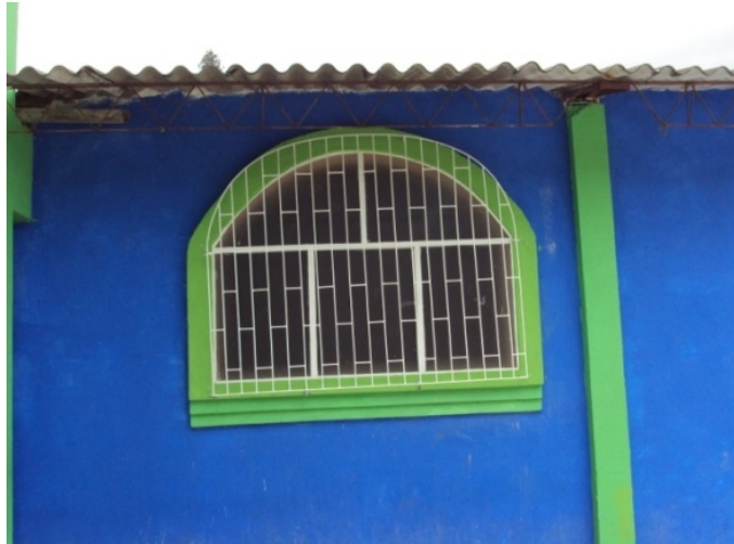
Figura 68. Ventanas aula múltiple (Instalación de ventanas y antepechos)
