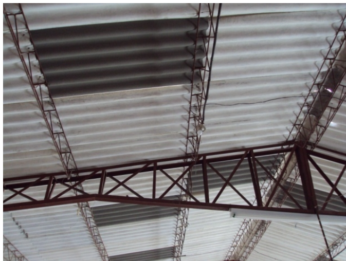
Figura 66. Cubierta aula múltiple
