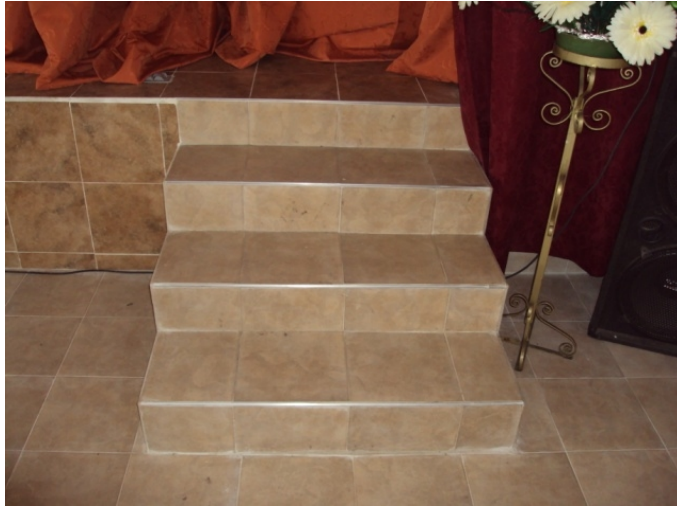
Figura 67. Escaleras aula múltiple (Fundición y enchape de escaleras)
