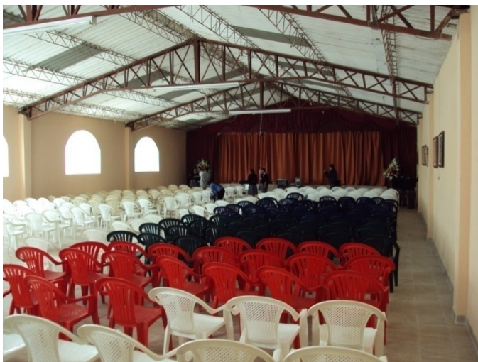
Figura 69. Aula Múltiple (estado final de la obra)
