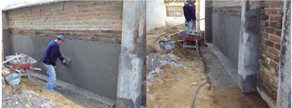
Figura 55. Impermeabilización de muros exteriores
