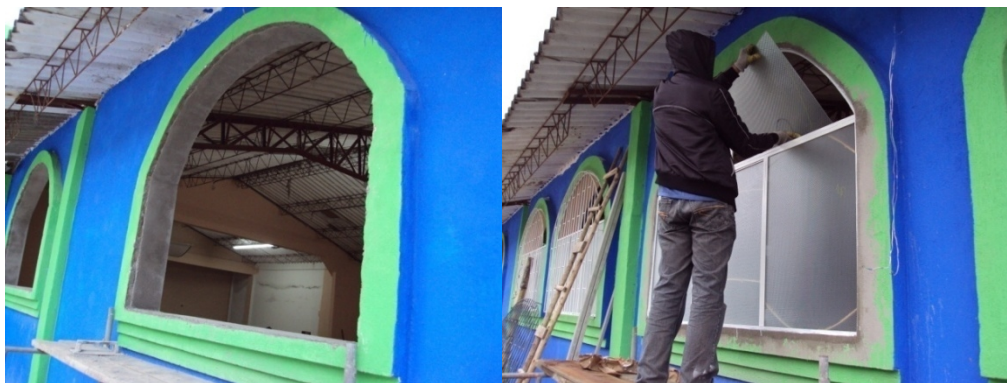
Figura 62. Instalación de ventanas en vidrio grafilado
