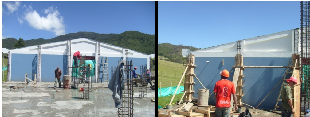
Figura 120. Armado de columnas 2° piso
