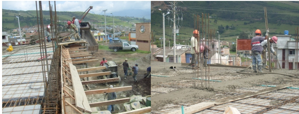
Figura 119. Fundición de losa aligerada
