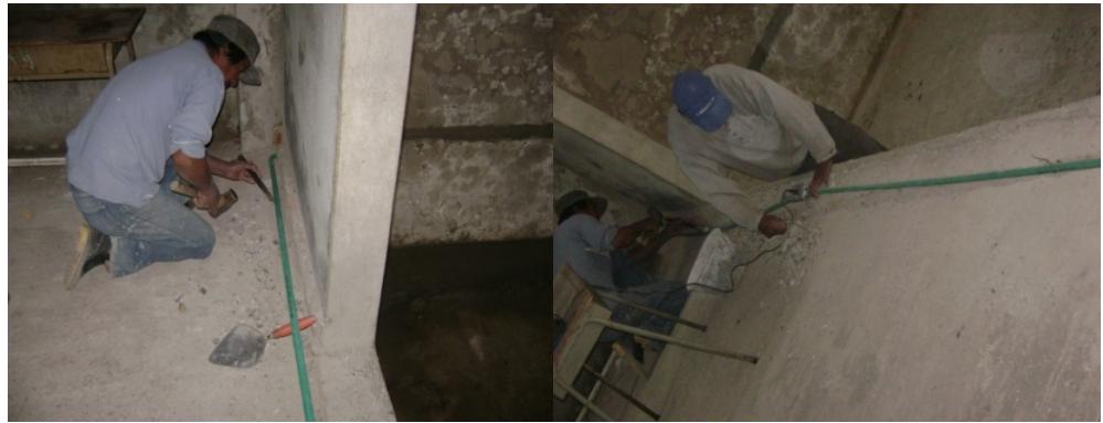
Figura 57. Adecuación de Instalaciones eléctricas
