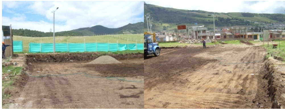
Figura 106. Compactación en recebo placa de contrapiso
