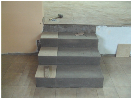
Figura 61. Enchape de escaleras
