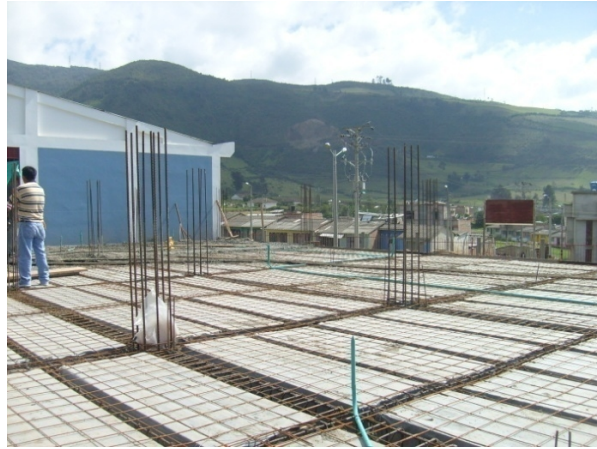
Figura 118. Refuerzo para losa aligerada
