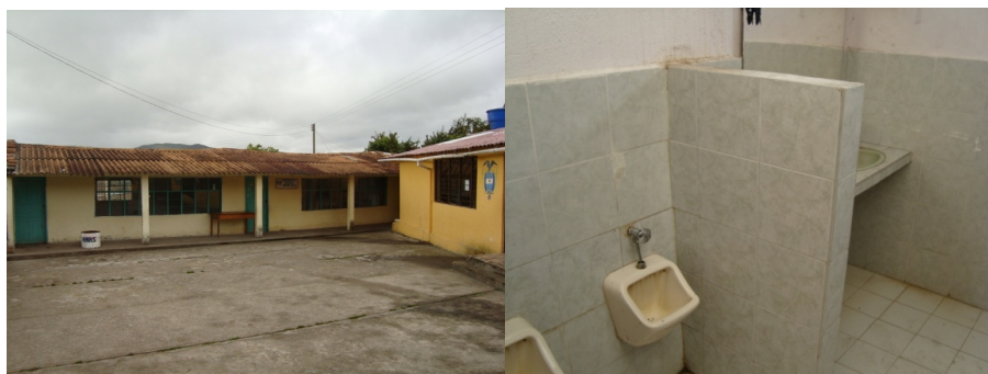
Figura 40. Tipología arquitectónica, Batería sanitaria - E.R.M Cubijan Alto
