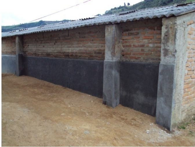
Figura 65. Fachada posterior aula múltiple (Muro impermeabilizado)
