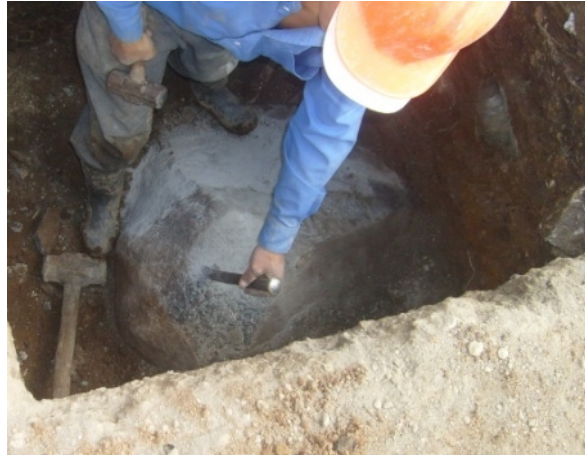
Figura 108. Corte de piedra
