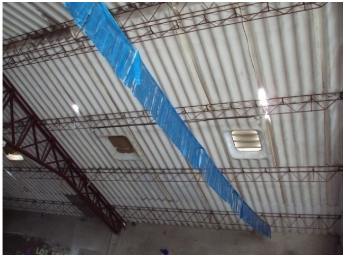
Figura 50. Cubierta aula múltiple
