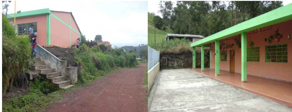
Figura 43. Tipología arquitectónica - E.R.M San Antonio de Acuyuyo
