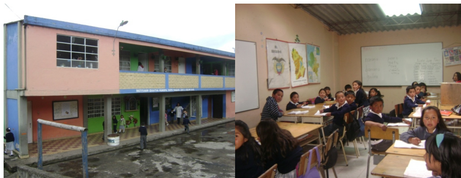
Figura 39. Tipología arquitectónica, Aula de clase - E.R.M Cubijan Bajo
