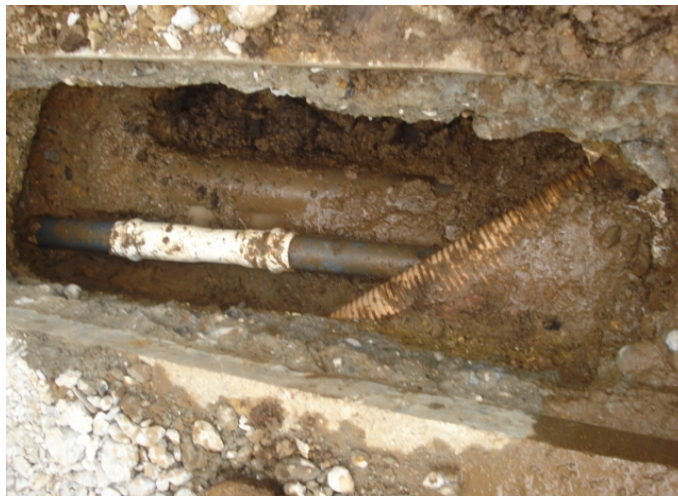
Figura 49 Suministro e instalación de uniones de reparación pvc 3"
