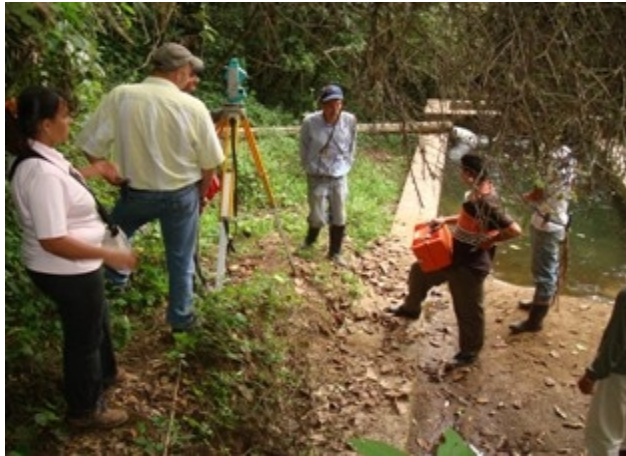
Figura 13 Localización y replanteo
