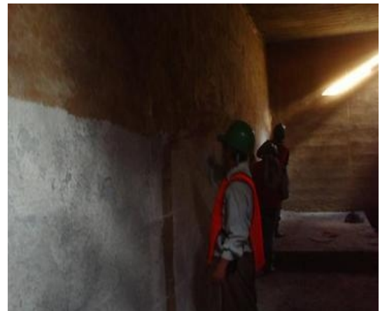
Figura 27 Repello impermeabilizado
