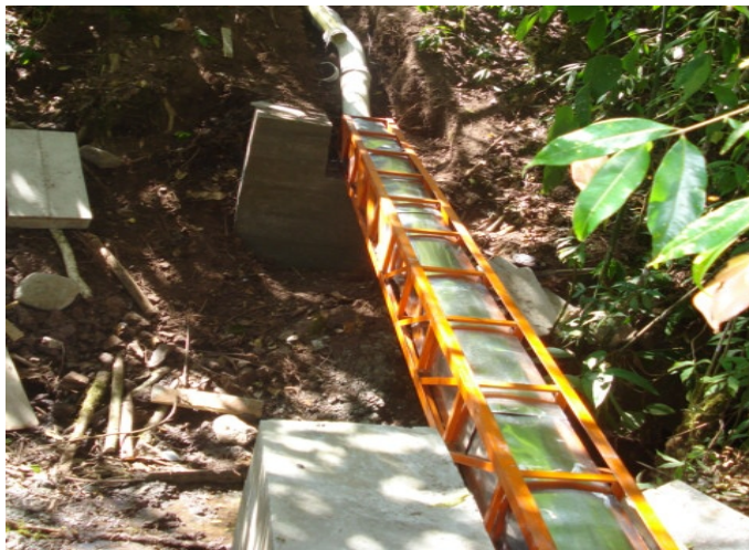
Figura 21 Viaducto l = 0.0 - 5.0 m tubería 6"
