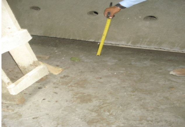
Figura 11 Concreto losa de fondo
