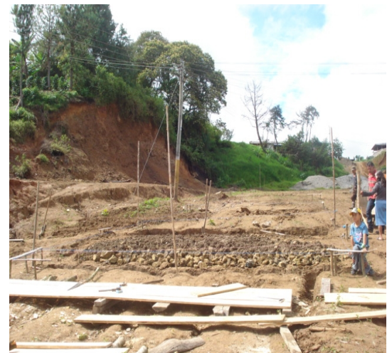
Figura 73 Localización y replanteo
