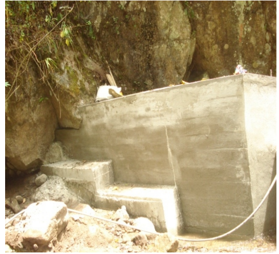
Figura 2 Concreto muros e=30 cm impermeabilizado
