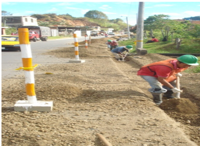
Figura 65 Excavación a mano en conglomerado
