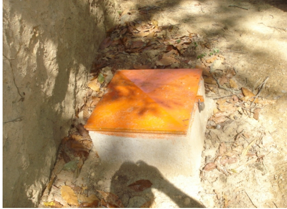
Figura 18 Construcción cámara para válvula de purga tipo 4
