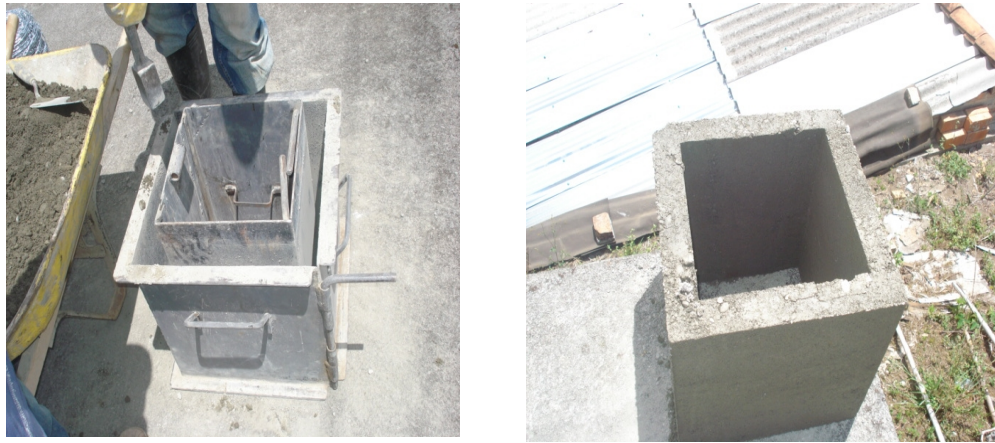
Figura 38 Construcción caja para válvula tipo I (calzada)
