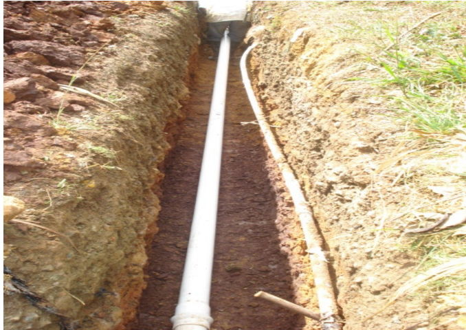
Figura 70 Suministro e instalación tubería pvc 3" rde 26
