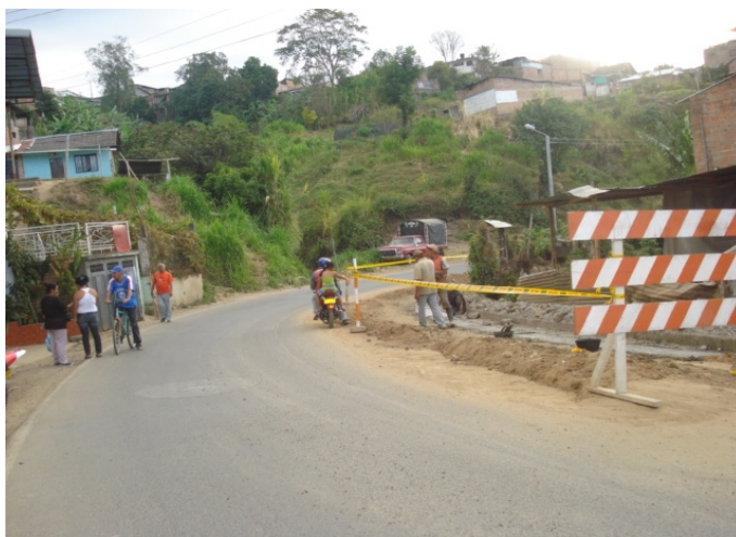
Figura 69 Retiro material sobrante (regar en sitio)
