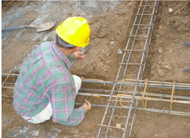
Figura78 Viga cimiento enlace h=20-40 cm
