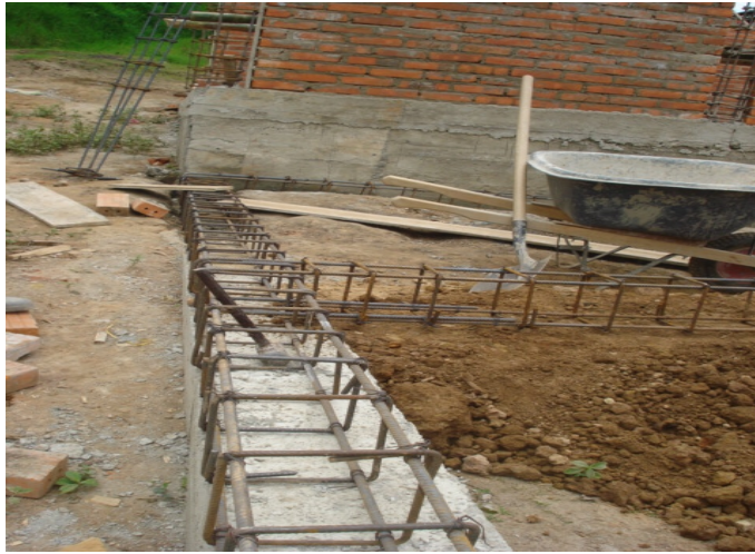
Figura 81 Viga de cimentación
