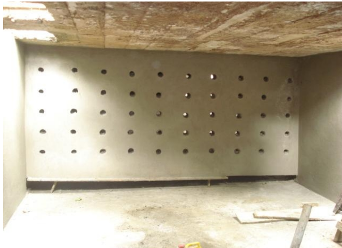
Figura 12 Repello impermeabilizado
