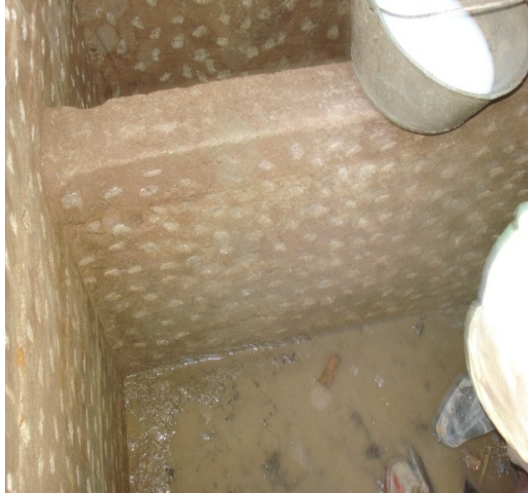
Figura 4 Concreto muros e=10 cm
