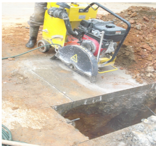
Figura 56 Rotura pavimento concreto rígido
