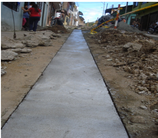
Figura 45 Reconstrucción de calzada en concreto
