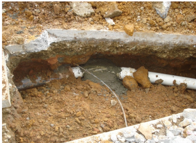
Figura 47 Anclajes para tubería pvc
