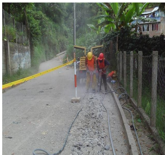
Figura 56 Rotura pavimento concreto rígido
