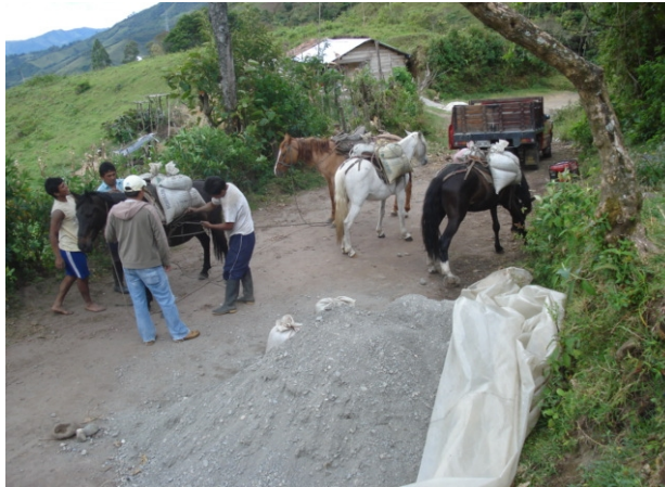
Figura 20 Transporte tubería a conducción.
