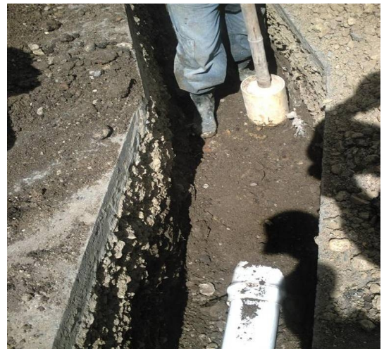
Figura 62 Suministro e instalación de tubería pvc 6" rde 26.
