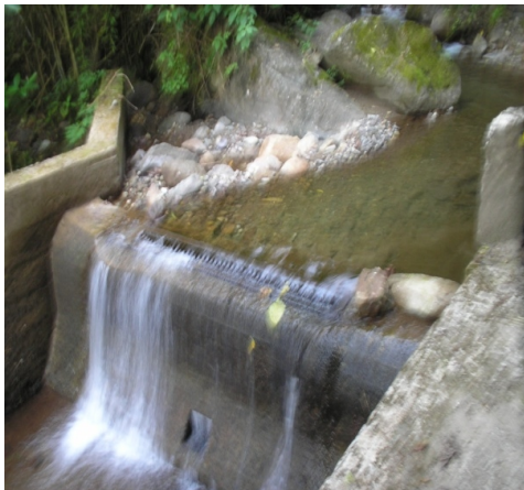
Figura 7 Suministro e instalación de rejilla metálica.
