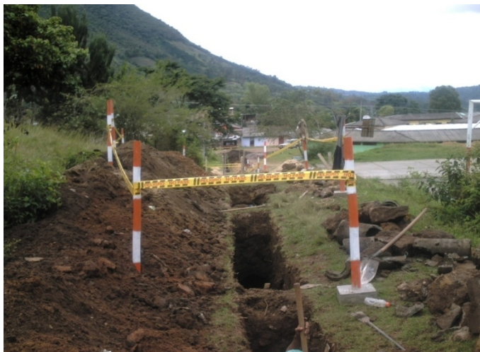
Figura 39 Excavación material común
