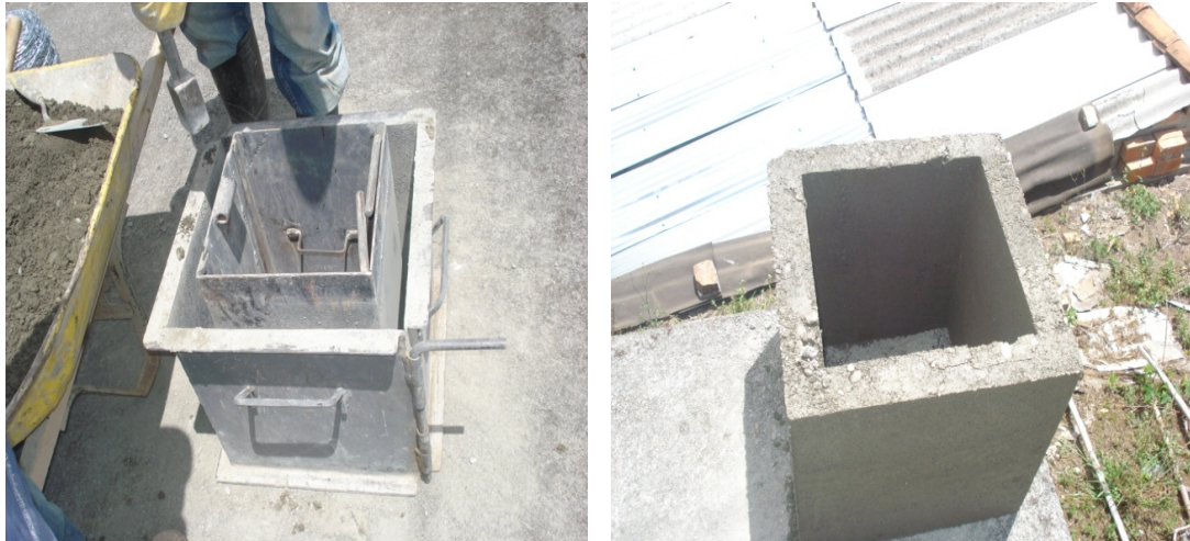
Figura 59 Construcción caja para válvula tipo I (calzada)
