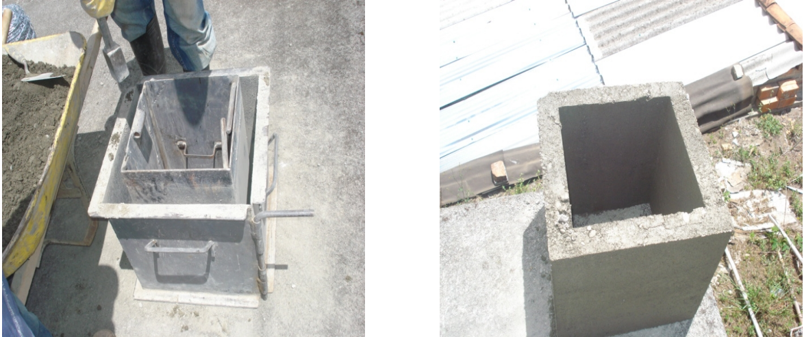
Figura 46 Construcción caja para válvula tipo I (calzada).
