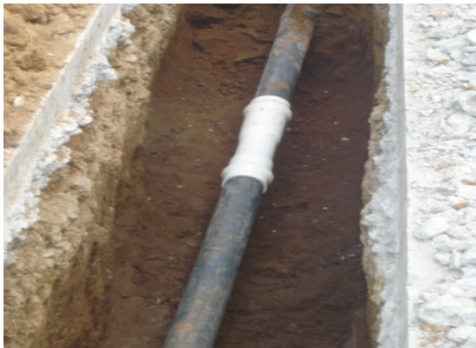
Figura 71 suministro e instalaciones de uniones de reparación pvc 3"
