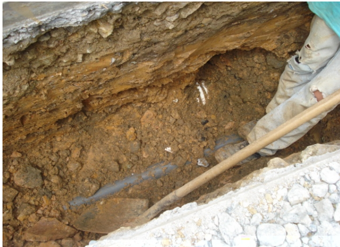
Figura 53 Excavación material común.
