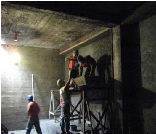
Figura 27 Repello impermeabilizado
