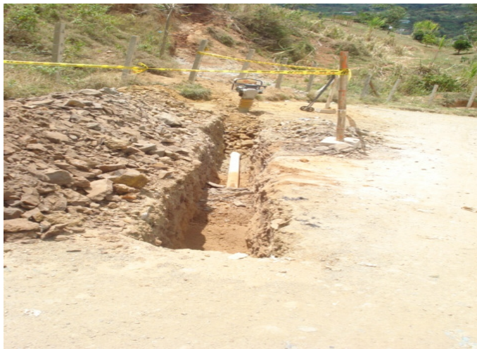
Figura 50 Excavación material común
