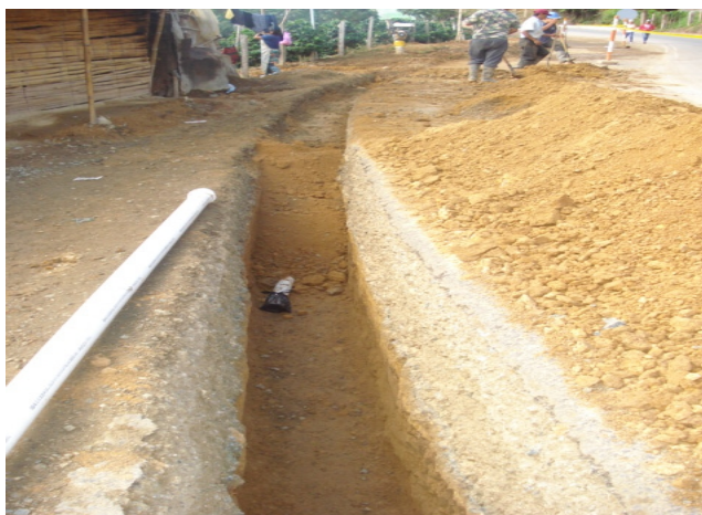
Figura 32 Excavación material común
