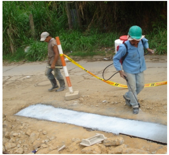
Figura 58 Reconstrucción de calzada concreto
