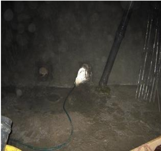
Figura 26 Solado de concreto 0.05
