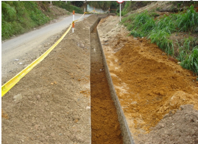
Figura 67 Relleno con material del sitio
