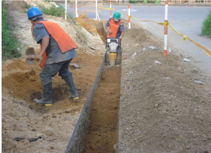
Figura 68 Relleno con material del sitio - 90 % p. m
