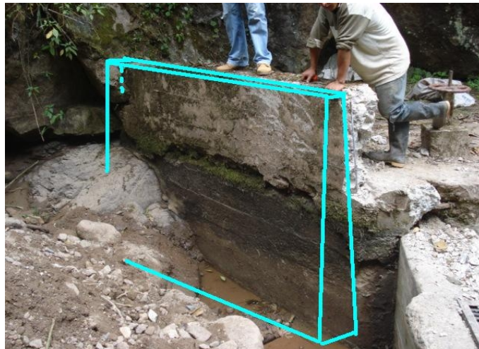
Figura 3 concreto muros e=15 cm
