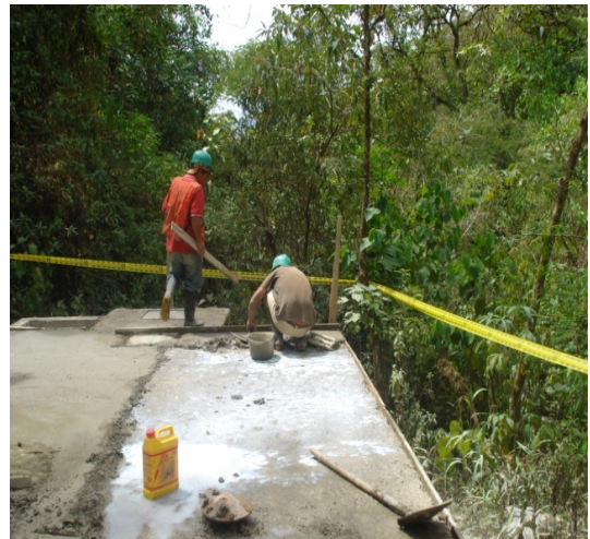
Figura 10 Concreto losa de cubierta e=15 cm
