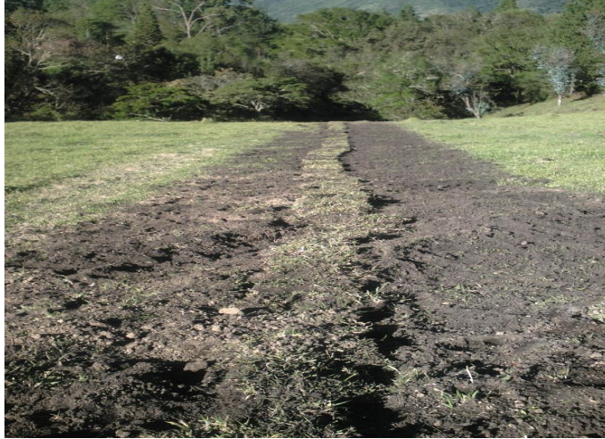
Figura 15 Relleno con material del sitio
