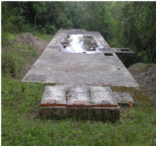
Figura 10 Concreto losa de cubierta e=15 cm
