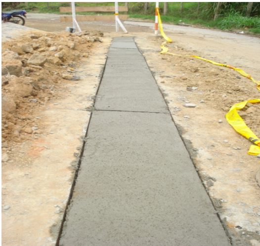
Figura 58 Reconstrucción de calzada concreto
