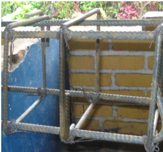
Figura 77 Acero refuerzo flejado 60000 psi 420 mpa
