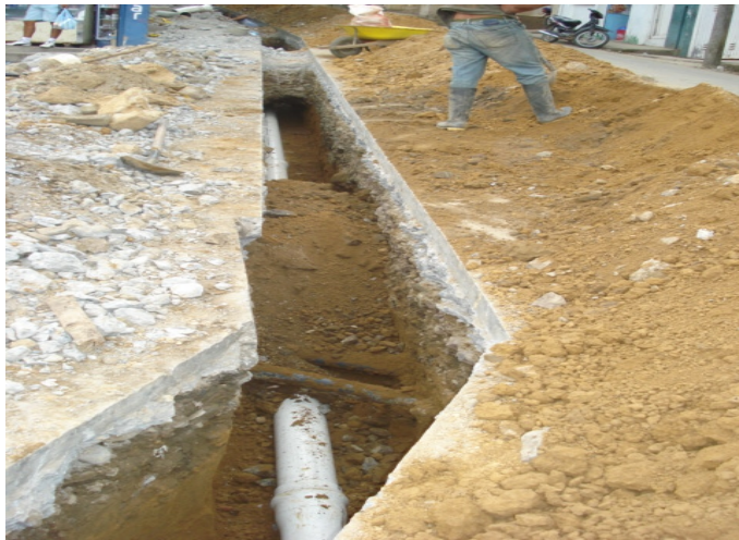
Figura 44 Relleno con material del sitio
