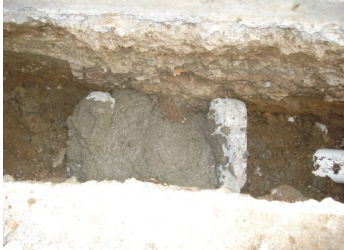
Figura 61 Anclajes para tubería pvc
