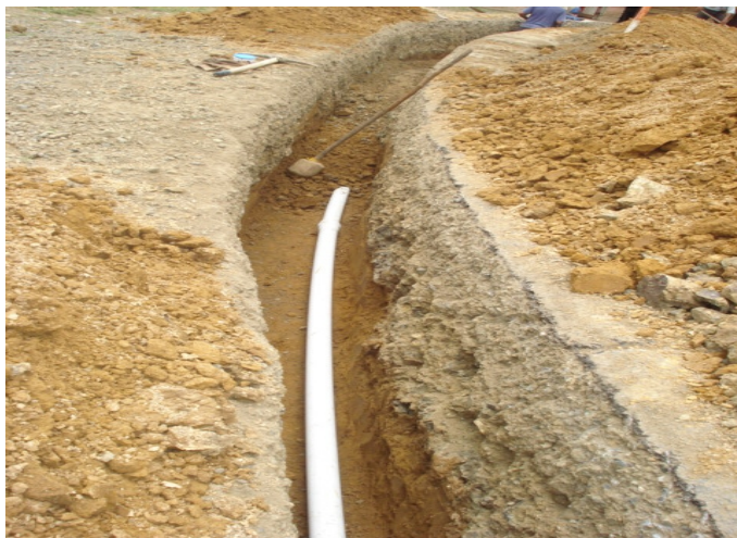
Figura 36 Suministro e instalación tubería pvc 3" rde 26
