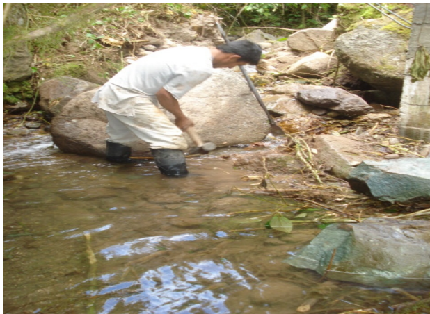
Figura 1 Excavación a mano roca
