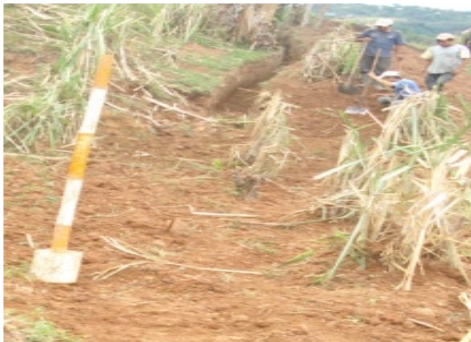
Figura 30 Relleno con material del sitio
