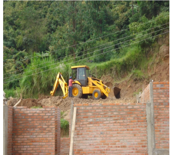
Figura 74 Cargue y bote de escombros
