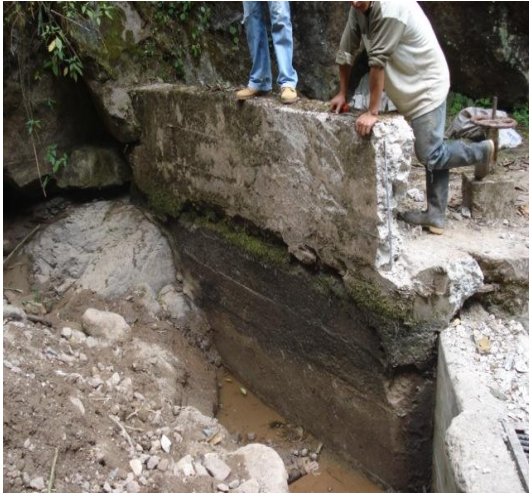
Figura 2 Concreto muros e=30 cm impermeabilizado
