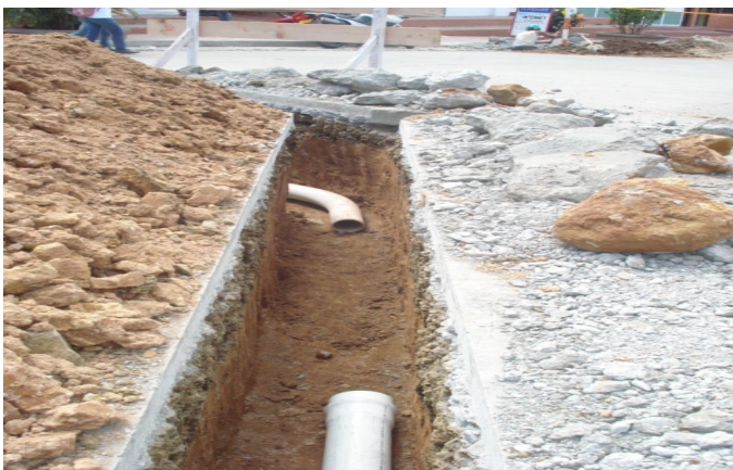
Figura 64 Suministro e instalación codo extremos lisos pvc (45x 6")
