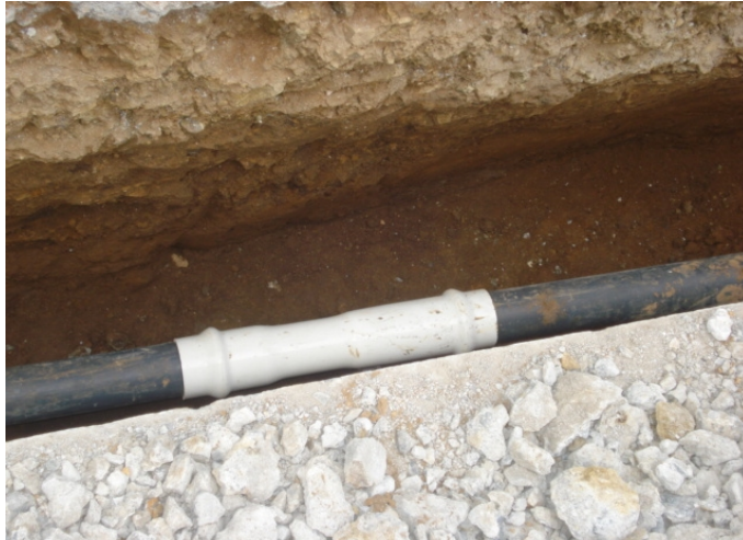
Figura 63 Suministro e instalación de uniones de reparación pvc 3"
