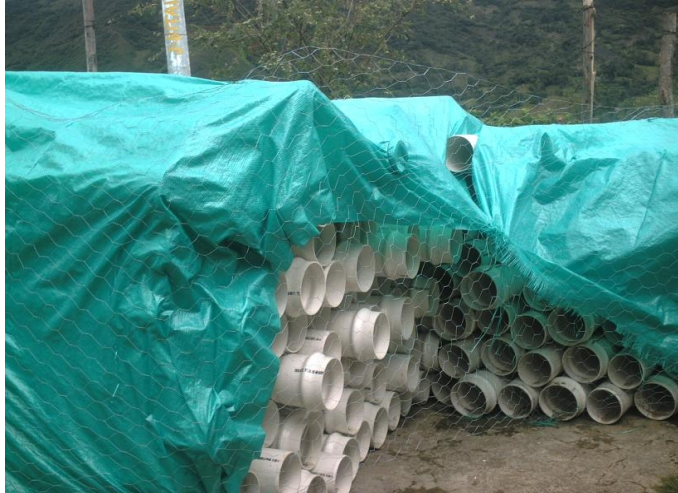
Figura 41 Transporte de tubería al municipio
