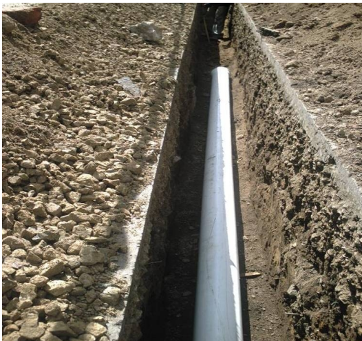
Figura 62 Suministro e instalación de tubería pvc 6" rde 26.
