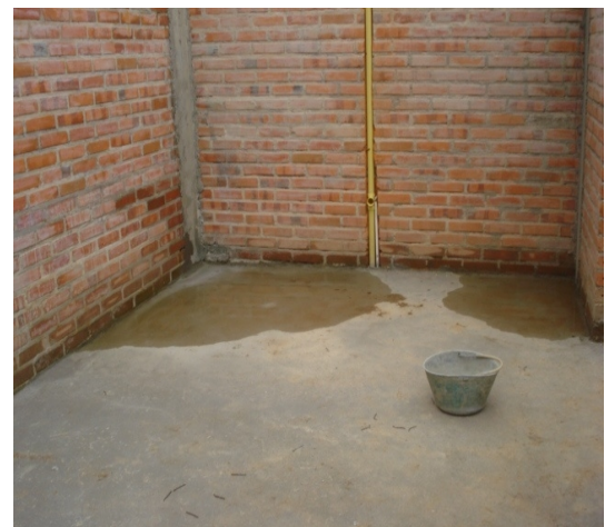
Figura 79 Solado espesor e=0.05m 3000 psi 210 mpa
