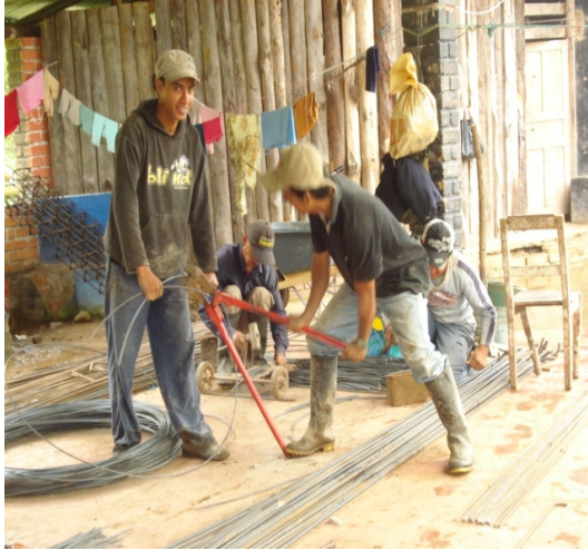
Figura 76 Acero refuerzo flejado 60000 psi 280mpa
