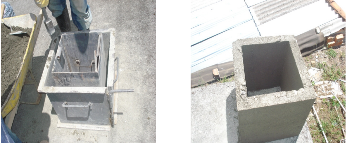
Figura 51 Construcción caja para válvula tipo I (calzada)
