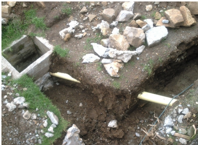
Figura 24 Demolición de concreto a mano
