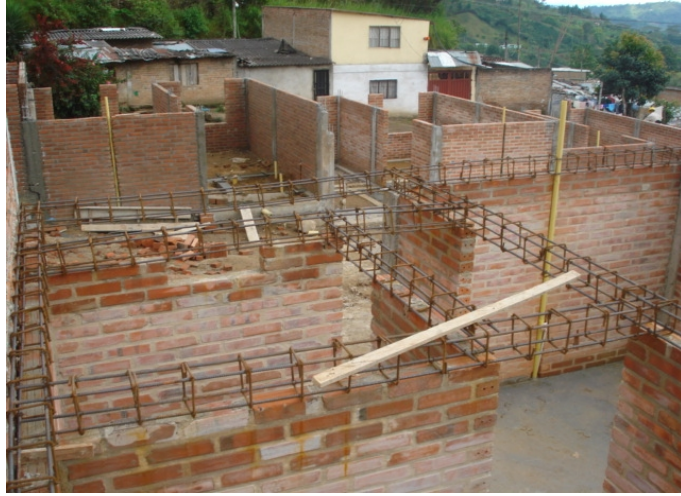
Figura 84 Viga de confinamiento
