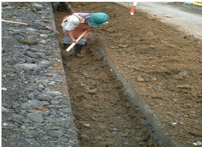
Figura 42 Excavación material común
