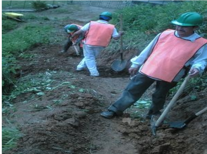
Figura 9 Excavación material común
