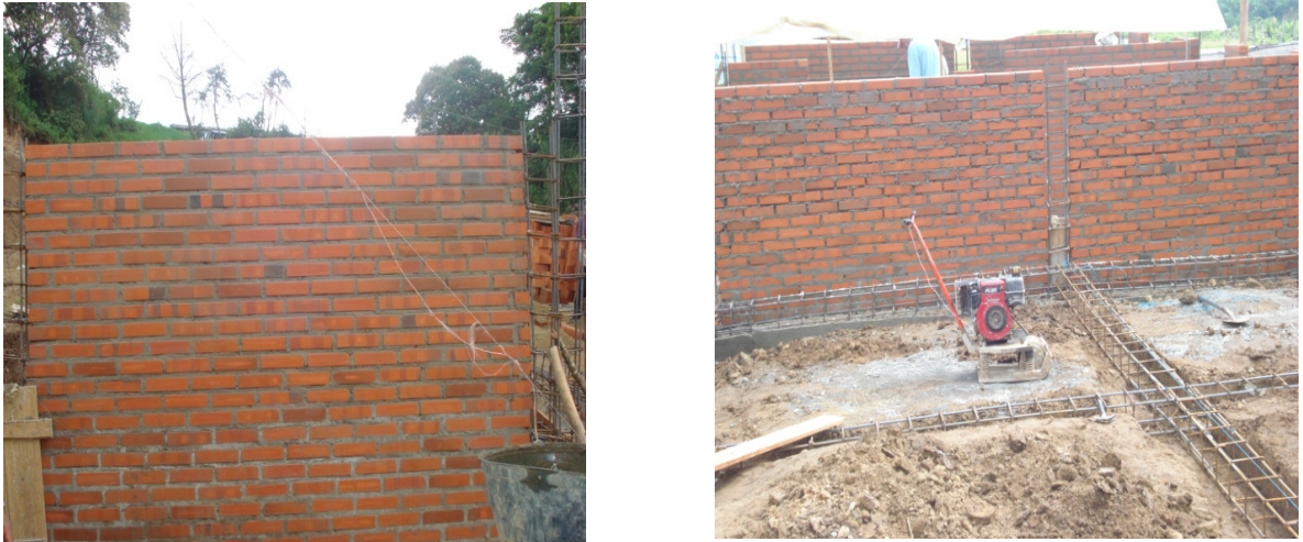
Figura 83 Muro en ladrillo a la vista.
