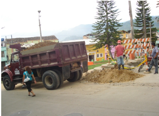
Figura 48 Retiro material sobrante (regar en sitio)
