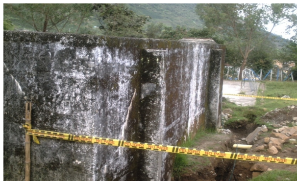
Figura 28 Concreto muros e=10 cm
