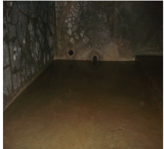
Figura 26 Solado de concreto 0.05
