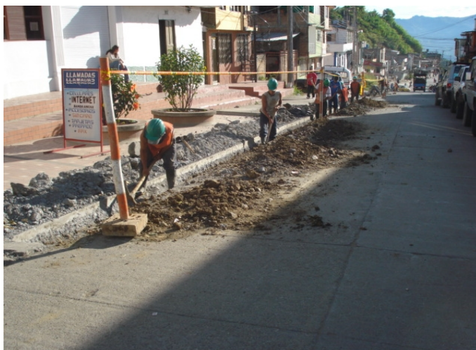
Figura 55 Excavación material común
