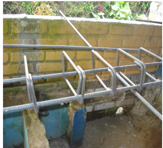
Figura 77 Acero refuerzo flejado 60000 psi 420 mpa
