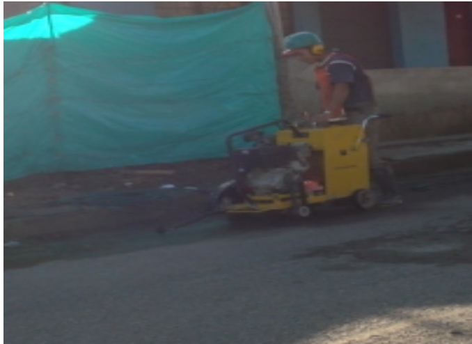
Figura 43 Rotura asfalto
