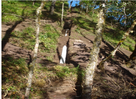
Figura 17 Suministro e instalación de tubería pvc 6" rde 41
