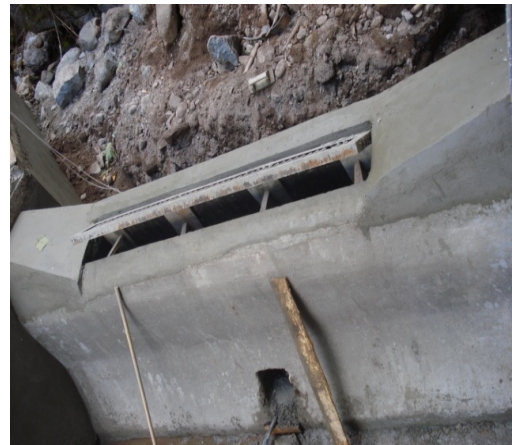
Figura 7 Suministro e instalación de rejilla metálica.
