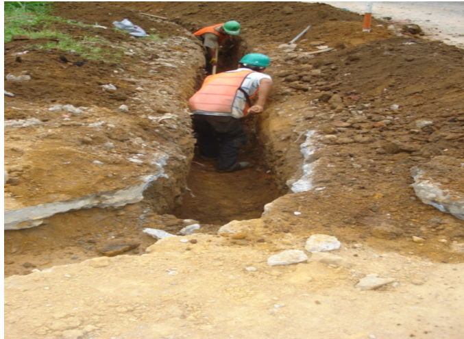
Figura 66 Excavación material común
