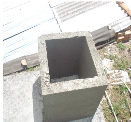
Figura 72 Construcción caja para válvula de cámara de quiebre tipo 2
