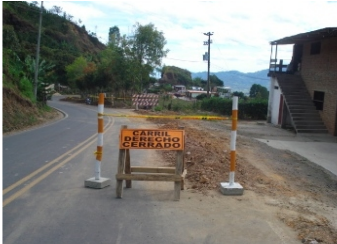
Figura 33 Relleno con material del sitio 90% pm
