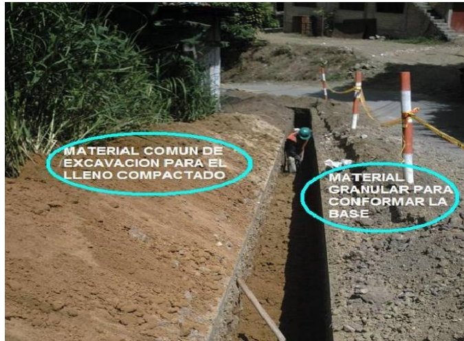
Figura 57 Relleno con material del sitio
