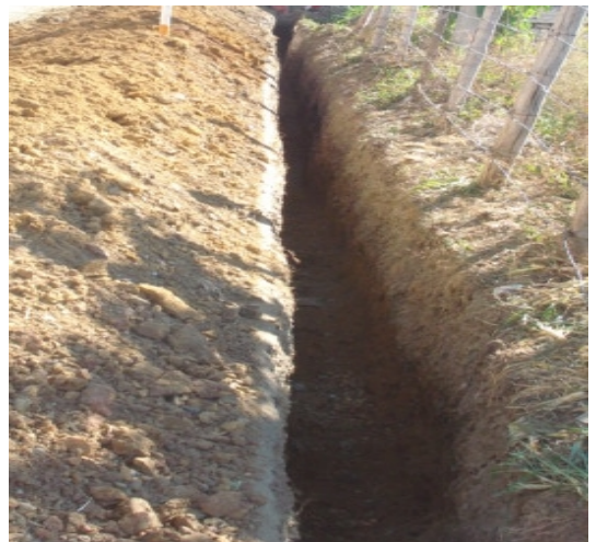
Figura75 excavación tierra a mano
