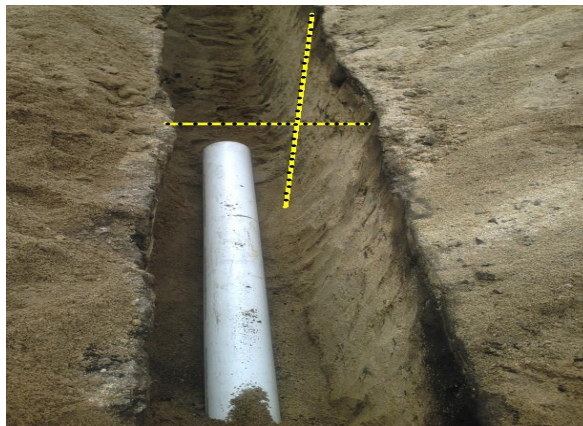
Figura 40 Suministro e instalación de tubería pvc 6" rde 26
