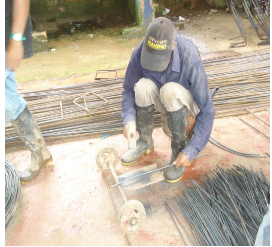
Figura 76 Acero refuerzo flejado 60000 psi 280mpa
