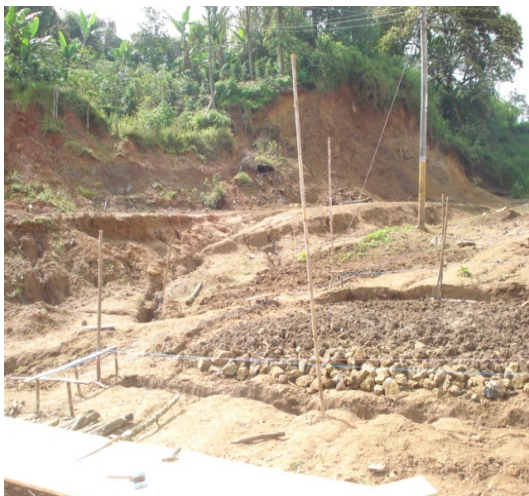
Figura 73 Localización y replanteo
