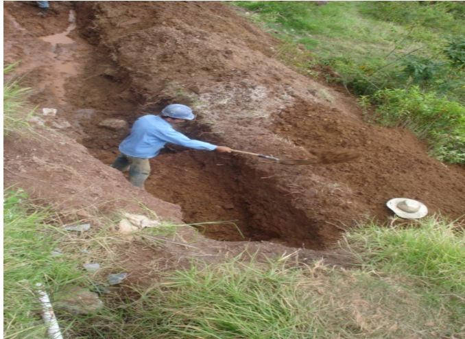
Figura 29 Excavación material común
