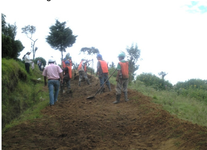
Figura 16 Retiro material sobrante (regar en sitio)
