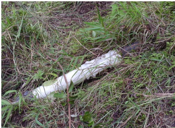
Figura 52 Suministro e instalación de uniones de reparación pvc 4"
