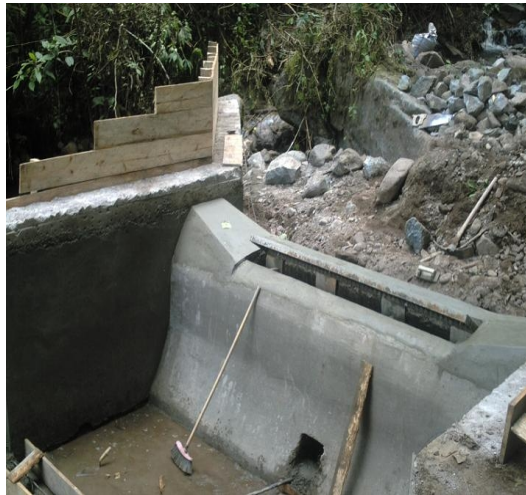
Figura 5 Concreto dique bocatoma
