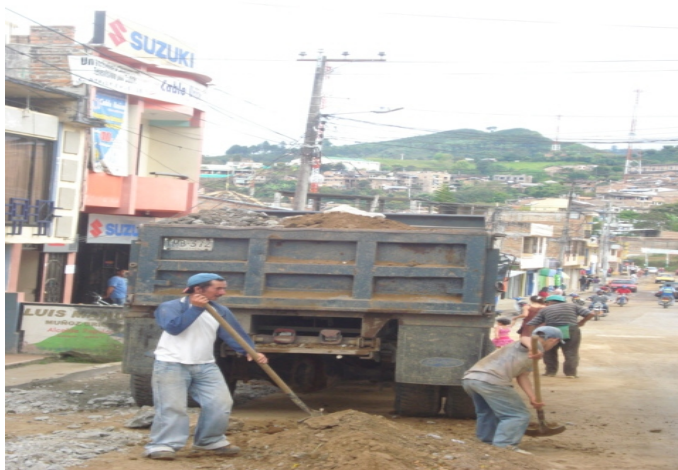
Figura 54 Retiro material sobrante (regar en sitio)
