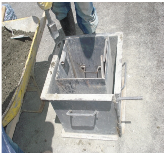
Figura 72 Construcción caja para válvula de cámara de quiebre tipo 2
