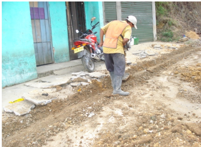
Figura 34 Relleno con roca muerta - 90 % p. m
