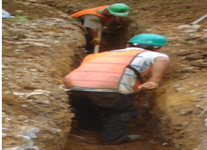
Figura 25 Excavación a mano en conglomerado
