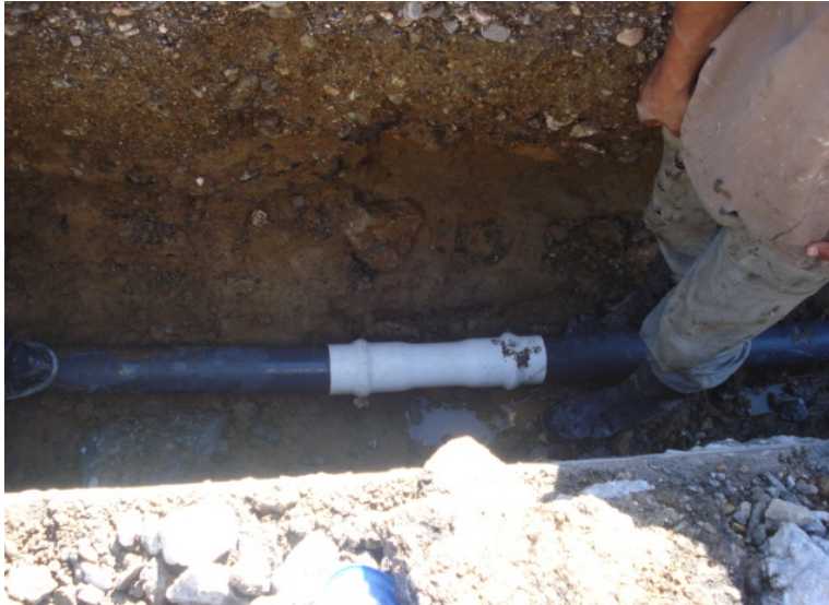
Figura 37 Suministro e instalación uniones de reparación pvc 3"
