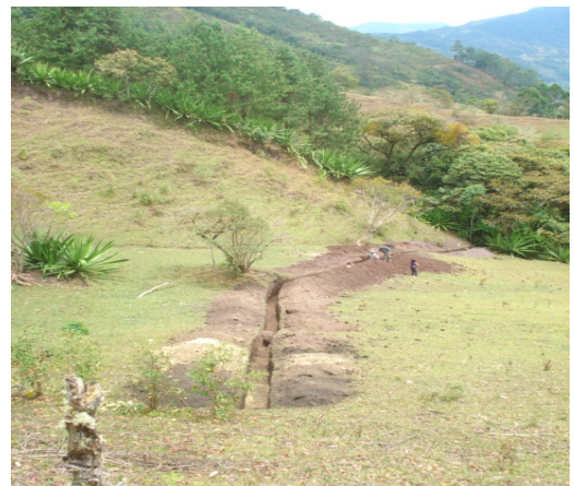
Figura 14 Excavación material común
