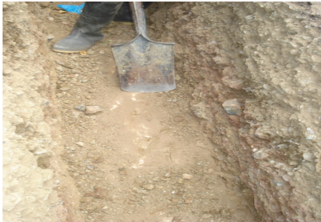
Figura 31 Excavación a mano en conglomerado
