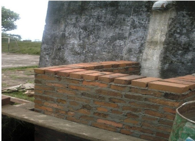
Figura 23 Caja de inspección 0.80 * 0.80 m h=1.50 m
