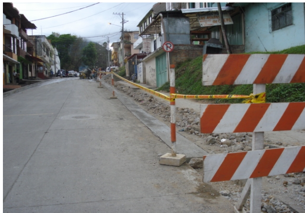
Figura 60 Retiro material sobrante (regar en sitio)
