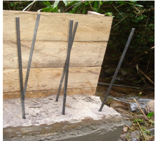
Figura 6 Acero de refuerzo
