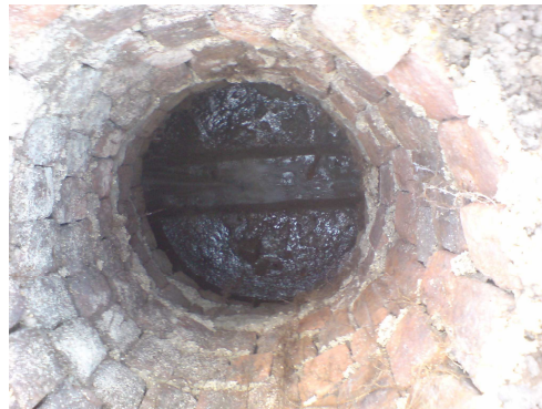
Figura 38. Estado cámara alcantarillado viejo
