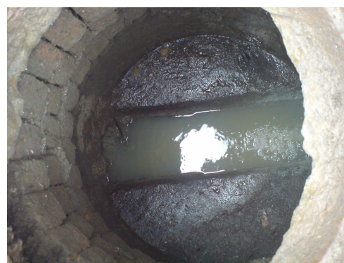
Figura 40. Estado cámara de empalme
