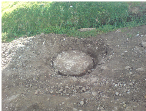
Figura 37. Cámara alcantarillado viejo
