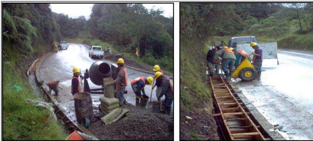
Fotografía 14. Fundición de canal en concreto clase D.
