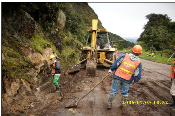
Fotografía 17. Demolición de cunetas y bordillos.
