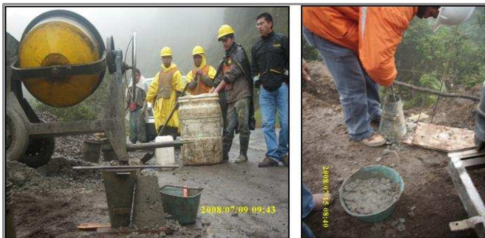
Fotografía 31. Toma de ensayo de asentamiento en fundición de muros.
