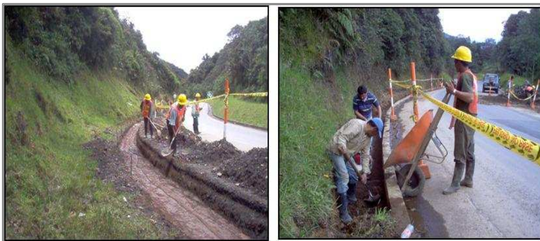
Fotografía 10. Colocación de material de cobertura para filtros.
