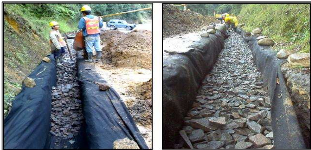
Fotografía 9. Colocación de material filtrante.
