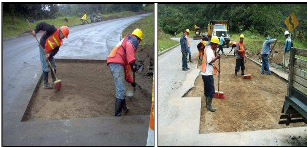
Fotografía 5. Barrido e imprimación para bacheo.
