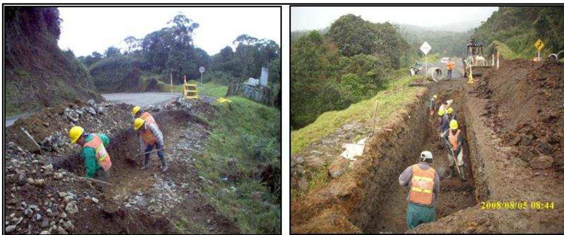
Fotografía 24. Excavaciones a mano para construcción de muros de contención.
