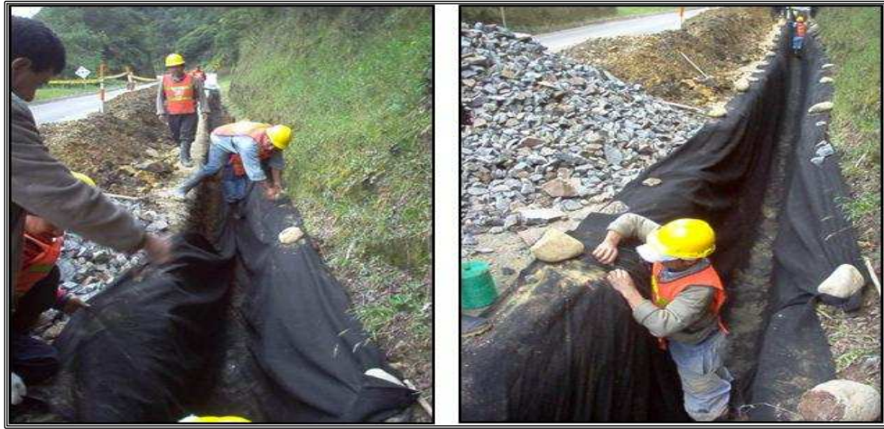
Fotografía 8. Colocación de geotextil.
