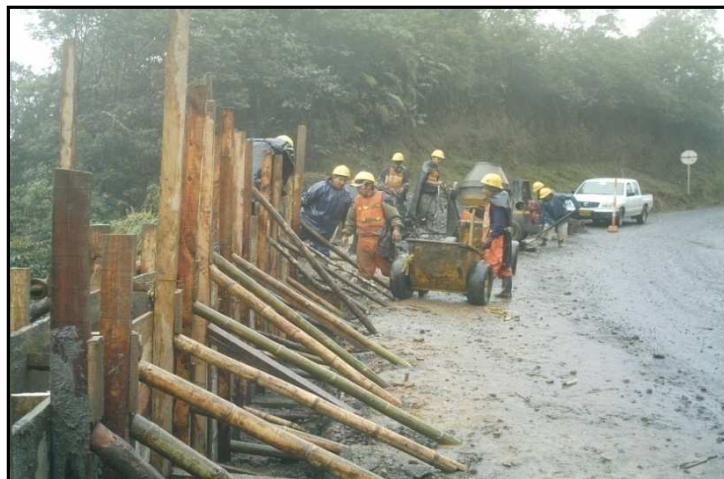
Fotografía 30. Fundición elevación muro de contención.
