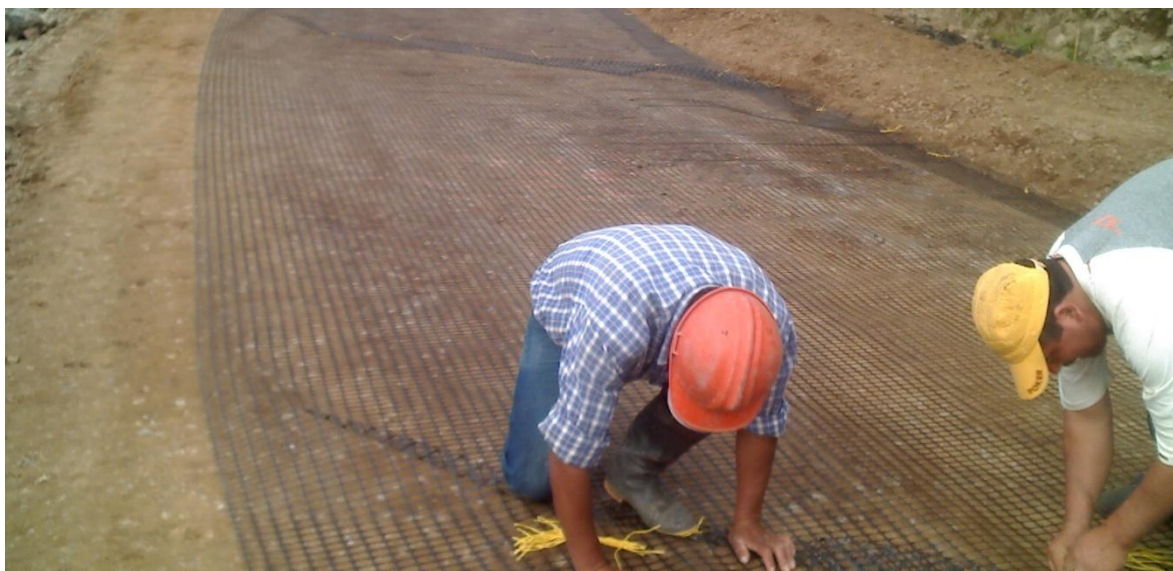
Figura 50. Amarre de la geomalla en curvas.
