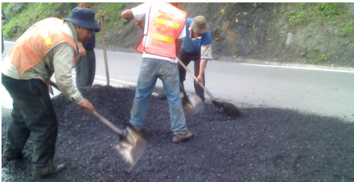
Figura 66. Extendido de la mezcla asfáltica.
