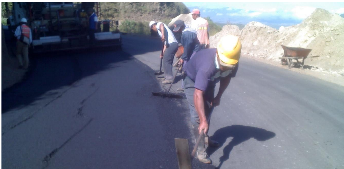
Figura 21. Conformación carpeta pavimento.
