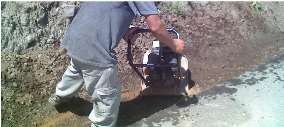
Figura 32. Compactación de la cuneta en tierra.
