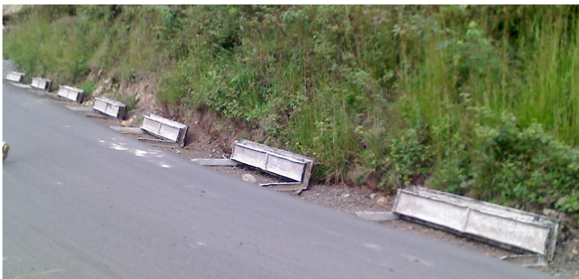
Figura 33. Formaleta metálica para cunetas triangulares en L.
