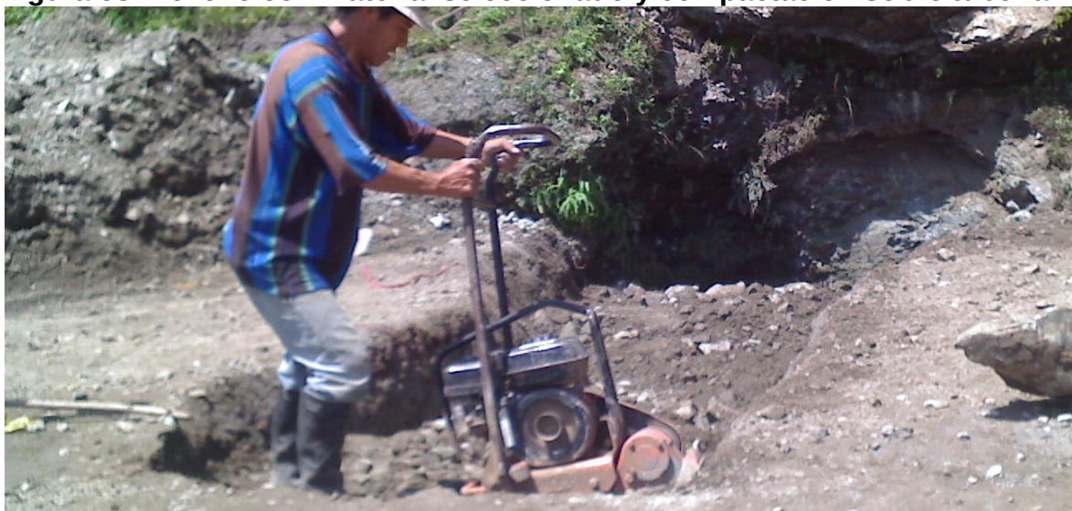
Figura 58. Relleno con material seleccionado y compactación sobre tubería.
