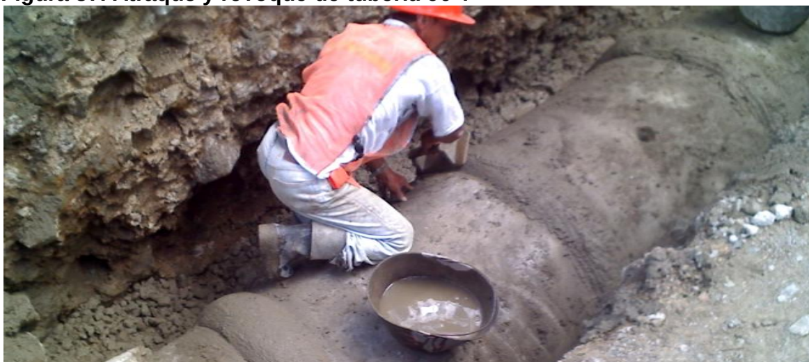
Figura 57. Atraque y revoque de tubería 36".
