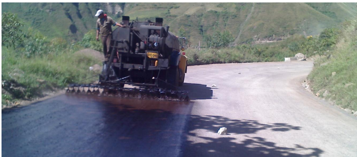
Figura 17. Aplicación del ligante bituminoso.
