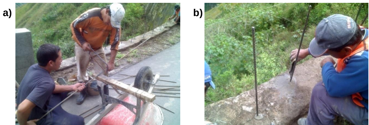
Figura 25. Corte, colocación y anclaje del refuerzo vertical.
