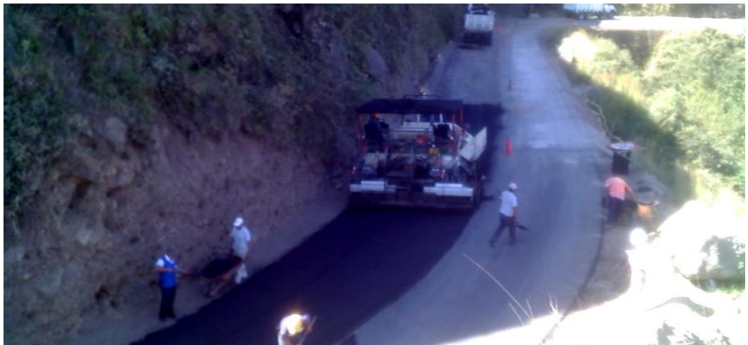
Figura 20. Descargue de la mezcla asfáltica MDC-2.
