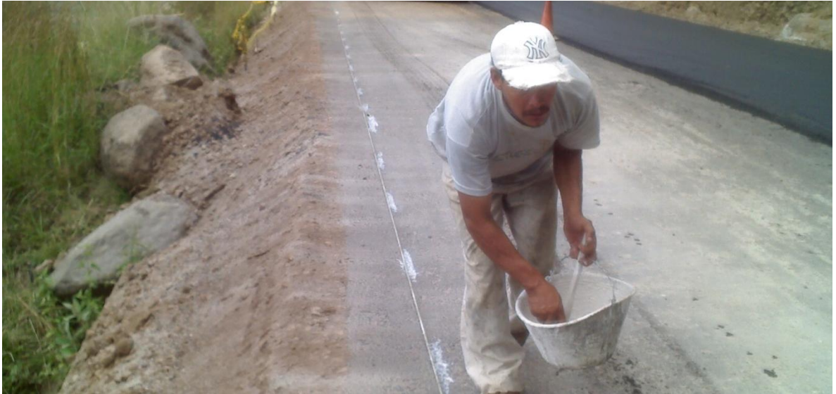
Figura 19. Delimitación del área para instalación de mezcla asfáltica.
