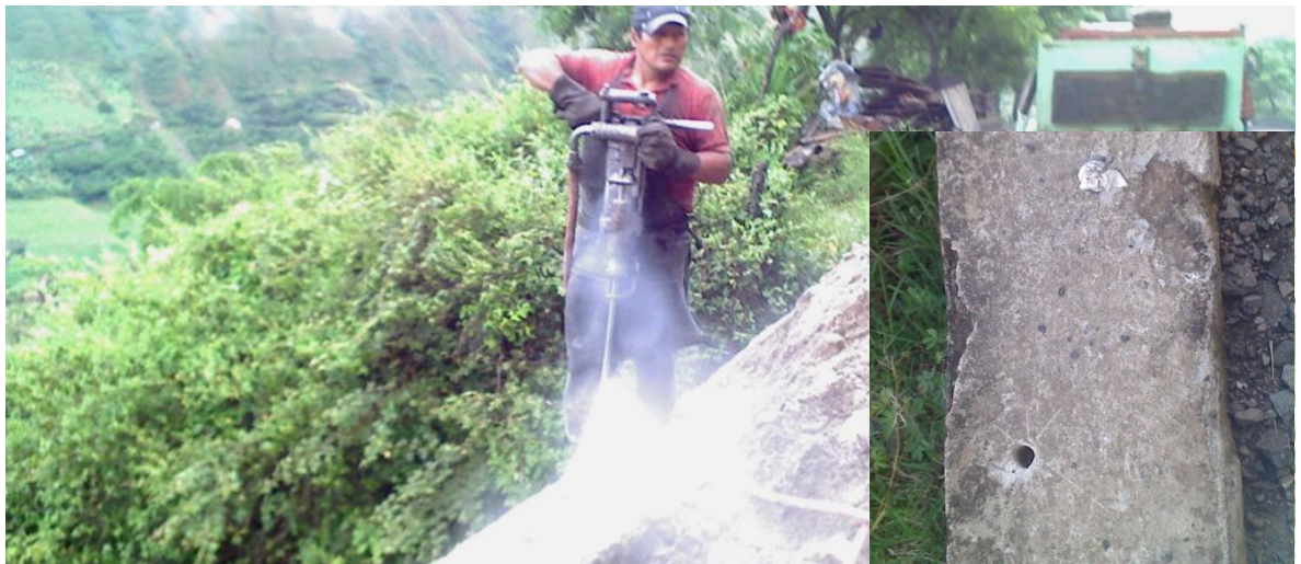
Figura 24. Perforaciones para anclar refuerzo vertical.
