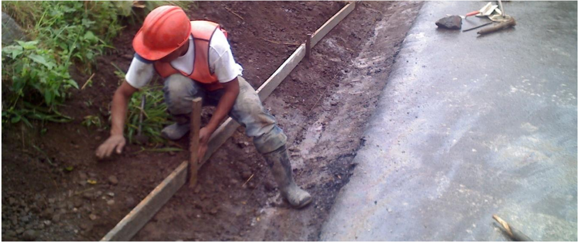
Figura 34. Instalación de formaleta de cunetas triangulares en V.
