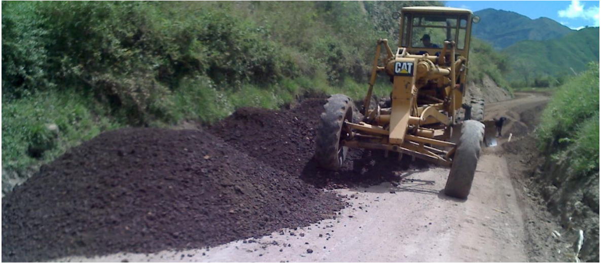
Figura 11. Acordonamiento de base granular.
