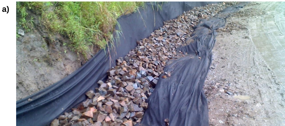
Figura 42. Colocación de material filtrante.
