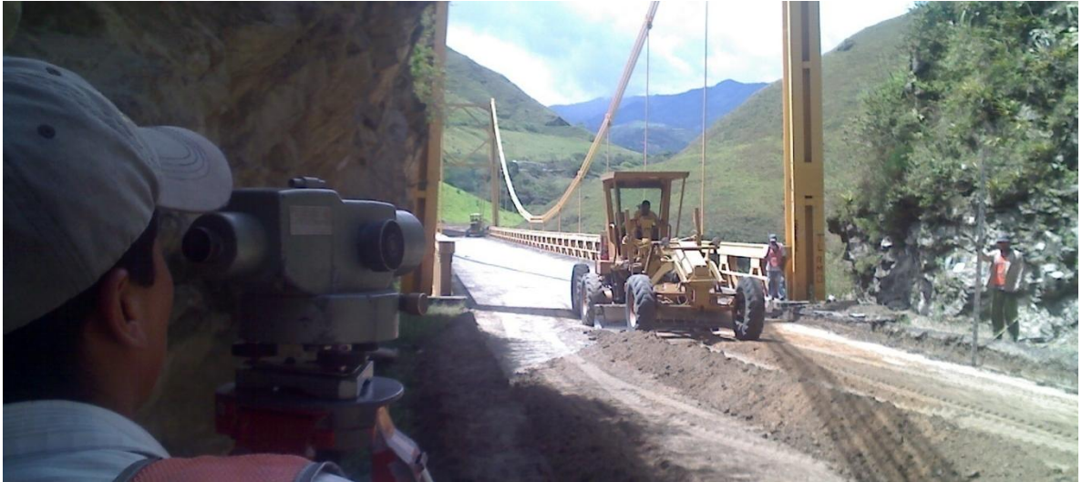
Figura 7. Cajeo para alcanzar la rasante en el Puente Juanambu.
