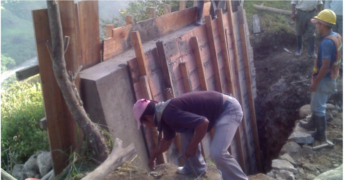
Figura 62. Desencofrado de los cabezotes de las alcantarillas.
