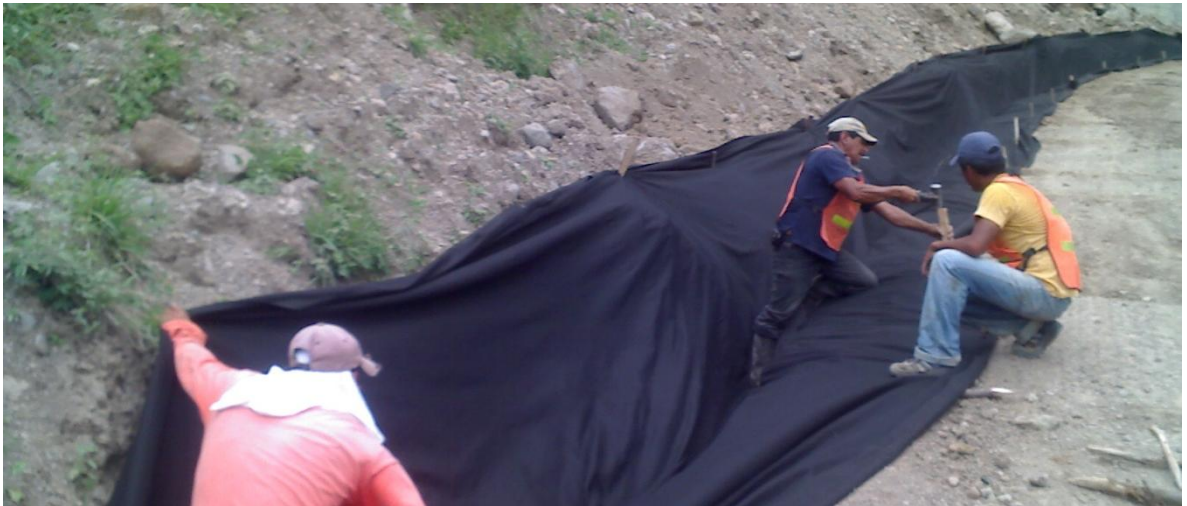
Figura 40. Colocación de geotextil.
