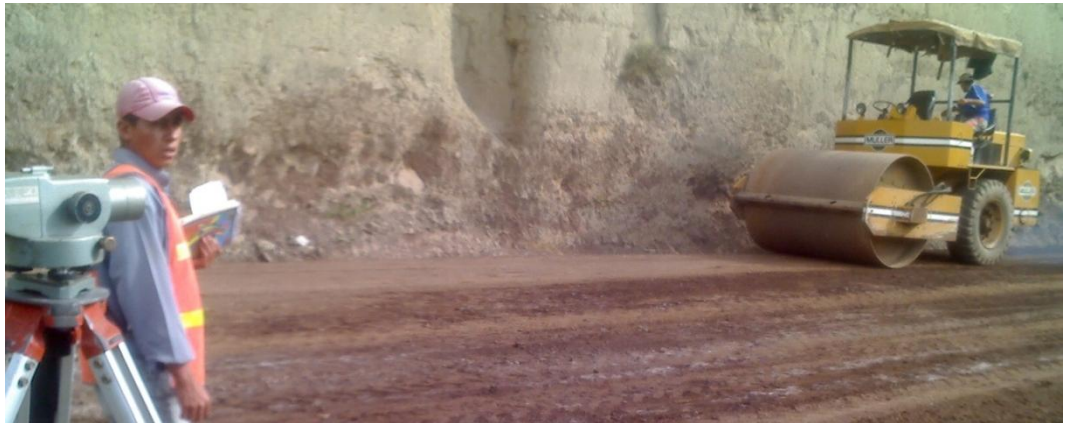
Figura 15. Compactación y toma de densidades del material de base granular.
