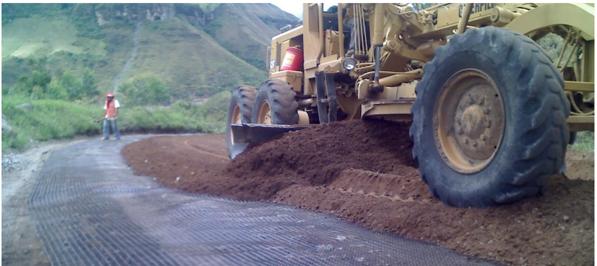
Figura 12. Extendido de base granular.
