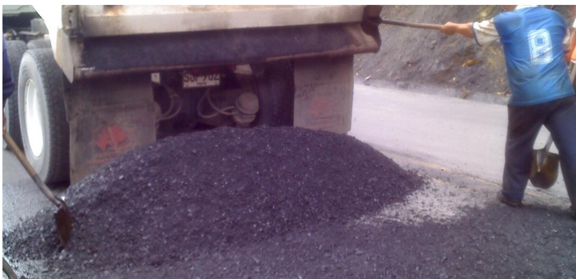
Figura 65. Descarga de la mezcla asfáltica.
