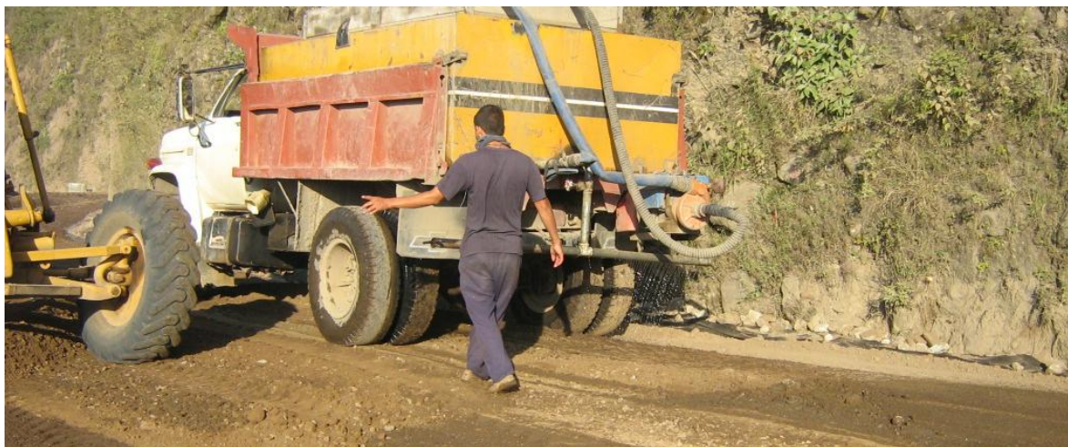
Figura 13. Humedecimiento del material base granular.
