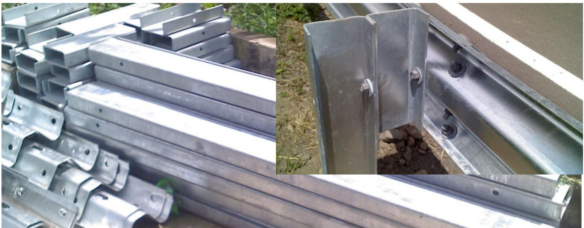
Figura 47. Partes de la defensa metálica.
