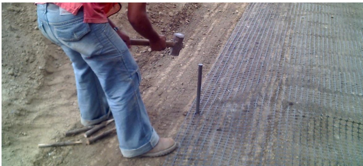
Figura 51. Tensado de la geomalla.
