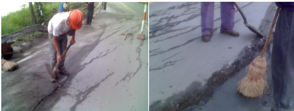
Figura 64. Preparación de la superficie a rehabilitar.
