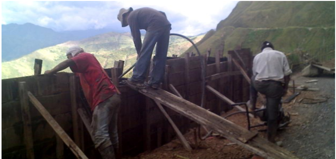
Figura 29. Vibrado y acabado del concreto en muros de realce.
