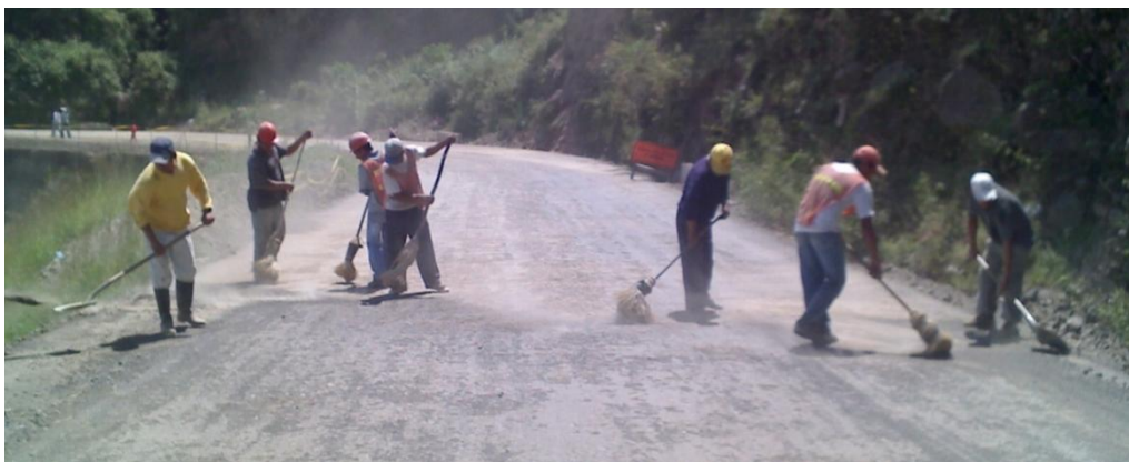
Figura 16. Preparación de la superficie existente.
