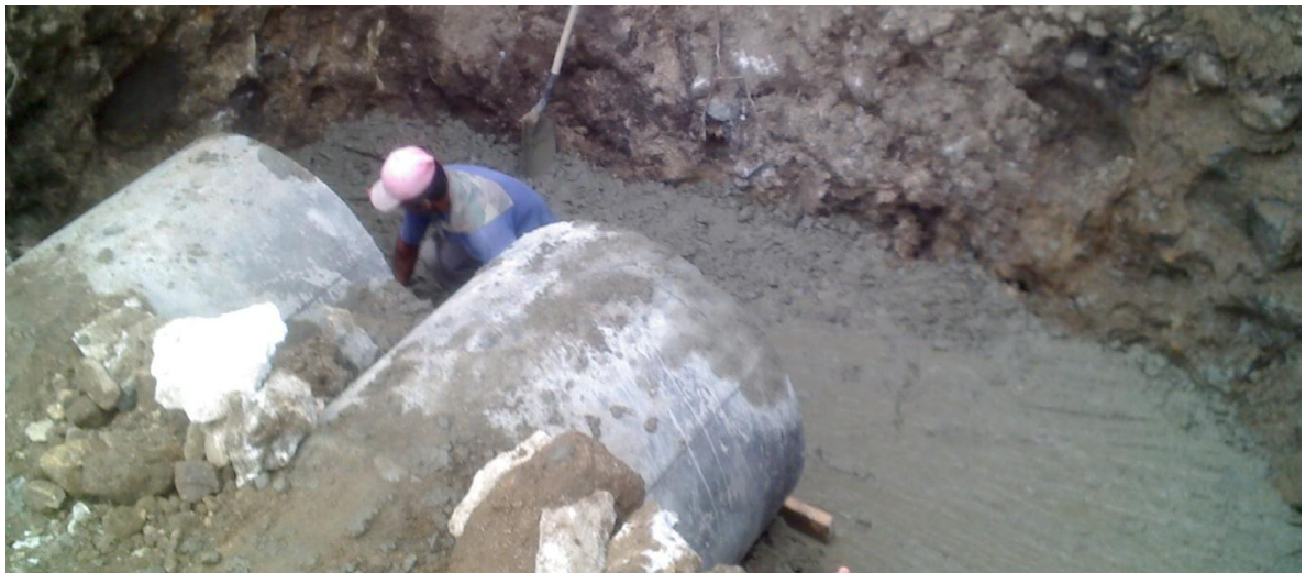
Punto de referencia cabezote de entrada de alcantarilla doble K48+577
