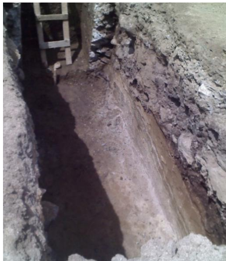
Figura 54. Conformación de excavación y solado para la instalación de nueva tubería.
