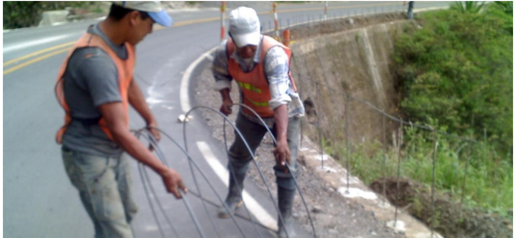
Figura 26. Colocación, fijación y amarre del refuerzo horizontal.
