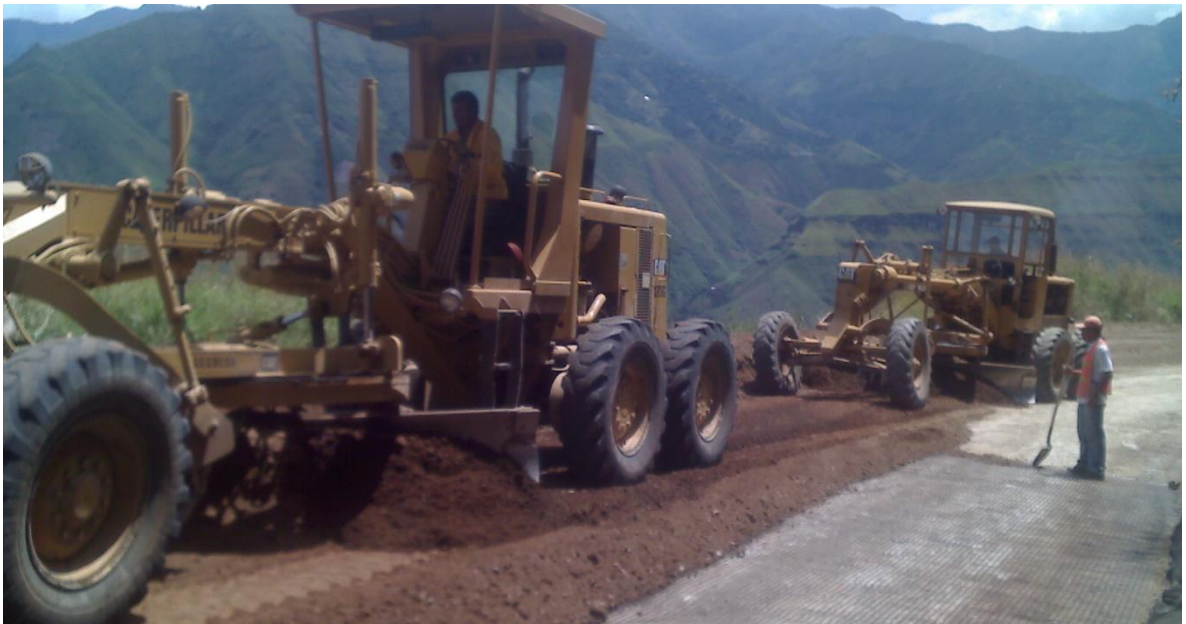
Figura 52. Extendido de la base granular.
