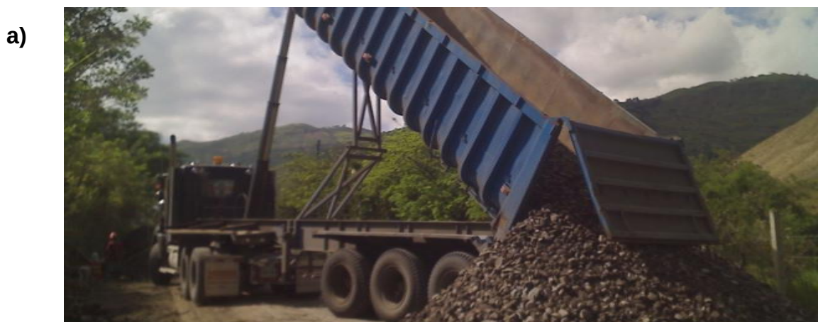
Figura 41. Material filtrante utilizado para el llenado de filtros longitudinales.
