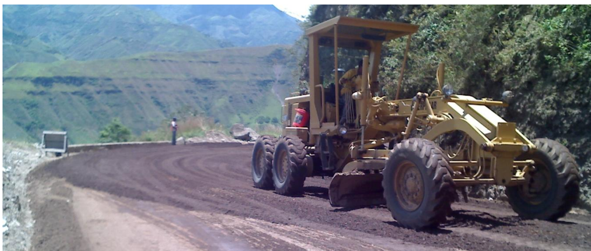
Figura 14. Conformación del material de base granular.
