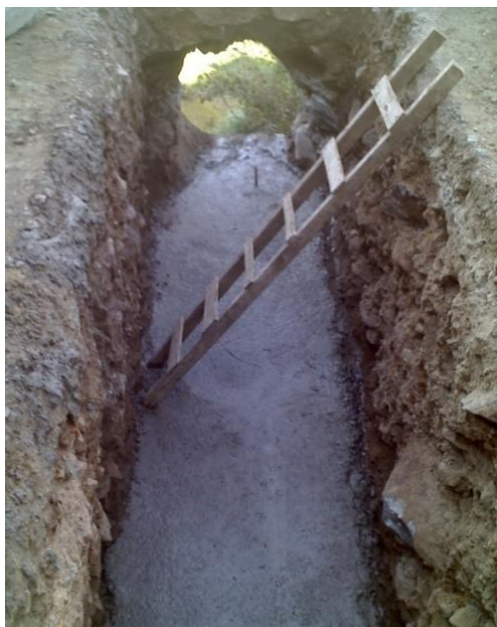
Figura 55. Solado para instalación de nueva tubería.
