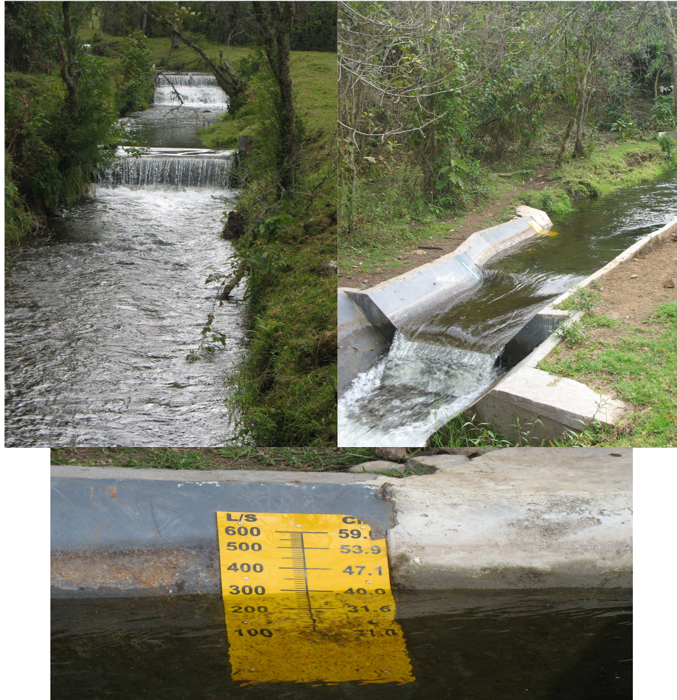
Figura 3. Sistema de conducción y aforo del agua.
