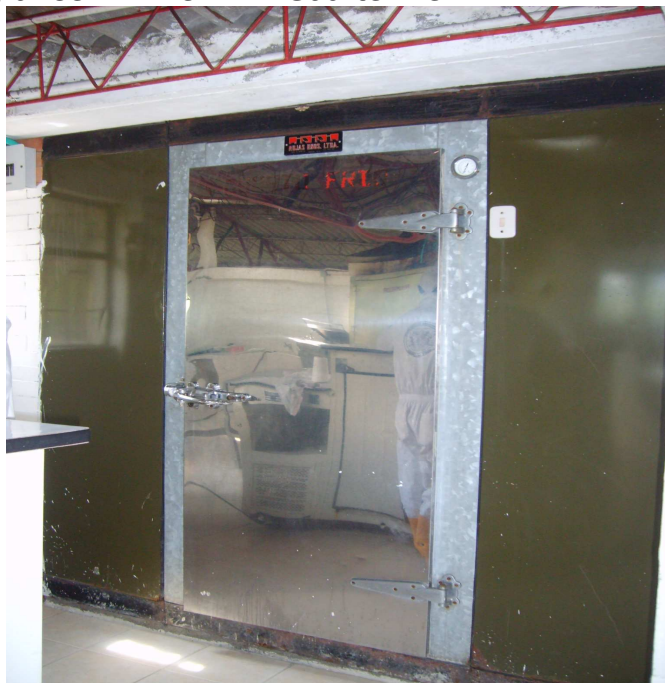
Anexo Fotográfico: AF No. 27 = Cuarto frío.
