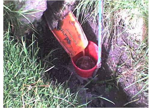
Foto 4 Canaleta de salida de estercolera.
