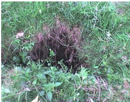
Foto 1. Punto de salida de tuberías
