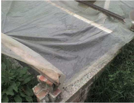
Foto 3 Cubierta plástica del tanque.
