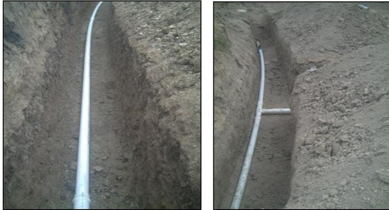
**5.4.2. Relleno.** Posteriormente, se procede al relleno con material de sitio, apisonamiento y compactación con saltarín, hasta cubrir totalmente la tubería.
