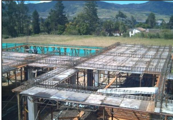
Posteriormente, se instala alambrión calibre 10 con espaciado de 15cm entre cada hilo en los dos sentidos amarrado de las vigas mas externas, formando una malla para controlar efectos de retracción y fraguado.
