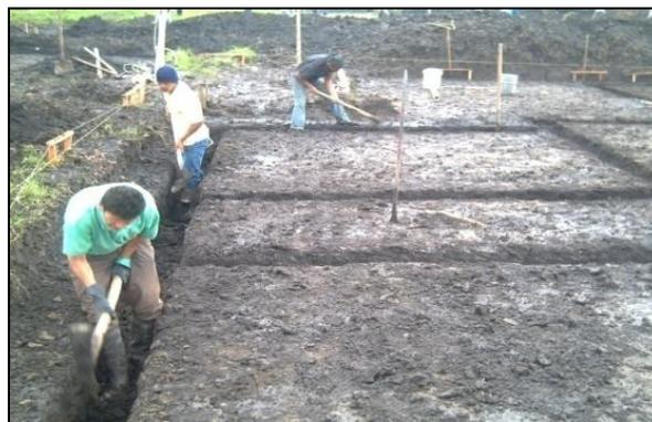
**5.6.4. Disposición de materiales excavados.** Parte del material proveniente de las excavaciones se utilizó para relleno y otra con características no aptas esta actividad se desalojó en volqueta a las escombreras cercanas.
