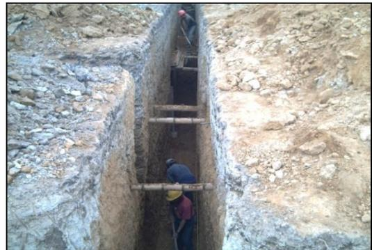
**5.3.2. Instalación red de alcantarillado.** Se instalaron 195 metros en tubería de cemento de 12" de diámetro en la vía principal, y 205 m en 8" de diámetro en las bahías, la tubería se instala y se pega con mortero (1:3), se verifica que la tubería se disponga en forma alineada por medio de la ayuda del hilo (ver tabla 9).
