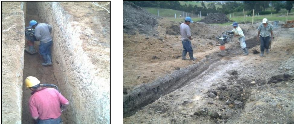
**5.3.5. Acometidas domiciliarias.** La conexión se realiza desde cada vivienda, a la red principal de alcantarillado, sale desde una caja de 0.80x0.80 m en tubería de cemento de 6" de diámetro hacia el colector principal, la excavación se realiza a mano, cuidando de que cumpla con la pendiente mínima y se disponga diagonalmente en ángulo de 45° a 60°.
