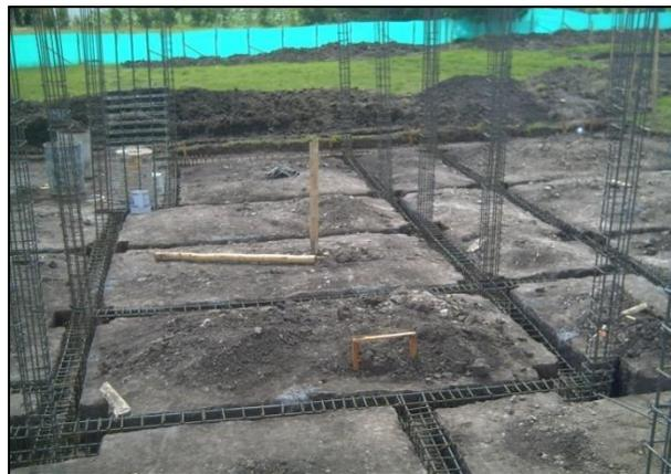
**Fotos 27 y 28. Fundición de vigas de cimentación y zapatas**
