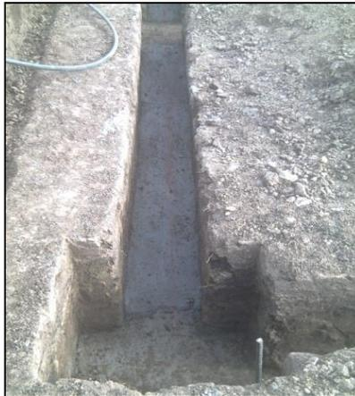
**5.9.2. Vigas de cimentación.** La sección de las vigas de cimentación es de 25x25cm, reforzadas con 2 varillas N°4 en la parte superior y 2 varillas N°5 en la parte inferior de la viga y estribos N°3, la dosificación del concreto empleado para la fundición de estas vigas es 1:2:2.5 para alcanzar una resistencia de 3000psi.
