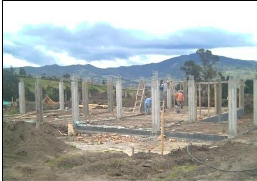
**5.11.2. Vigas de entrepiso.** Las vigas de entre piso son otro de los componentes del sistema estructural aplicado en el desarrollo del proyecto, considerándose como vigas de entrepiso o vigas aéreas a los elementos de concreto reforzado que se colocan en la parte superior para amarrar las columnas formando finalmente el pórtico.
