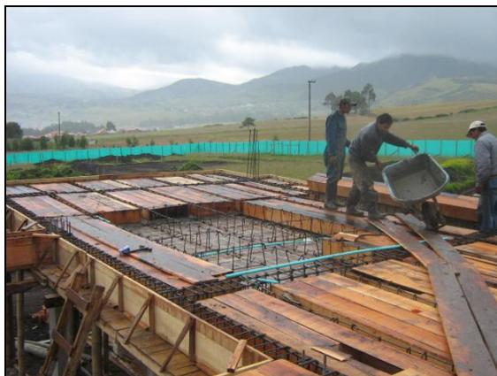
**Foto 38. Fundición de losa**
