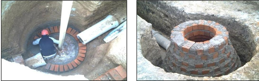
**5.3.4. Relleno.** Posteriormente se procede al relleno con material de sitio, apisonamiento y compactación con saltarín, hasta cubrir totalmente la tubería.
