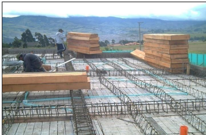
Durante la ejecución de los anteriores procesos y una vez terminados se realizó una revisión general antes de fundir, chequeando dimensiones, niveles horizontales, colocación y separación de flejes, entre otros.
