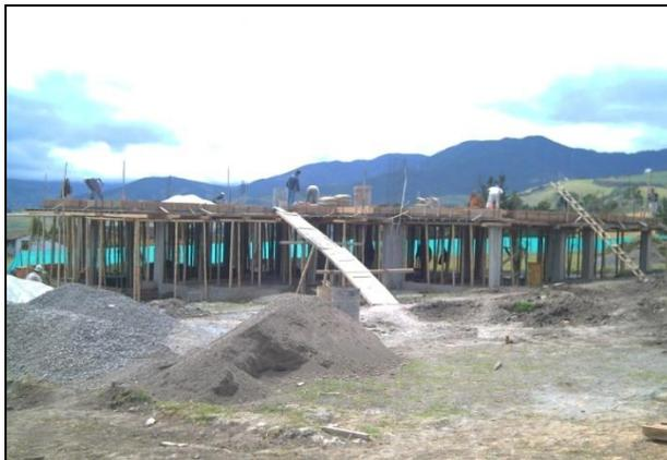
Una vez se tenga instalada toda la formaleta se procede a armar el acero de refuerzo de las vigas de entrepiso y los nervios según los planos estructurales.
