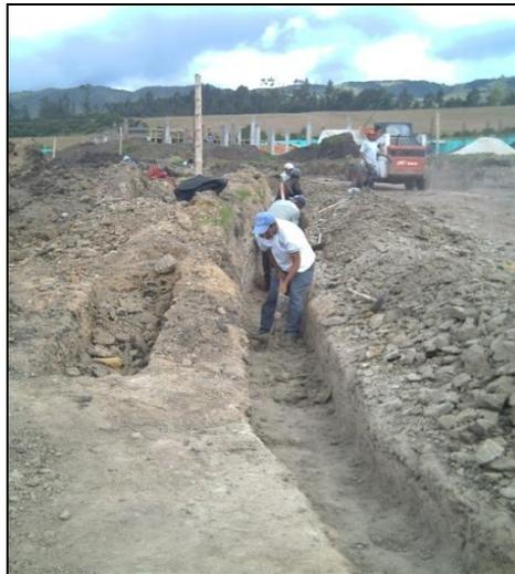
**5.4.1. Instalación red de acueducto.** Se instalaron 184 metros de tubería de presión PVC Pavco de 2 1/2", y 148 metros de 1", la tubería se instala con soldadura y limpiador pvc (ver tabla 10).
