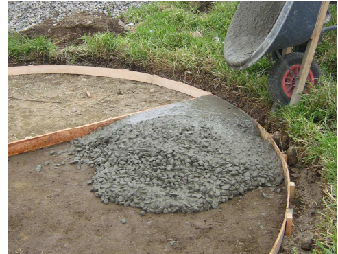
Imagen 141. Fundición de la plazoleta
