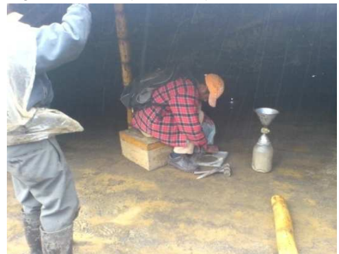
Imagen 75.Ensayo cono y arena en obra
