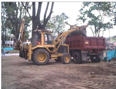
Imagen 100.Desalojo de material en volquetas
