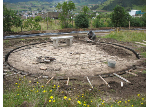
Imagen 35. colocación de los adoquines
