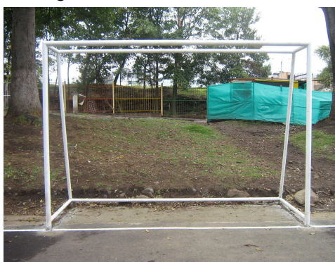
Imagen 114. Instalación de canchas
