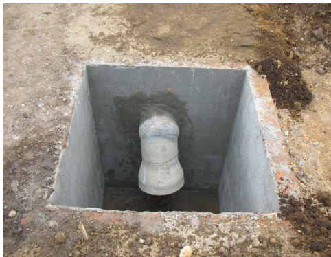
Imagen 8. Sumidero repellado y esmaltado.
