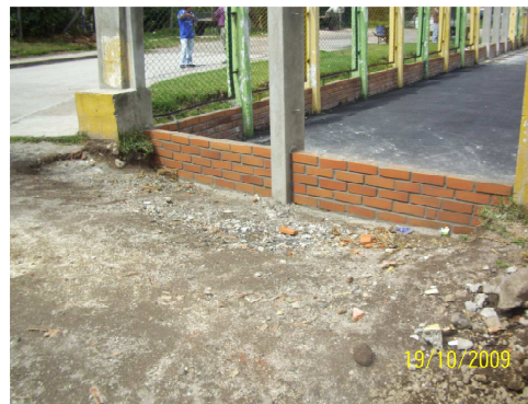
Imagen130. Construcción muro cerramiento
