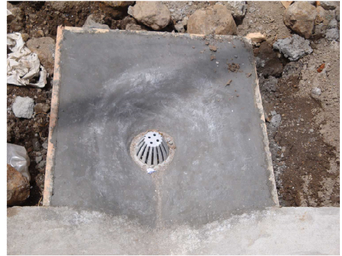
Imagen 65. Conexión tubo de 4"
