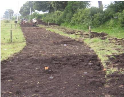
Imagen 2 inicio de la excavación
