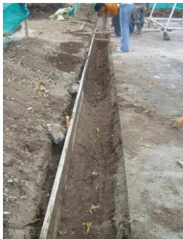
Imagen 111. Formaleta para cuneta
