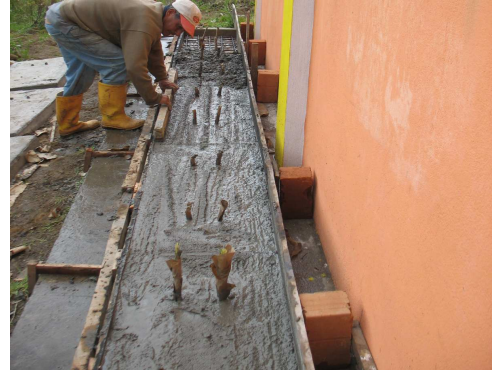
Imagen 11. Tapas armadas y fundidas
