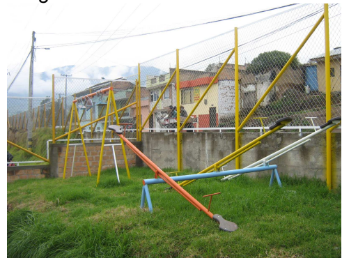
Imagen 151. Finalización de la obra.
