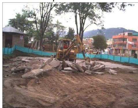
Imagen 99. Demolición de losa con Maquinaria
