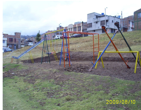
Imagen 91 Suministro e instalación de juegos infantiles
