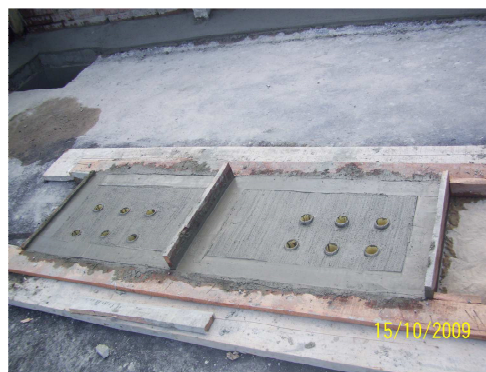
Imagen 132.tapas armadas y fundidas
