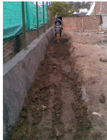
Imagen 55. Compactación material de relleno
