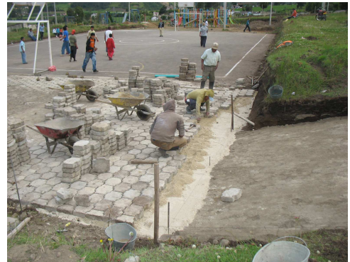
Imagen 36. Relleno de juntas con arena
