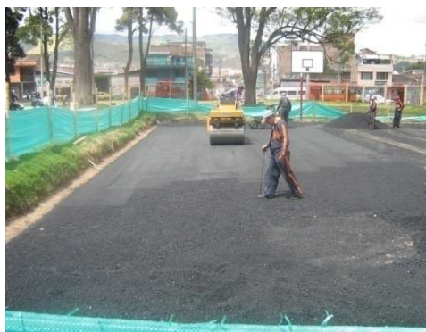
Imagen 109. Compactación de la carpeta asfáltica
