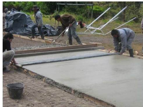
Imagen 79. Acabado de la superficie
