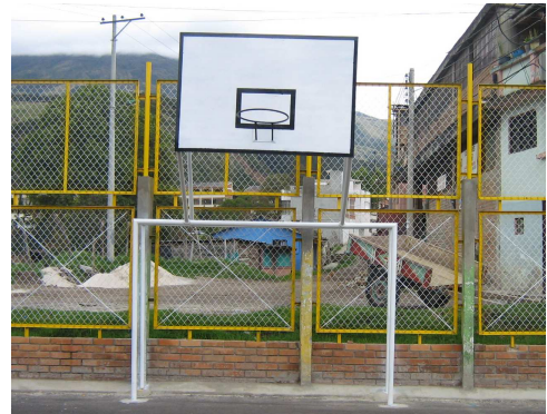
Imagen 136. Arreglo de canchas Existentes
