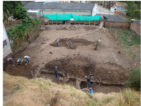
Imagen 51. Nivelación del terreno
