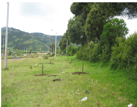
Imagen 1. Localización y replanteo del lote
