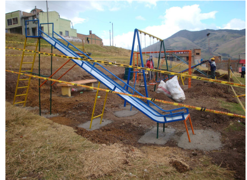
Imagen 90. Apoyo dados en concreto Ciclópeo.
