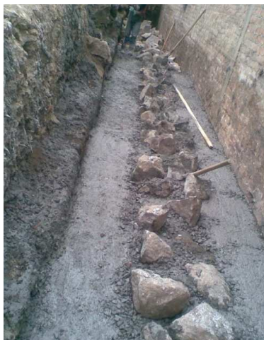
Imagen 52. Construcción de zarpa
