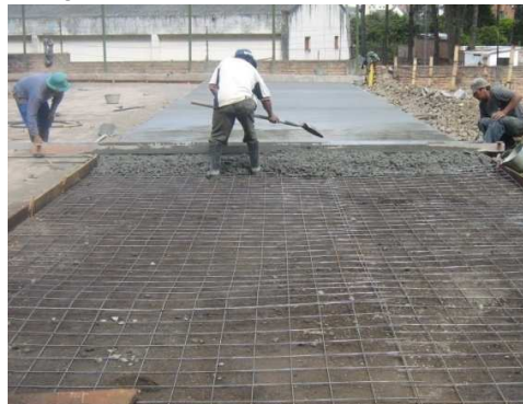
Imagen 62. Acabado de la superficie
