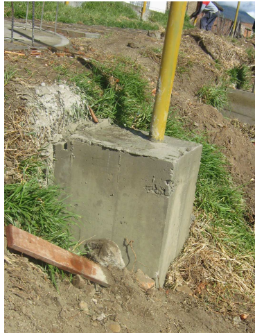
Imagen 142.dado en concreto 2500 psi
