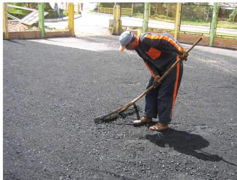
Imagen 125. Extendido de la mezcla Asfáltica
