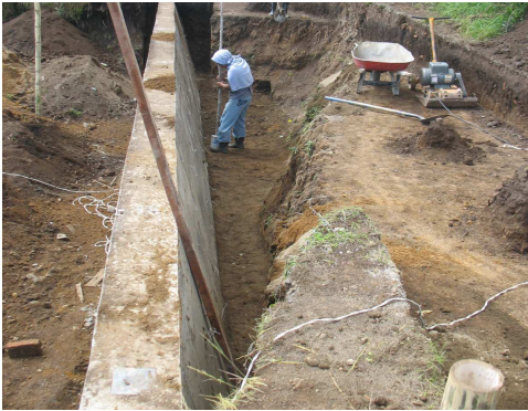
Imagen 6. Relleno con material seleccionado
