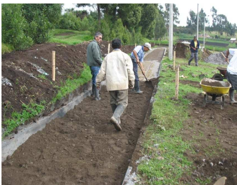
Imagen 19. Extendido de material
