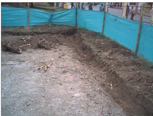
Imagen 96. Excavación de 10 cm
