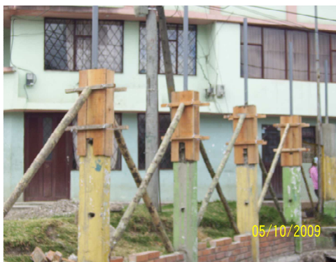
Imagen 127. Conformación de formaleta
