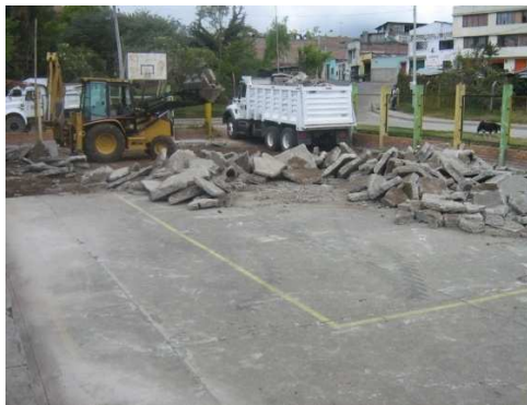
Imagen 118. Demolición de placa existente
