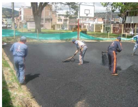
Imagen 109. Compactación de la carpeta asfáltica
