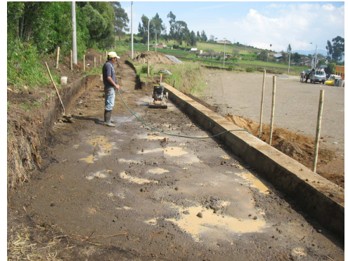
Imagen 7. Compactación de base
