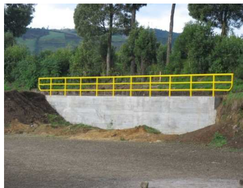
Imagen 31.Baranda pintada y terminada
