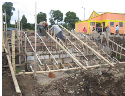
Imagen28. Conformación de formaleta
