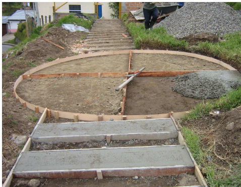
Imagen 140. conformación de formaleta.
