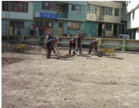
Imagen 120. Cajeo inicial de 10 cm
