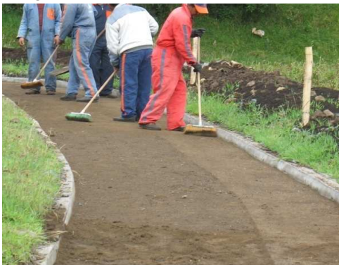
Imagen 23. Limpieza de la superficie.
