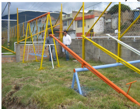
Imagen 148. Suministro e instalación de juegos infantiles
