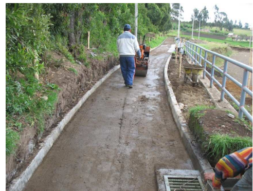
Imagen 20 Compactación del material.
