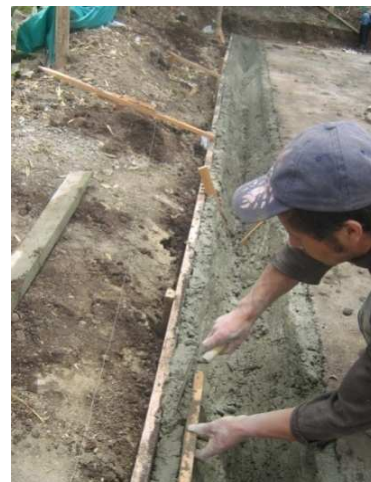
Imagen 112. construcción de cuneta
