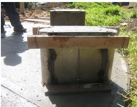
Imagen 143. Construcción de las bancas
