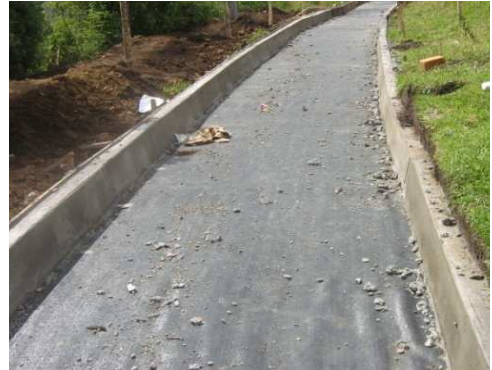
Imagen 18. fundicion y curado de bordillos
