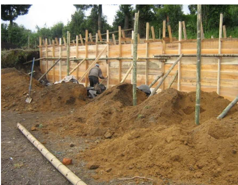
Imagen 4. Formaleta y fundición de muros.
