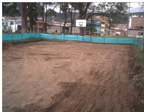
Imagen 97. Preparación de la subrasante
