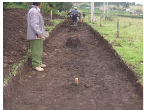
Imagen 3 .Excavación del terreno Manualmente
