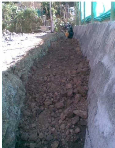
Imagen 54. Relleno con material de sitio
