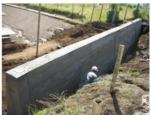
Imagen 5. Terminación del muro.
