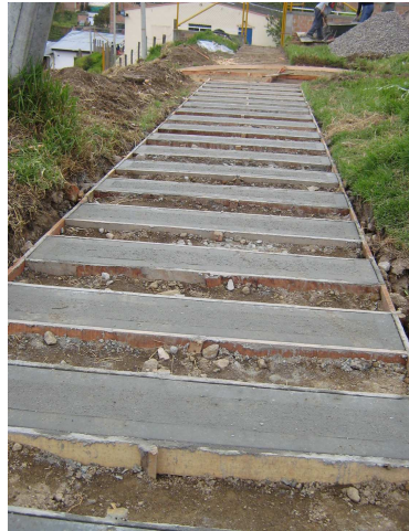
Imagen 139. construcción de losetas en concreto
