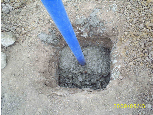
Imagen 89. Fundición dados en concreto Ciclópeo.
