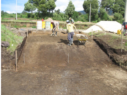
Imagen 34. Extendido y nivelación de la capa de arena
