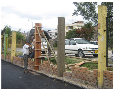
Imagen 128. fundicion de columnas
