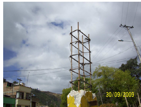
Imagen 119 demolición de columnas
