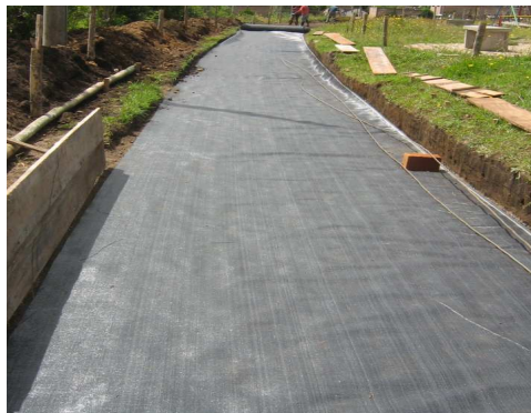
Imagen 16.instalacion de geotextil
