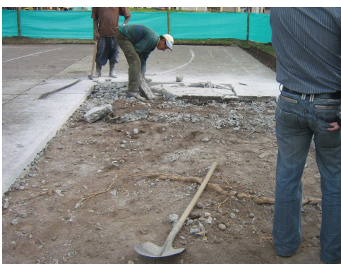
Imagen 98. Demolición manual de paños
