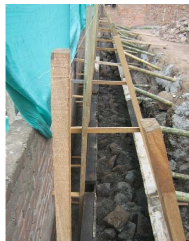
Imagen 53. fundicion muro de contención
