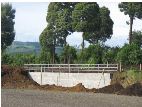
Imagen 30.Suministro e instalación de baranda
