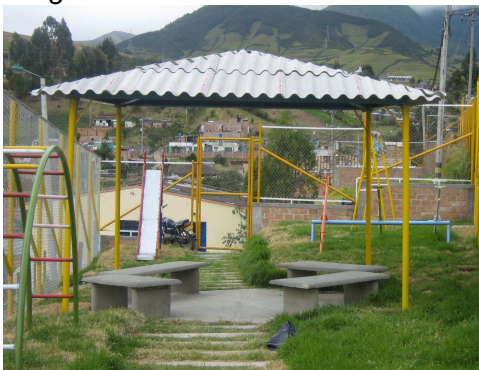
Imagen 150. cubierta en asbesto cemento
