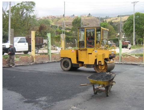
Imagen 126. Compactación carteta Asfáltica
