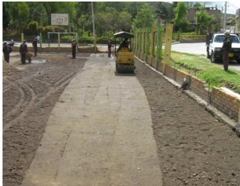
Imagen 123. Compactación de la base
