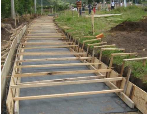
Imagen 17. conformacion de formaleta
