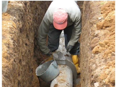
Imagen 13. Revoque de tubería.
