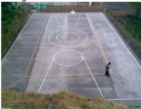
Imagen 67. líneas de demarcación
