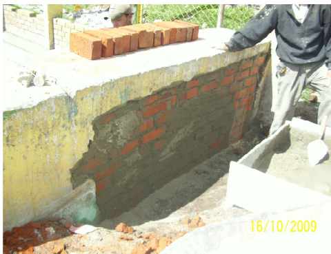
Imagen 129. Construcción muro de Graderías
