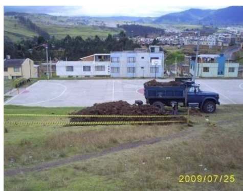
Imagen 88. desalojo del material en volquetas.
