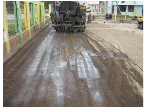
Imagen 122. humedecimiento con tanque irrigador.
