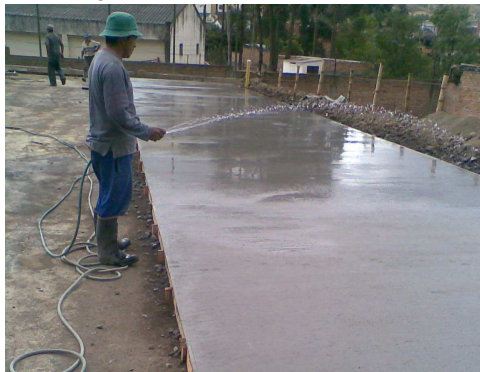
Imagen 63. Proceso de curado
