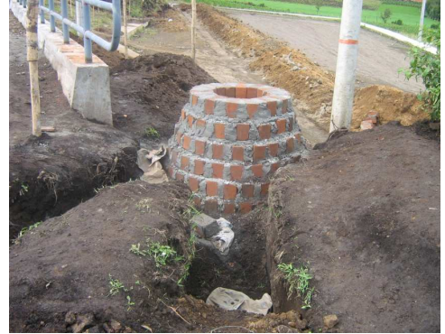
Imagen 15.terminacion cámara de insp
