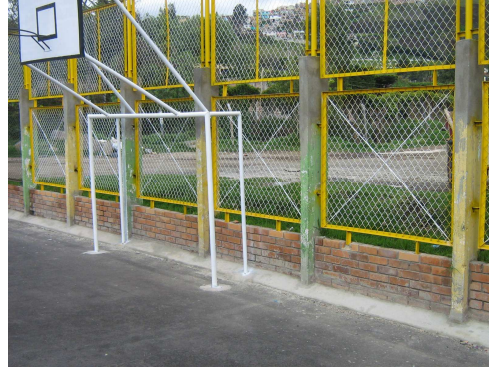
Imagen 134. Arreglo de mallas existentes
