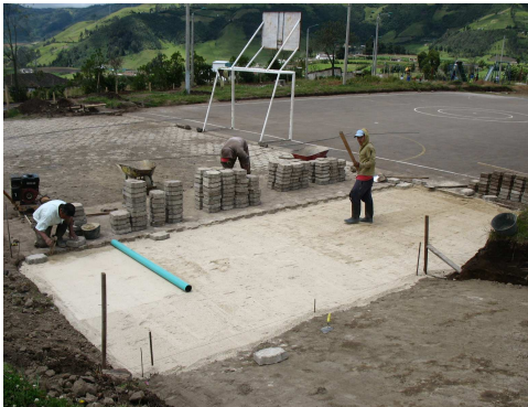
Imagen 36. Relleno de juntas con arena
