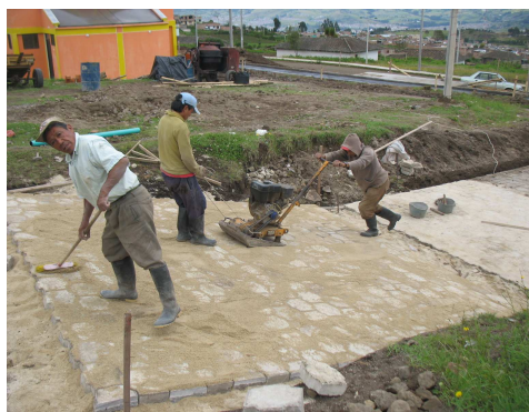
Imagen 36. Relleno de juntas con arena
