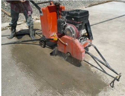
Imagen 80. Corte de juntas transversales
