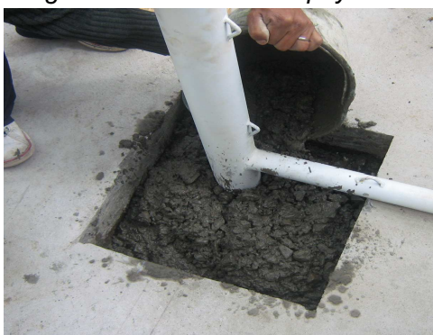
Imagen 68. Fundición de apoyos de las canchas.
