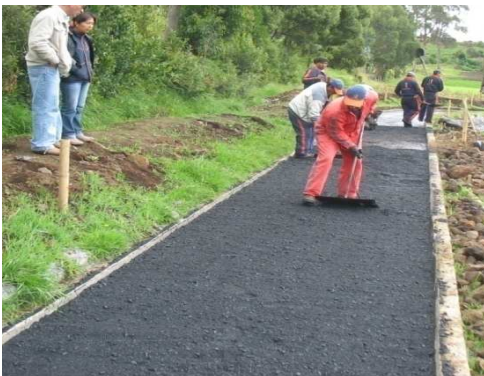
Imagen 25. Extendido de la mezcla
