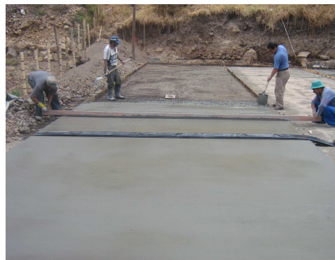
Imagen 62. Acabado de la superficie
