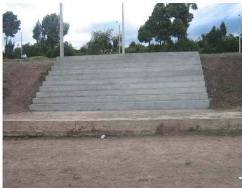
Imagen 29.terminacion gradas de acceso.
