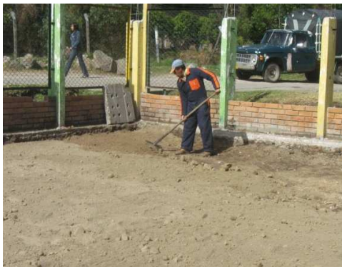
Imagen 121. Extensión de material para base
