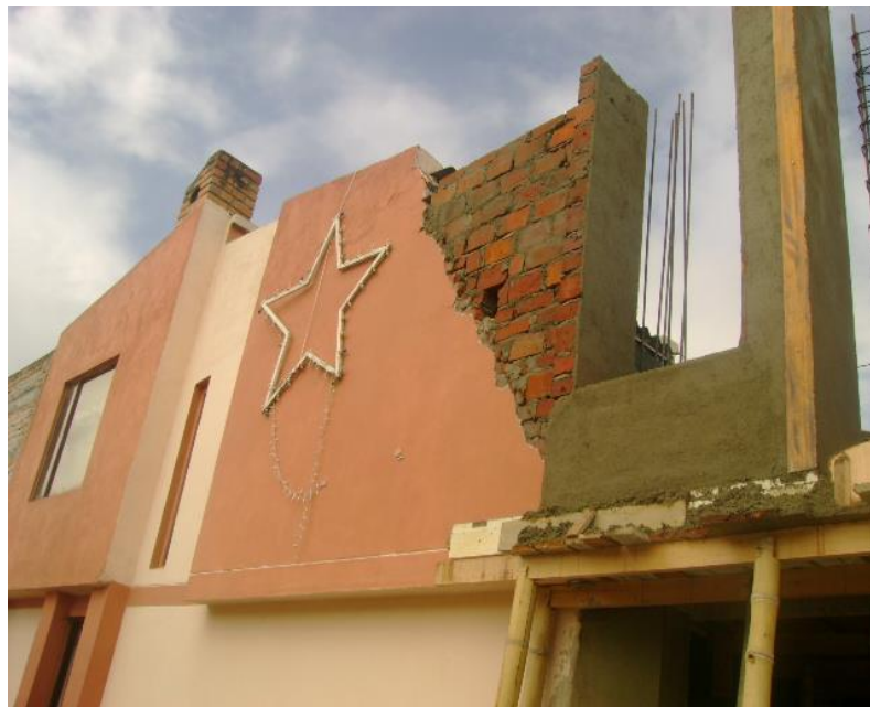
Figura 14. Cambio de fachada
