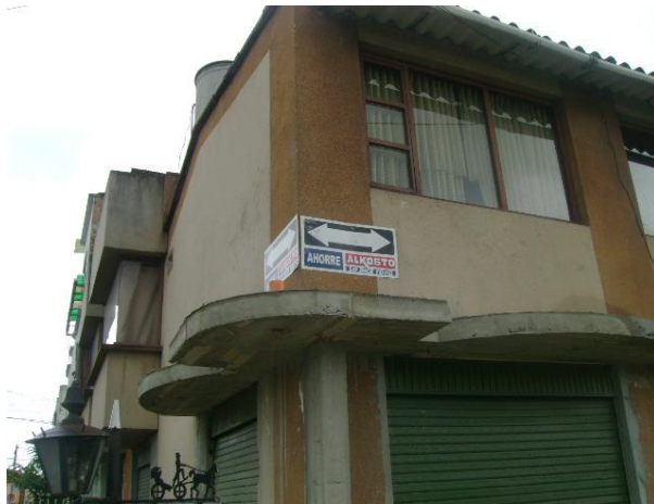
Figura 17. Voladizos no ajustados a las normas
