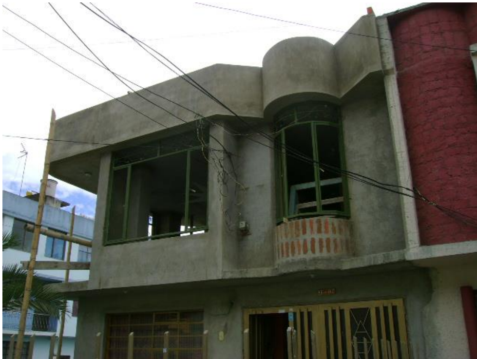
Figura 15. Cambio de Cubierta a losa
