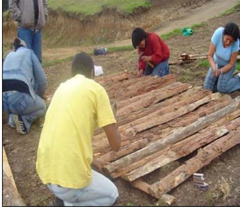
**FIGURA 25.- CONFORMACIÓN DE PANELES**
