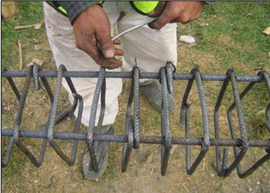
**FIGURA 53.- ARMADO DEL ACERO DE REFUERZO PARA COLUMNAS**
