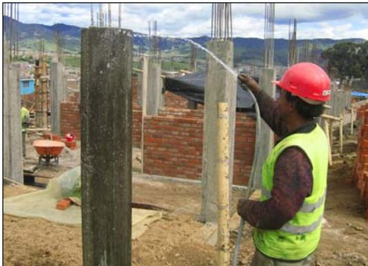
FIGURA 86.- CURADO DE COLUMNAS.
