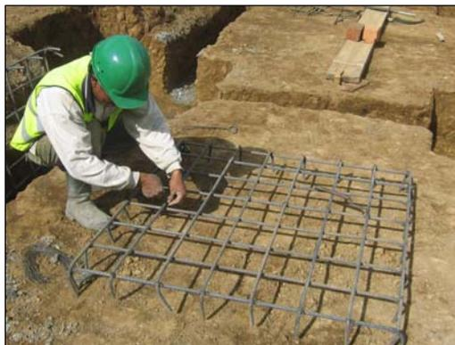
**FIGURA 55.- ARMADO DE PARRILLAS PARA ZAPATAS**
