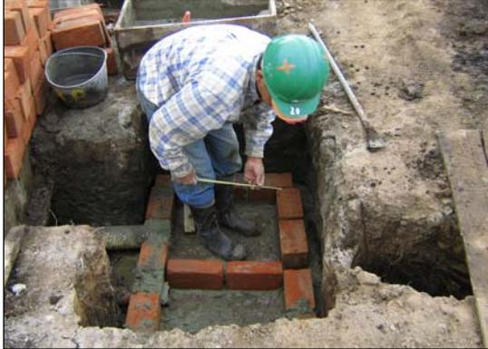
**FIGURA 95.- CONSTRUCCIÓN DE CAJAS DE INSPECCIÓN.**
