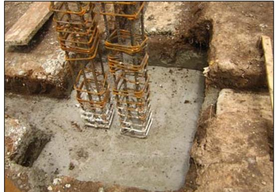
**FIGURA 72.-** FUNDICIÓN DE ZAPATAS CONJUNTAS.
