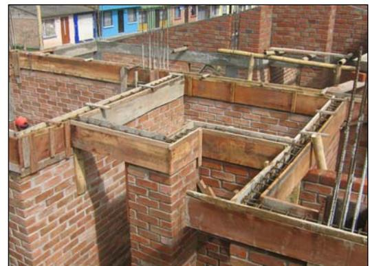
FIGURA 89.- ENCOFRADO DE VIGAS AÉREAS.
