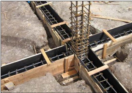
**FIGURA 75.- ENCOFRADO DE VIGAS DE AMARRE**
