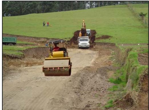
FIGURA 38.- EMPLEO DE VIBROCOMPACTADOR
