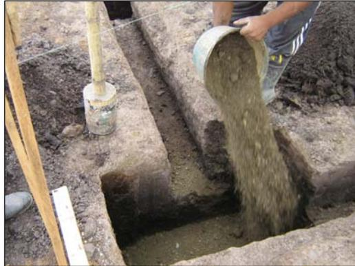
**FIGURA 50.- COLOCACIÓN MEZCLA DE SUELO-CEMENTO**
