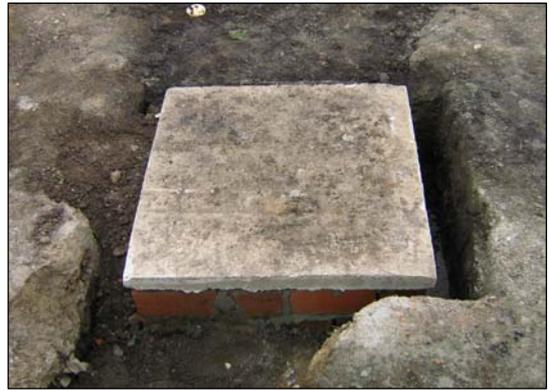
**FIGURA 98.- CAJA DE INSPECCIÓN CON TAPA.**
