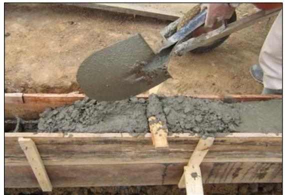
**FIGURA 76.- FUNDICIÓN DE VIGAS DE AMARRE**
