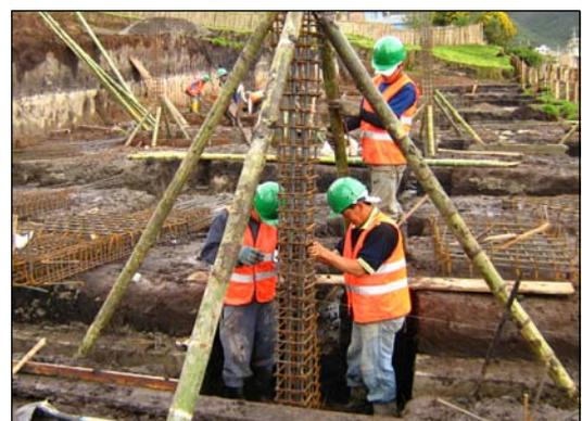
**FIGURA 69.- APOYO DEL ACERO DE REFUERZO PARA COLUMNAS.**
