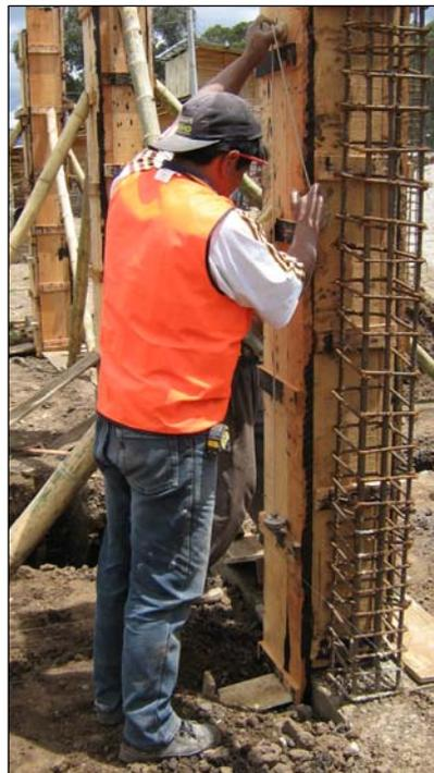
**FIGURA 84.- CHEQUEO DE VERTICALIDAD DE COLUMNAS.**
