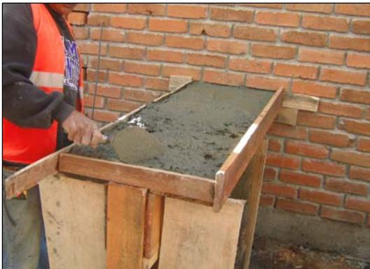
**FIGURA 107.- FUNDICIÓN DE MESÓN**
