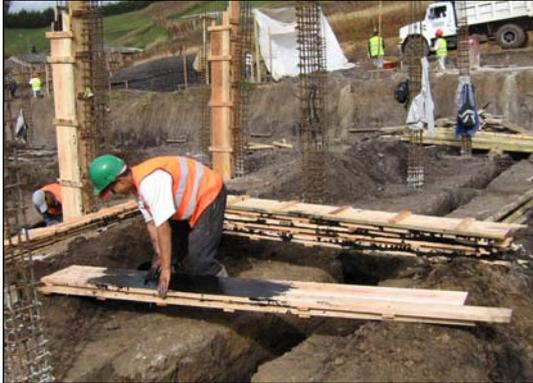
**FIGURA 82.- APLICACIÓN DE ANTIADHERENTE.**
