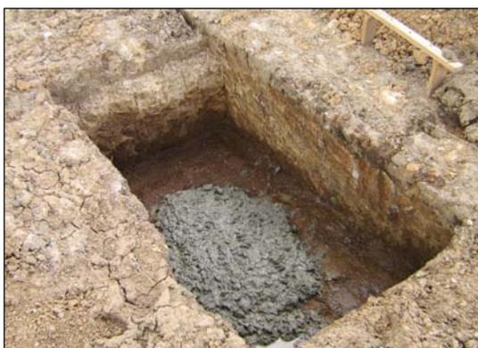
**FIGURA 64.- SOLADO EN ZAPATAS**
