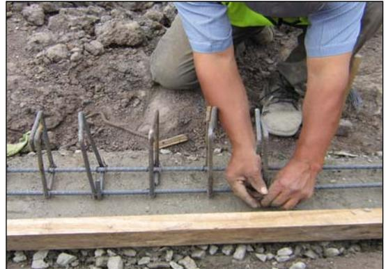
**FIGURA 54.- ARMADO DE VIGAS DE AMARRE**
