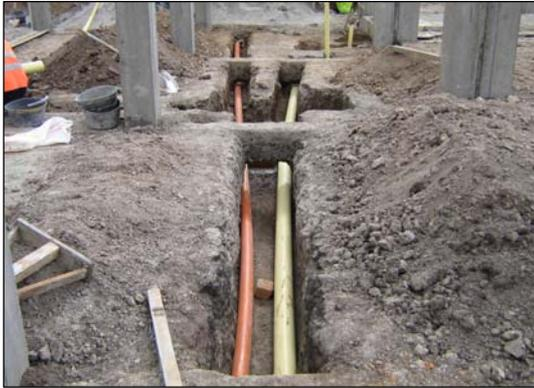
**FIGURA 99.- TUBERÍA PARA AGUAS LLUVIAS Y AGUAS SERVIDAS.**
