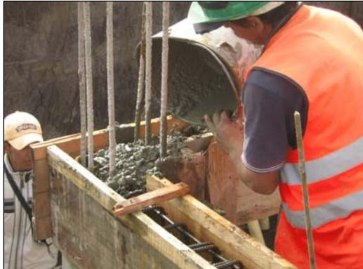
**FIGURA 90.- FUNDICIÓN DE VIGAS AÉREAS**
