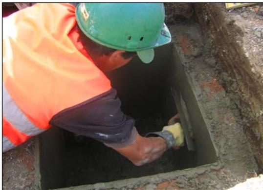
**FIGURA 97.- ESMALTADO DE CAJAS DE INSPECCIÓN.**
