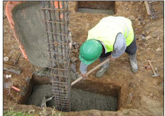
**FIGURA 67.- FUNDICIÓN DE ZAPATAS INDIVIDUALES.**
