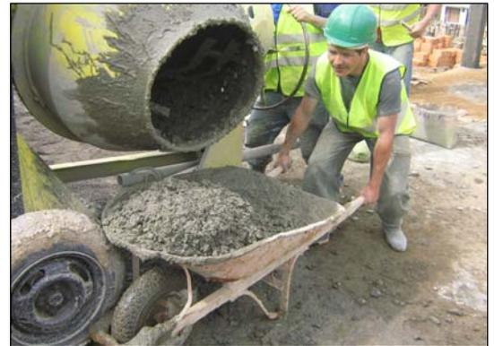
**FIGURA 59.- TRANSPORTE DEL CONCRETO**
