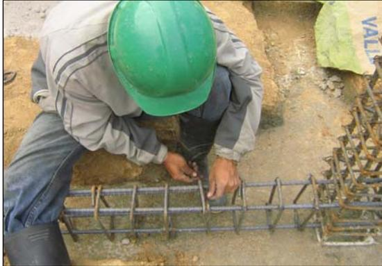
**FIGURA 73.- AMARRE DE VIGAS CON COLUMNAS**
