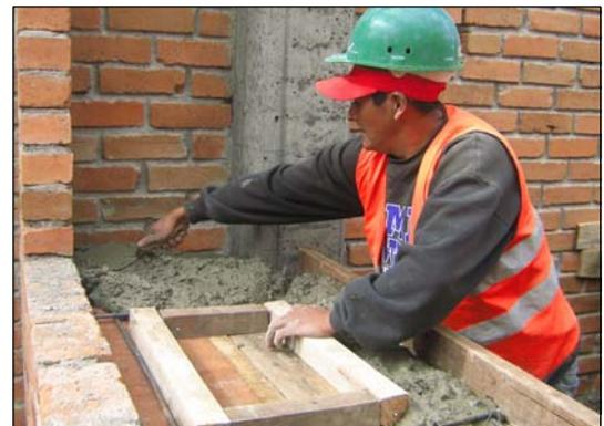
**FIGURA 108.- FUNDICIÓN DE LAVAPLATOS**
