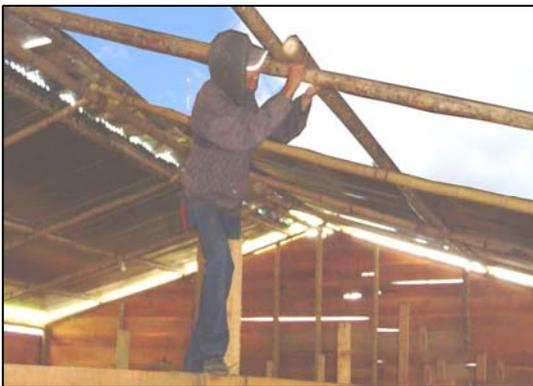
**FIGURA 21.- CONSTRUCCIÓN CUBIERTA DEL CAMPAMENTO**
