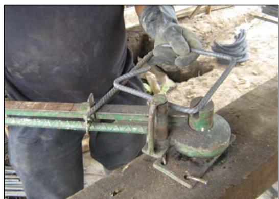
**FIGURA 52.- FIGURADO DE ACERO**
