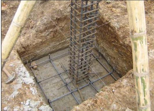
**FIGURA 66.- AMARRADO DE ACERO DE REFUERZO DE COLUMNA CON ACERO DE REFUERZO DE ZAPATAS INDIVIDUALES**
