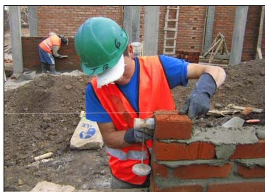
**FIGURA 104.-** CHEQUE DE VERTICALIDAD EN MUROS
