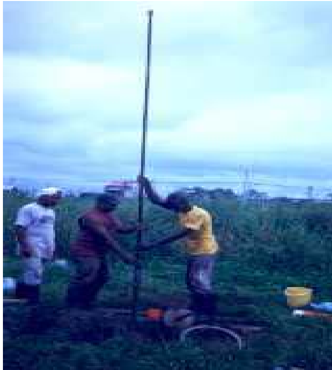
Construcción de sondeos.
