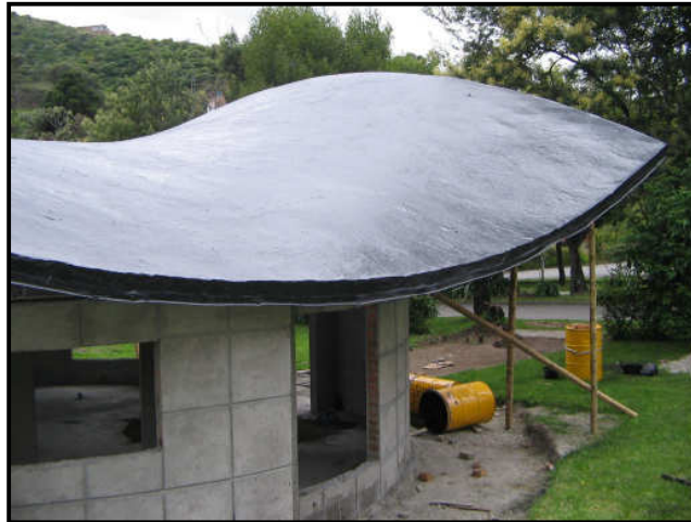
Figura 33. Impermeabilización de la cubierta - Kiosco de Internet No. 2
