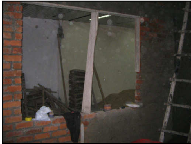
Figura 55. Repello de muros del almacén del Departamento de Física.
