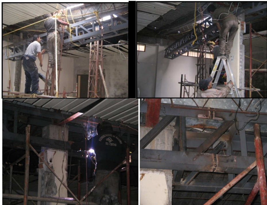
Figura 53. Instalación de la cercha en el Lab. 2 del Departamento de Física
