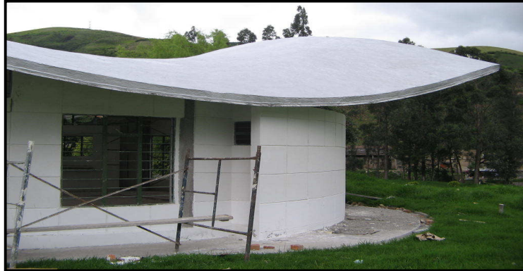
Figura 11. Estucado de muros del Kiosco de Internet No. 1
