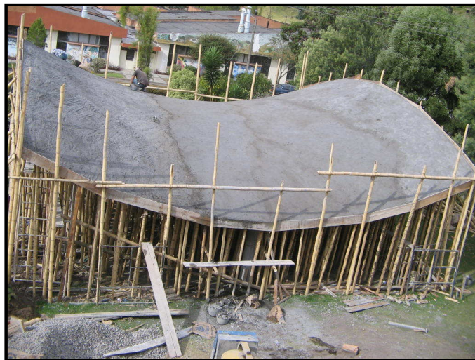
Figura 32. Repello parte superior de la cubierta - Kiosco de Internet No. 2
