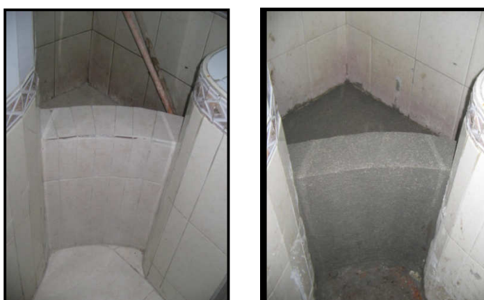
Figura 83. Reparación de poseta del Bloque 3.
