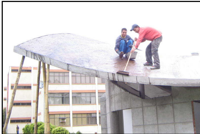
Figura 15. Impermeabilización de la cubierta - Kiosco de Internet No. 1
