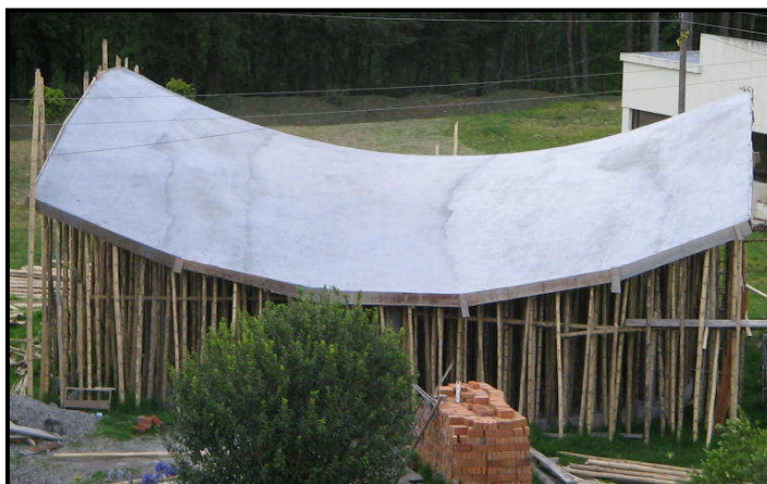
Figura 14. Parte superior de la cubierta repellada - Kiosco de Internet No. 1
