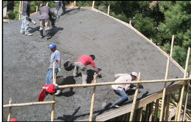
Figura 25. Fundición de la cubierta - Kiosco de Internet No. 2
