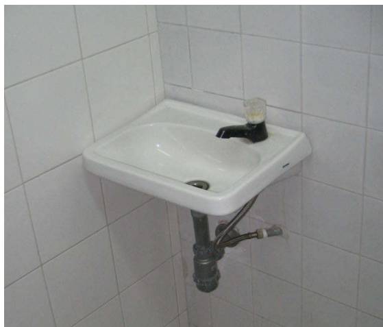
Figura 75. Lavamanos reubicado del baño de damas del Dep. de Recursos hidrobiológicos
