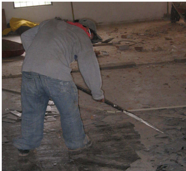
Figura 42. Retiro de vinisol del laboratorio 6 del Departamento de Física.
