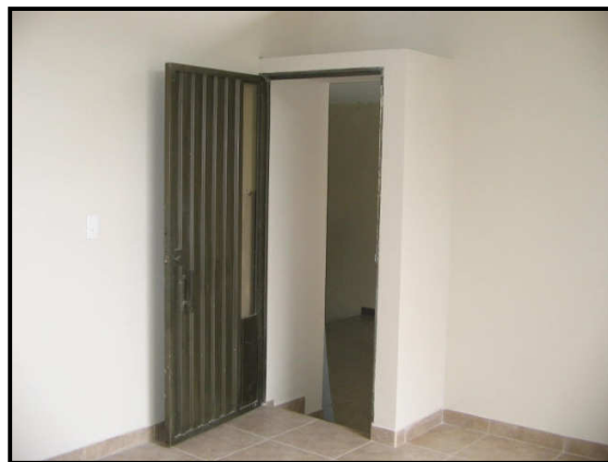
Figura 58. Muros terminados de la oficina de profesores del Departamento de Física.
