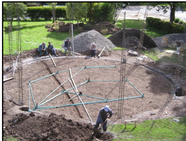
Figura 28. Instalación eléctrica de piso - Kiosco de Internet No. 2
