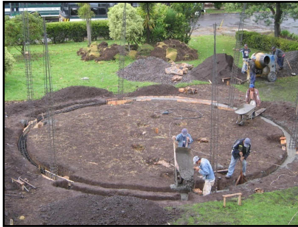
Figura 21. Fundición viga de cimentación - Kiosco de Internet No. 2
