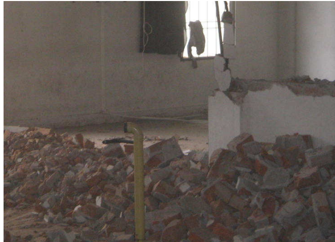
Figura 41. Demolición de muros en el laboratorio 2 del Departamento de Física.
