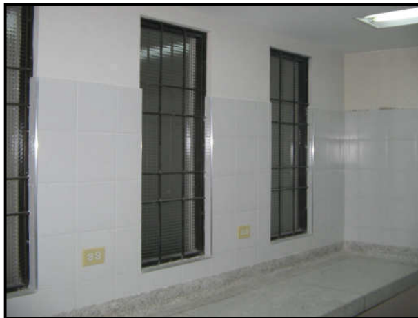
Figura 62. Enchape de pared del Laboratorio de Sanidad y Patología Acuícola.
