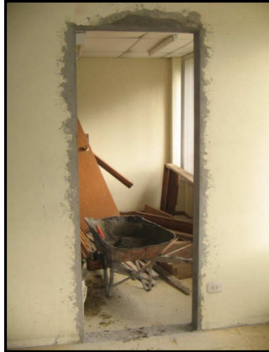
Figura 69. Vano de puerta en el Departamento de recursos hidrobiológicos
