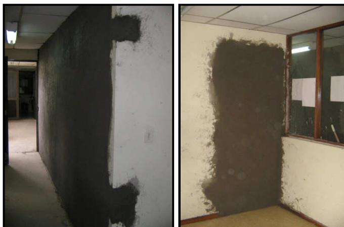
Figura 71. Repello muro biblioteca y cerramiento de puerta del departamento de Recursos hidrobiológicos
