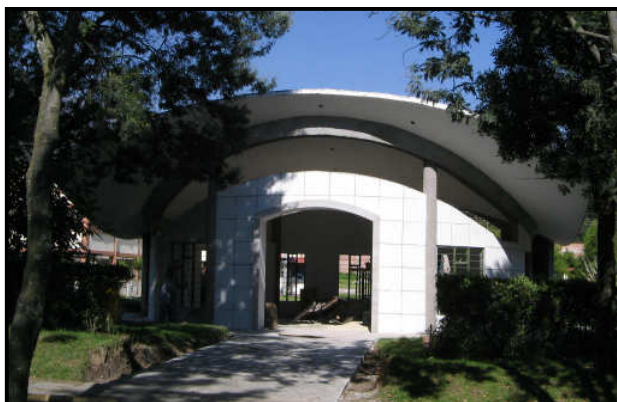
Figura 31. Muros estucados - Kiosco de Internet No. 2
