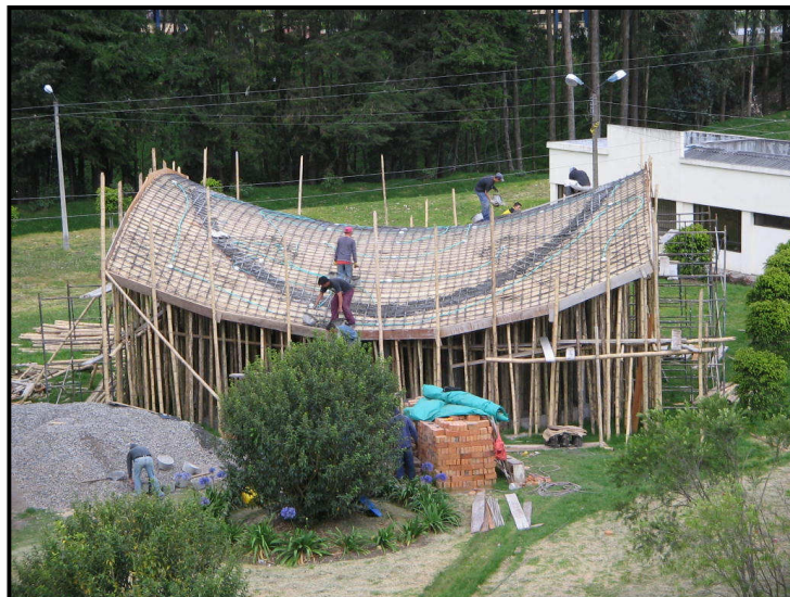
Figura 6. Fundición viga aérea del Kiosco de Internet No. 1
