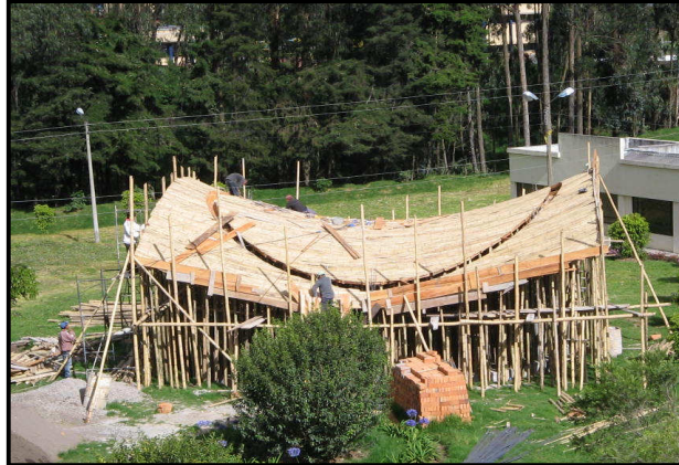
Figura 7. Formaleta de la cubierta del Kiosco de Internet No. 1
