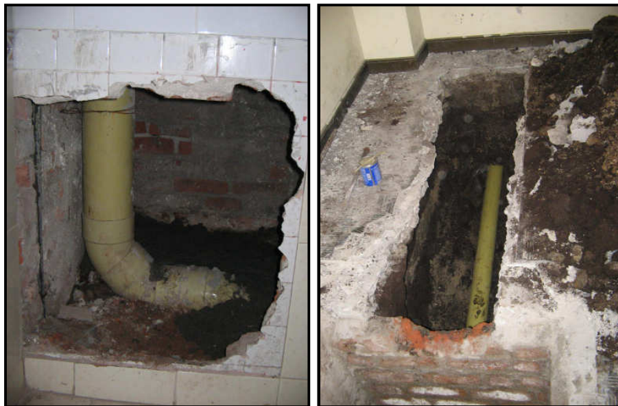
Figura 84. Sustitución de Tubería de 4" en PVC - del baño de damas y Aula 101 – bloque 3
