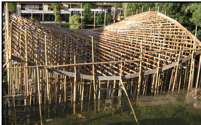
Figura 24. Formaleta cubierta - Kiosco de Internet No. 2
