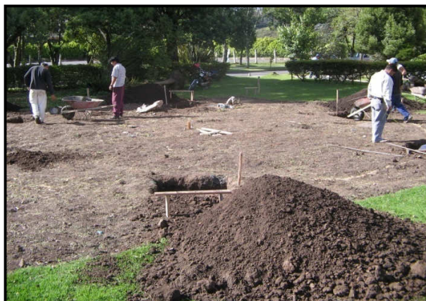
Figura 19. Excavación de zapatas - Kiosco de Internet No. 2
