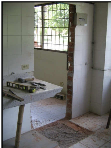
Figura 73. Demolición del Mesón del laboratorio del Dep. de Recursos hidrobiológicos
