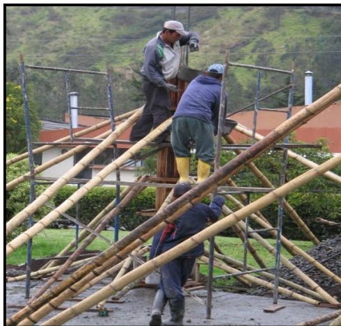
Figura 22. Fundición de columnas - Kiosco de Internet No. 2
