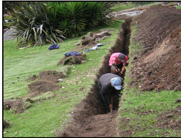
Figura 18. Excavación de Chambas - Kiosco de Internet No. 2
