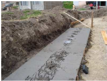
Fig. No 39 Base Muro de contención Fig. No 40 Formaleta Muro
