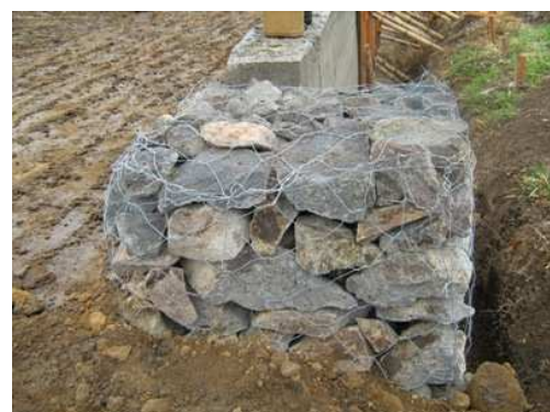
Fig. No 43 Muro en gaviones.
