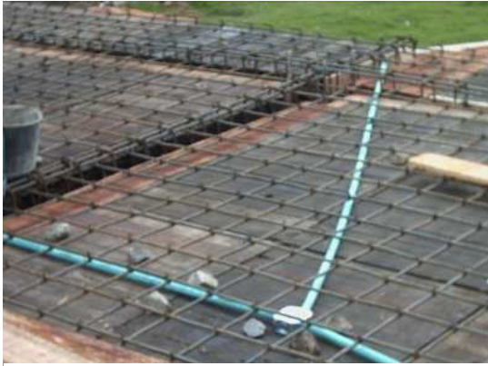
Fig. No 73 Formaleta e instalaciones eléctricas
