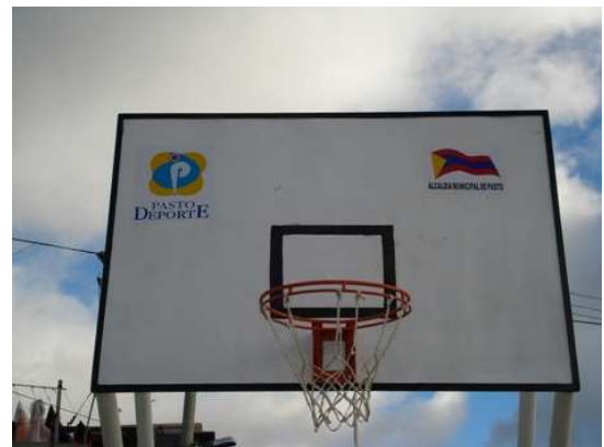
Fig. No 35 Arreglo de canchas existentes
