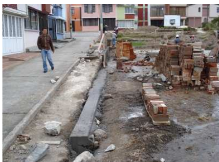
Fig. No 84 Viga cimentación cerramiento
