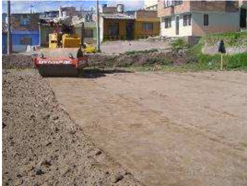
Fig. No 16 Base en recebo compactado
