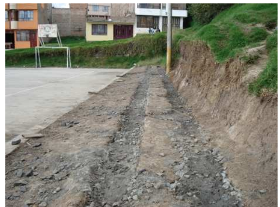
Fig. No 25 Ccto. Ciclópeo graderías.
