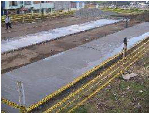
Fig. No 18 Fundición de losa.
