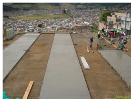
Fig. No 45 Fundición de placa
