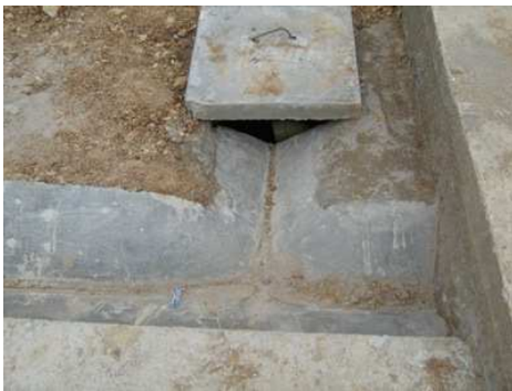
Fig. No 46 Cunetas con conexión
