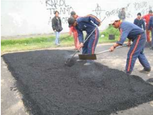
Fig. No 8 Riego del asfalto
