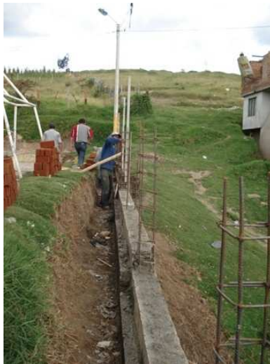
Fig. No 26 Cimentación cerramiento
