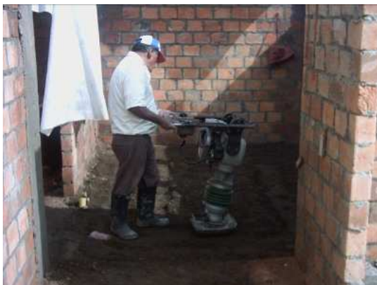
Fig. No 68 Base en recebo compactado
