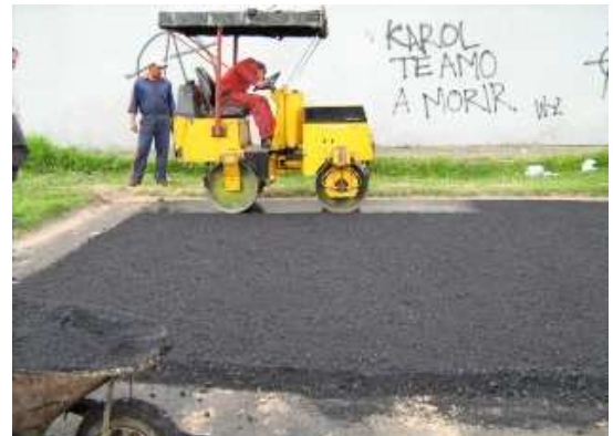
Fig. No 9 Compactación del asfalto
