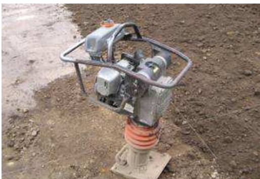
Fig No 3 Compactación base en recebo
