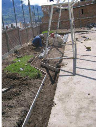
Fig. No 32 Construcción de cuneta y placa
