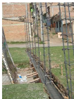
Fig. No 93 Viga de cimentación y columnas
