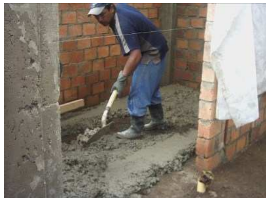
Fig. No 69 Fundición de placa de piso
