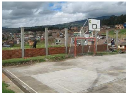
Fig. No 96 Muro en ladrillo común
