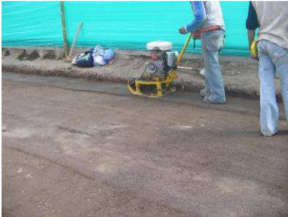
Fig. No 50 Compactación base en recebo.
