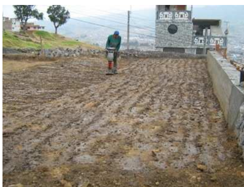
Fig. No 42 Relleno con material seleccionado
