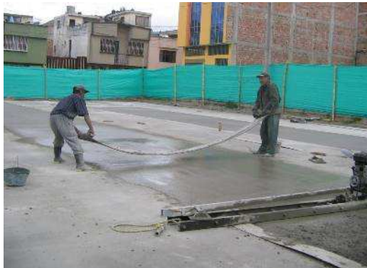
Fig. No54 Terminado de placa
