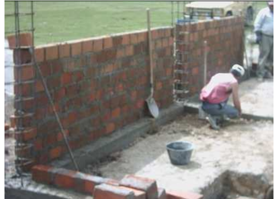
Fig. No 67 Muro en ladrillo común sencillo
