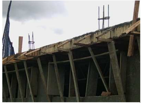
Fig. No74 Formaleta losa y vigas.
