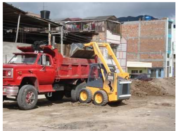
Fig. No 49 Excavación y retiro.
