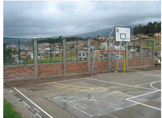
Fig. No 100 Cerramiento de protección terminado.
