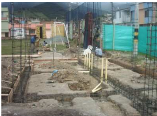
Fig. No 64 Acero de refuerzo
