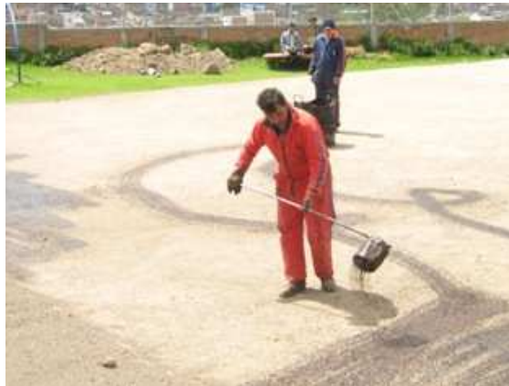
Fig No 5 Imprimación con MC-70
