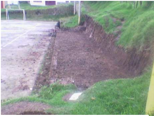
Fig. No 22 Excavación graderías
