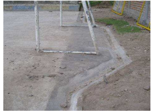
Fig. No 33 Cunetas y Placa adicional.
