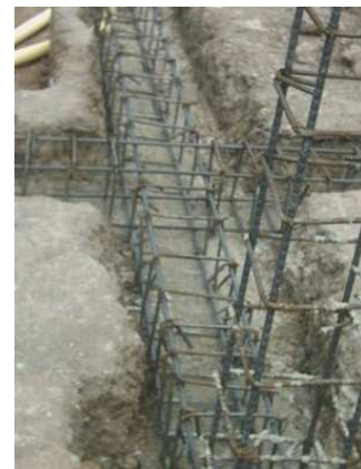
Fig. No 65 Acero de refuerzo vigas y columnas
