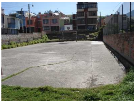
Fig. No 82 Estado inicial polideportivo
