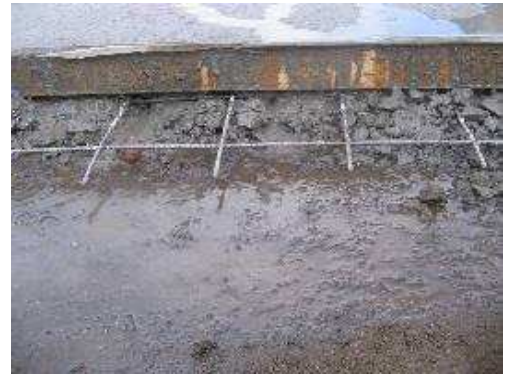
Fig. No 19 Malla electrosoldada.
