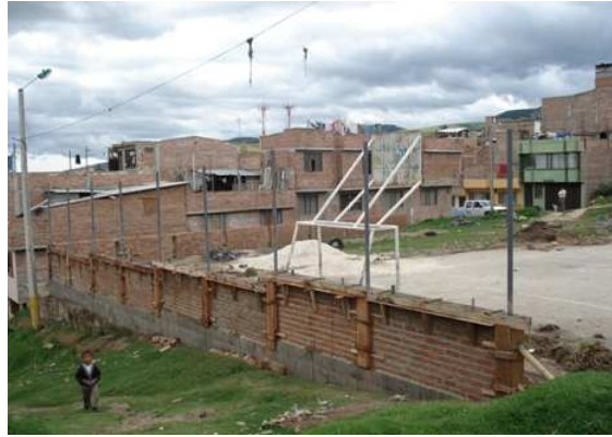
Fig. No 29 Fundición Columnas y viga sobre muro
