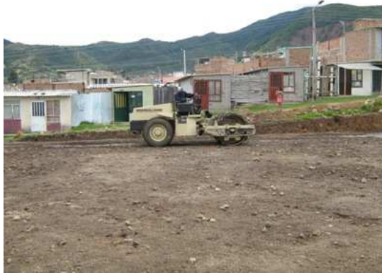
Fig. No103 Base en recebo compactado.
