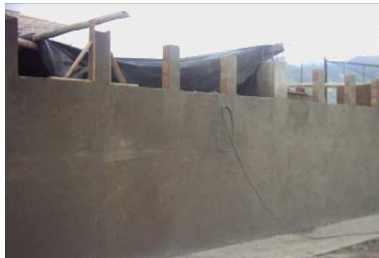
Fig. No 72 Repello de muros.
