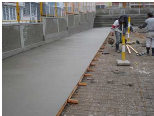
Fig. No 89 Fundición losa
