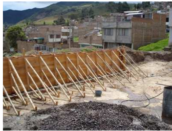
Fig. No 39 Base Muro de contención Fig. No 40 Formaleta Muro
