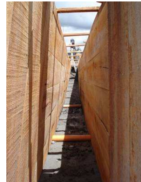
Fig. No 41 Formaleta y lagrimales muro
