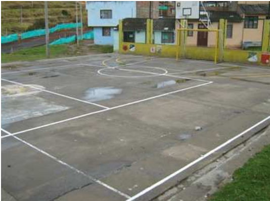
Fig. No 99 Líneas de demarcación continuas
