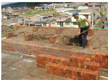
Fig. No 97 Relleno graderías
