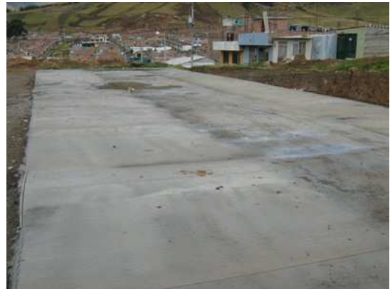
Fig. No104 Losa maciza de 3000psi.
