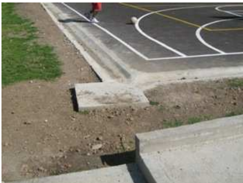
Fig. No 10 Cunetas y caja de conexión.
