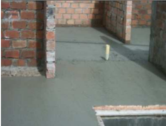
Fig. No 70 Placa de piso espesor 8cm
