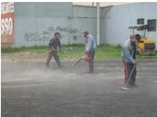
Fig No 6 Limpieza Imprimación
