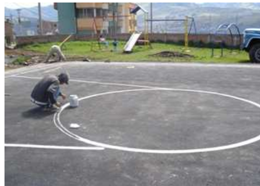
Fig. No 11 Líneas de demarcación continuas
