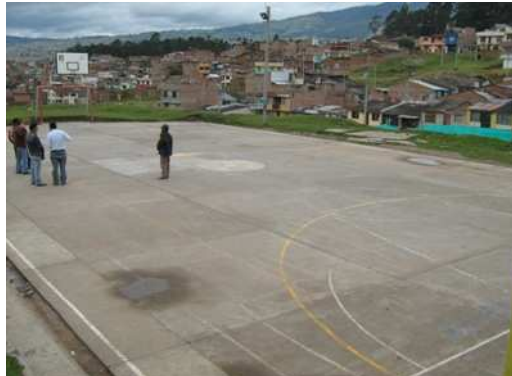
Fig. No 92 Estado inicial Polideportivo
