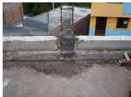
Fig. No 85 Columnas cerramiento
