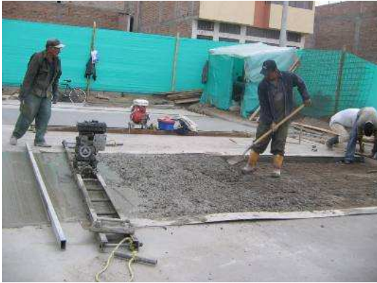
Fig. No52 Fundición de placa.
