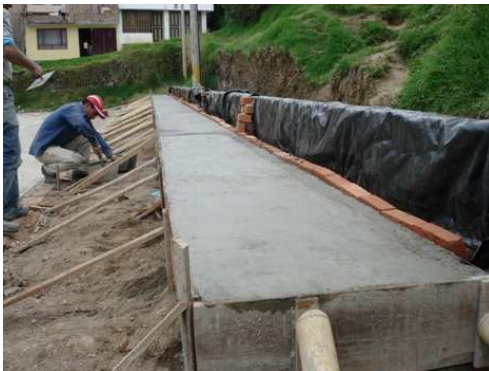
Fig. No 30 Fundición de placa para graderías
