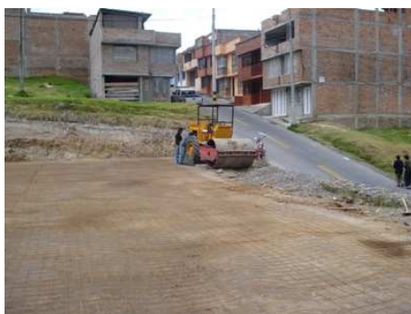
Fig. No 44 Base en recebo compactado
