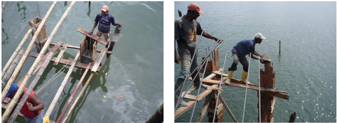
Figura 117. Hincado de pilotes para el descanso o apoyo de la escalera
