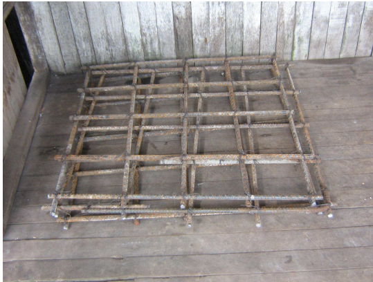
Figura 100. Armado del refuerzo
