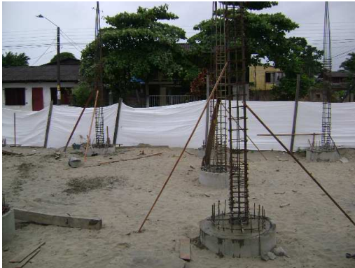
Figura 8. Fundición total de caisson
