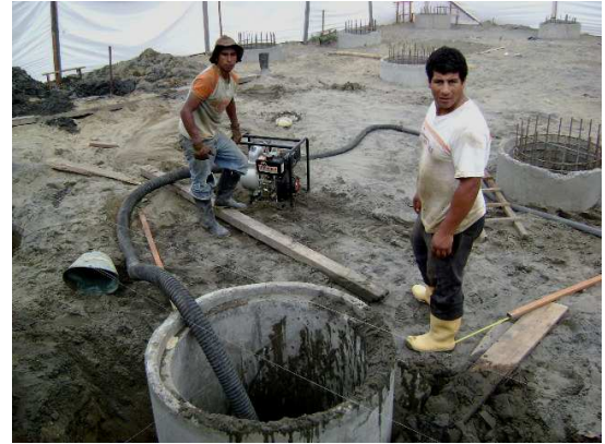
Figura 5. Excavación e instalación de tubería caisson
