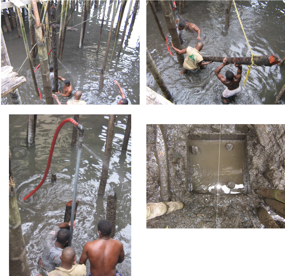
Figura 99. Hincado de pilotes
