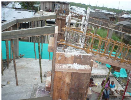
Figura 82. Desencofrado de las vigas de cubierta
