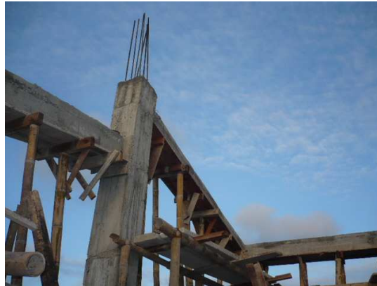
Figura 37. Fundición de vigas de cubierta
