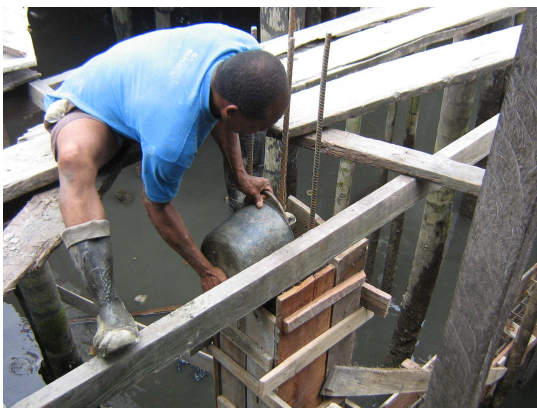
Figura 107. Fundición de las columnas
