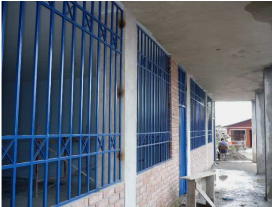
Figura 56. Instalación de puertas y ventanas
