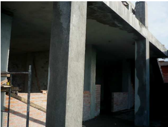
Figura 46. Repello de columnas y vigas
