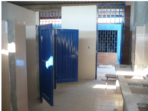
Figura 95. Instalación de puertas
