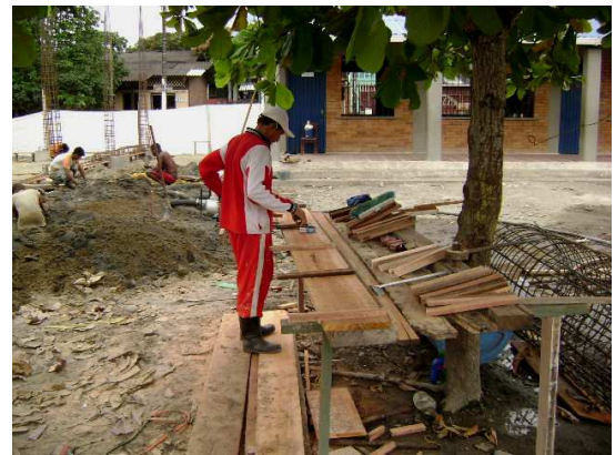
Figura 14. Construcción de la formaleta para columnas
