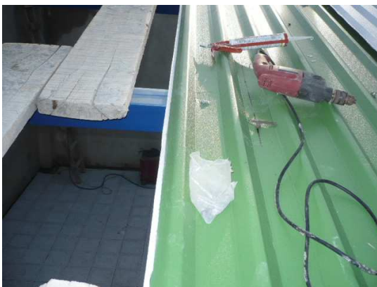
Figura 57. Instalación cubierta termo acústica
