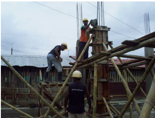
Figura 14. Construcción de la formaleta para columnas
