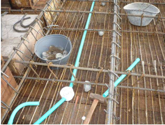
Figura 24. Instalación de ductos eléctricos
