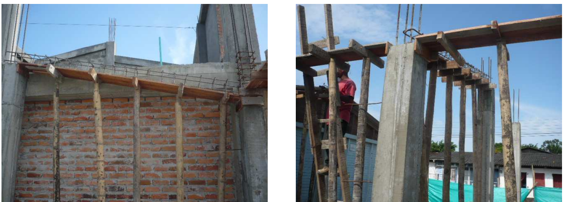
Figura 80. Armado del refuerzo
