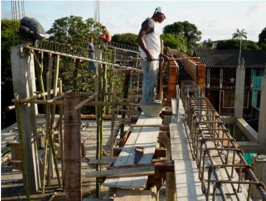
Figura 36. Armado del refuerzo
