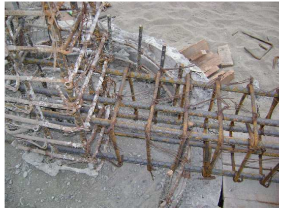
Figura 11. Armado y amarrado de refuerzo de vigas de cimentación
