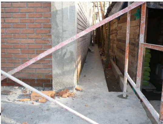
Figura 49. Fundición del andén
