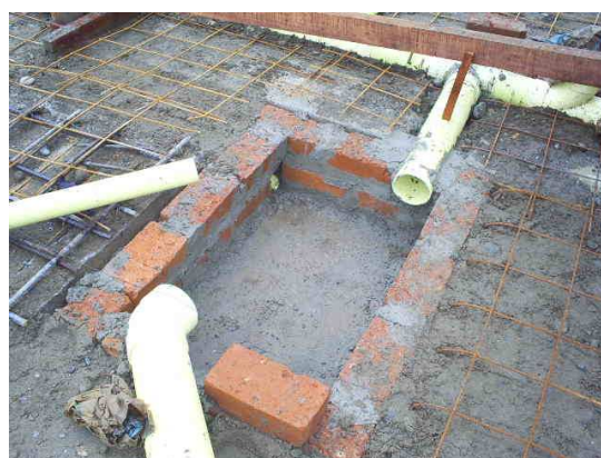
Figura 72. Caja de inspección
