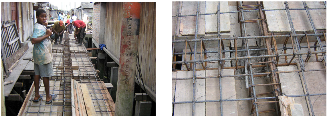
Figura 110. Armado de la losa
