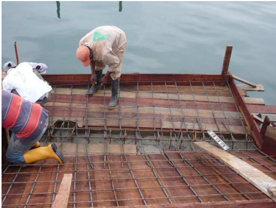
Figura 119. Construcción de la escalera
