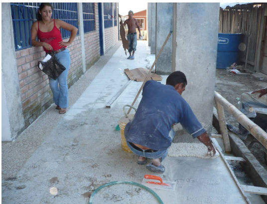
Figura 58. Instalación de granito en escalera y pasillo
