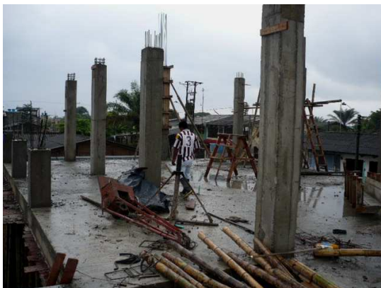
Figura 32. Fundición de las columnas
