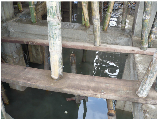
Figura 114. Vigas de cimentación de la losa del mirador
