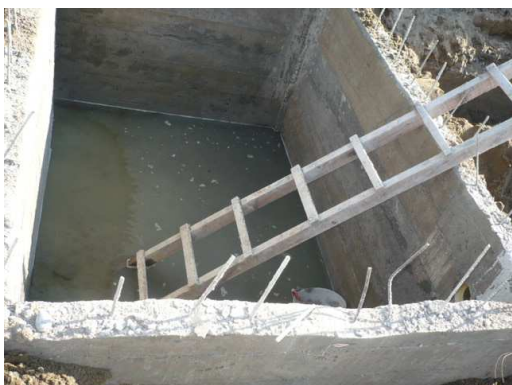
Figura 71. Filtro anaeróbico
