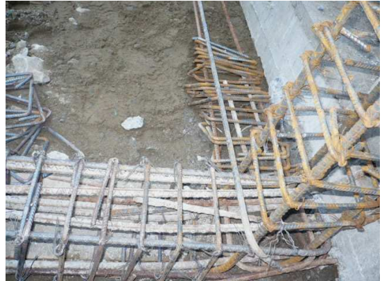
Figura 64. Armado de refuerzo para vigas de cimentación
