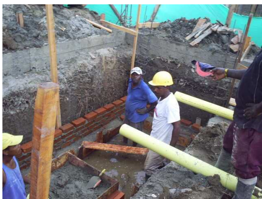
Figura 71. Filtro anaeróbico
