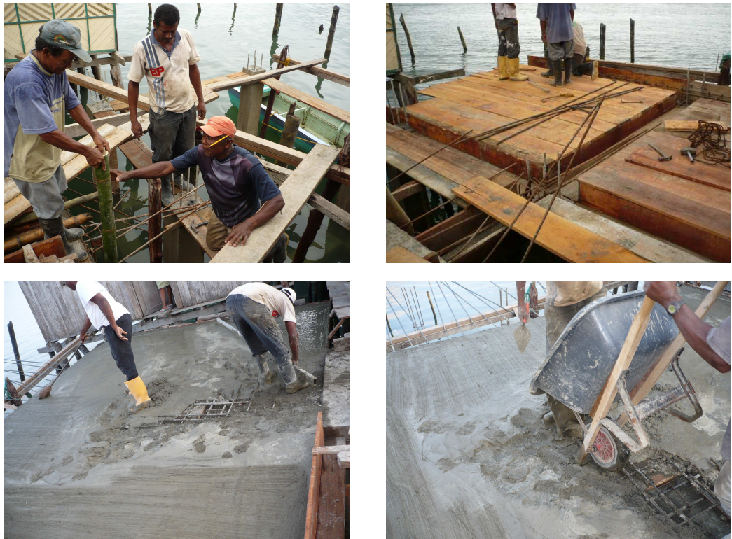
Figura 116. Construcción de la losa del mirador
