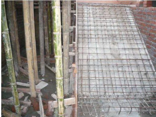
Figura 41. Armadura de la escalera
