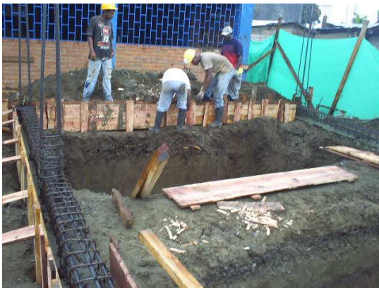
Figura 65. Construcción de la formaleta de vigas de cimentación
