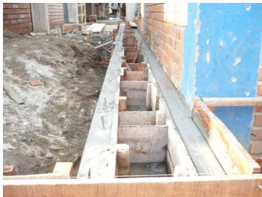
Figura 87. Fundición de cañuelas
