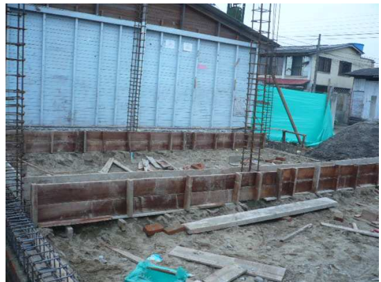
Figura 65. Construcción de la formaleta de vigas de cimentación
