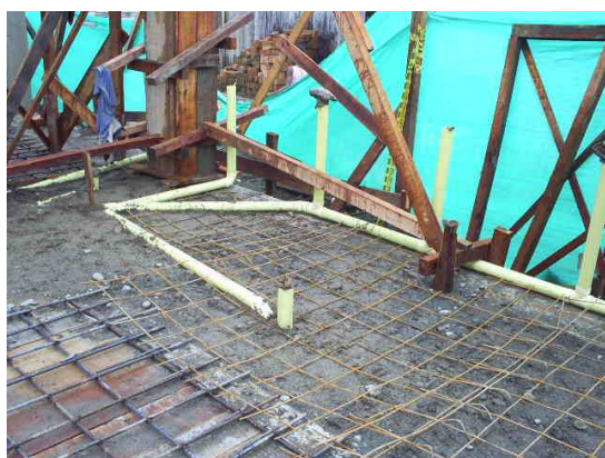
Figura 73. Tapas del pozo séptico y filtro anaeróbico, instalación sanitaria
