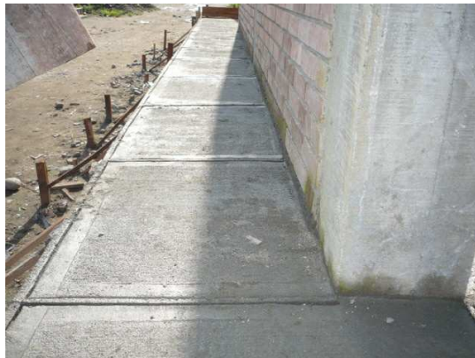
Figura 89. Fundición del andén
