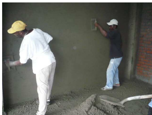
Figura 45. Repello de muros interiores
