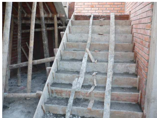
Figura 42. Fundición de la escalera
