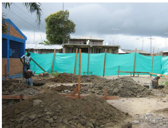
Figura 59. Localización y replanteo
