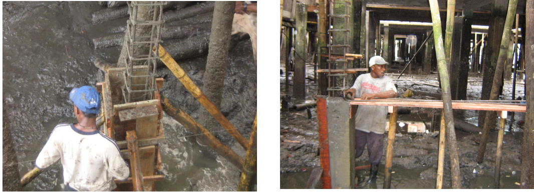
Figura 102. Fundición de pedestales
