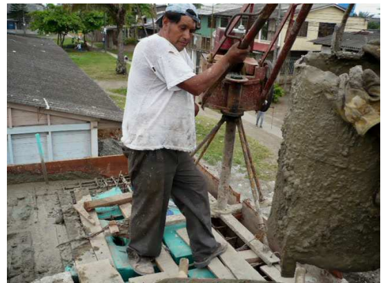
Figura 26. Fundición o llenado de vigas, viguetas y plaquetas superior
