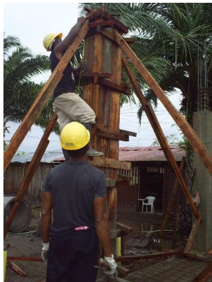
Figura 75. Formaleta de columnas
