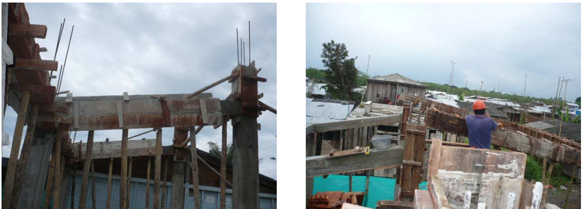
Figura 81. Fundición de la viga de cubierta
