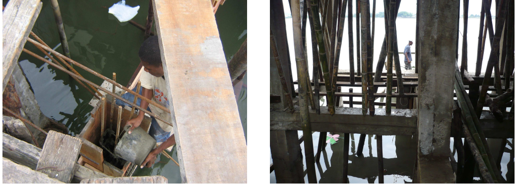
Figura 115. Formaleta y fundición de columnas
