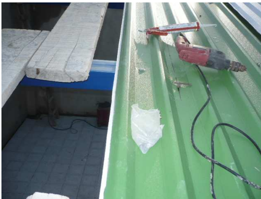
Figura 96. Instalación de cubierta termo acústica
