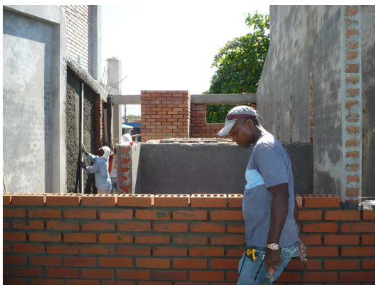
Figura 85. Repello de muros interiores
