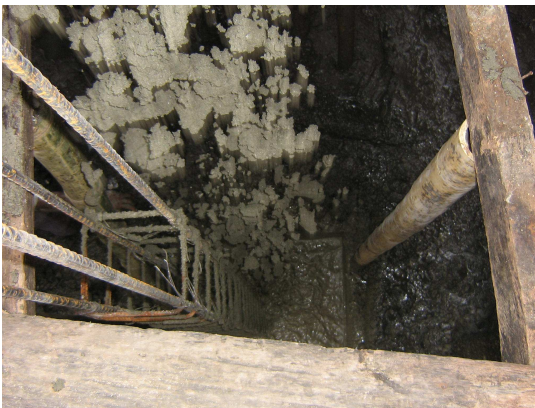
Figura 101. Fundición de las zapatas
