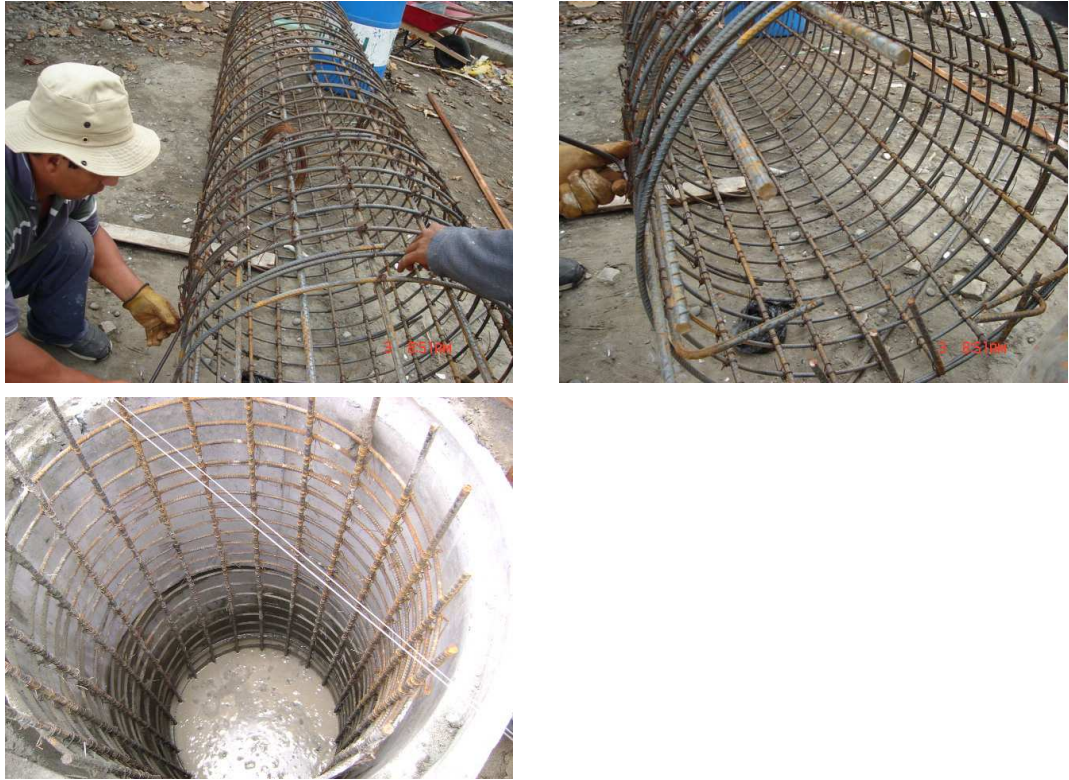
Figura 6. Armado de estructura para caisson y fundición de estros
