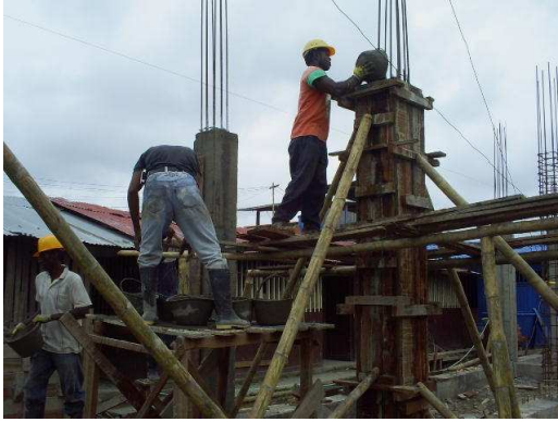
Figura 15. Fundición de columnas
