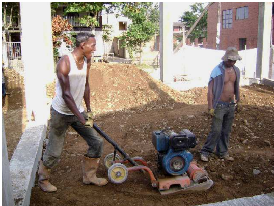
Figura 19. Relleno y compactación
