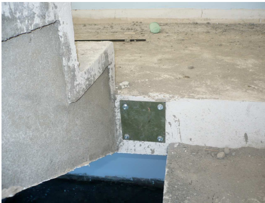
Figura 53. Instalación de pasamanos
