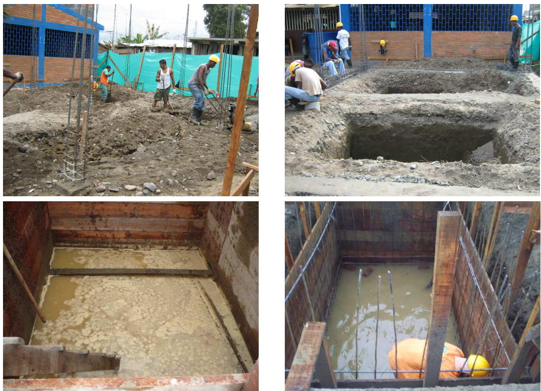
Figura 70. Pozo séptico
