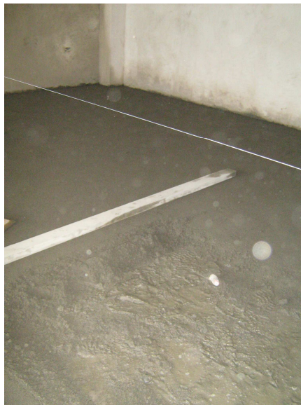
Figura 90. Repello o alistado de piso
