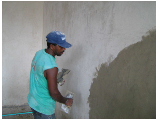
Figura 88. Estuco para mampostería común
