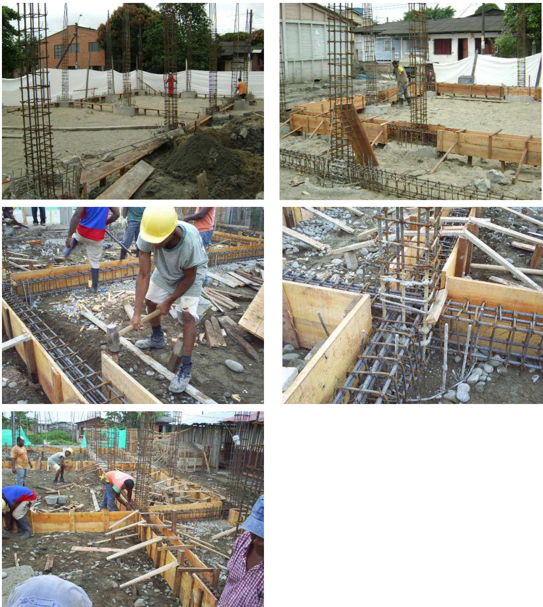
Figura 12. Construcción de la formaleta de vigas de cimentación
