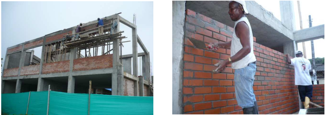
Figura 44. Pega de mampostería
