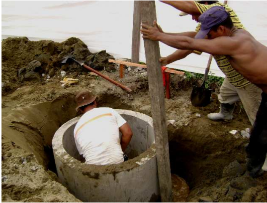
Figura 5. Excavación e instalación de tubería caisson
