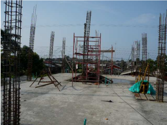
Figura 27. Desencofrado de la losa aligerante
