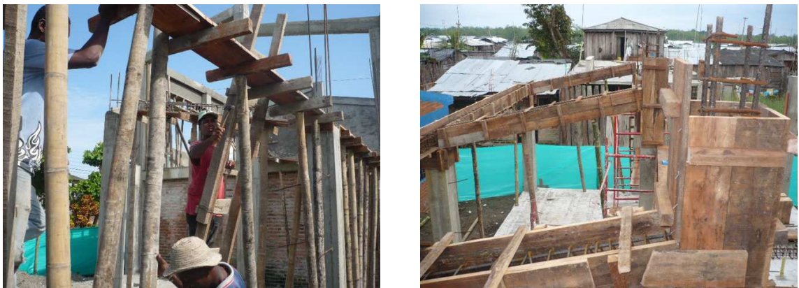
Figura 79. Encofrado de las vigas de cubierta
