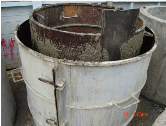
Figura 4. Elaboración del cuerpo del caisson.
