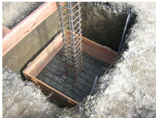
Figura 61. Armado de refuerzo
