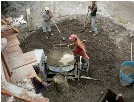
Figura 26. Fundición o llenado de vigas, viguetas y plaquetas superior
