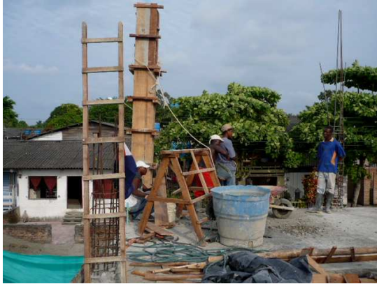
Figura 31. Formaleta de columnas
