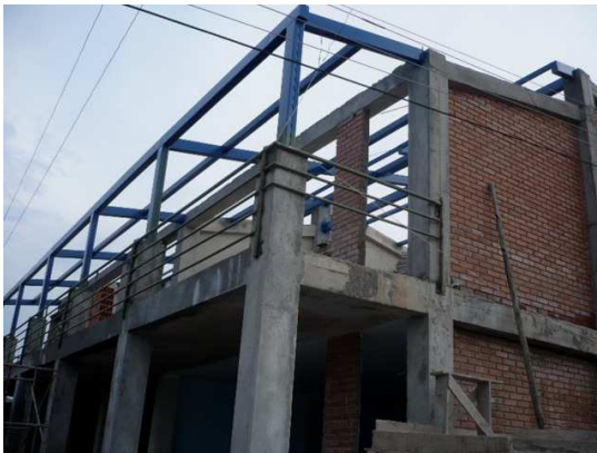
Figura 52. Instalación de la estructura metálica
