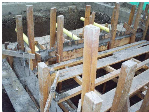
Figura 72. Caja de inspección
