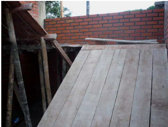
Figura 40. Encofrado de la escalera
