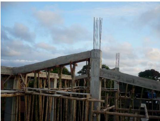
Figura 38. Desencofrado de vigas de cubierta
