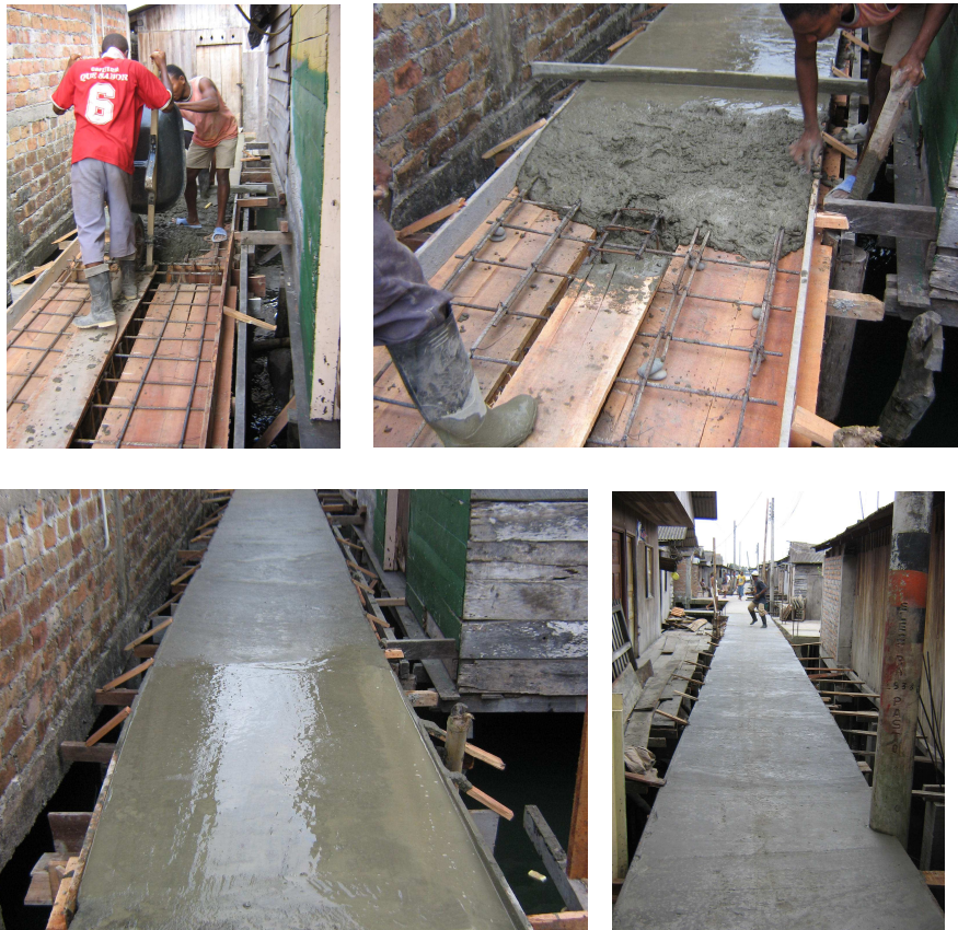
Figura 111. Fundición de la losa
