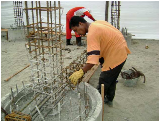
Figura 11. Armado y amarrado de refuerzo de vigas de cimentación
