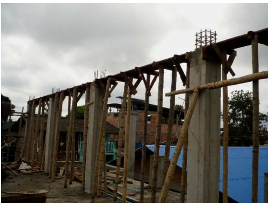
Figura 35. Encofrado de vigas de cubierta
