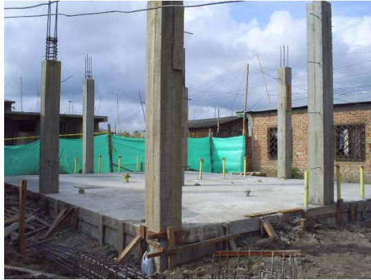
Figura 76. Fundición de columnas y losa
