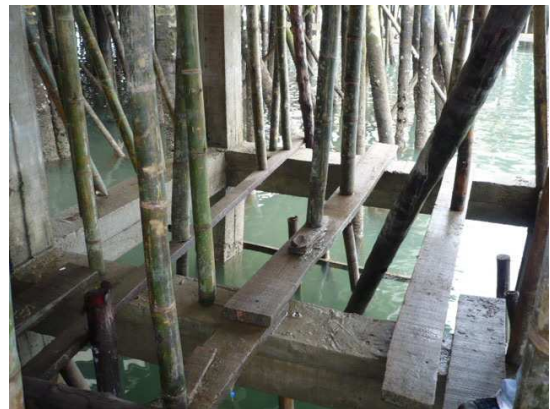
Figura 114. Vigas de cimentación de la losa del mirador
