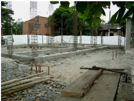
Figura 16. Desencofrado de columnas y vigas
