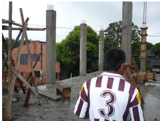
Figura 33. Desencofrado de columnas
