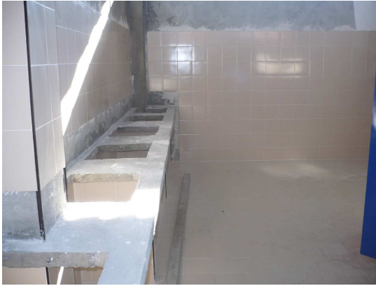
Figura 91. Pega de cerámica y emboquillado
