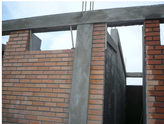
Figura 86. Repello de columnas y vigas
