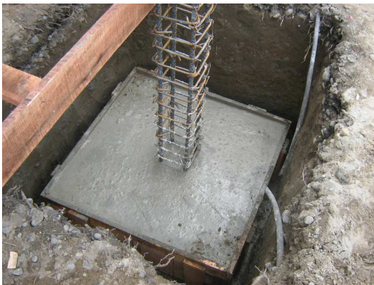
Figura 62. Fundición de las zapatas
