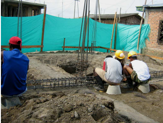
Figura 64. Armado de refuerzo para vigas de cimentación
