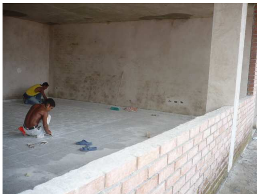
Figura 51. Pega de baldosa y emboquillado
