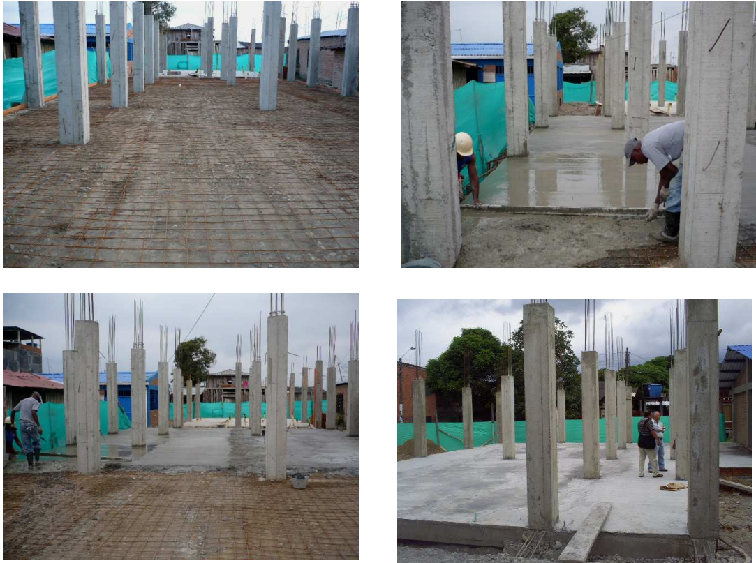
Figura 20. Instalación de malla electrosoldada
