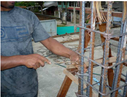
Figura 30. Armado de refuerzo
