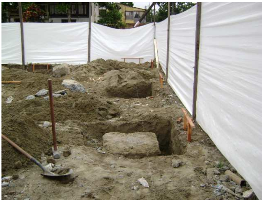
Figura 2. Localización y replanteo
