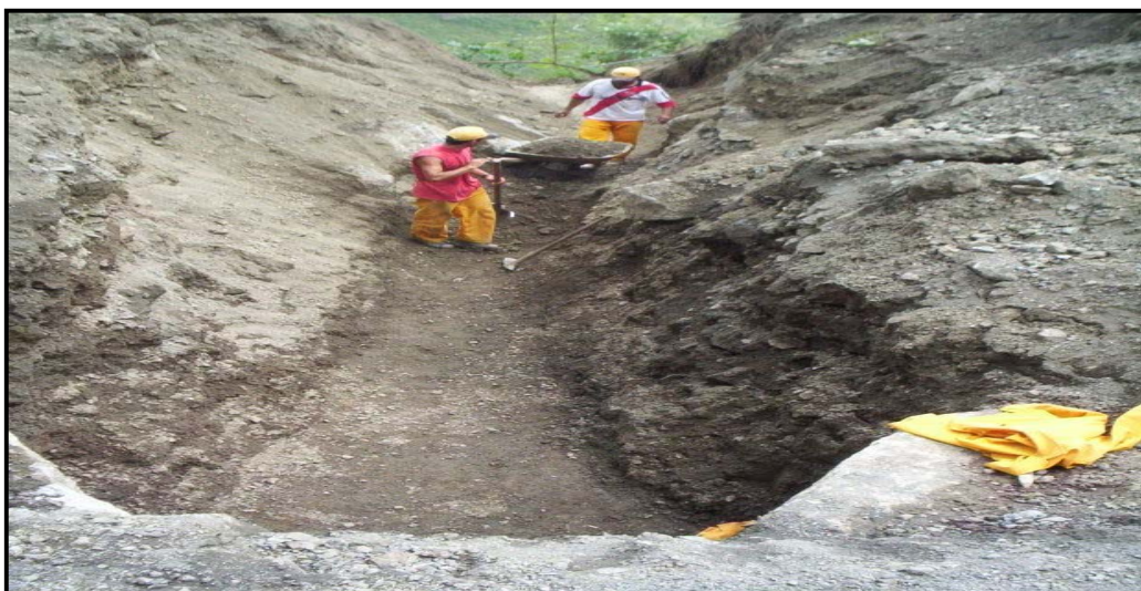
Figura 41. Recuperación de alcantarillas y descoles
