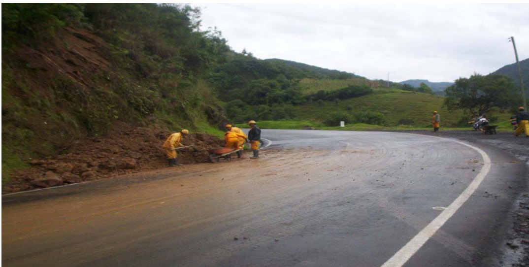
Figura 39. Limpieza de Calzada PR19+200
