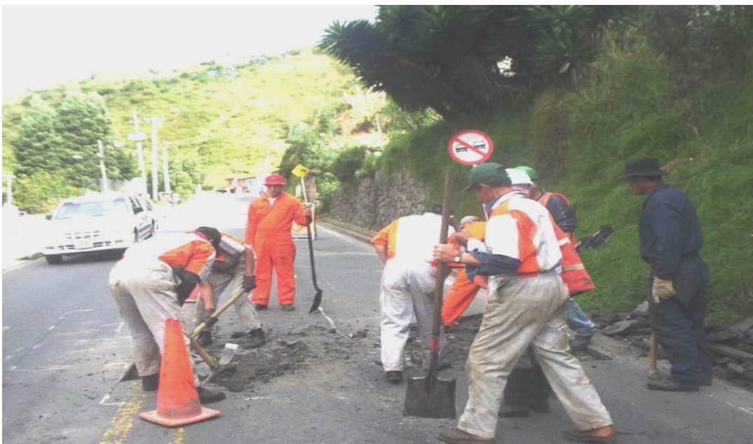
Figura 47. Corte para parcheo
