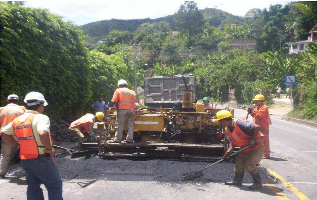
Figura 49. Riego de la mezcla con la finisher
