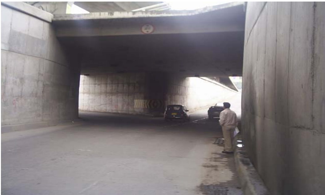
Figura 25. Detalle acceso deprimido – señalización
