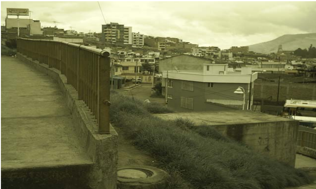
Figura 29. Detalle andén - muro de contención – baranda
