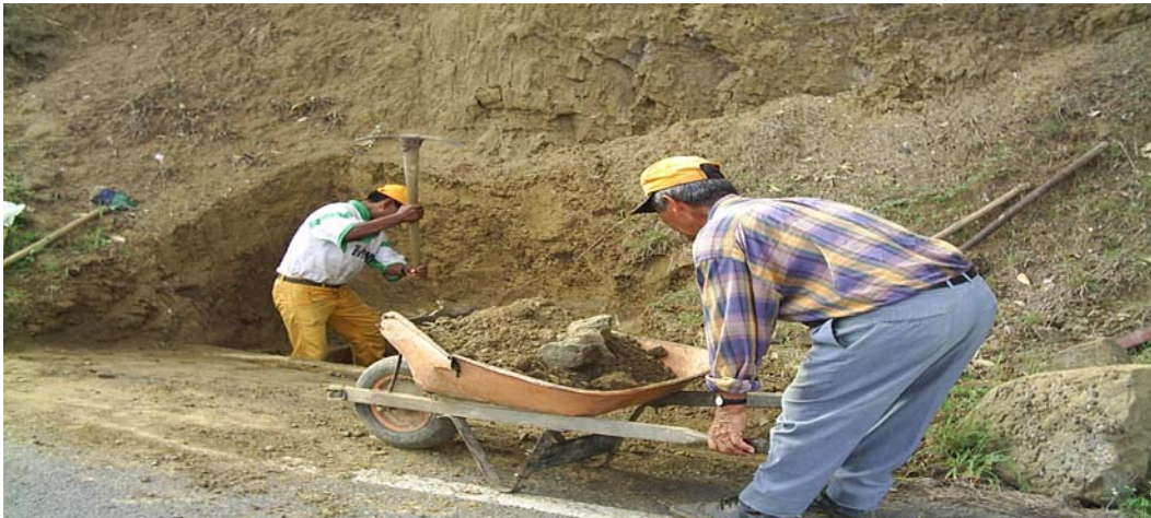
Figura 40. Rehabilitación obras de drenaje Destaponamiento de alcantarilla
