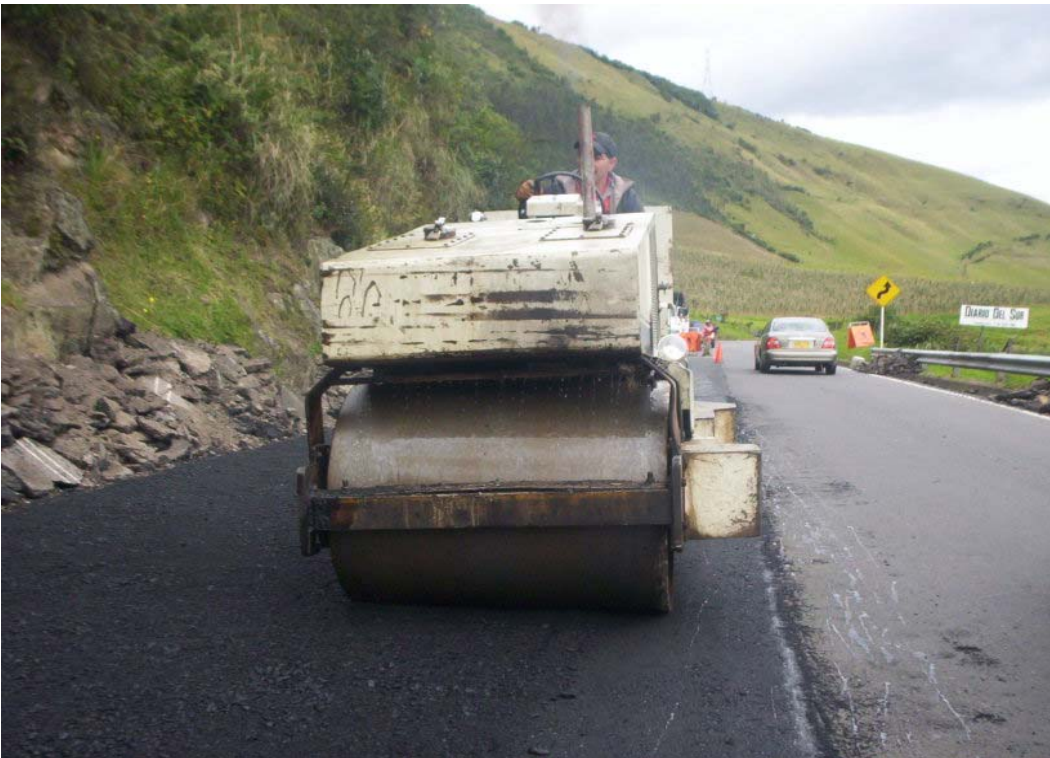
Figura 51. Compactación de la mezcla PR 8+0500
