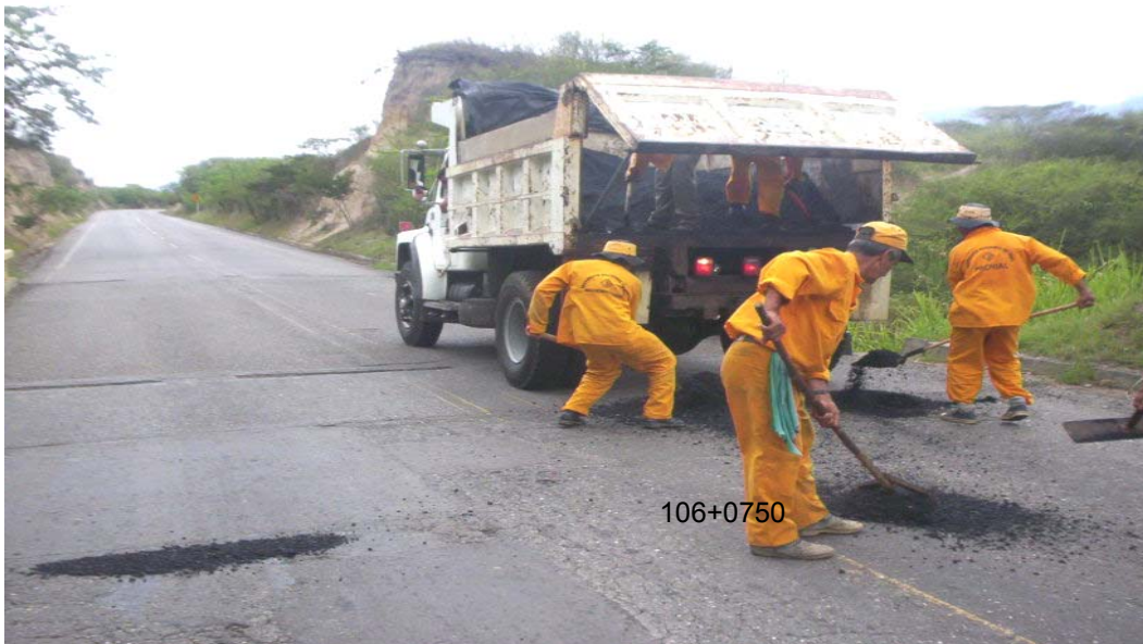
Figura 44. Trabajos de Bacheo en el PR 114+0700
