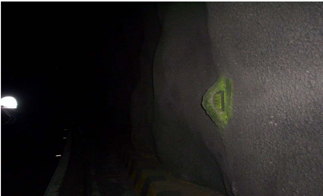
Figura 18. Captafaro en mal estado en hastial del túnel
