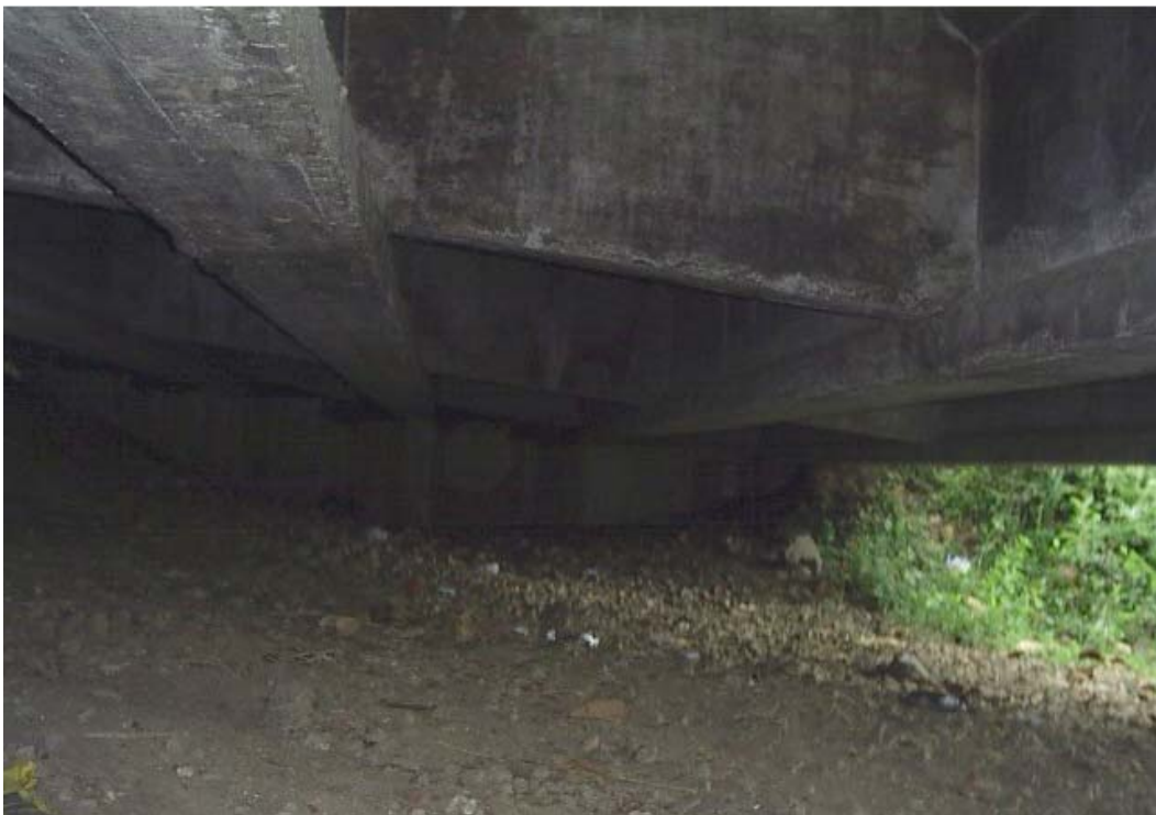
Figura 13. Puente la Barriga Estribo No 1 - Placa - Vigas – Riostras
