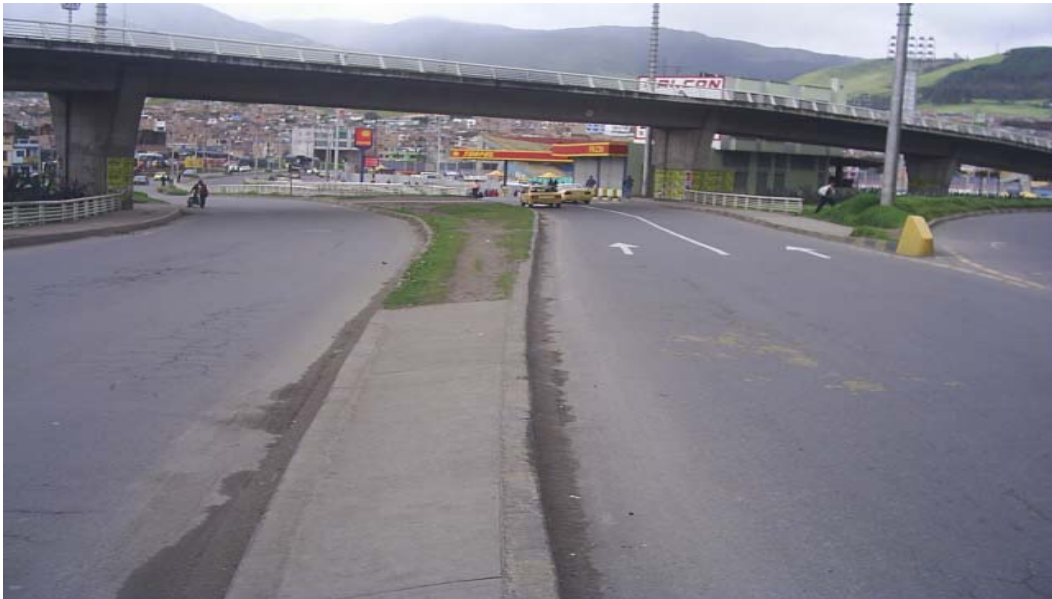
Figura 24. Vista general deprimido estadio
