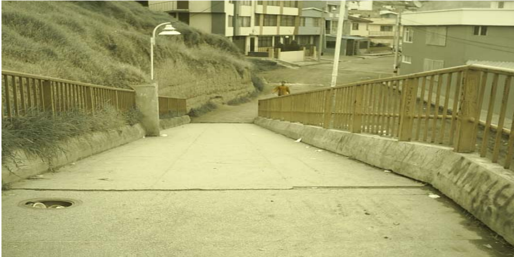
Figura 28. Acceso lateral derecho – barandas
