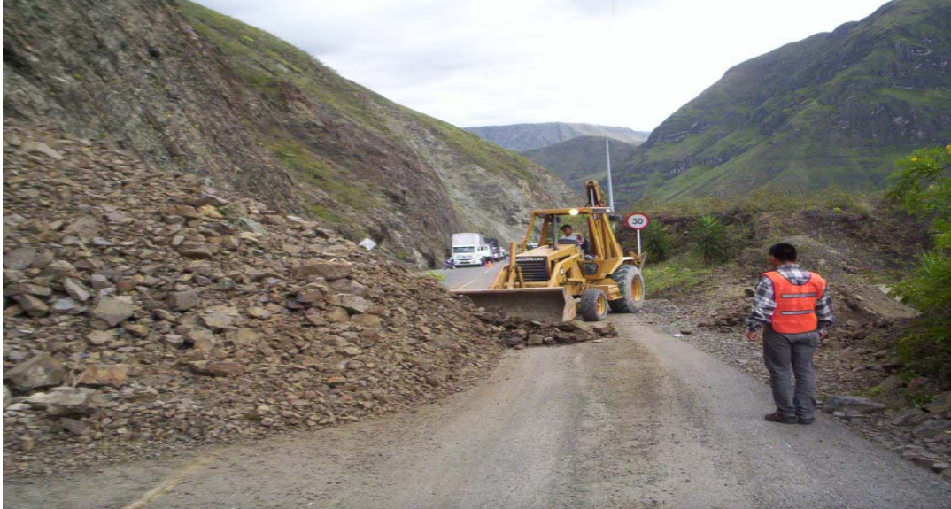
Figura 37. Despeje de derrumbe PR53+0150
