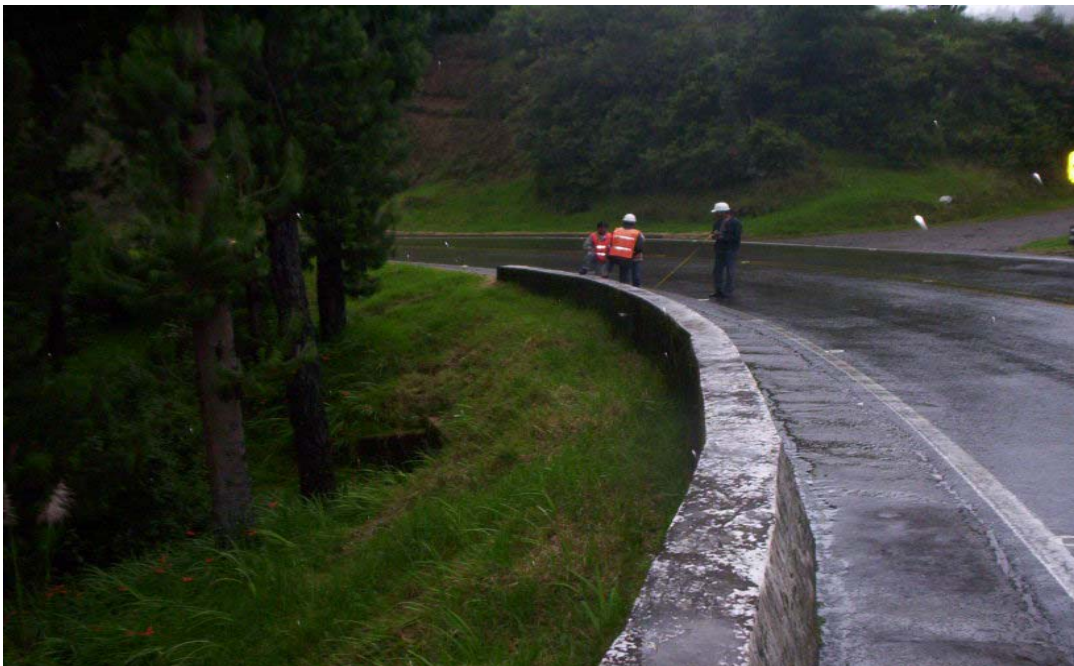
Figura 21. Inspección del ponton localizado en el PR 015+0330
