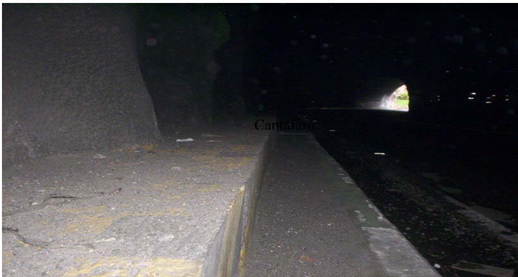
Figura 19. Hastial con concreto lanzado - bordillo – andén
