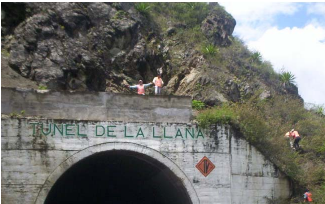
Figura 14. Túnel la Llana (salida)
