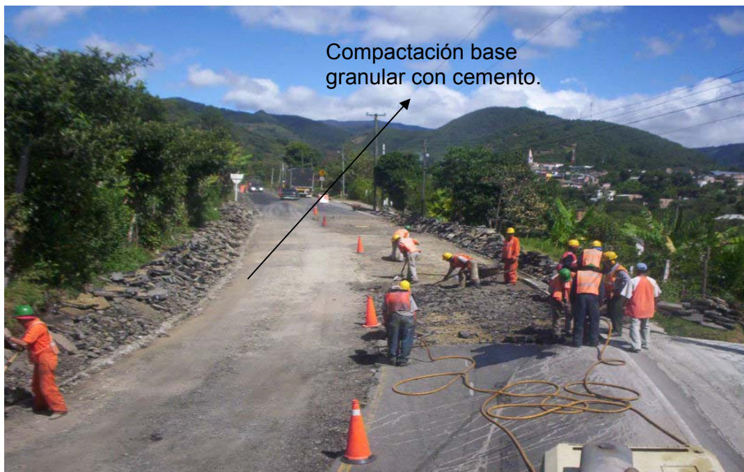
Figura 36. Compactación base granular con cemento
