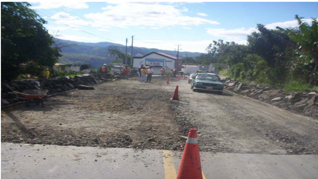
Figura 35. Mezclado de la base granular con cemento
