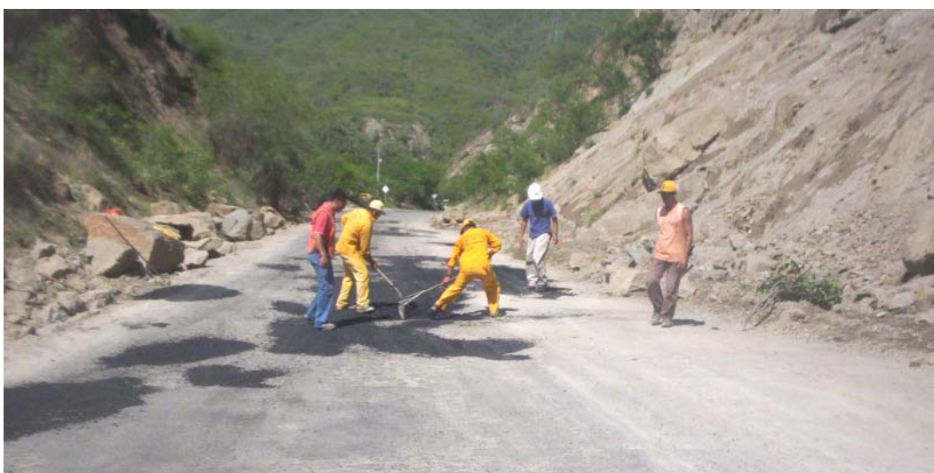
Figura 44. Trabajos de Bacheo en el PR 114+0700
