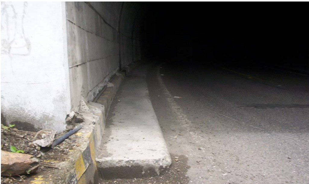
Figura 16. Túnel la Llana Hastial - bordillos - andenes - señalización horizontal
