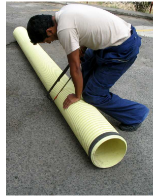
Foto 33. Corte de tubo durafort.
