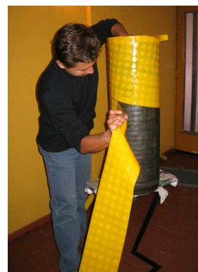
Foto 64. Tapizado de piso vinílico.
