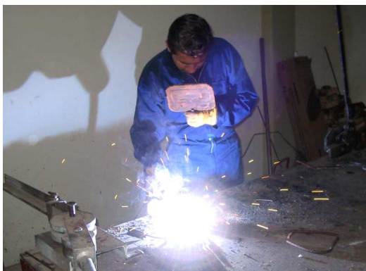
Foto 35. Soldadura de arco.
