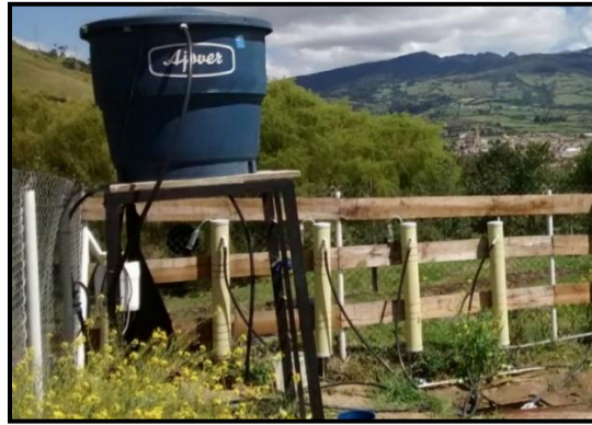
Figura 3. Montaje del sistema de filtros 2017.
