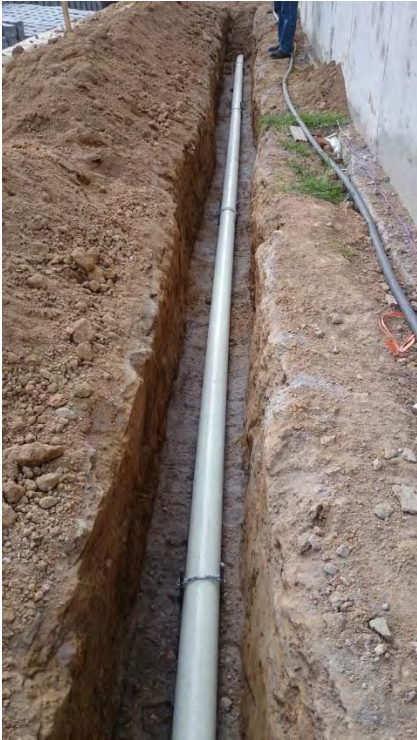
Figura 59. Colocación tubería de agua potable
