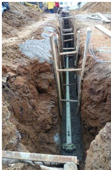
Figura 57. Excavación y entibado para tubería sanitaria
