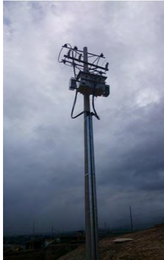
Figura 50. Ubicación e instalación de postes y transformadores
