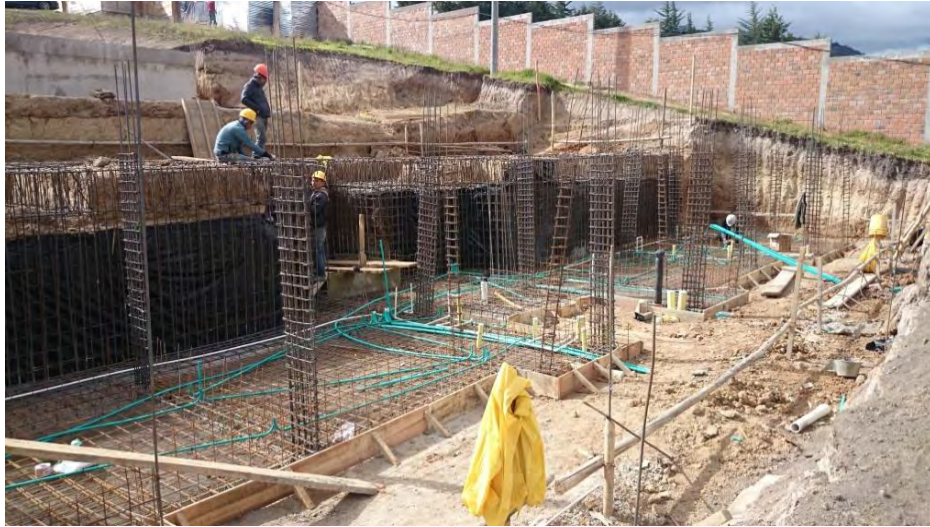
Figura 19. Instalaciones hidrosanitarias, eléctricas gas y relleno con material de sitio para cimentación
