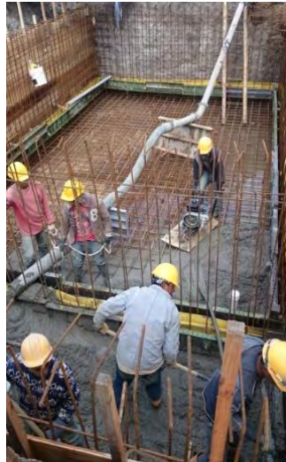
Figura 55. Fundición primera fase del tanque de almacenamiento
