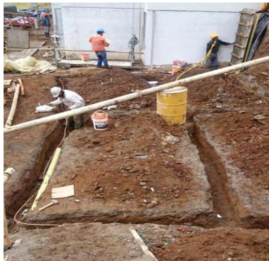
Figura 49. Instalación malla para polo a tierra
