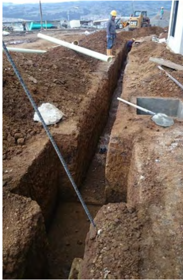
Figura 46. Excavación manual para alcantarillado
