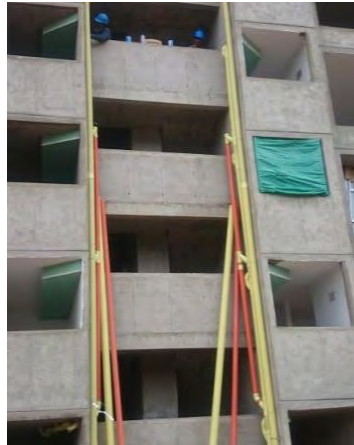
Figura 37. Armado bajantes sanitarios, aguas lluvias y ventilación
