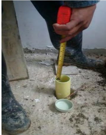
Figura 35. Prueba de estanqueidad a tubería sanitaria
