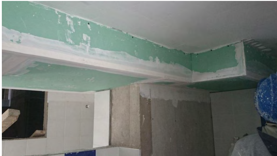
Figura 38. Descolgado en RH para tubería sanitaria y tapa buitrón en superboard
