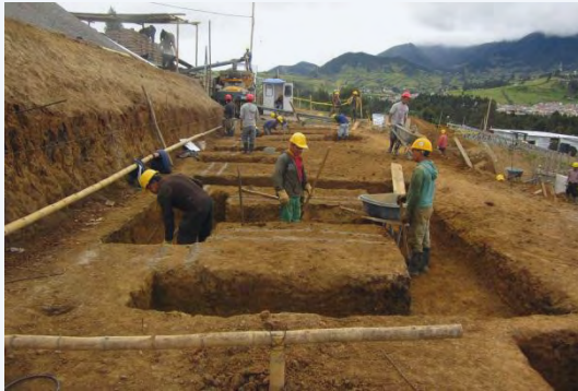
Excavación para cimentación
