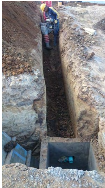
Figura 48. Relleno y compactación de excavación para tubería sanitaria
