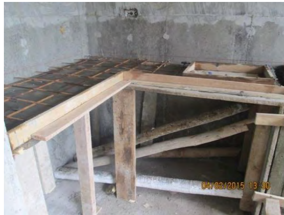
Figura 31. Construcción de mesones en concreto.
