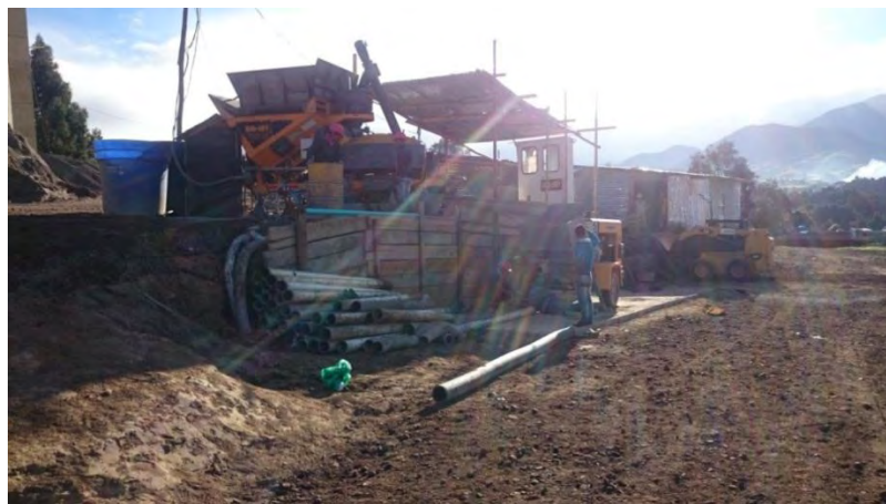
Figura 13. Planta DOMAT y bomba de concreto
