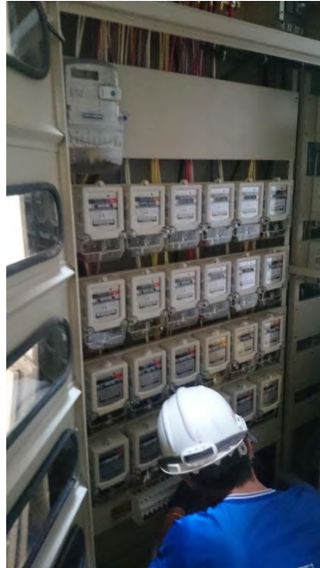
Figura 44. Instalación gabinete con medidores
