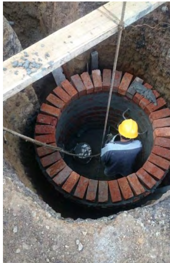
Figura 58. Construcción de cámaras
