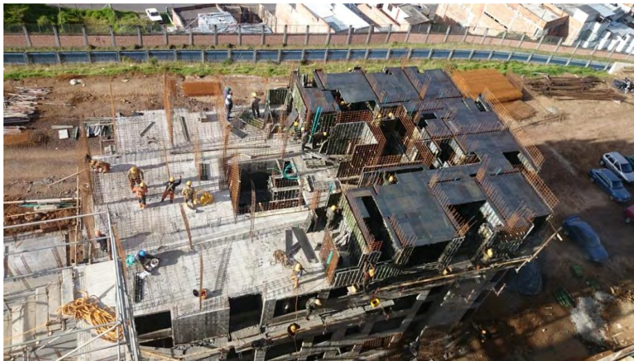
Figura 24. Conformación de formaleta lista para colocar instalaciones y refuerzo de acero
