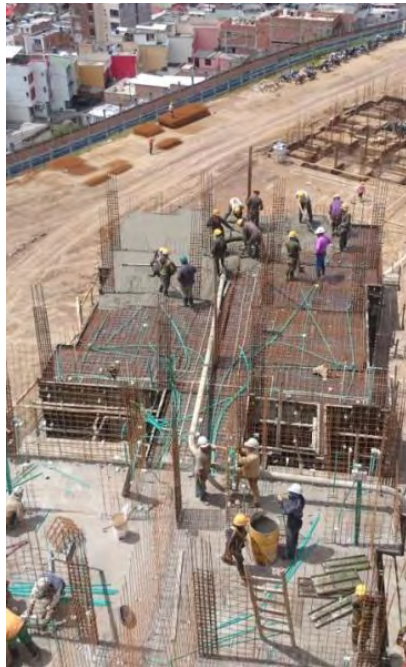
Figura 27. Fundición muros y losas apartamentos 703 y 704
