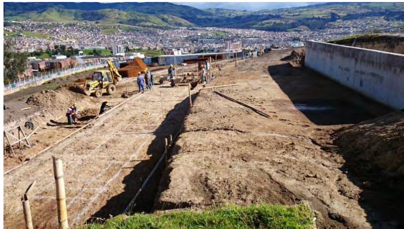
Figura 16. Replanteo y señalización de zapatas corridas
