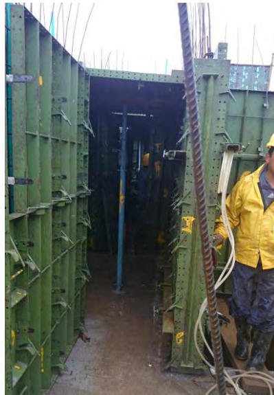
Figura 22. Armado de formaleta muros y losa apoyada sobre alineadores y gatos.
