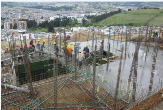
Fundición de muros y placa
