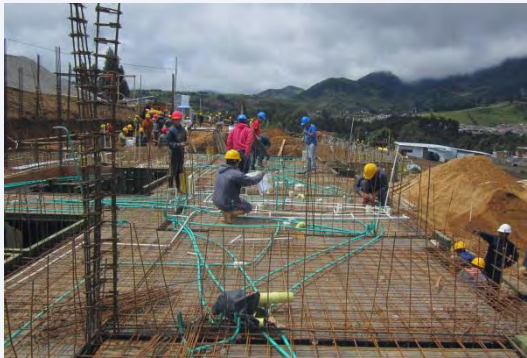
Colocación de Mallas, elementos de borde Instalaciones eléctricas, gases e hidrosanitarias
