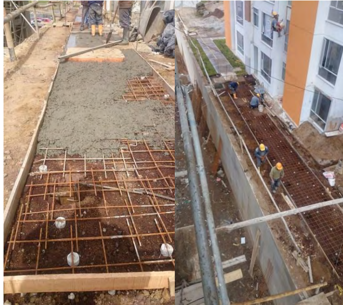
Figura 52. Anden perimetral en fundición y terminado
