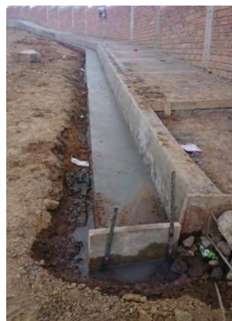
Figura 11. Sardinel y cuneta para andén exterior
