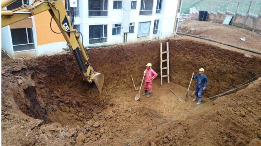
Figura 53. Excavación tanque de almacenamiento torre A y B
