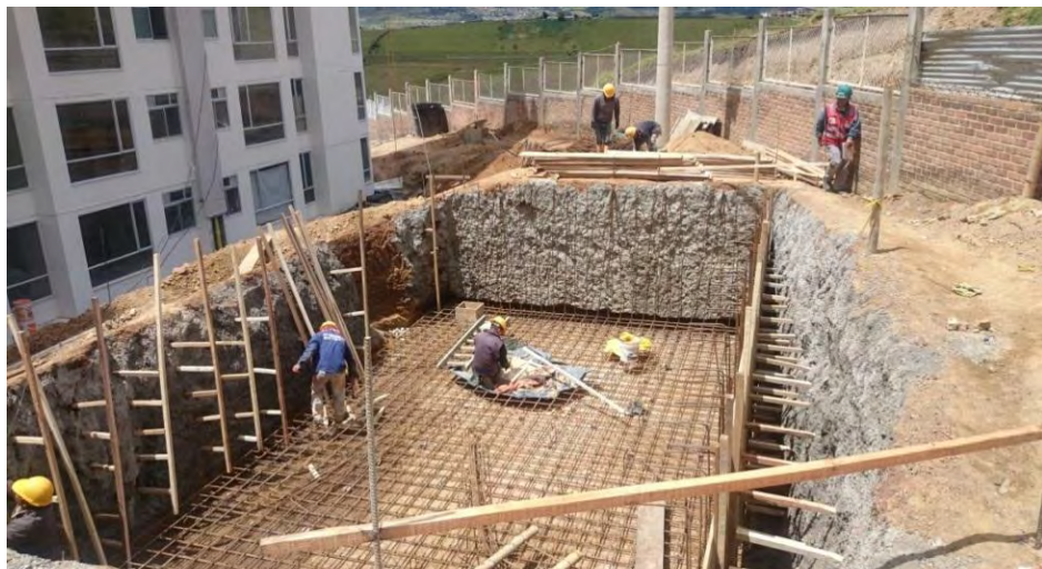
Figura 54. Armado de refuerzo de losa y muros
