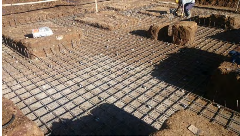
Figura 18. Armadura de parrilla y refuerzo cimentación
