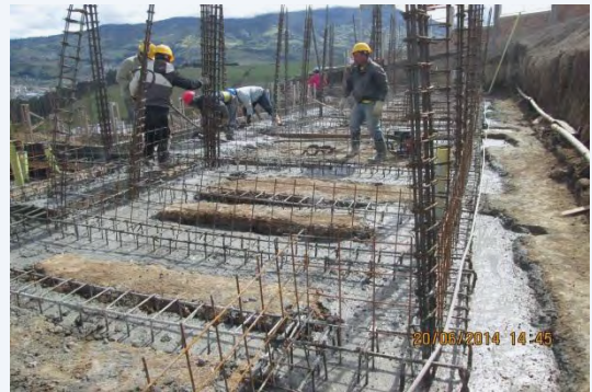
Fundición de cimentación
