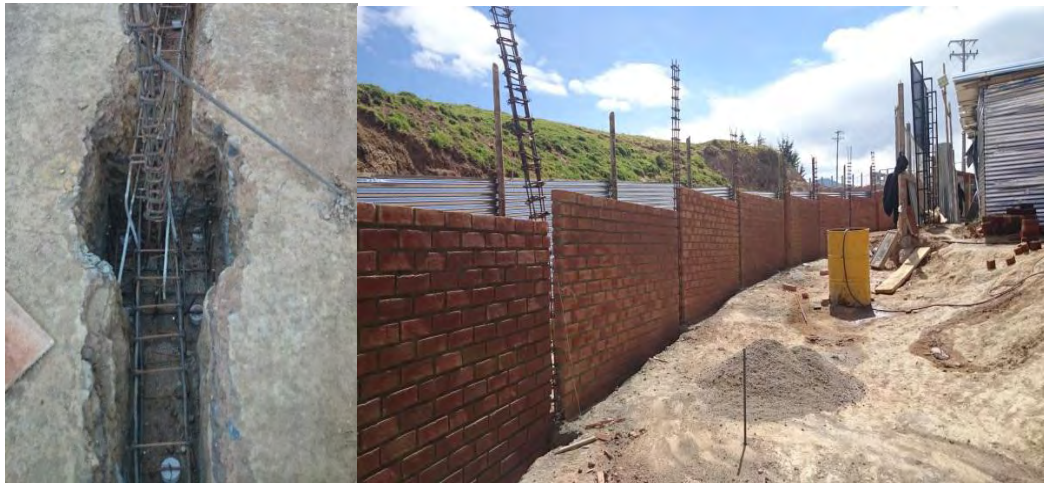
Figura 9. Refuerzo de vigas de cimentación y columnas. Muro de cerramiento con malla eslabonada
