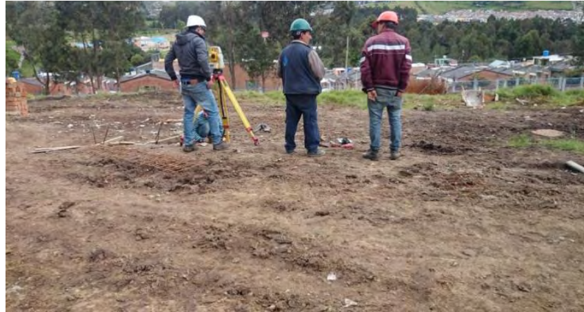
Figura 15. Localización por equipo topográfico torre I
