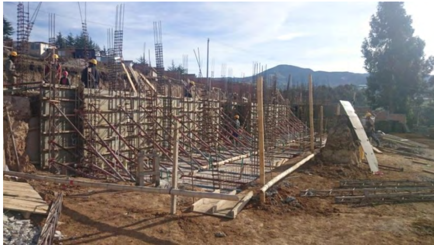
Figura 21. Formaleteado y apuntalamiento de muro de contención
