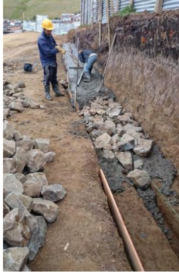
Figura 10. Fundición zarpa muro en concreto ciclopeo donde ira la parte final del muro de cerramiento perimetral
