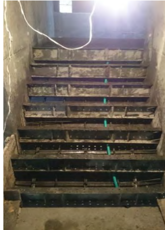
Figura 30. Escalera lista para fundir
