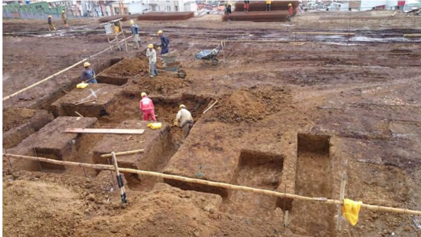
Figura 17. Excavación a mano zapatas corridas
