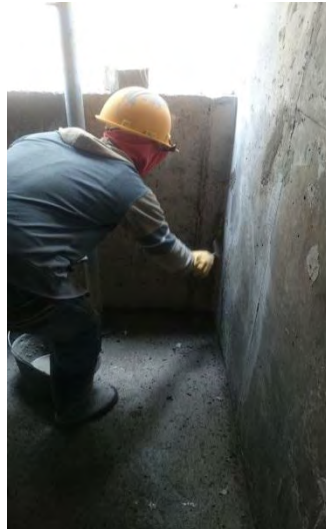
Figura 32. Resane interno de apartamentos
