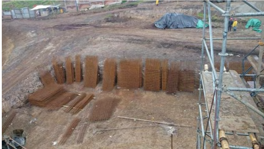
Figura 23 Malla figurada para torre 1
