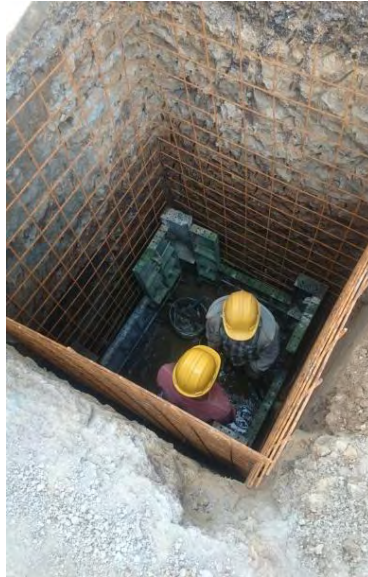
Figura 47. Armado formaleta y fundición de cajillas
