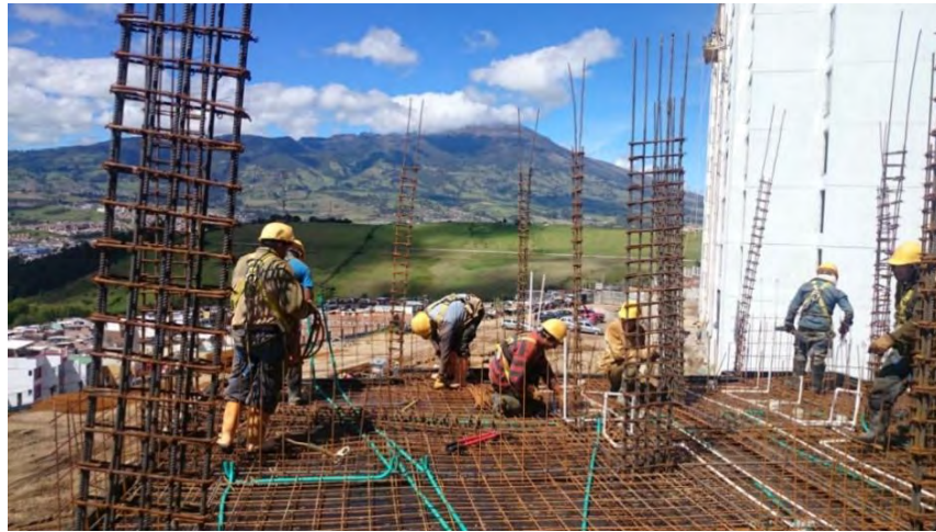
Figura 25. Armado de refuerzo y tubería instalaciones hidráulicas eléctricas y de gas
