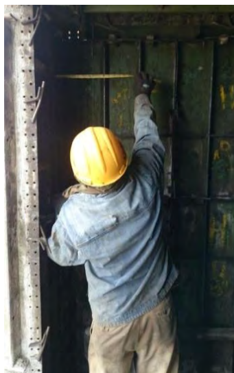
Figura 26. Chequeo de plomos de muros
