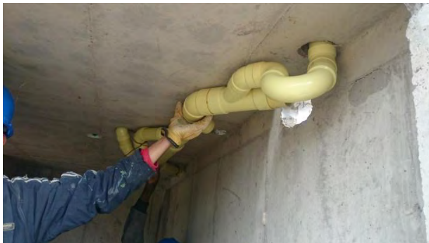
Figura 34. Armado tubería sanitaria en cocina
