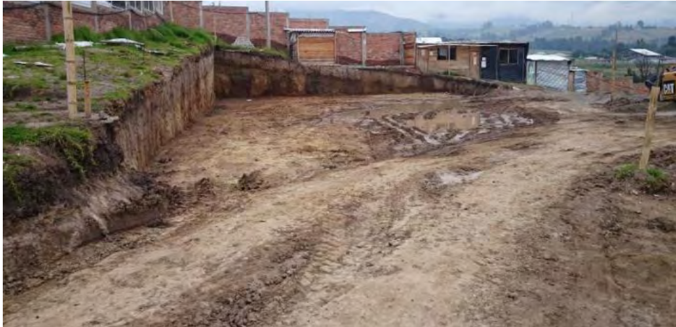
Figura 56. Excavación para cancha múltiple
