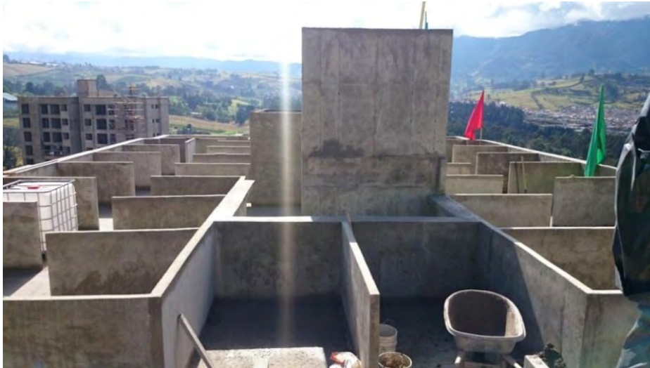
Figura 29. Muros divisorios de terrazas y cuarto de máquinas
