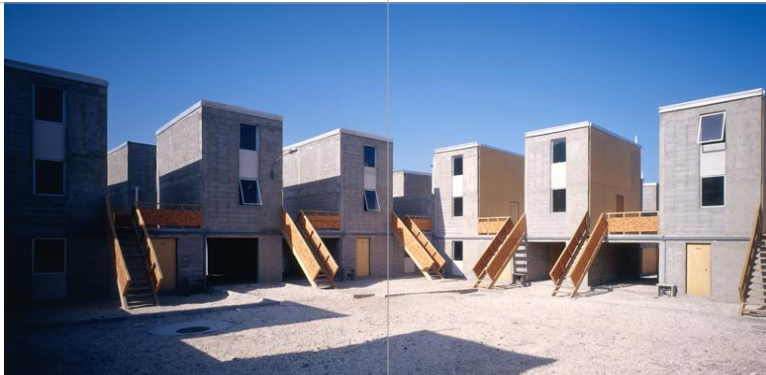
VISTA GENERAL DEL CONJUNTO
