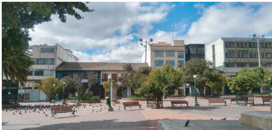
Figura 13. Perfil urbano degradado de la carrera 24 contigua a la plaza de Nariño.
