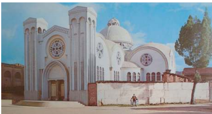
Figura 15. Iglesia de Fátima antes de la degradación del ambiente construido. Fuente: Desconocido.
