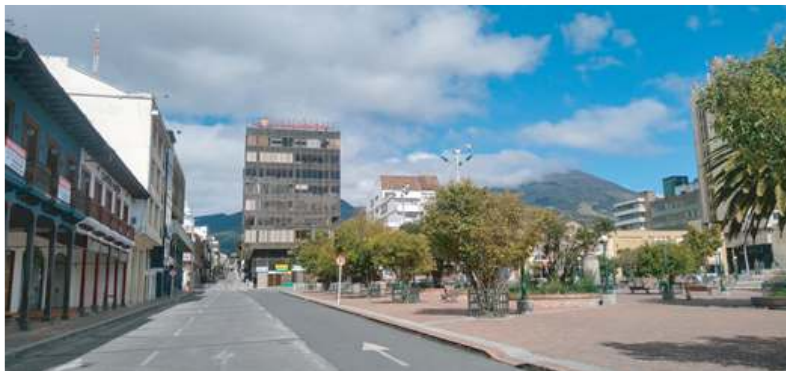
Figura 26. Edificio de fachada acristalada en el Centro Histórico de la ciudad de San Juan de Pasto.
