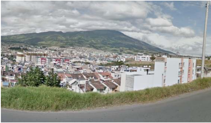
Figura 10. Degradación del ambiente construido a causa de la vivienda en altura en la ciudad de San Juan de Pasto.
