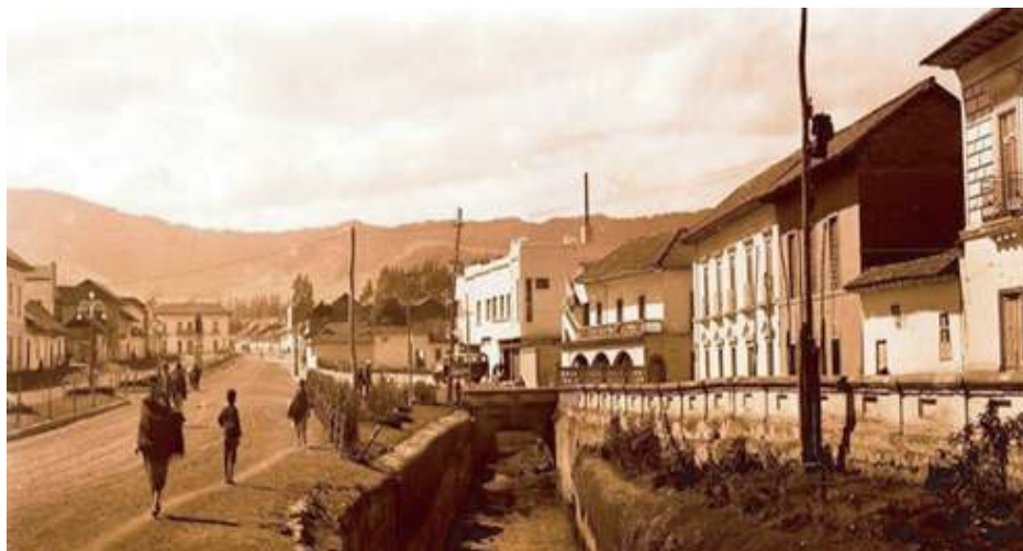
Figura 19. Sector actualmente reconocido como la avenida Santander cuando aún era habitable.
