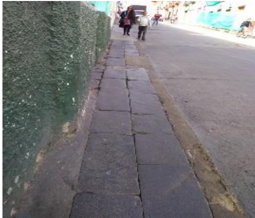
Imagen 18 Andenes barrio Santiago. Fuente propia.
