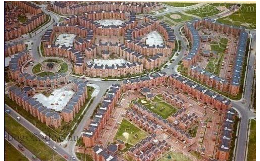
SAMPER /CIUDADELA COLSUBSIDIO
