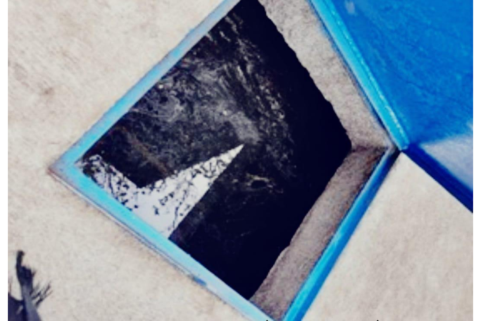
Imagen 5. Evidencia de contaminación en el recurso hídrico.
