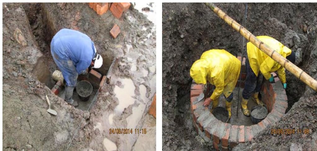
Figura 29. Elaboración de cajillas y pozos de inspección.
