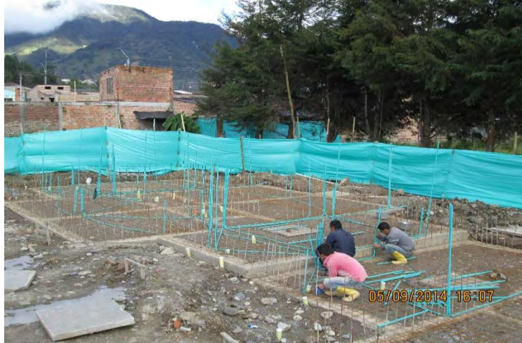
Figura 15. Instalación de malla, instalaciones eléctricas, hidráulicas.
