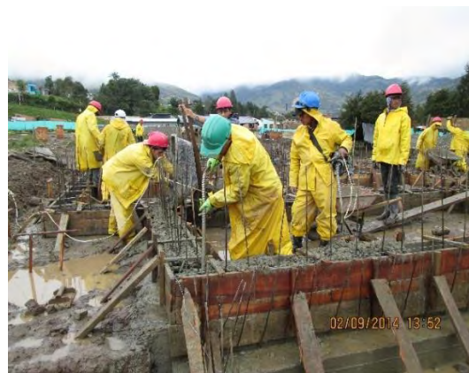
Figura 14. Fundición de vigas.
