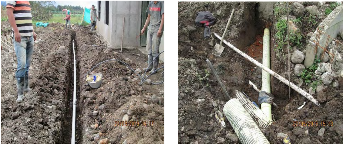
Figura 30. Instalación de tubería acueducto.
