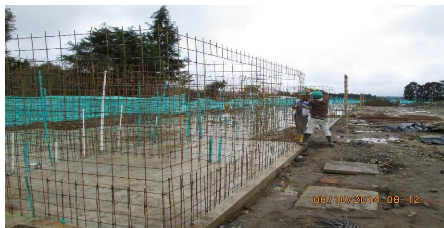
Figura 17. Instalación de malla para muros.
