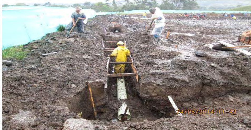
Figura 12. Instalación tubería sanitaria.
