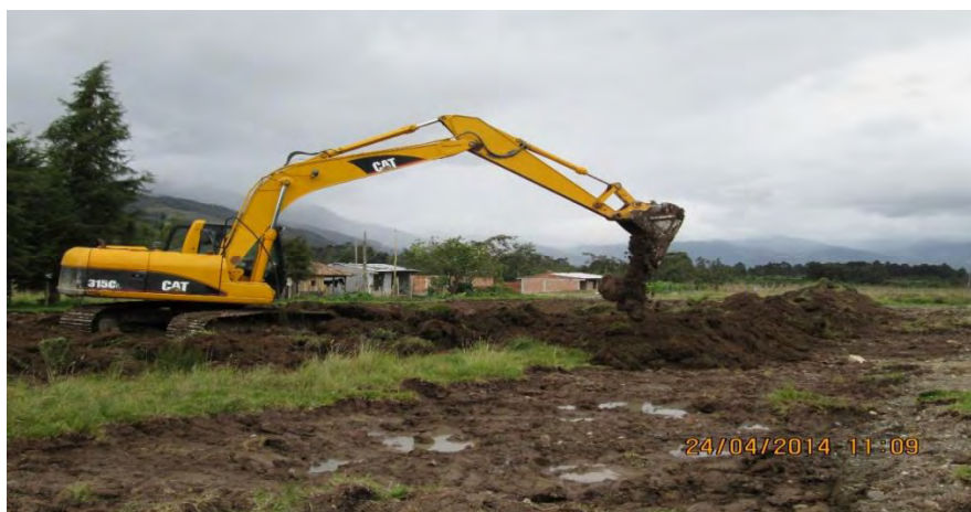
Figura 8. Descapote, excavación y desalojo de material.
