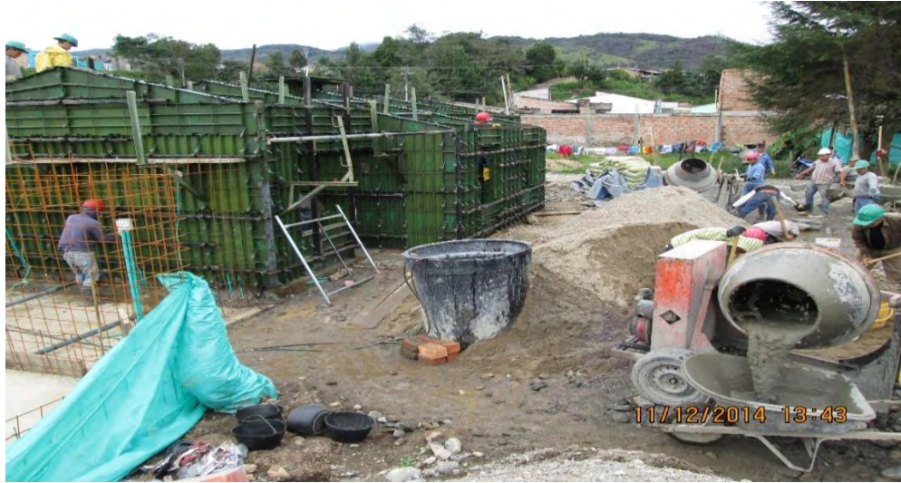
Figura 19. Fundición de una vivienda.
