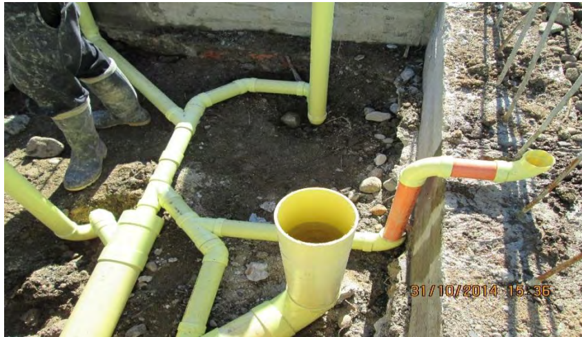
Figura 27. Prueba de estanqueidad.
