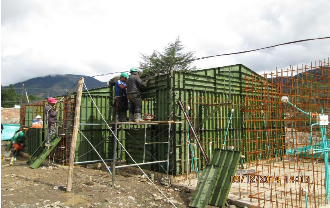
Figura 32. Utilización de elementos de protección.
