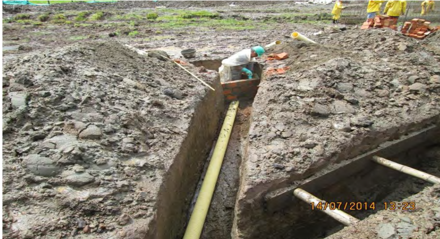
Figura 28. Elaboración de cajillas sanitarias y conexión a red sanitaria.
