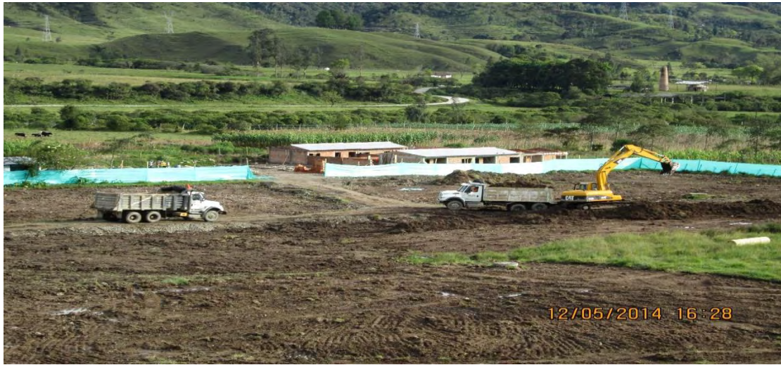
Figura 2. Estado inicial de la obra
