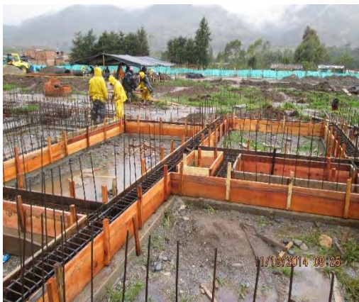
Figura 14. Fundición de vigas.
