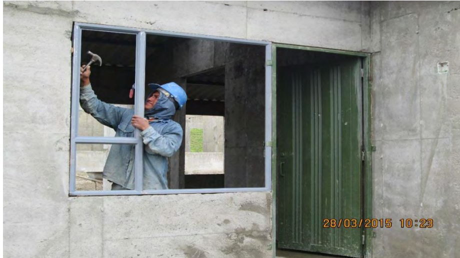
Figura 22. Instalación de ventana.
