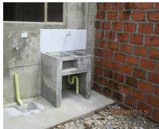
Figura 24. Instalación de lavadero.
