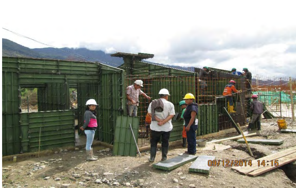
Figura 18. Formaleta metálica para construcción de viviendas.
