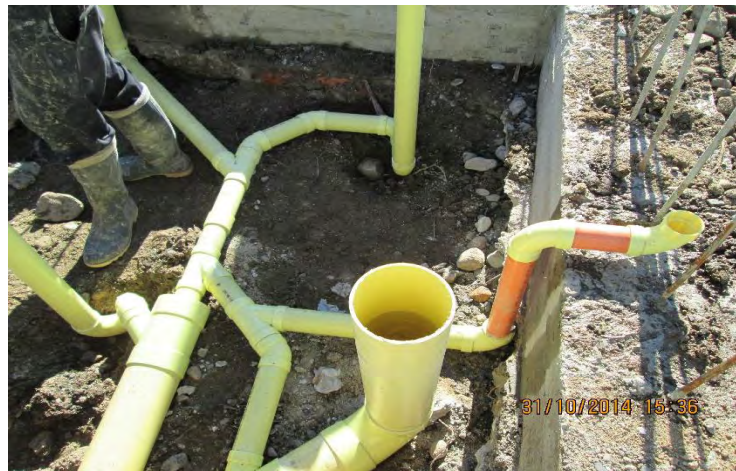
Figura 5. Prueba de estanqueidad.
