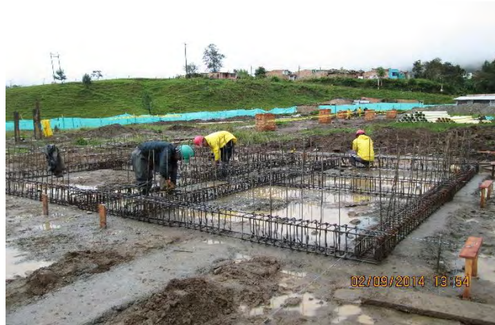
Figura 11. Amarre de vigas de cimentación.
