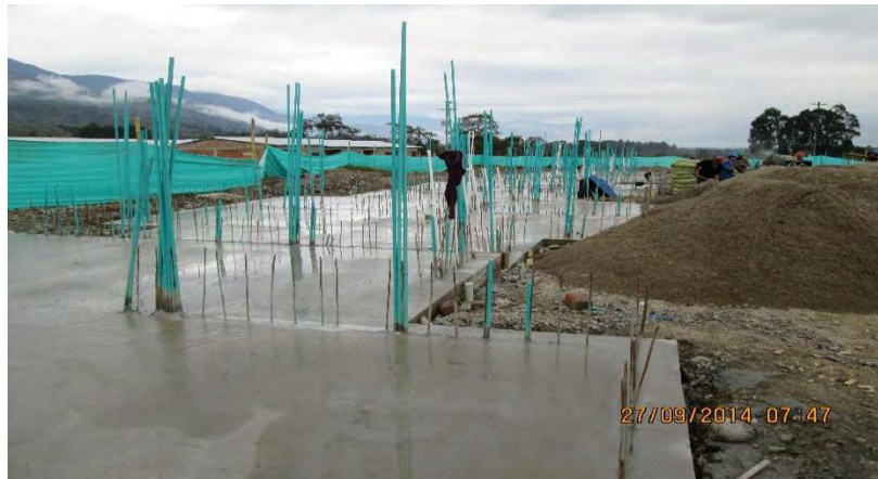
Figura 16. Terminado de la losa cimentación.
