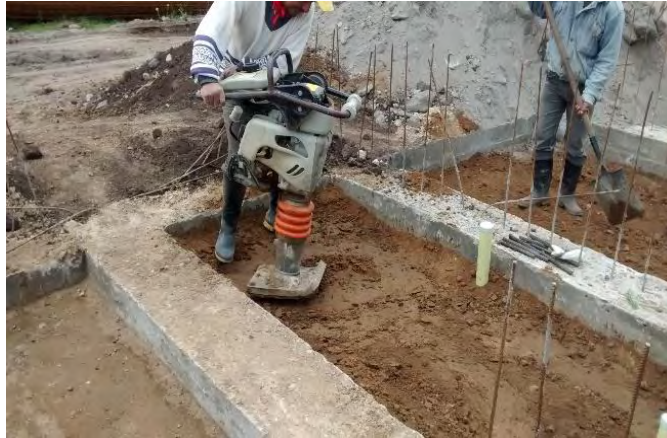
Figura 13. Compactación con recebo y material de sitio.
