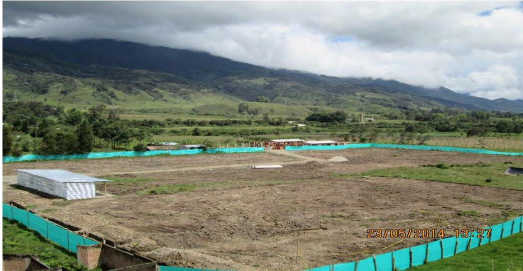
Figura 9. Lote para construcción del proyecto.
