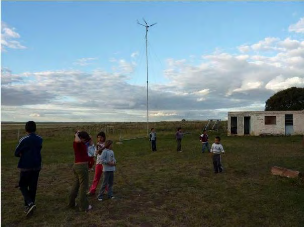
Figura 72. Aerogenerador Escuela No. 81 – Uruguay.
