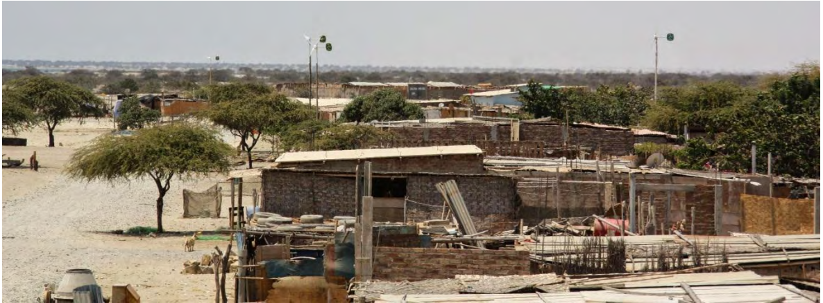
Figura 73. Sistema de Aerogeneradores Instalados Piura - Perú.
