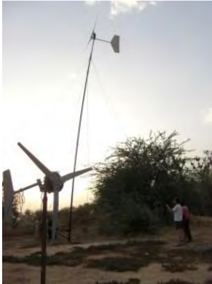
Figura 75. Aerogeneradores artesanales instalados en Mopti, Mali.
