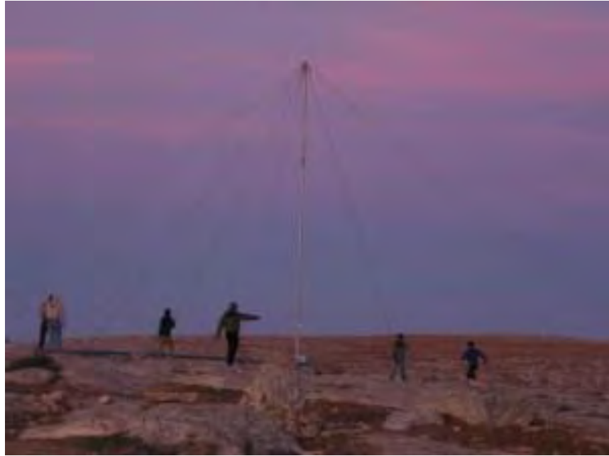
Figura 74. Instalación aerogenerador en Shaeb al Buttum, Palestina.
