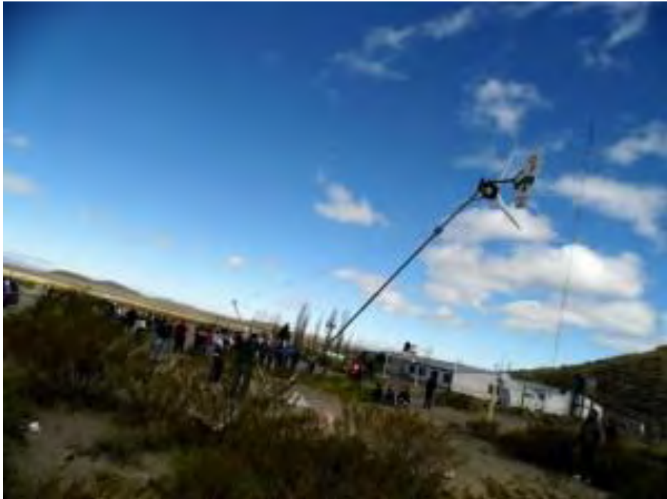
Figura 76. Levantamiento de la Torre en Carapacho, Argentina.
