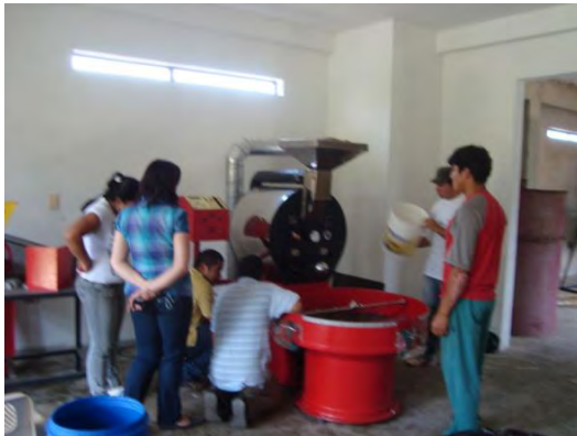
Imagen 4. Instalación de maquina tostadora
