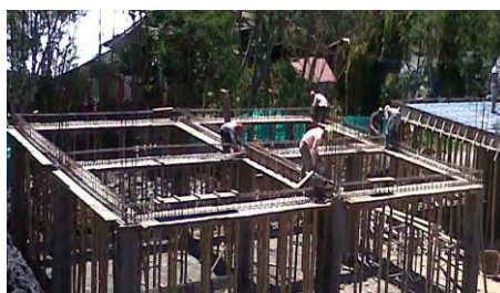
ARMADO DE REFUERZO VIGAS AERES BATERIAS SANITARIAS
