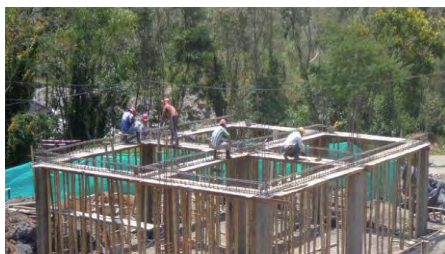
ARMADO DE REFUERZO VIGAS AEREAS CAMERINOS
