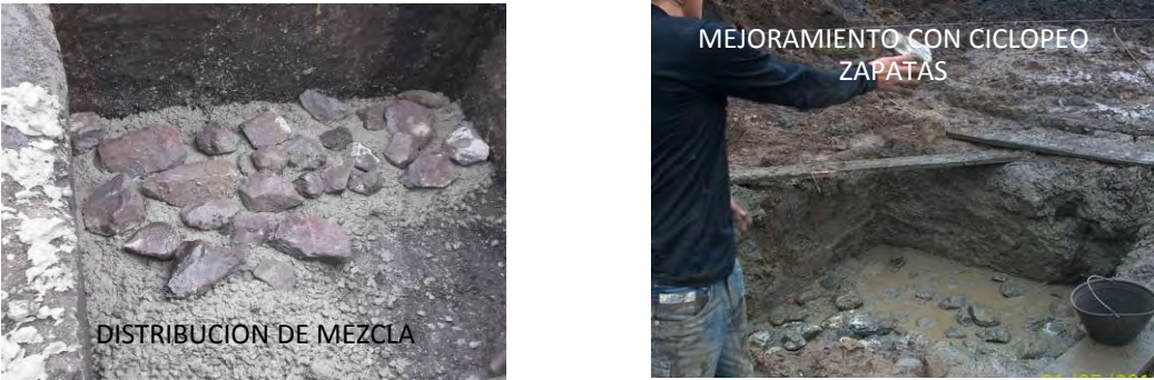
Ilustración 23 Concreto ciclópeo para mejoramiento de suelo
