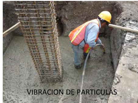
Ilustración 13 Concreto para zapatas
