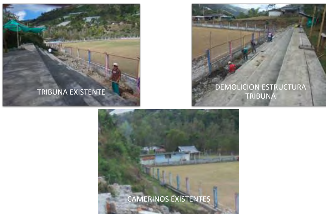
Ilustración 49 Demolición de estructura existente
