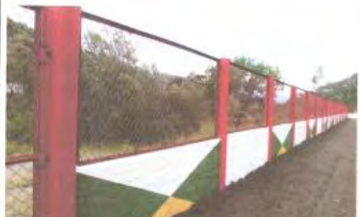
Cerramiento perimetral pintado y terminado. (Presentan buenas condiciones).
