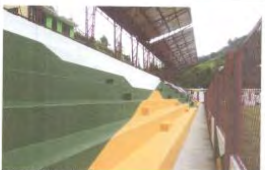
Graderías pintadas y terminadas.
