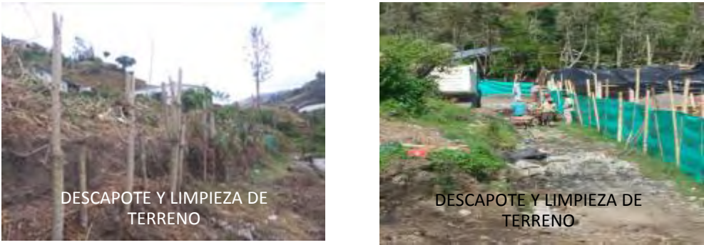
Ilustración 6 Descapote y limpieza de terreno
