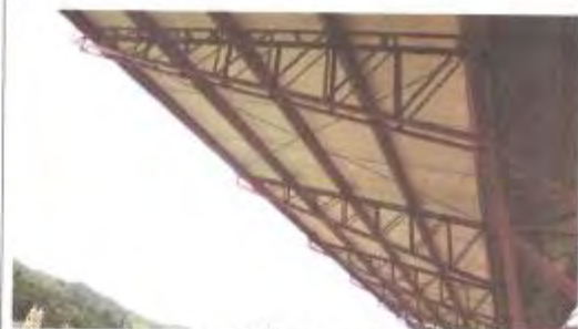
Vista de la cubierta, en gradería obras terminadas y pintadas. (En buenas condiciones)
