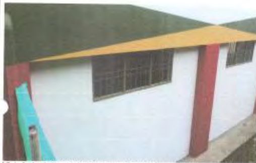
Vista fachada lateral derecha camerinos. (Presentan buenas condiciones).
