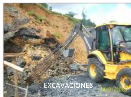
Ilustración 44 Excavación a máquina
