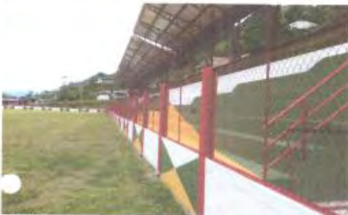
Vista interna de cerramiento perimetral. (Presentan buenas condiciones).
