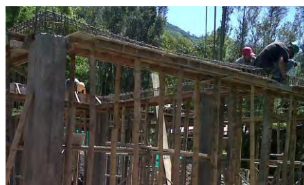
ARMADO DE REFUERZO BATERIAS SANITARIAS
