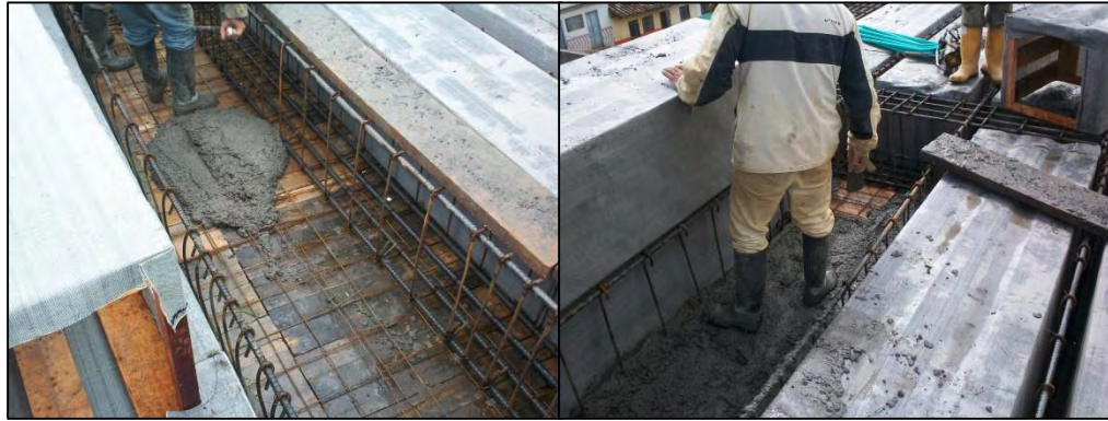
Fotografía 4.1-43. Solado de losa aligerada.
