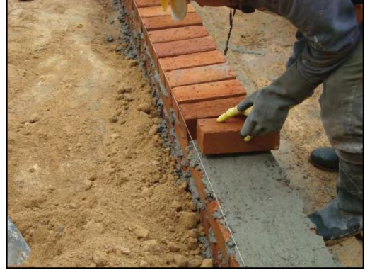
Fotografía 4.1-35. Alzado de muros de confinamiento, sobrecimiento de vigas.
