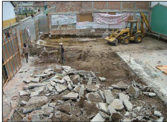
Fotografía 4.1-7. Demolición de placa.
