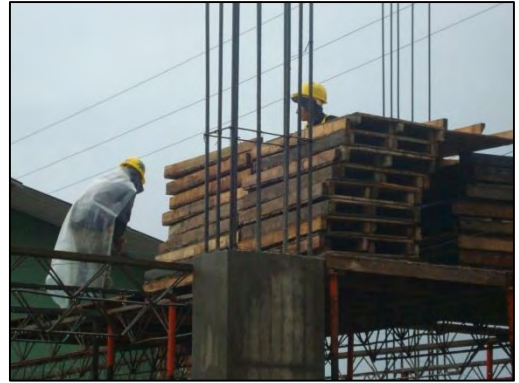
Fotografía 4.1-51. Instalación de formaleta de losa aligerada.
