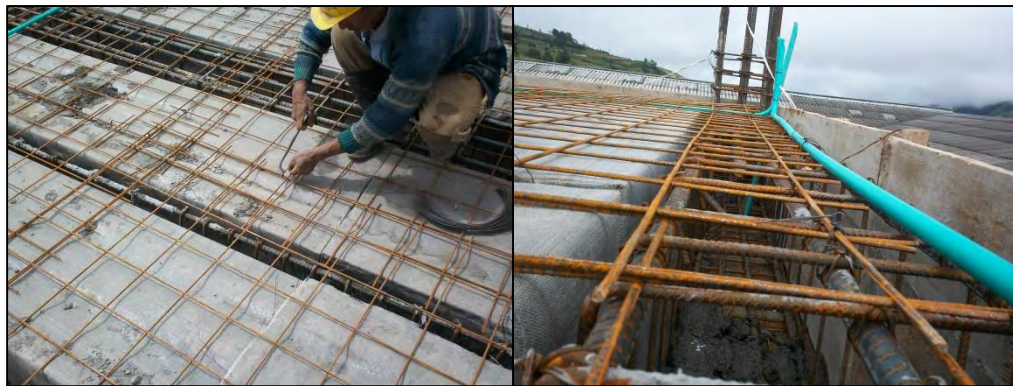
Fotografía 4.1-44. Malla electrosoldada para la torta superior de losa aligerada.
