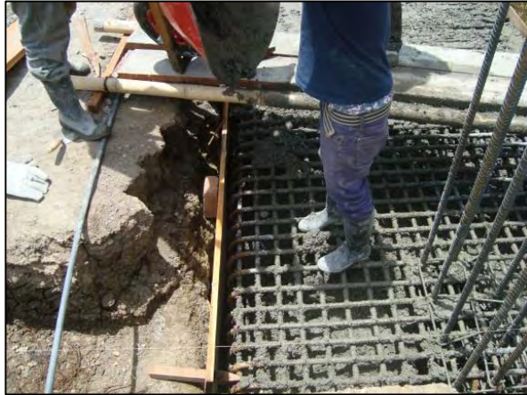
Fotografía 4.1-24. Fundición de zapatas concreto 3000 psi.
