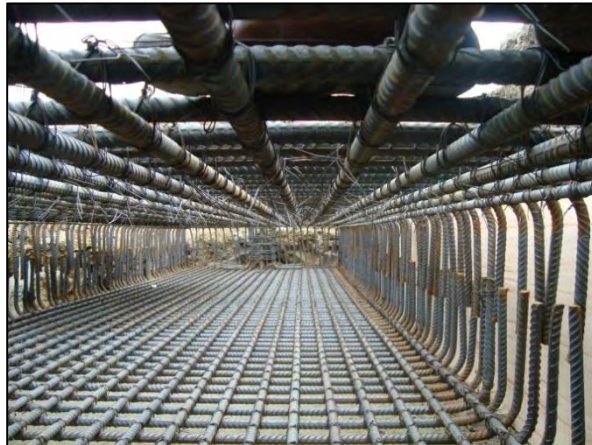
Fotografía 4.1-22. Acero de refuerzo zapatas Z-2.
