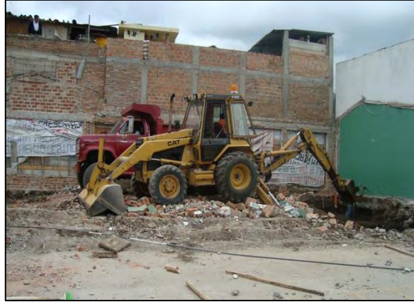
Fotografía 4.1-6. Excavación con máquina.
