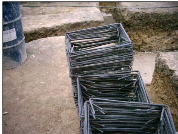
Fotografía 4.1-21. Flejes para vigas de cimentación.
