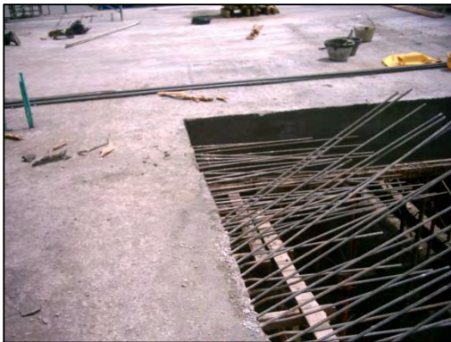
Fotografía 4.1-46. Refuerzo de escalera.
