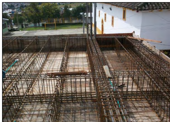
Fotografía 4.1-39. Refuerzo viguetas losa aligerada.
