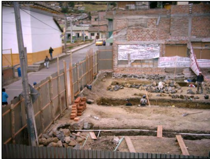
Fotografía 4.1-16. Avance de excavaciones.
