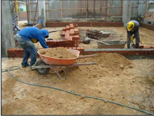
Fotografía 4.1-34. Relleno con material de préstamo (recebo).
