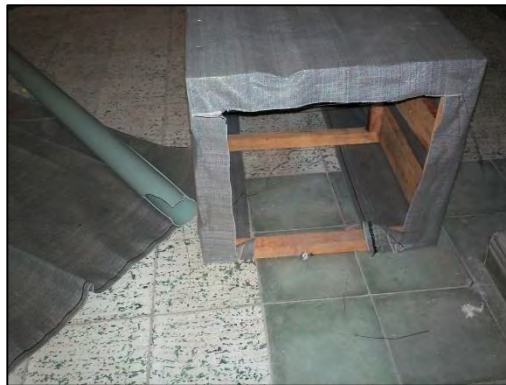
Fotografía 4.1-37. Casetones construidos en tabla y malla gris.
