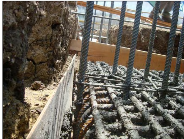
Fotografía 4.1-25. Fundición de zapatas concreto 3000 psi.
