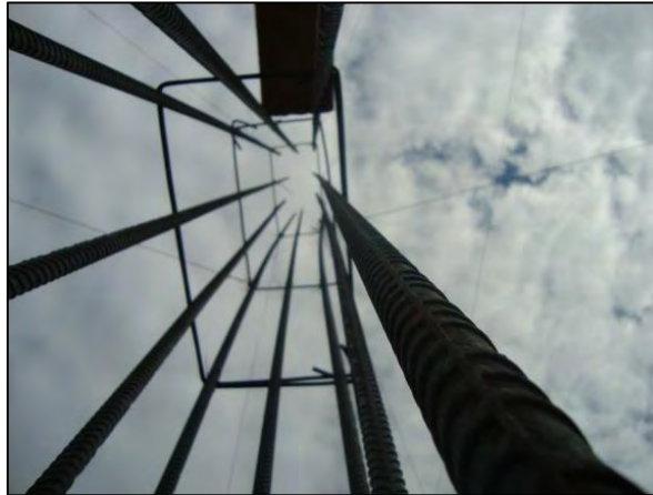
Fotografía 4.1-23. Refuerzo longitudinal columnas 40 x 70 (cm) bloque de aulas de clase.
