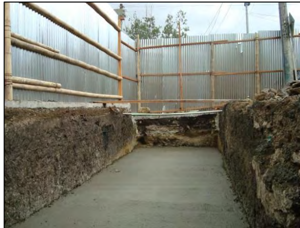
Fotografía 4.1-20. Solado de limpieza-mejoramiento de cimientos en concreto ciclópeo.
