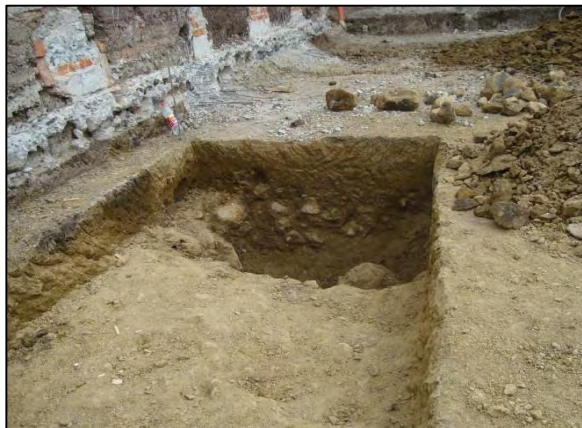
Fotografía 4.1-10. Excavación de zapata alargada.
