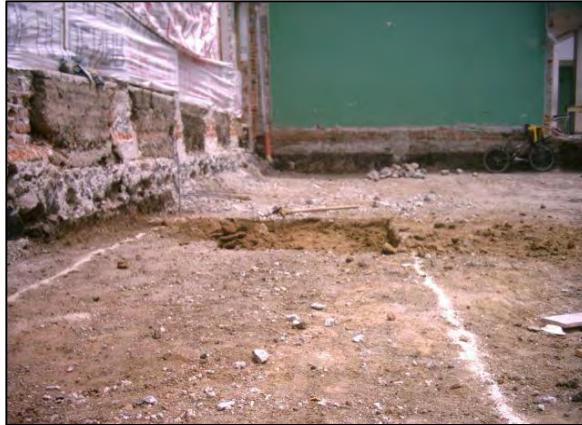
Fotografía 4.1-9. Excavación de zapata alargada.
