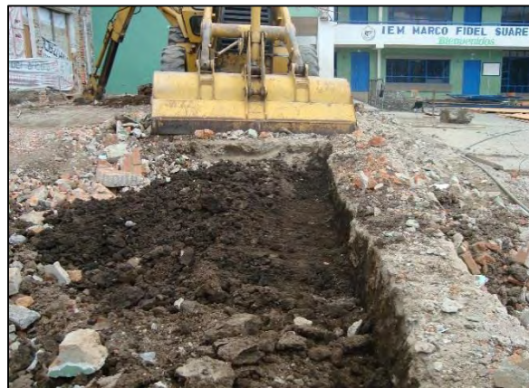
Fotografía 4.1-8. Remoción de cimientos existentes.
