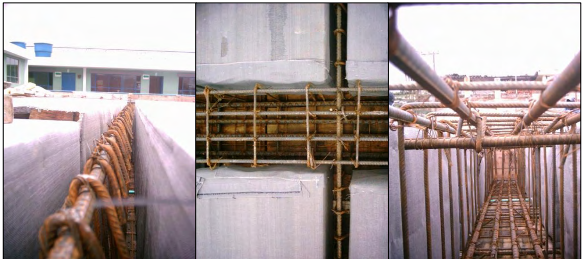
Fotografía 4.1-42. Casetones, viguetas y vigas principales.
