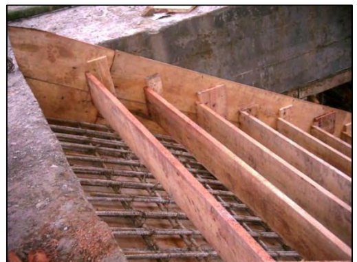
Fotografía 4.1-49. Formaleta para escalera.
