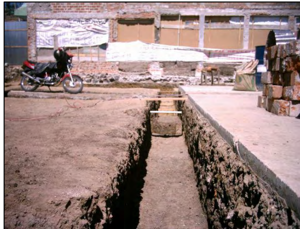
Fotografía 4.1-18. Culminación de excavación vigas de amarre.
