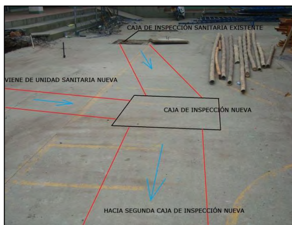
Fotografía 4.1-12. Trazado de cajas de inspección.
