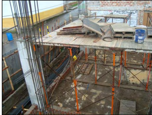
Fotografía 4.1-36. Instalación de formaleta para losa aligerada nivel N+4,14.
