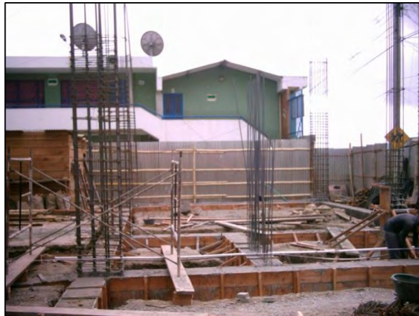
Fotografía 4.1-33. Vigas de cimentación y acero de refuerzo bloque de aulas.
