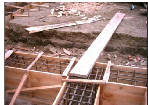
Fotografía 4.1-31. Refuerzo y formaleta viga de amarre sección 2.
