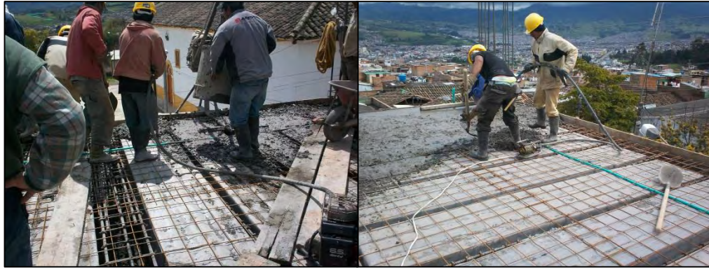
Fotografía 4.1-45. Fundición de losa aligerada.
