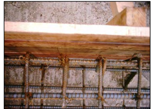
Fotografía 4.1-29. Chequeo espesor mínimo de recubrimiento lateral.
