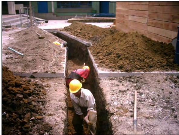
Fotografía 4.1-14. Excavación cámaras de inspección y tuberías sanitarias.
