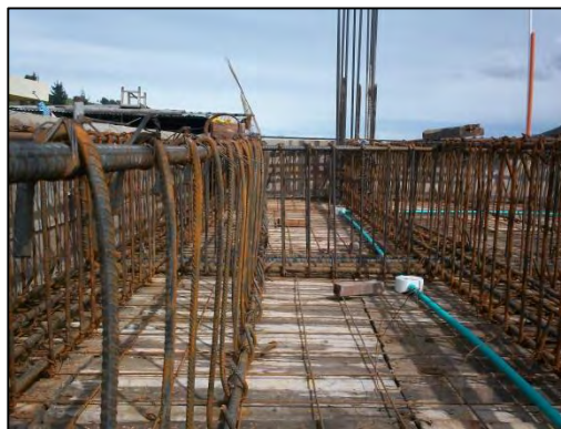
Fotografía 4.1-38. Acero de refuerzo e instalaciones eléctricas para losa aligerada.
