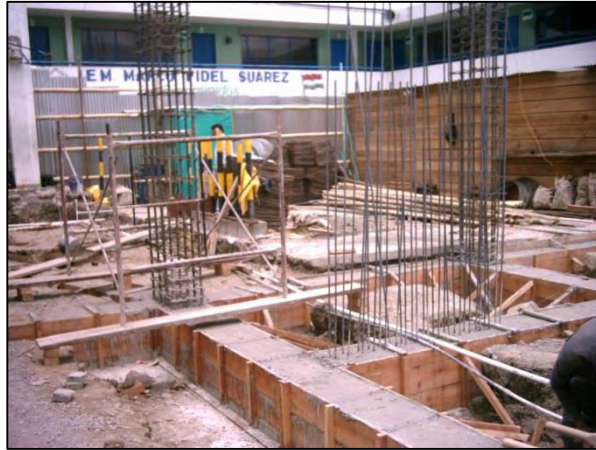
Fotografía 4.1-32. Vigas de cimentación, acero longitudinal de columnas y escalera bloque de aulas.
