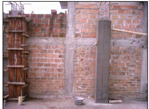
Fotografía 4.1-47. Columnas segundo piso unidad sanitaria nivel N+4,14.
