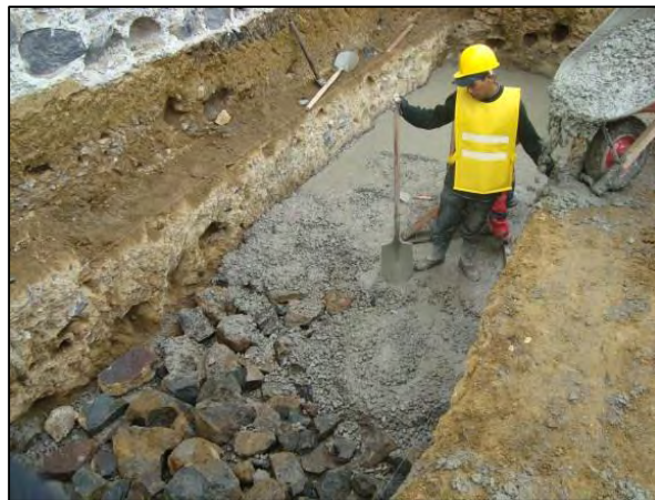
Fotografía 4.1-19. Fundición mejoramiento de cimientos concreto ciclópeo.
