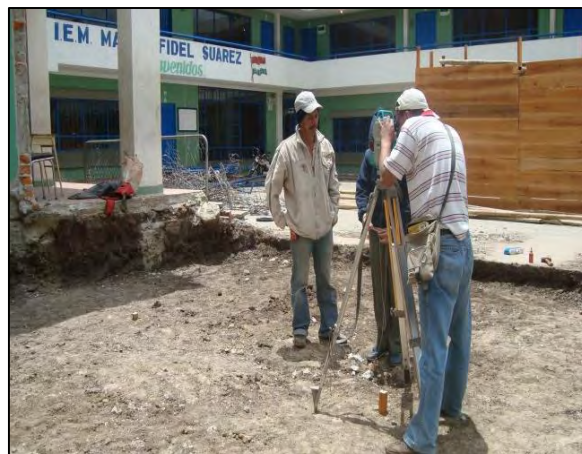
Fotografía 4.1-3. Localización de ejes.
