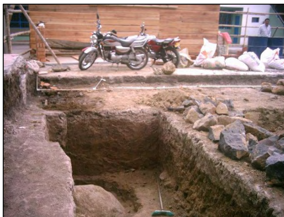
Fotografía 4.1-11. Corte y extracción de roca.
