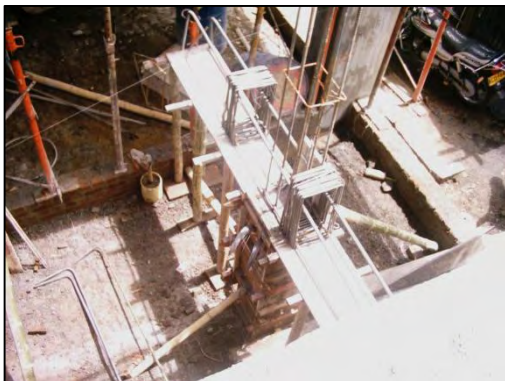
Fotografía 4.1-48. Acero de refuerzo viga de escalera.
