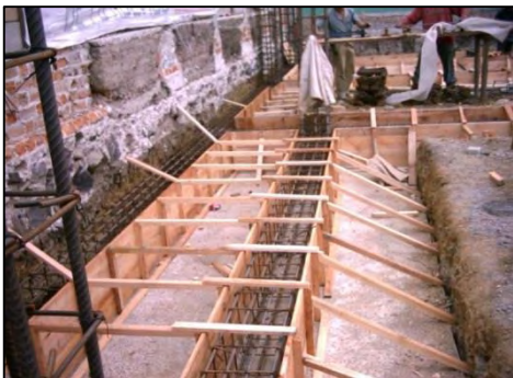
Fotografía 4.1-30. Refuerzo y formaleta viga de amarre sección 1.
