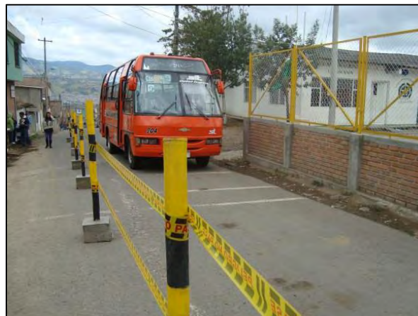
Fotografía 4.1-27. Señalización sendero peatonal.
