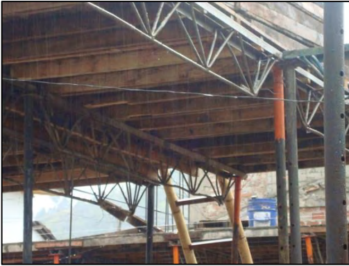
Fotografía 4.1-50. Lluvias intensas durante instalación de formaleta de losa aligerada.
