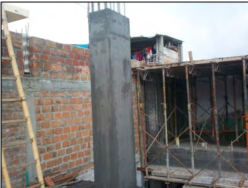
Fotografía 4.1-52. Columnas segundo piso N+4,14.
