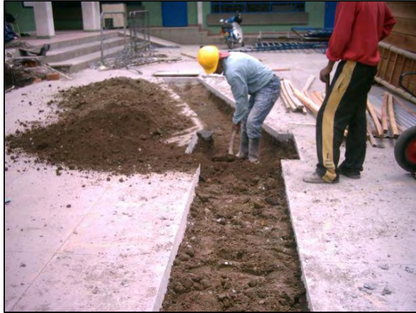
Fotografía 4.1-13. Excavación cámaras de inspección y tuberías sanitarias.
