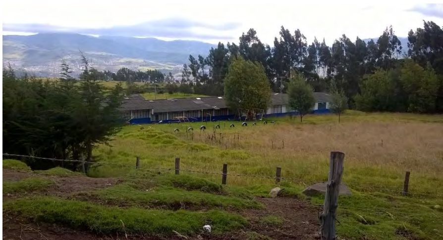
Fotografía 3. Infraestructura de una escuela abandonada. Fuente: la presente investigación
