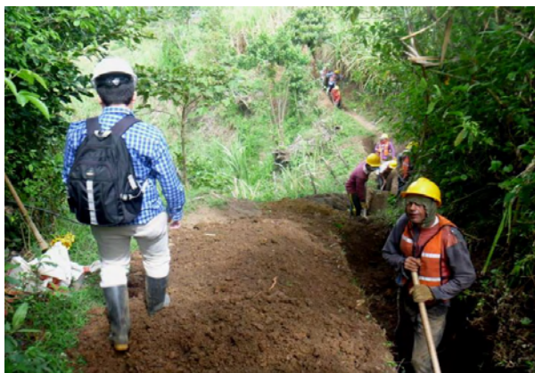
Figura 24. Excavación en material común.
