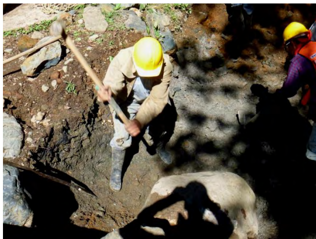
Figura 13. Excavación en roca para desarenador.
