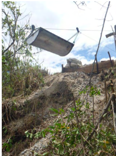
Figura 10. Transporte local de material en tarabita.
