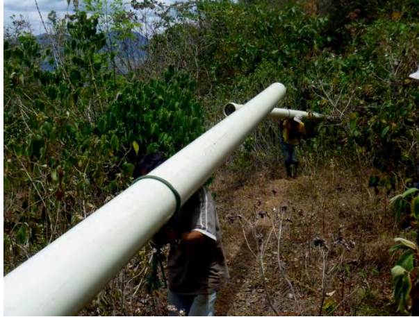
Figura 28. Transporte local de tubería en zonas de difícil acceso.
