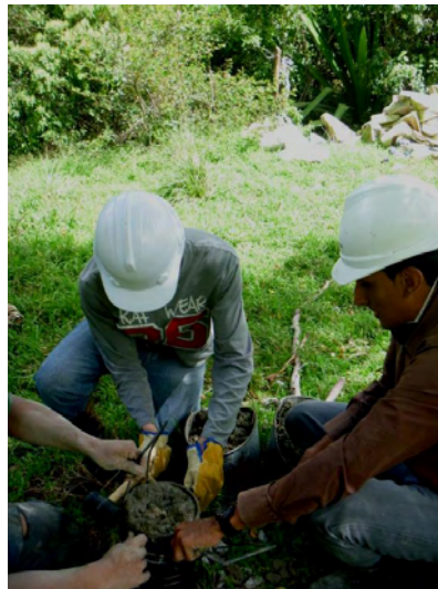
Figura 20. Toma de muestras para ensayos de resistencia.
