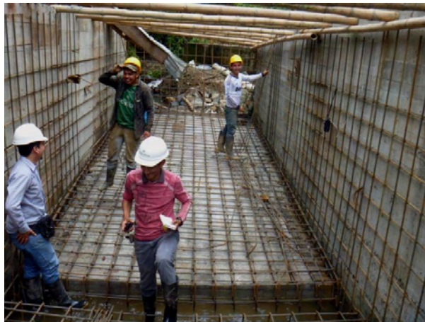
Figura 12. Armado parrilla de fondo y muros para desarenador.
