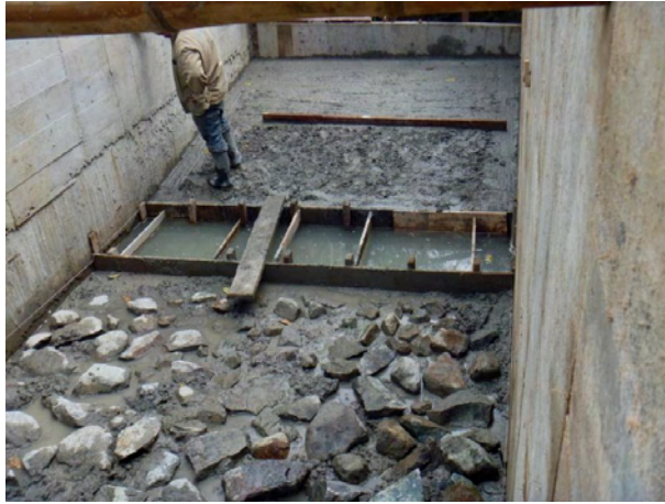
Figura 14. Fundición de solado para Desarenado.
