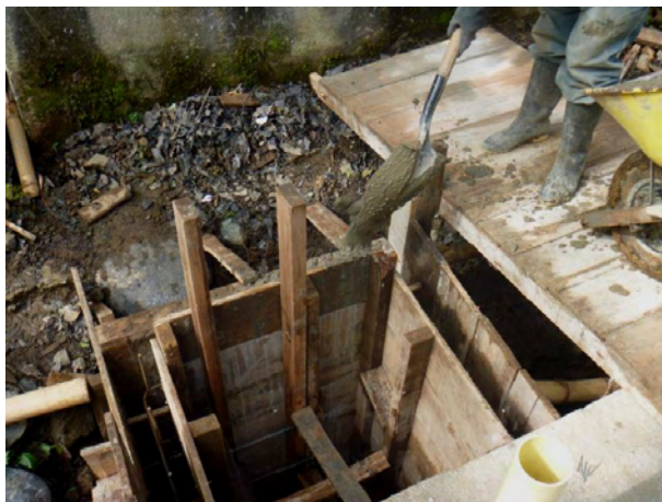
Figura 19. Fundición cámara de recolección.
