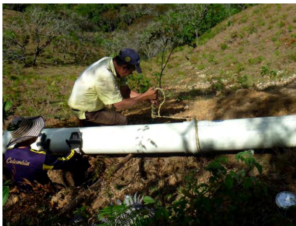
Figura 30. Ensamble de tubería empleando una barra y cuerda.
