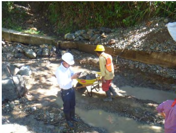
Figura 4. Limpieza en el área de construcción de la bocatoma.
