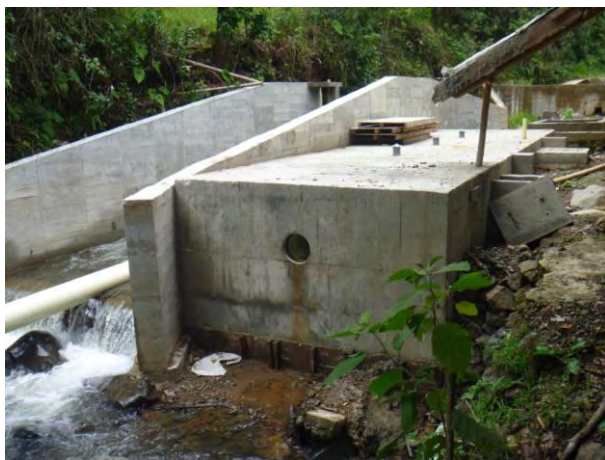
Figura 18. Losa superior del Desarenador.
