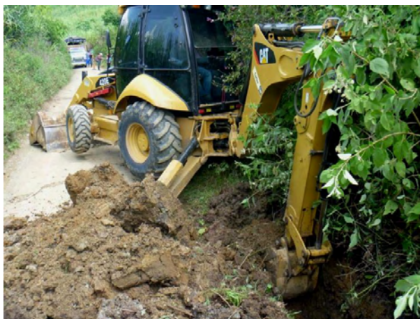
Figura 26. Excavación en vía con retroexcavadora.
