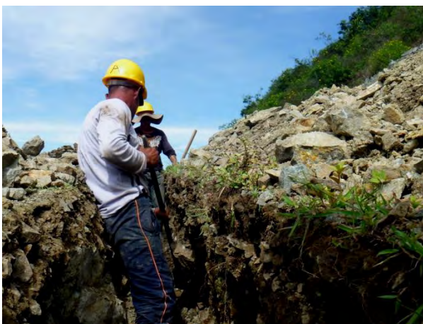
Figura 27. Excavación en roca.
