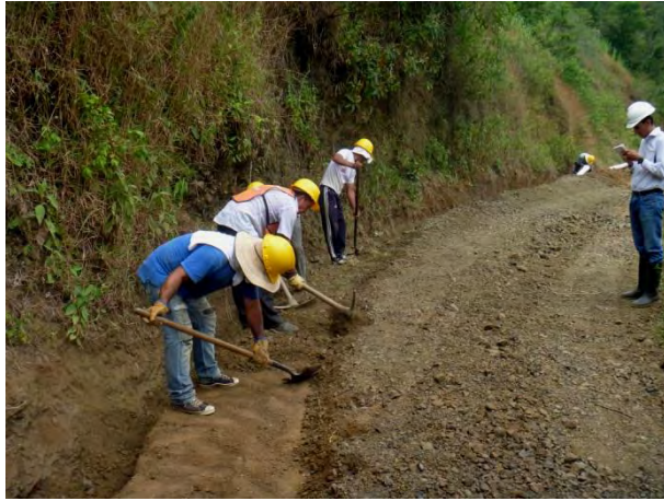
Figura 31. Relleno con material del sitio.
