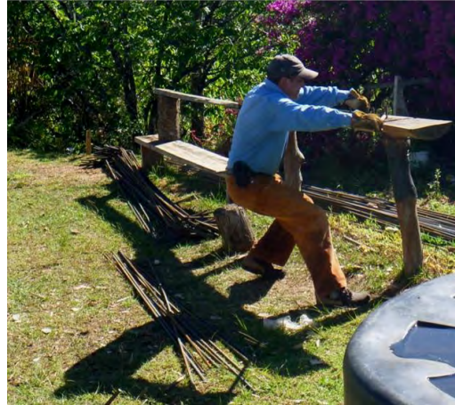
Figura 11. Figurado acero de refuerzo para desarenador.
