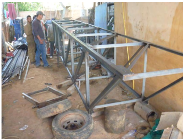
Figura 37. Construcción de cerchas.
