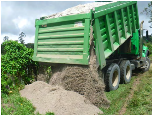
Figura 2. Recibimiento de material para bocatoma.
