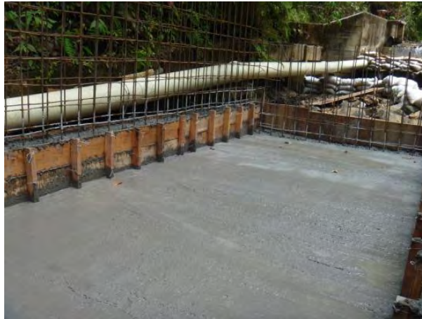
Figura 6. Losa del pozo de amortiguación.
