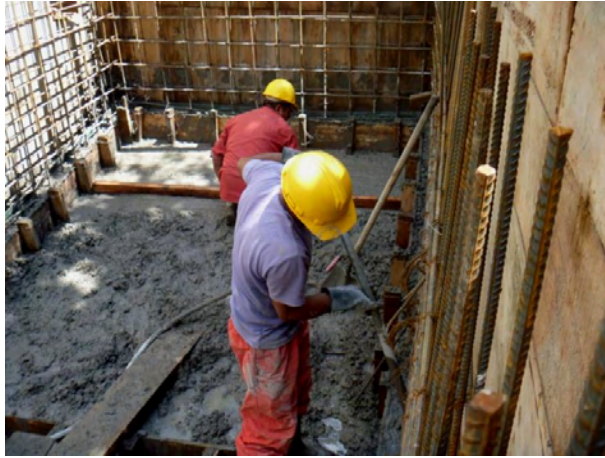
Figura 15. Empleo de vibrador en fundición de losa de fondo.
