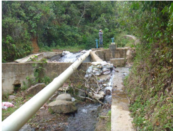
Figura 3. Desvío de la quebrada Porcaurco.
