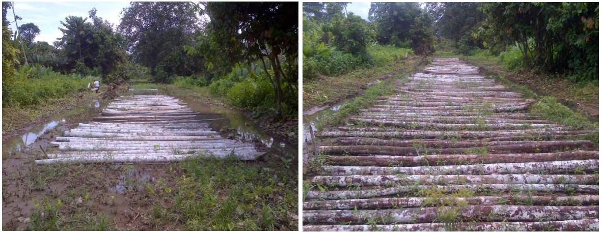
Figura 3.20. Empalizado para conformación de subrasante.
