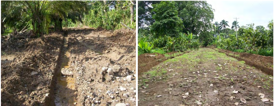
Figura 3.7. Excavación de la explanación.
