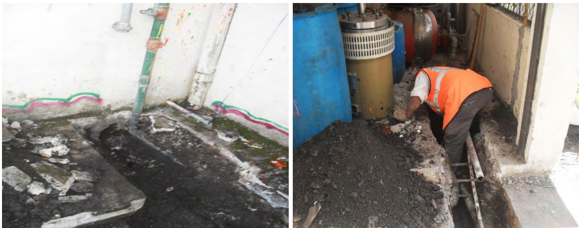
Figura 5.10. Desmonte de tubería de 2”.
