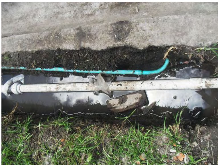
Figura 5.11. Reposición tubería de 2".
