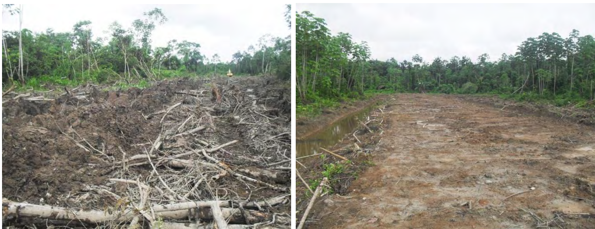
Figura 2.11. Excavación para conformación de la vía.
