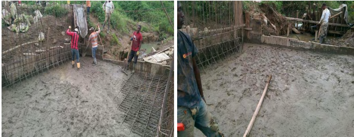
Figura 2.14. Armado y fundición de placa inferior.
