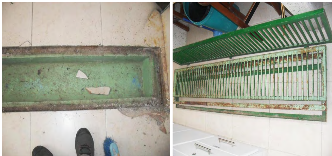
Figura 5.3. Desmonte de rejilla.
