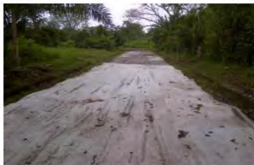
Foto. No 1. Estabilización de suelos de subrasante con Geotextil NT 5000
