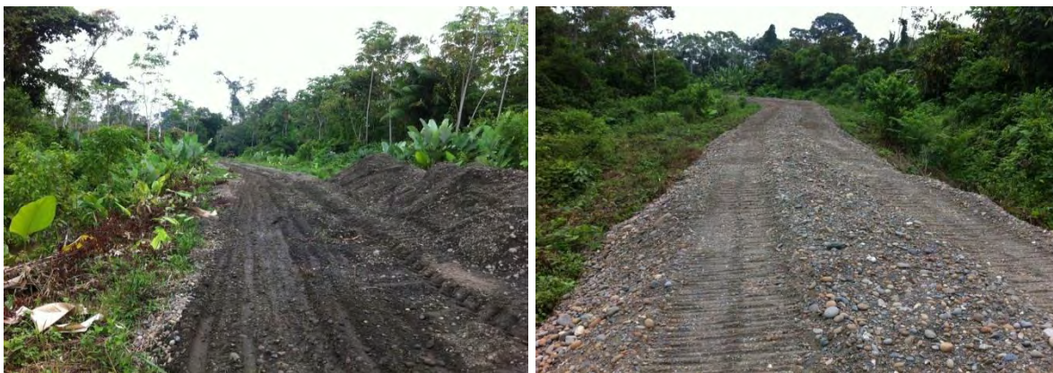
Figura 2.10. Conformación de base con material granular.
