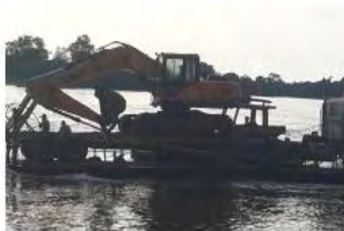
Transporte de Equipo al sitio de la obra
