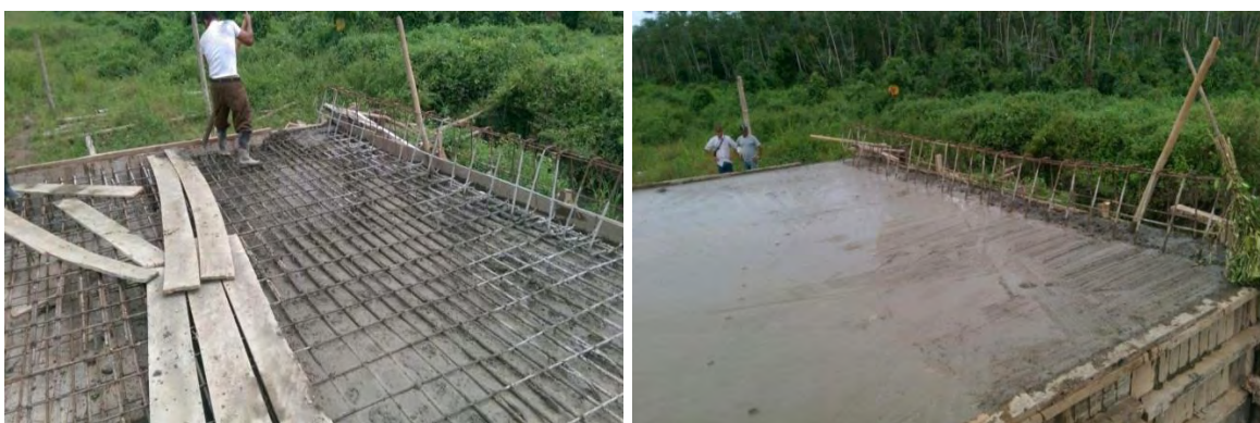
Figura 2.17. Fundición placa superior.
