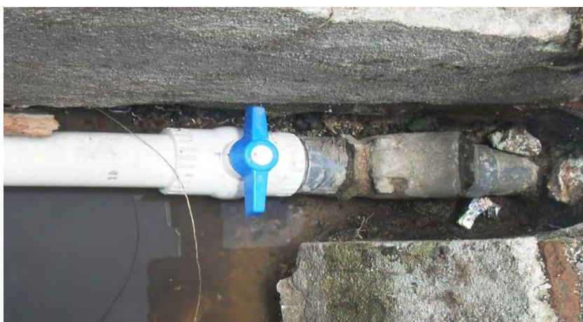
Figura 5.14. Instalación llave de paso 2”.
