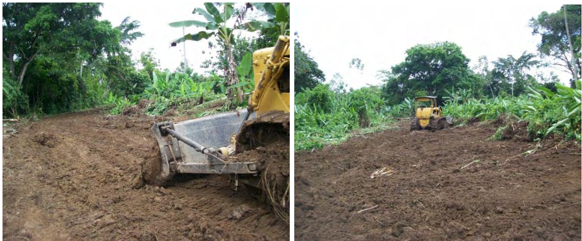
Figura 3.6. Desmonte y limpieza.
