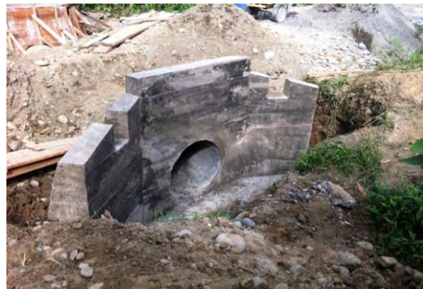
Figura 3.15. Construcción cabezal entrada.
