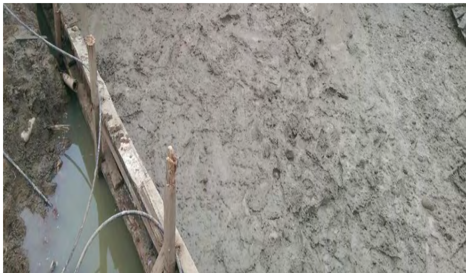
Figura 2.13. Instalación concreto ciclópeo.
