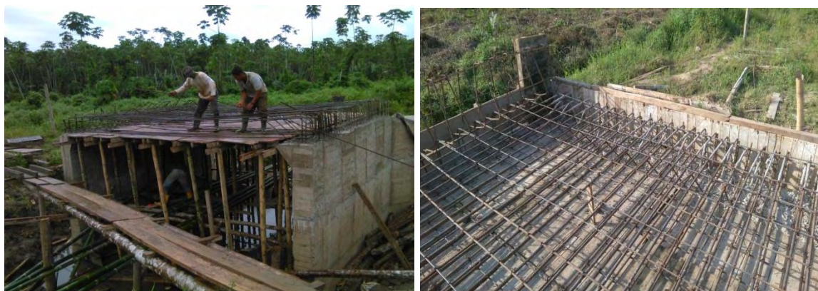
Figura 2.16. Armado acero de refuerzo placa superior.
