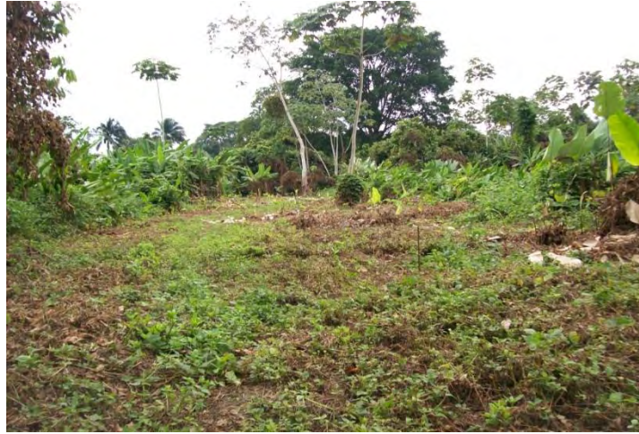
Figura 2.6. Localización y replanteo.
