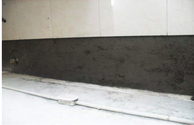
Figura 5.5 Reposición placa en concreto 3000 psi.
