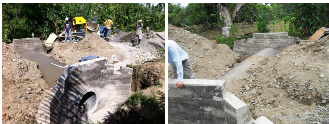
Figura 3.19. Vista alcantarilla terminada.
