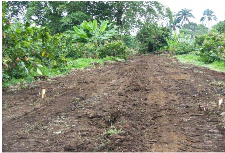
Figura 3.5. Localización y replanteo.
