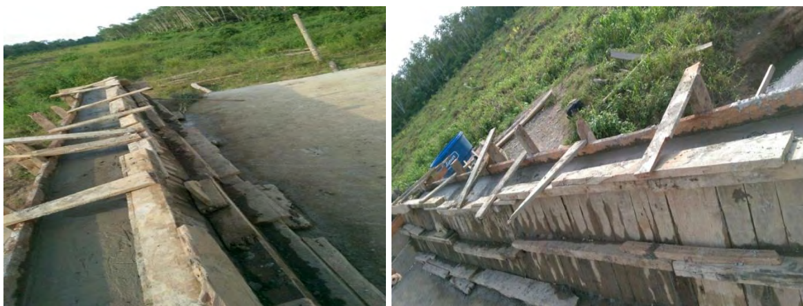
Figura 2.18. Fundición de bordillos.
