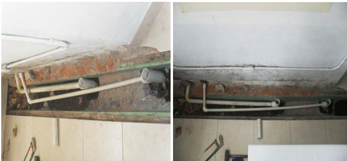
Figura 5.4. Instalación de tubería PVC de 2".
