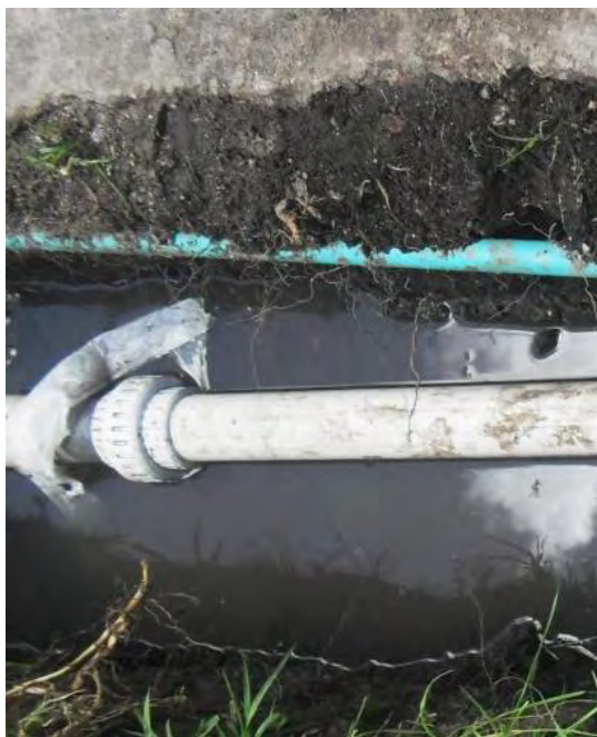
Figura 5.13. Instalación unión universal 2”.
