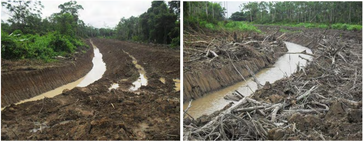
Figura 2.8. Excavación a máquina de cunetas.
