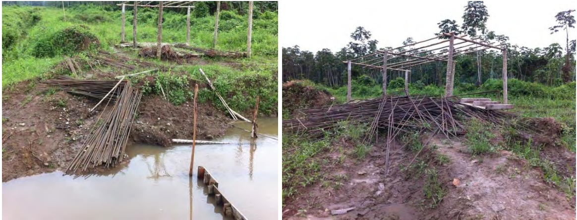
Figura 2.12. Acero de refuerzo figurado.
