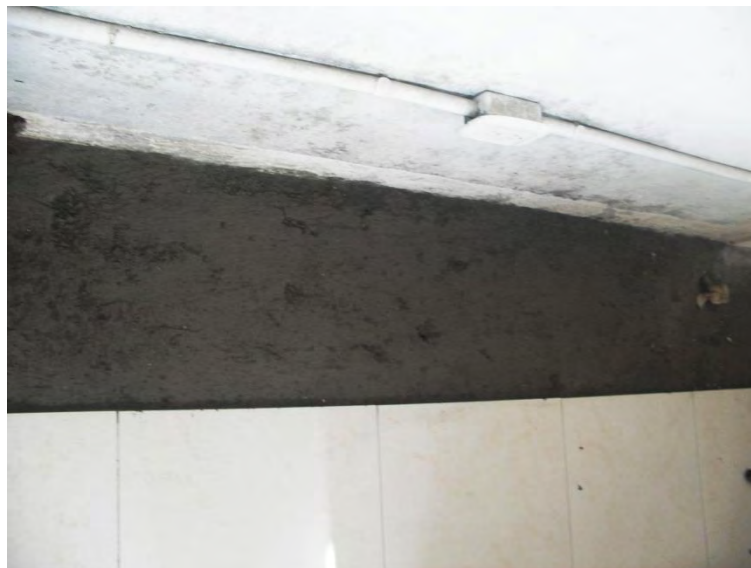
Figura 5.6. Pañete de piso.
