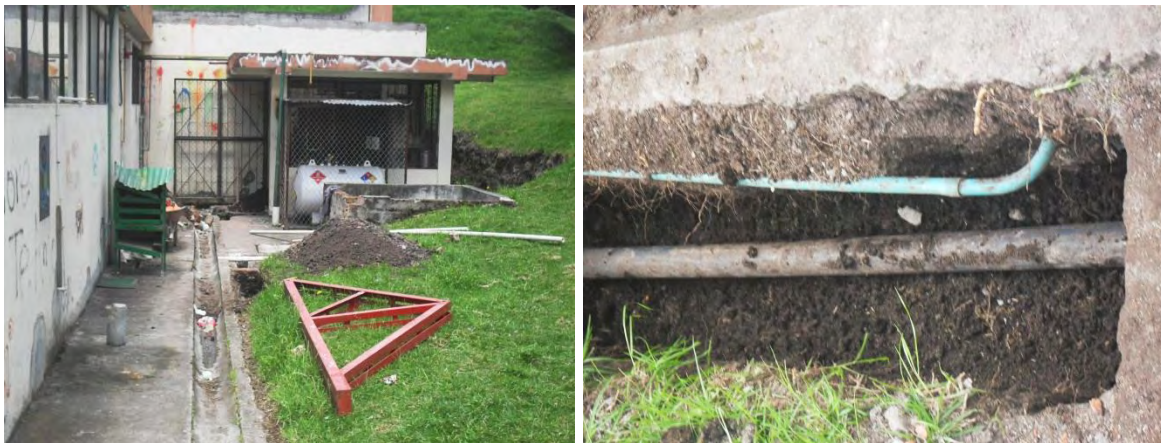
Figura 5.9. Excavación a mano.
