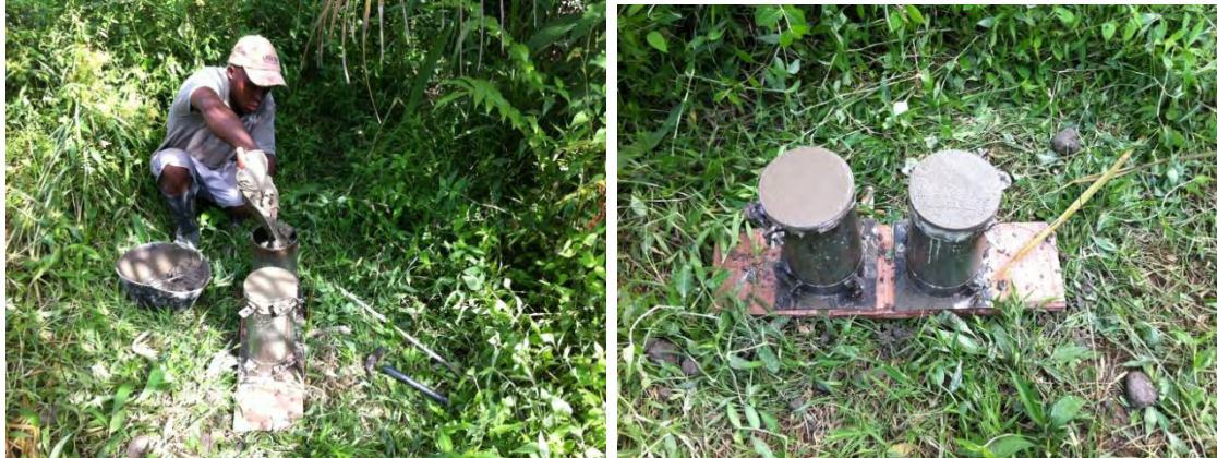
Figura 3.22. Toma de cilindros para ensayo a compresión.
