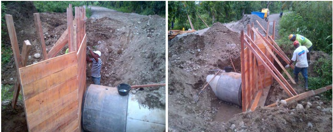
Figura 3.12. Instalación de tubería.
