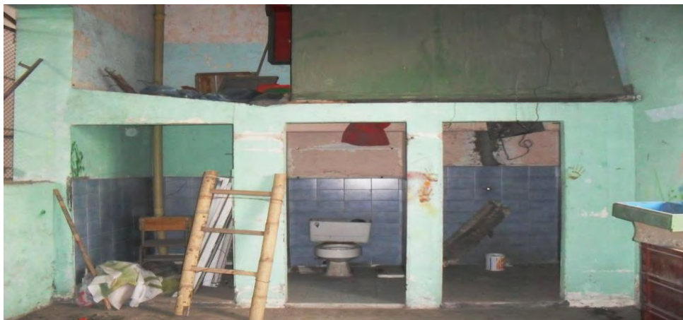
Figura 4.1. Lugar adecuaciones baterías sanitarias.
