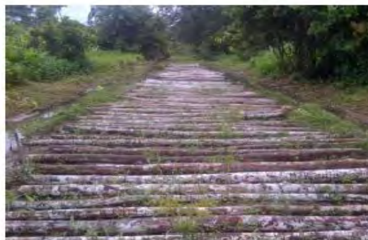
Foto. No 2. Empalzado para conformación de subbase
