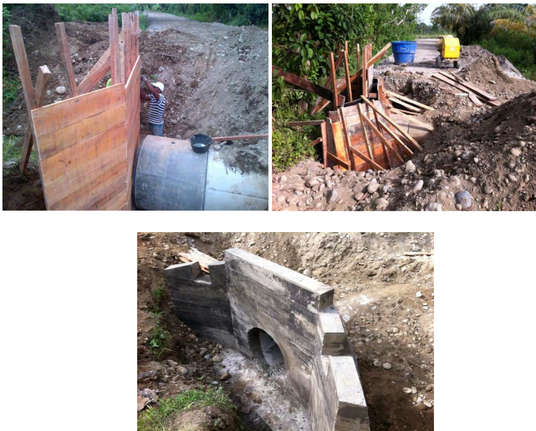
Figura 3.16. Construcción cabezal de salida.
