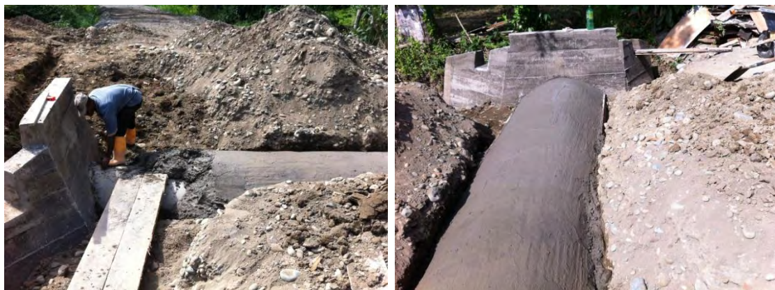
Figura 3.18. Recubrimiento de tubería en concreto simple.
