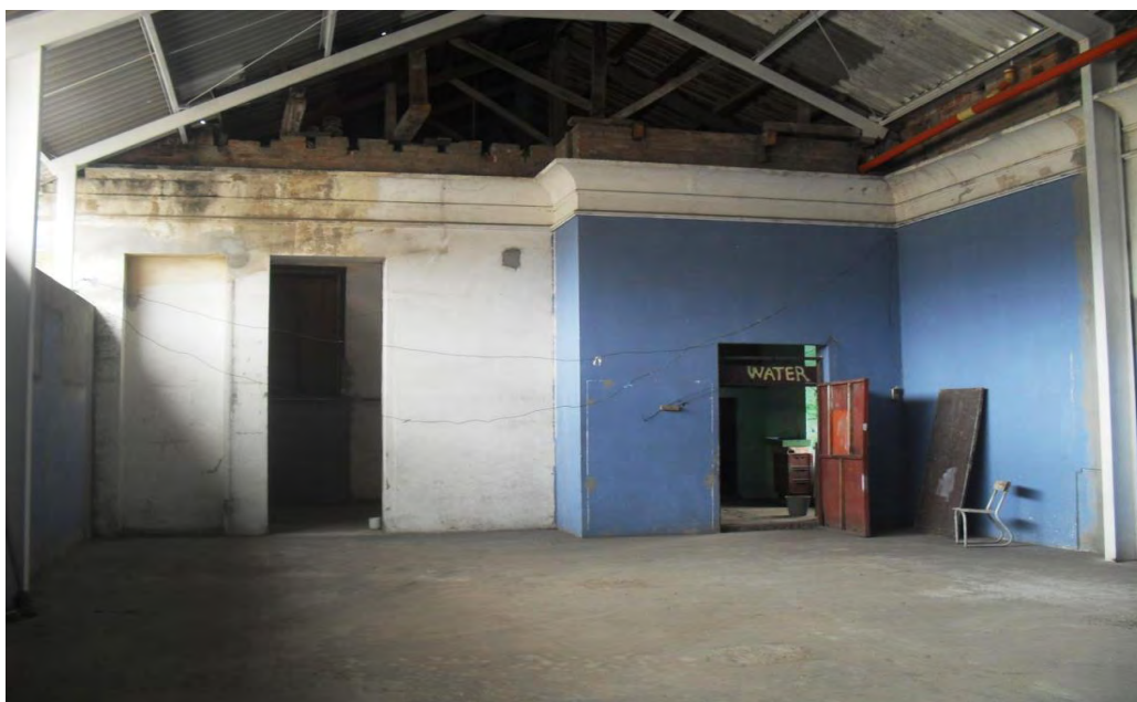
Figura 4.2. Lugar instalación acabados auditorio.
