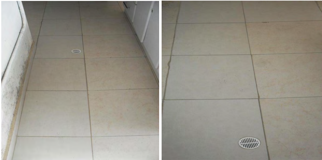
Figura 5.17 Estado de la obra terminada desagüe cuartos fríos.
