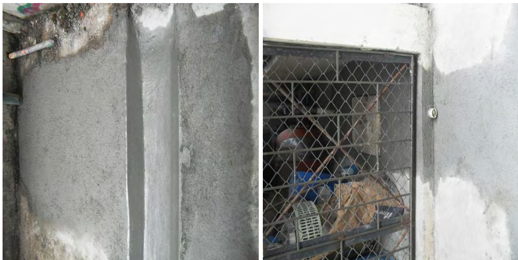
Figura 5.15. Reposición placa en concreto de andén.
