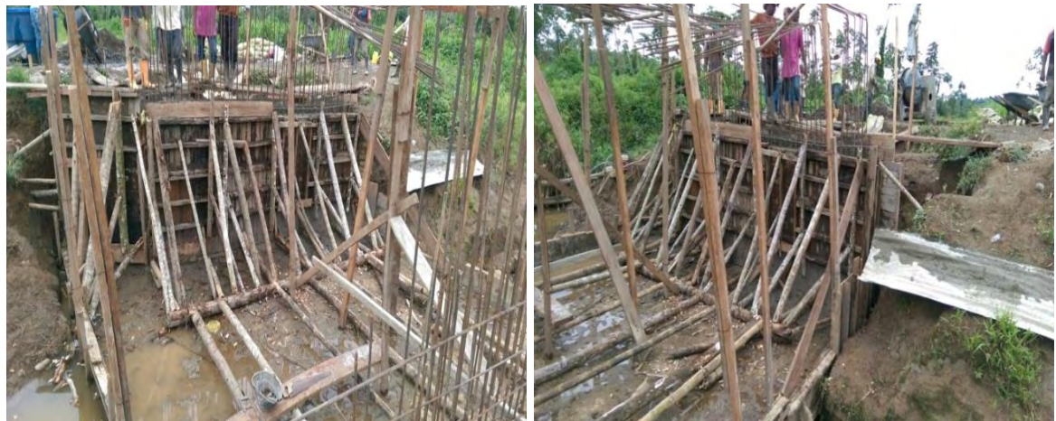
Figura 2.15. Armado y fundición de muros y aletas.
