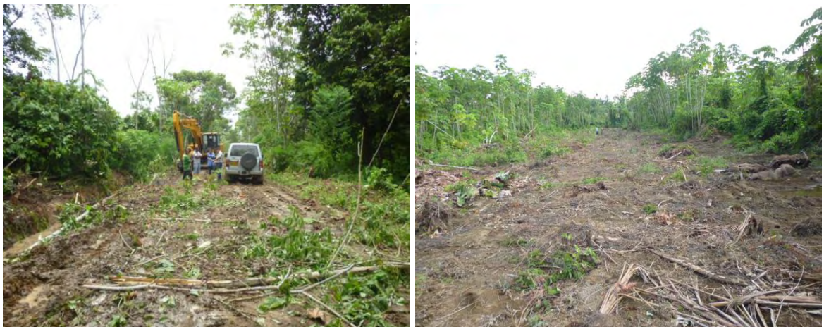
Figura 2.7. Rocería y limpieza de la vía.
