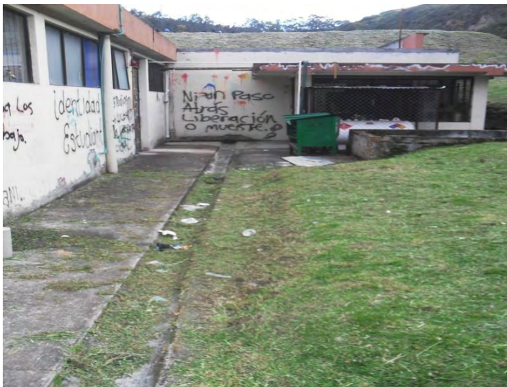
Figura 5.16. Relleno de material.
