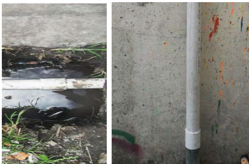
Figura 5.12. Instalación unión de 2".
