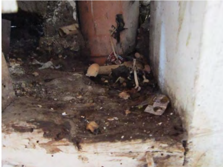
Figura 62. Presencia de hongos en gradas de Centro Cultural Palatino. Fuente: Elaboración Propia.
