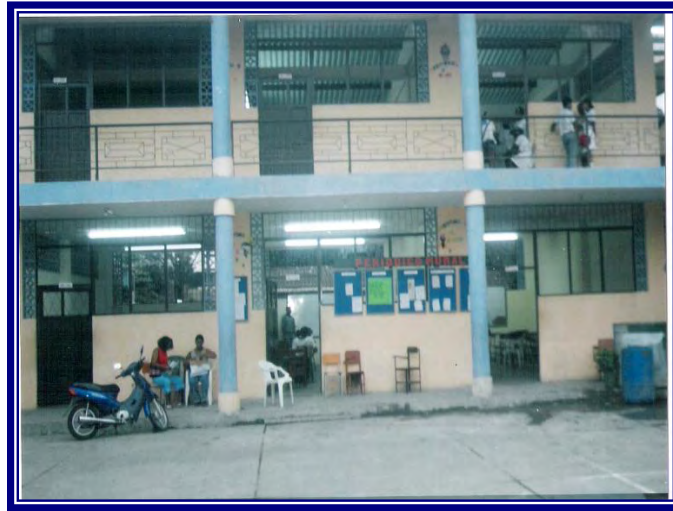
Figura 6. Bloque 1, Sede Principal
