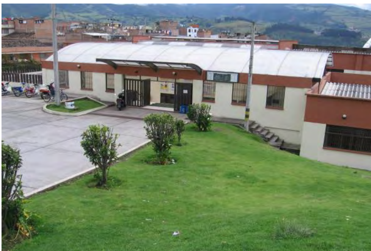
Figura 5. Instalaciones Liceo Universidad de Nariño. 2016
