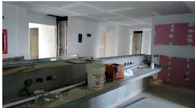
Imagen 26. Zona de estación de enfermería, pasillo principal 3er piso .H.C.I
