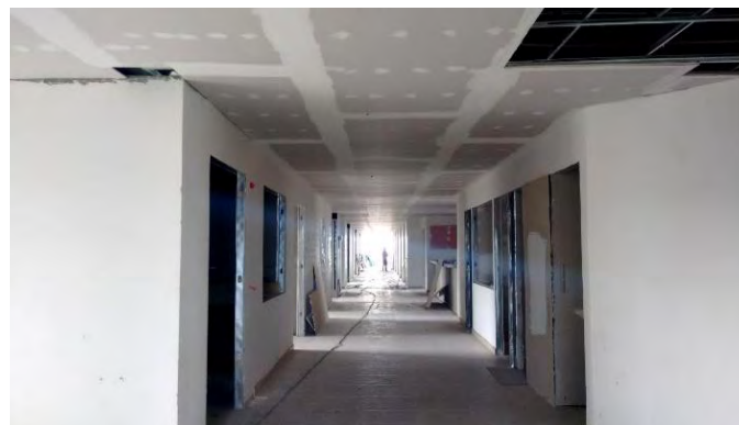
Imagen 27. Pasillo principal 3er piso hospital civil de Ipiales (H.C.I).
