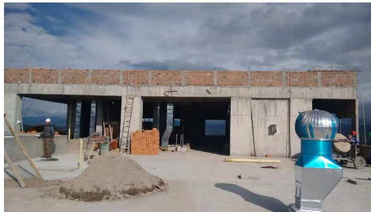
Imagen 29. Estado actual de obra 8vo piso y terraza H.C.I.
