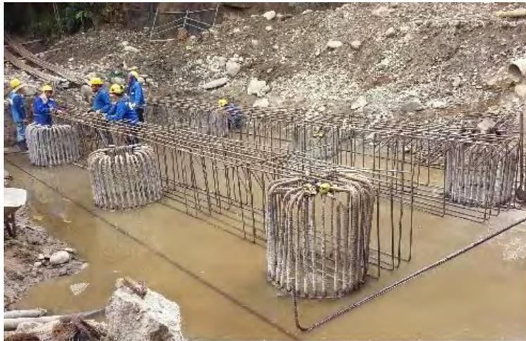
**Imagen 61. Amado y amarre de acero para zapata eje 2 – puente pienta**
