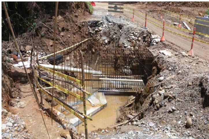
**Imagen 12. Losa Inferior de box K30+515 MD**
