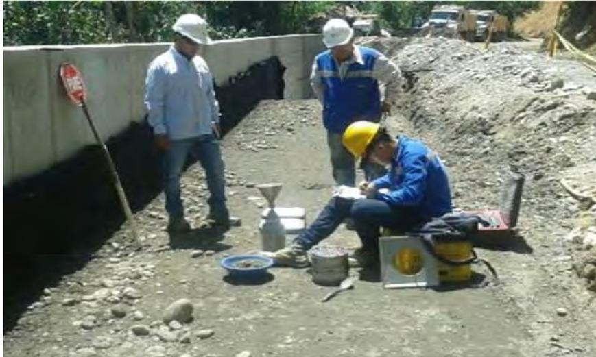
**Imagen 21. Relleno estructural y control de densidades muro K31+815 MI**
