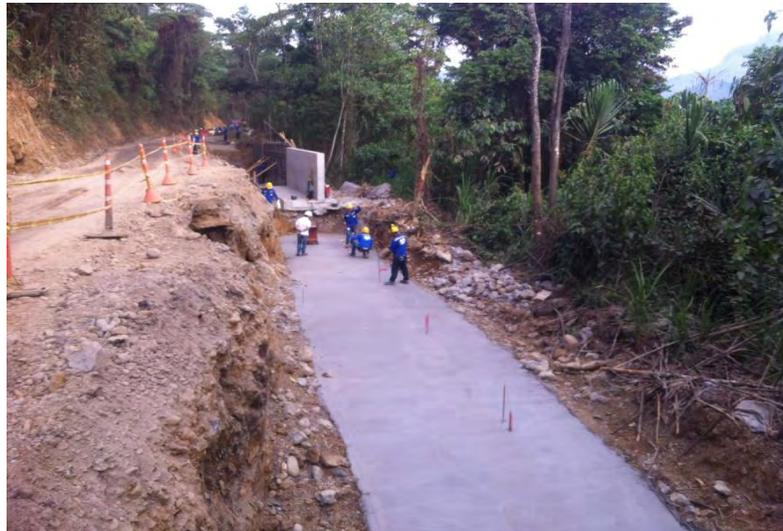
**Imagen 18. Solado de limpieza muro K31+815 MI**
