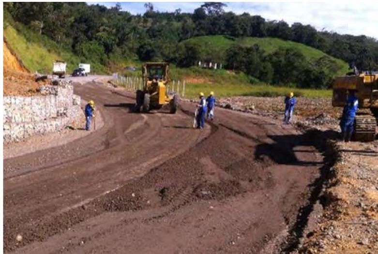
**Imagen 30. Instalación de subbase K30+300 - K30+600**
