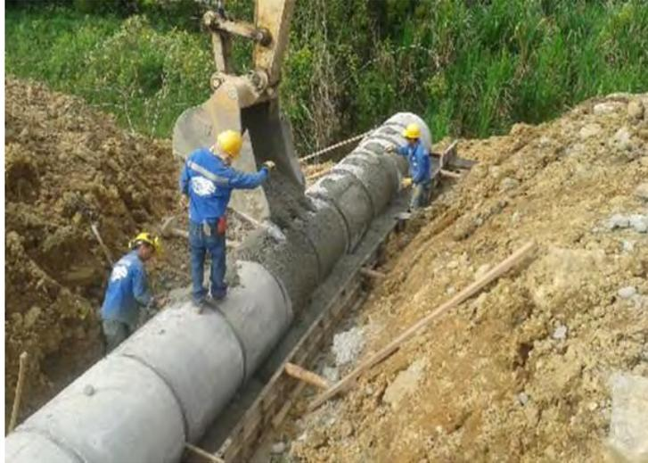
**Imagen 7. Atraque de tubería K32+080 MI**
