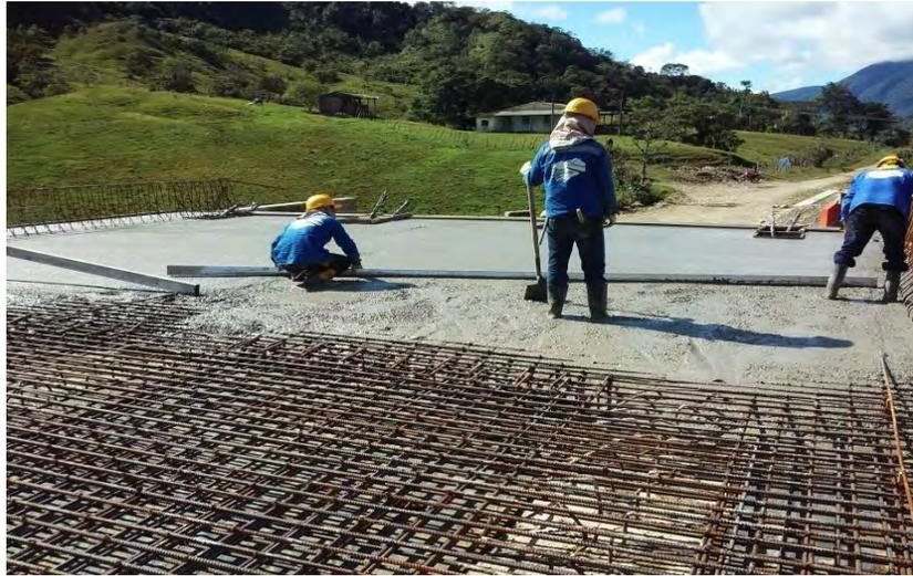
**Imagen 55. Fundición losa superior (tablero) – puente violin**
