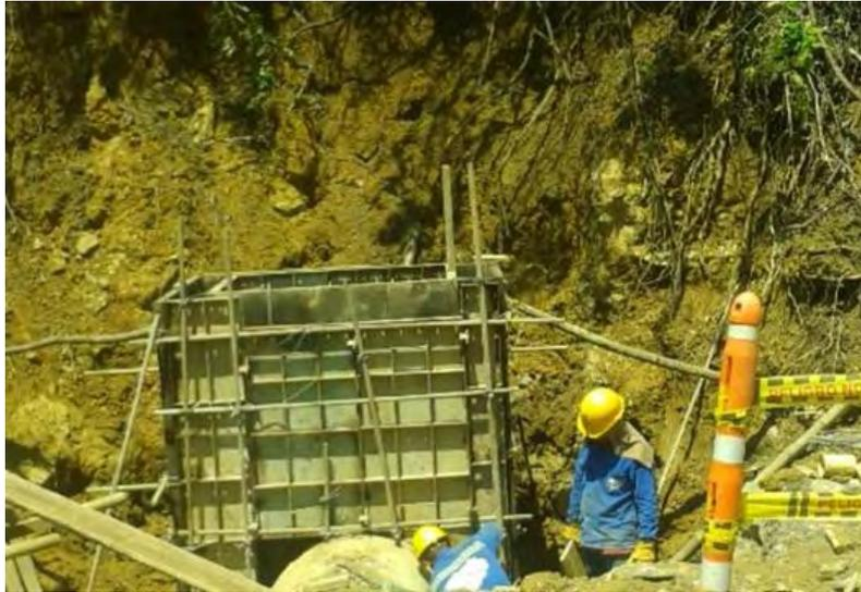
**Imagen 8. Encofrado de la estructura de encole (caja) K32+080 MD**
