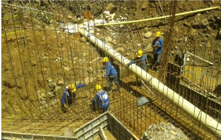
**Imagen 11. Armado de acero box K30+515 MD**
