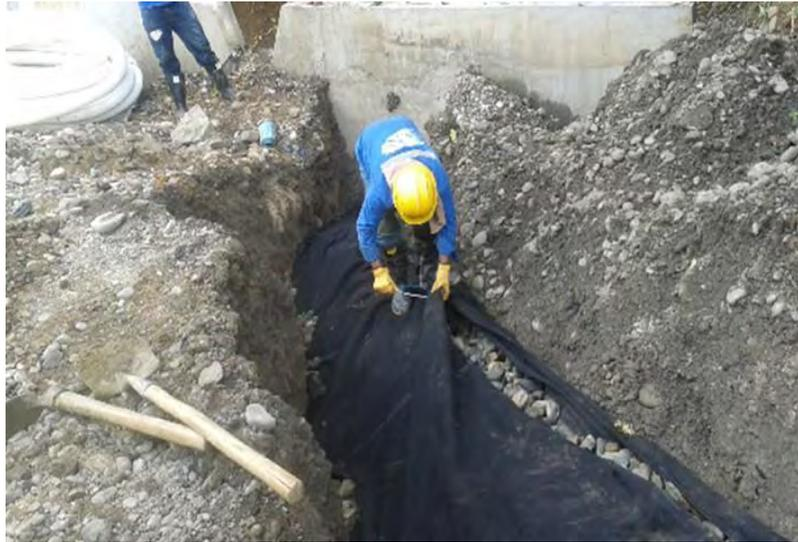
**Imagen 26. Cierre de geotextil K31+950 MD**
