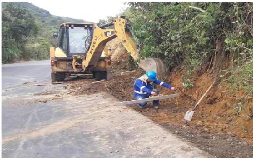
Imagen 46. Excavación para cunetas K32+ 700 MD
