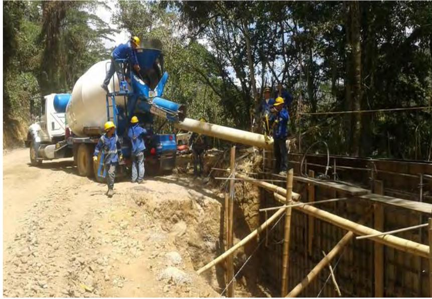
**Imagen 20. Fundición de vástago de muro K31+815 MI**
