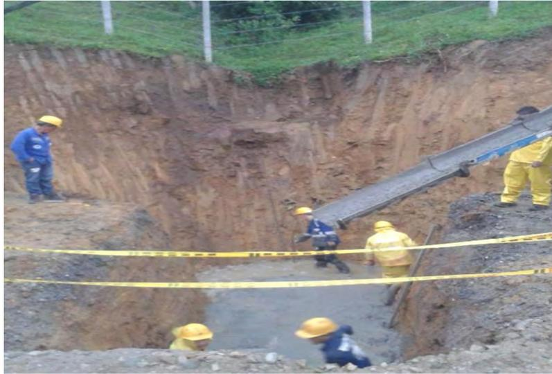
**Imagen 5. Vaciado de solado K31 +200 MD**
