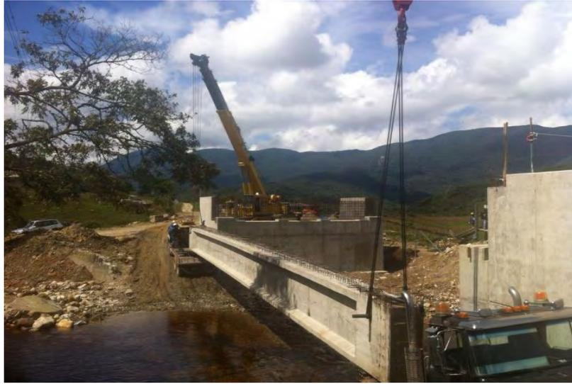
**Imagen 52. Izaje de viga pos-tensadas – puente violín**
