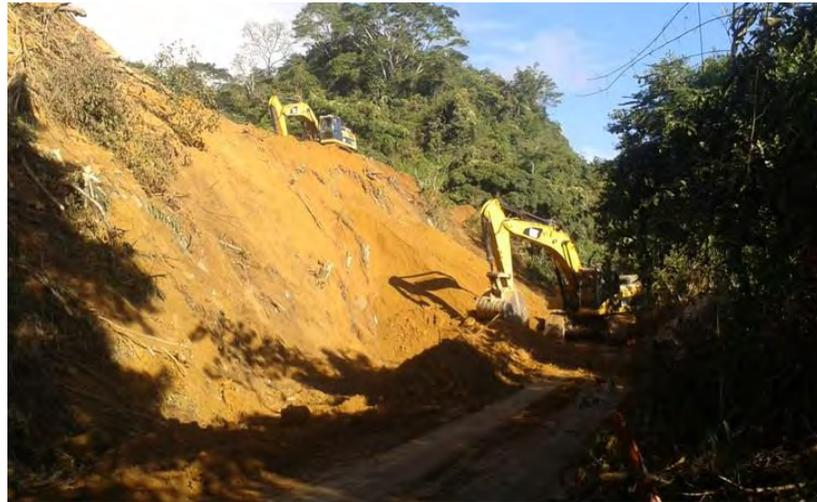
**Imagen 4. – Corte de talud K32+490 MD**
