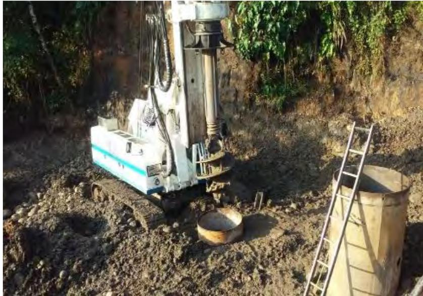
**Imagen 57. Excavación y ubicación de la camisa pilote eje 2 – puente pienta**
