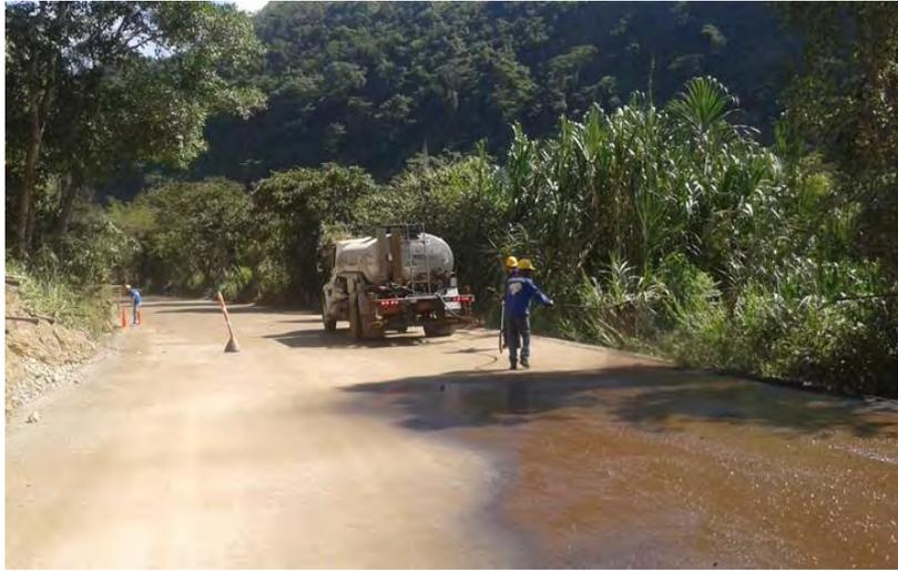
**Imagen 37. Riego de emulsión asfáltica K31+ 200 MI**
