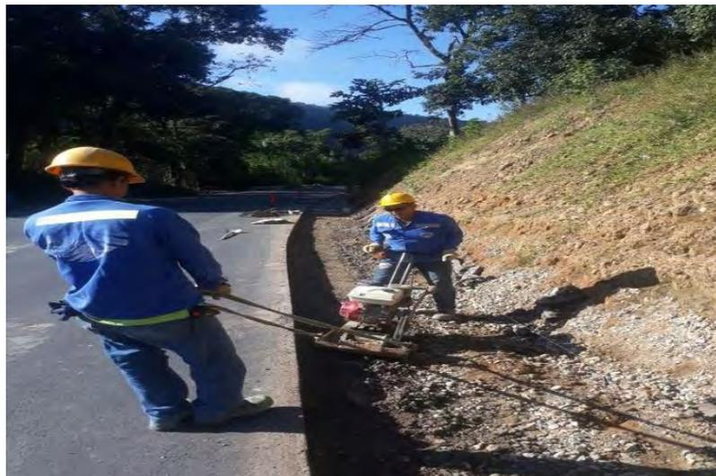
**Imagen 48. Conformación de piso para cunetas K32+900 MD**
