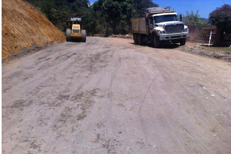
**Imagen 31. Compactación de subbase granular K32+100 - K32+300**
