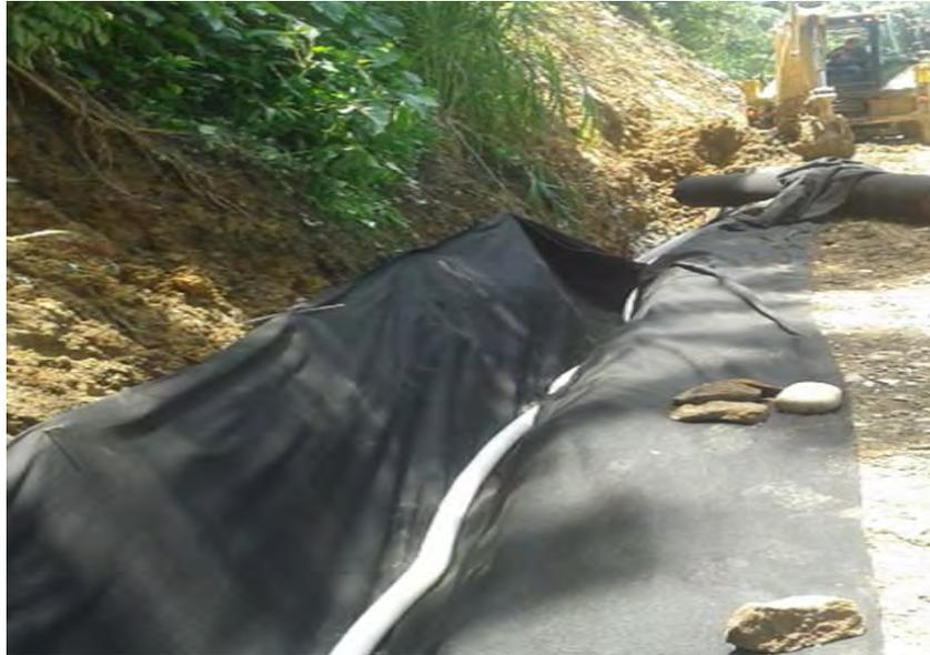
**Imagen 24. Instalación de geotextil y manguera perforada 4" K31+850 MD**
