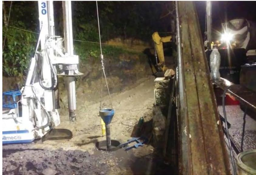
**Imagen 59. Vaciado de concreto pilotes eje 2 - tubería tremie - puente pienta**
