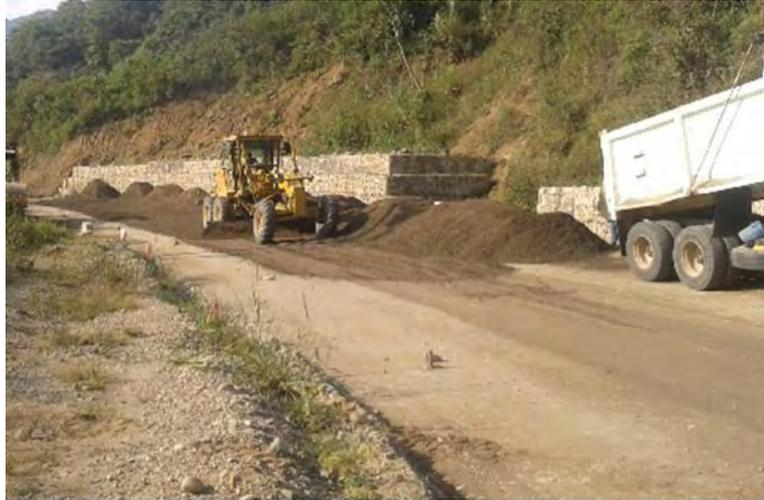
**Imagen 34. Instalación de base granular K30+500 - K30+660**
