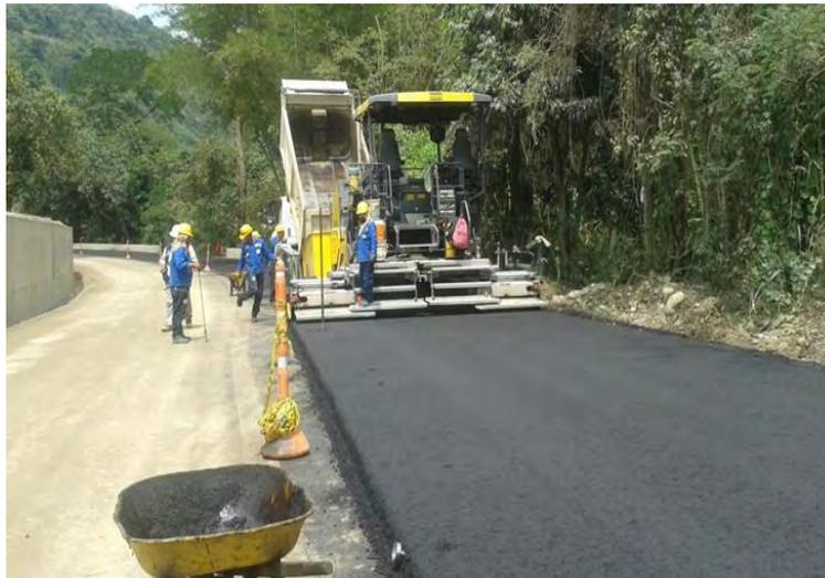
**Imagen 40. Instalación de mezcla asfáltica K32+ 800 MI**
