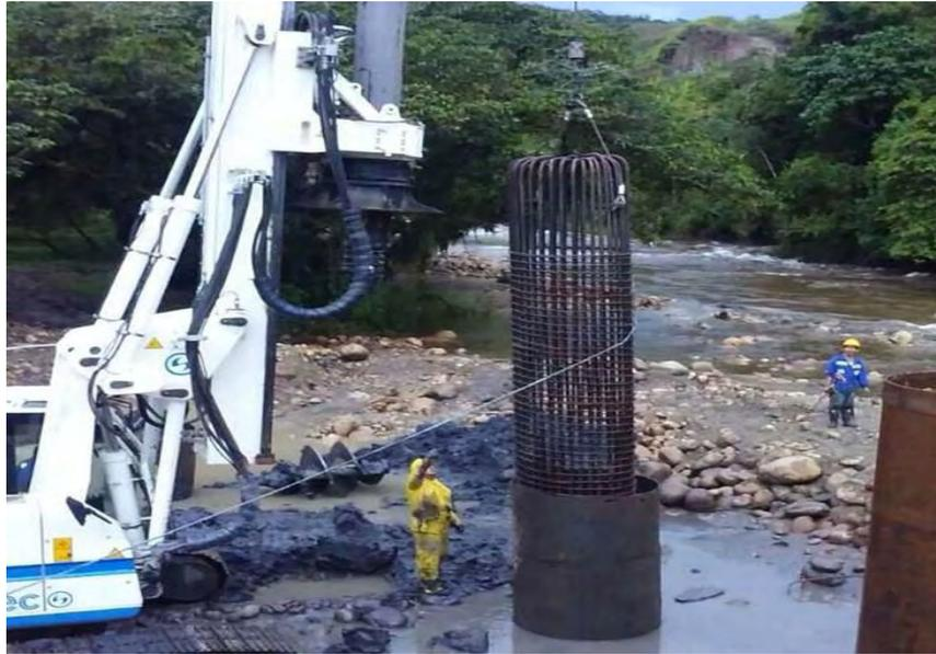
**Imagen 58. Instalación canasta de refuerzo eje 3 – puente pienta**
