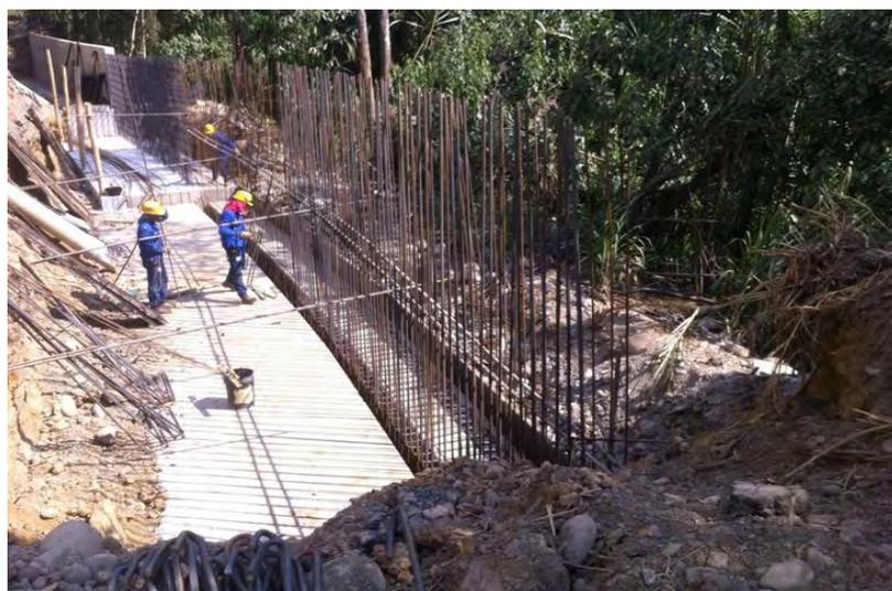
**Imagen 19. Instalación de acero muro K31+815 MI**
