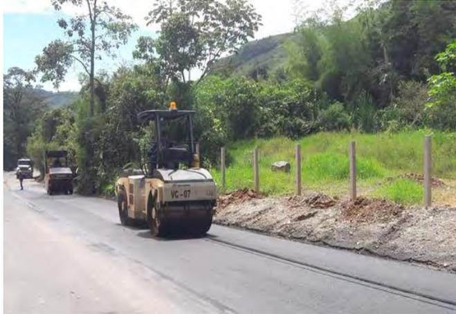
**Imagen 42. Compactación mezcla asfáltica con rodillo liso K31+300 MI**
