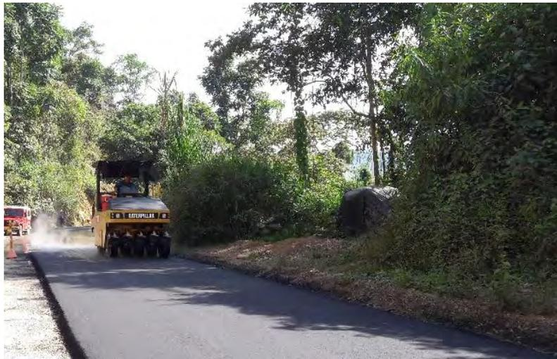
**Imagen 43. Compactación mezcla asfáltica con rodillo de llantas K32+000 MI**
