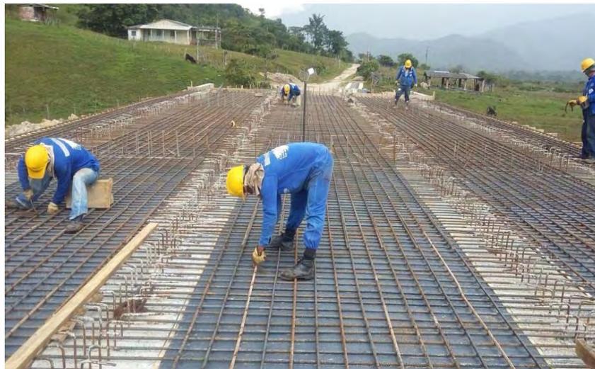
**Imagen 54. Armado y amarre de acero de losa superior – puente violin**
