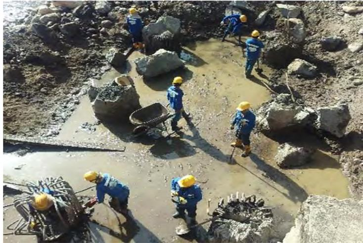
**Imagen 60. Demolición de concreto sobrante (descabezado) eje 2 – puente pienta**
