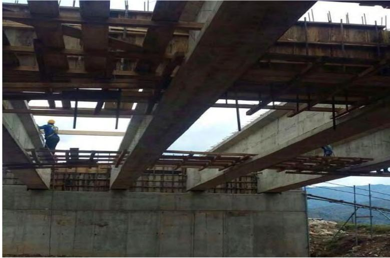
**Imagen 53. Construcción de obra falsa – puente violin**
