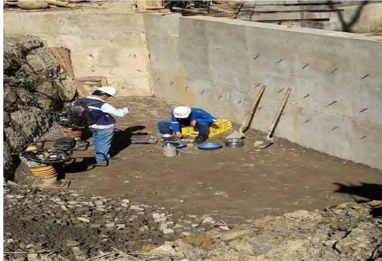
**Imagen 16. Relleno estructural y toma de densidad K34+608 MI**
