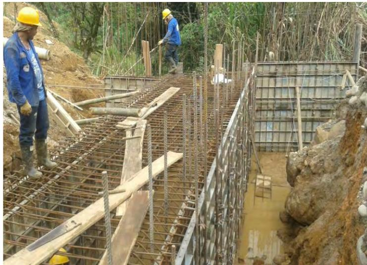
**Imagen 13. Encofrado muros laterales box K35+130 MD**
