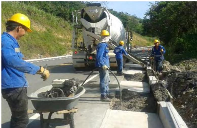
**Imagen 50. Fundición de cuneta K21+600 MI**
