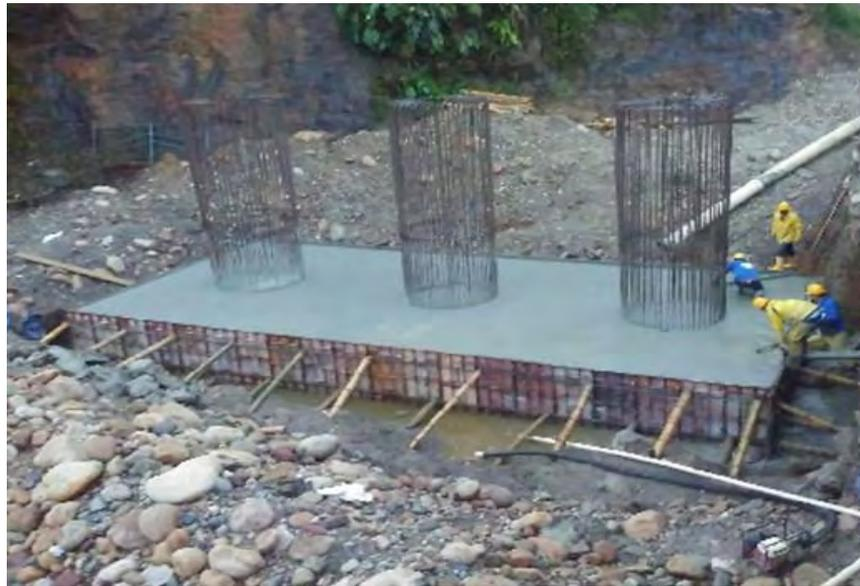
**Imagen 62. Fundición de zapata eje 2 – puente pienta**
