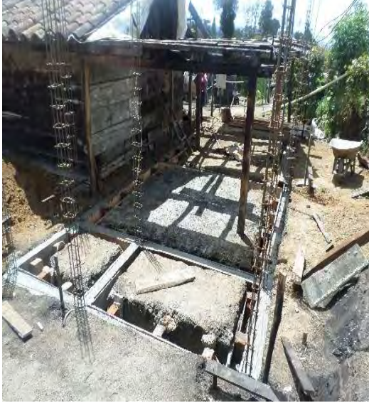
Ilustración 9. Viga de cimentación.
