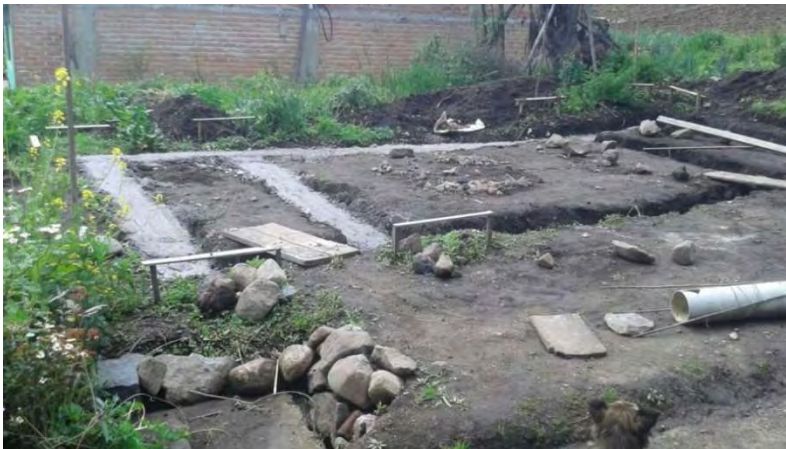
Ilustración 8. Cimentación en concreto ciclópeo 40x40cm.
