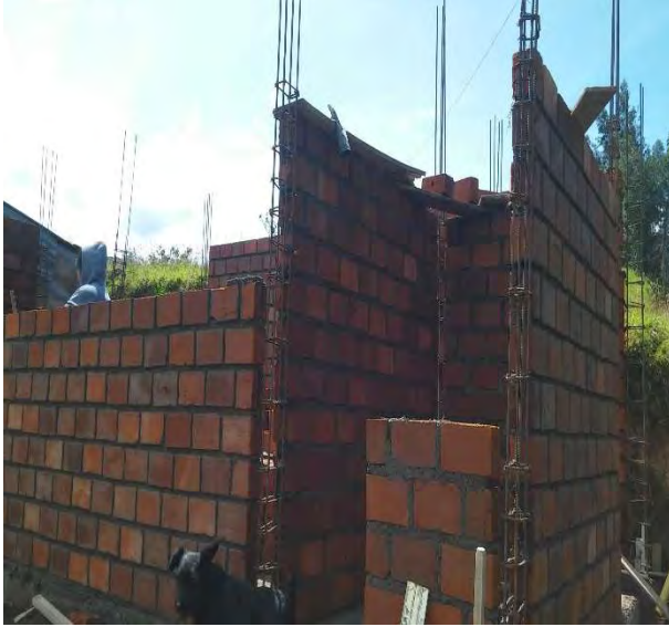
Ilustración 10. Mampostería en ladrillo.
