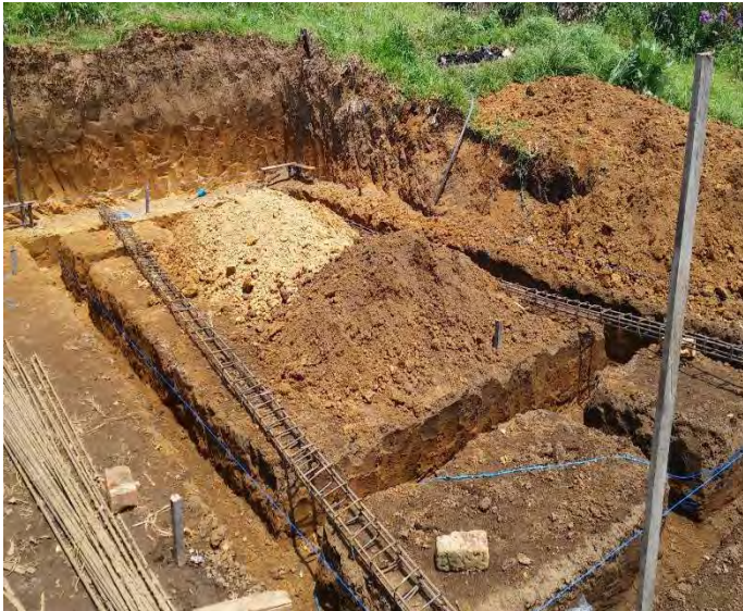
Ilustración 6. Excavación a mano.
