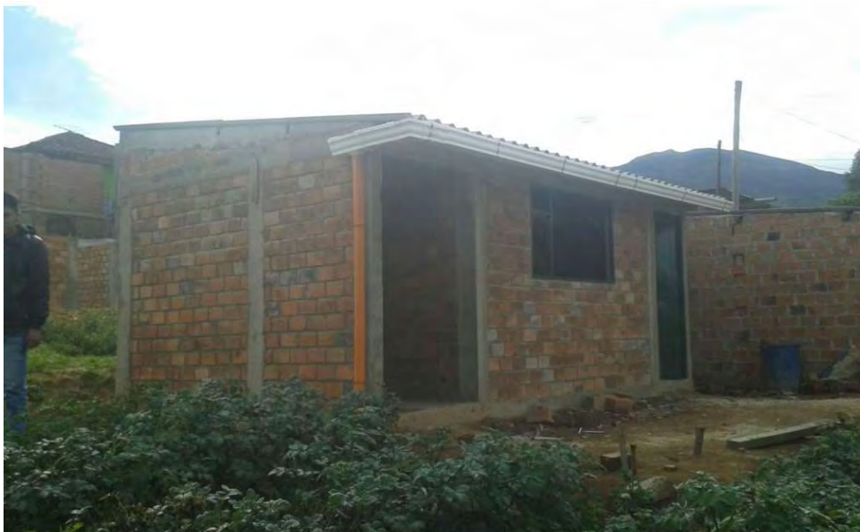
Ilustración 2. Módulo de mejoramiento de vivienda, modalidad VISR.
