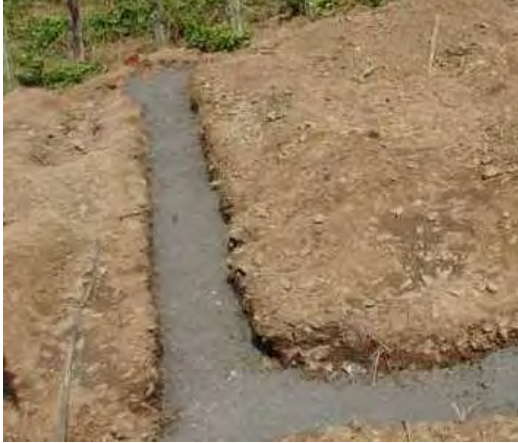
Ilustración 7. Solado de limpieza.
